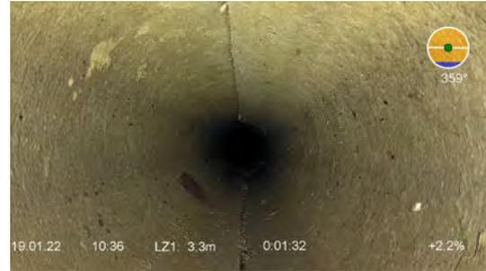
Abb. 6: Beispiel für einen sauberen Kanal (nach erfolgter Reinigung)
