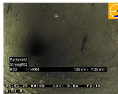
Abb. 9: Beispiel für Sedimente auf der gesamten Kanaloberfläche
