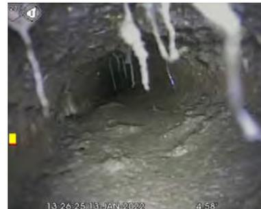
Abb. 8: Beispiel für eine Sedimentschicht von über 2 cm
