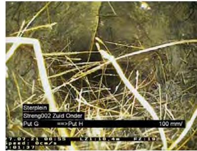
Abb. 10: Beispiel für in den Kanal hineinwachsende Haarwurzeln
