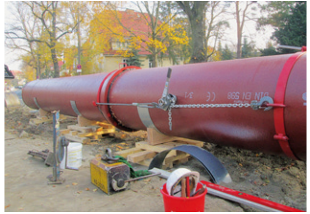
Montierte BLS®-Verbindung mit Rohrauflagern.
