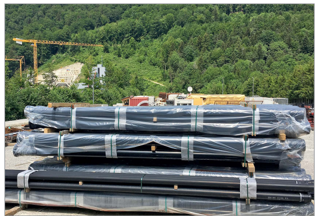
Duktile Gussrohre vom Typ vonRoll ECOPUR vor dem Einbau in den Werkleitungskanal
