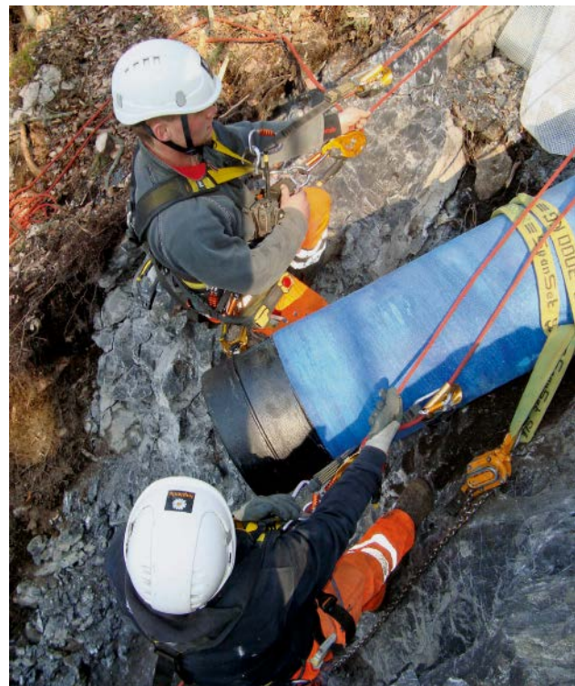
Bild 11: Arbeiten im Steilhang – Vorbereitung der Montage einer BLS® - Steckmuffen-Verbindung
