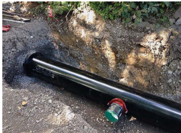
Bild 4: Montierter Anbohrsatel nach der Behandlung der Schnittkante mit Epoxidharz und montierte Übergangsmanschette auf ein Kunststoffrohr
