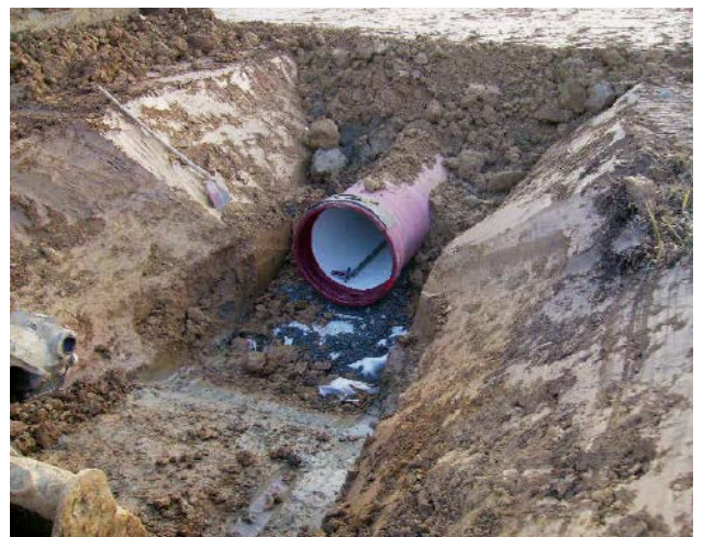
Bild 10: Mit Aushubmaterial verfüllter Rohrgraben
