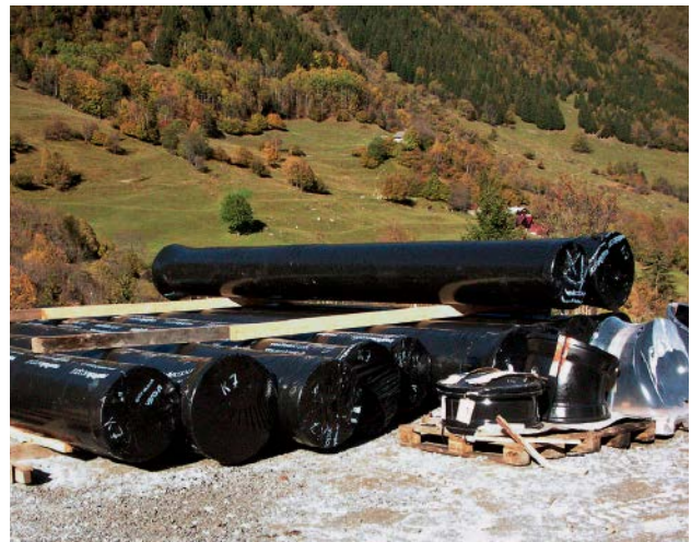
Bild 6: Lagerplatz der duktilen Gussrohre und Formstücke
