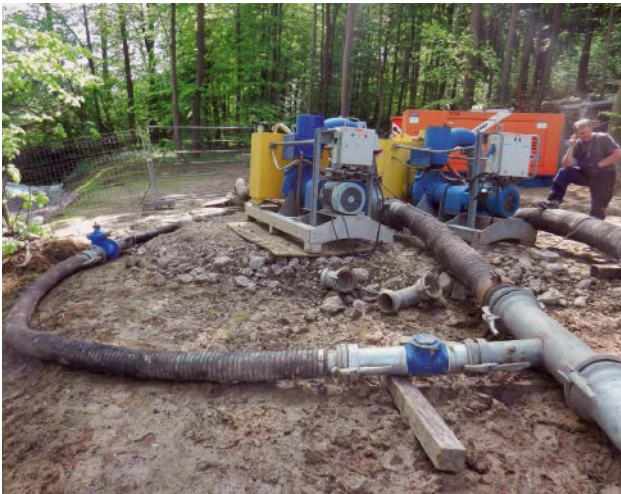
Bild 12: Abwasserhaltung beim Umschluss zum neuen Kanal
