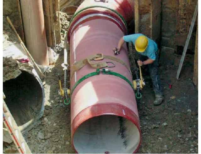
Bild 8: Rohraufleger mit Mineralgemisch 0/45 mm
