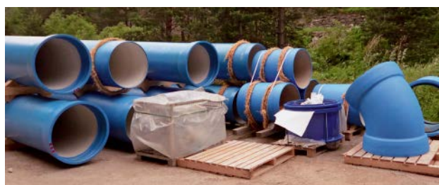
Bild 6: Duktile Gussrohre und Formstücke DN 800, vorbereitet für den Einbau
