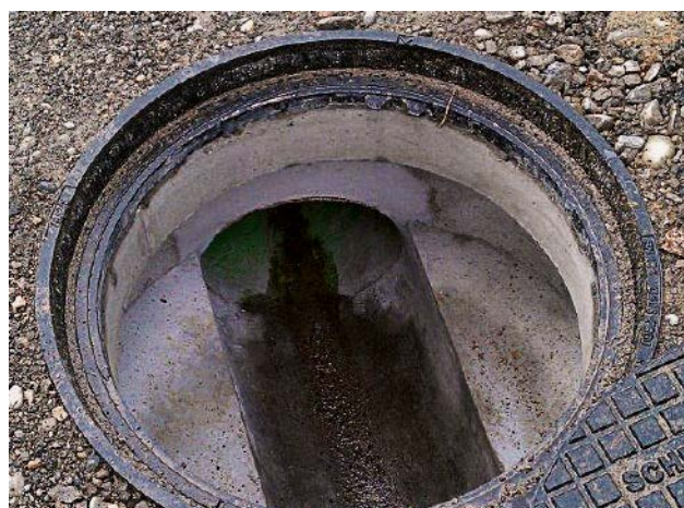
Bild 5: Ortbetonschacht mit Durchlaufrinne und Schachtbankett
