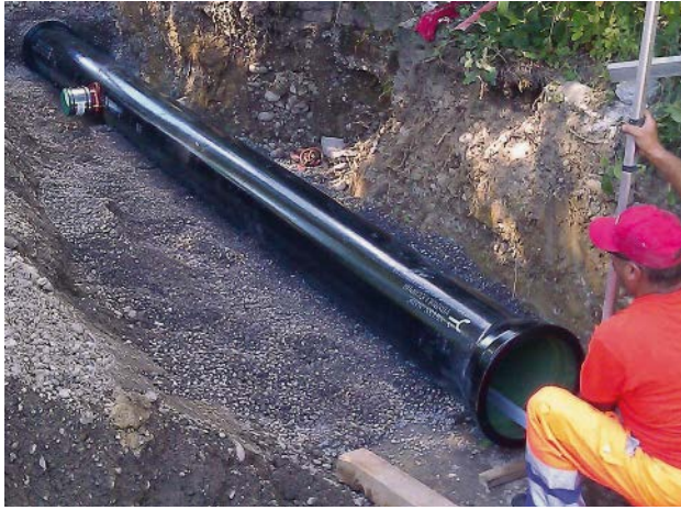
Bild 6: Kontrolle des Gefälles der eingebauten vonRoll ECOPUR-Rohre
