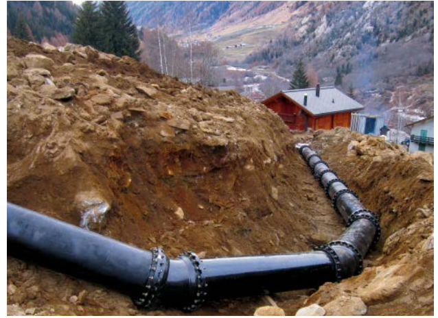
Bild 3: vonRoll ECOPUR-Rohre mit verstärkter Umhüllung (PUR) nach EN 545 [1], sehr widerstandsfähig in felsigem Gelände, geeignet für Korngrößen 0–63 mm, Größtkorn 100 mm, mit Schubsicherungen vonRoll HYDROTIGHT längskraftschlüssig gesichert
