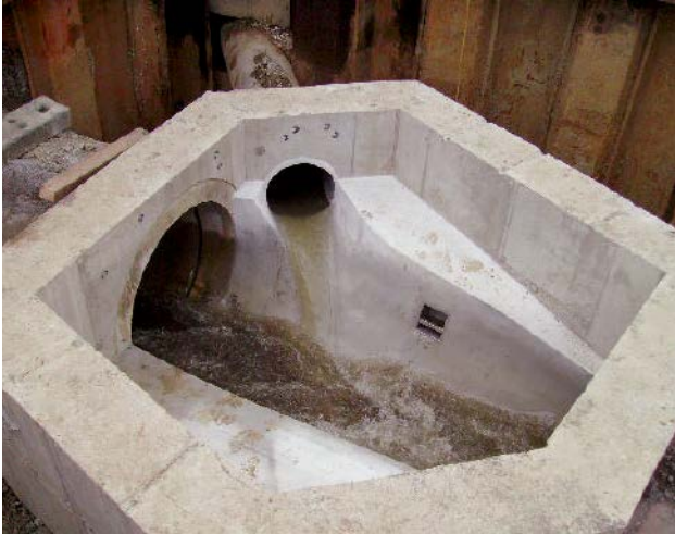
Bild 11: Bereits angeschlossenes Schachtbauwerk
