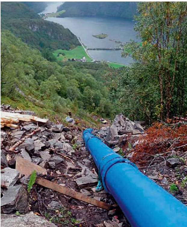
Bild 10: Fertiggestellte Steilhangleitung mit längskraftschlüssigen BLS® - Steckmuffen-Verbindungen
