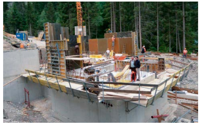
Bild 11: Neues Maschinenhaus an der Inn-Mündung
