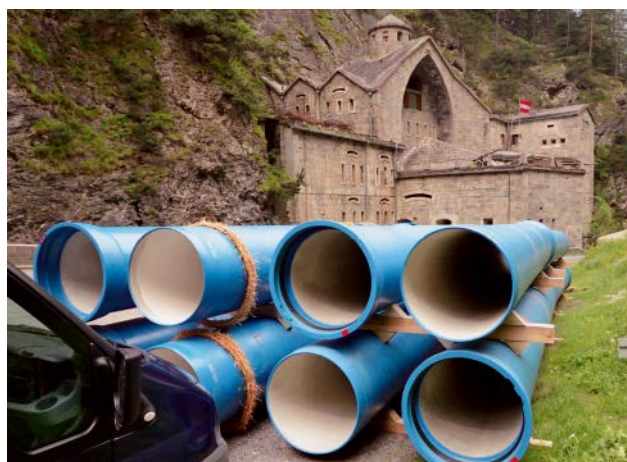
Bild 1: Duktile Gussrohre - Rohrlager für den Bau der Druckrohrleitung des Wasserkraftwerkes Stiller Bach in Nauders
