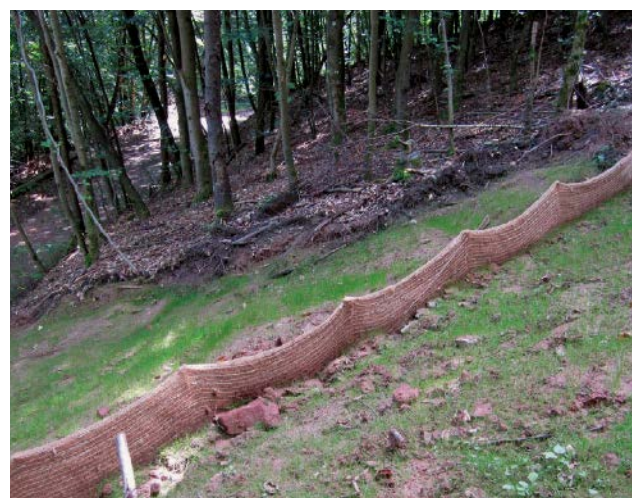
Bild 8: Die Hangsicherung der Trasse aus Jute-Vlies verhindert ein Wegspülen des Oberbodens.
