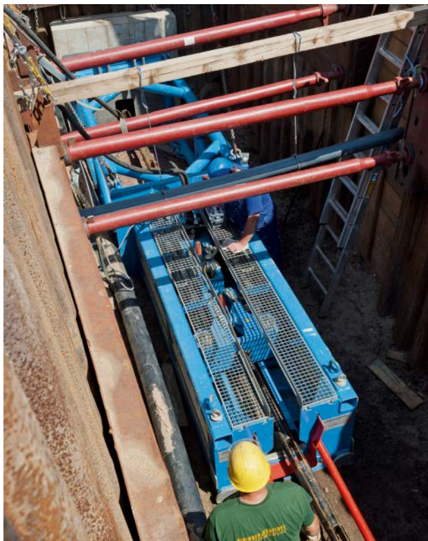
Bild 5: GRUNDOBURST 1900G in der Baugrube Quelle: BASF SE, Ludwigshafen
