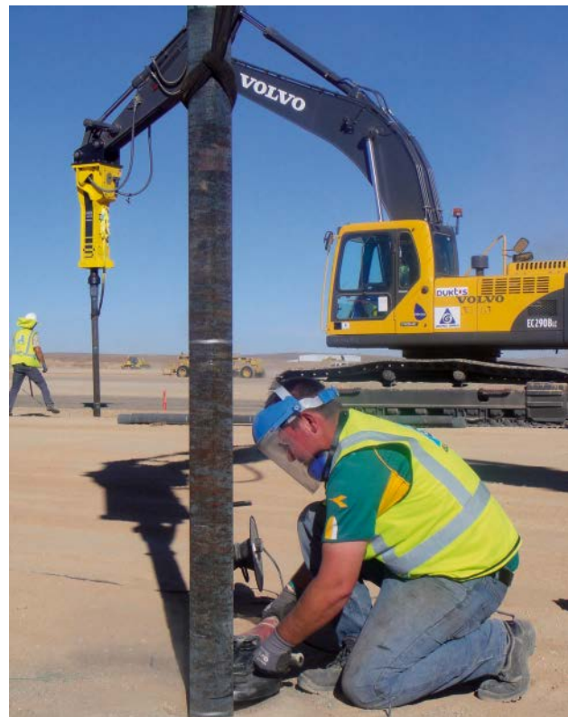
Bild 3: Abtrennen der überzähligen Länge des eingebauten Guss-Rammpfahls
