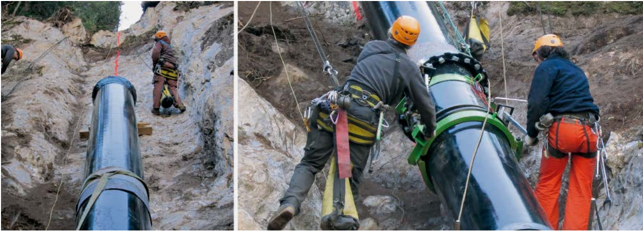
Bild 4: Oberirdische Montage der duktilen Gussrohre in der Steilwand im Fels
