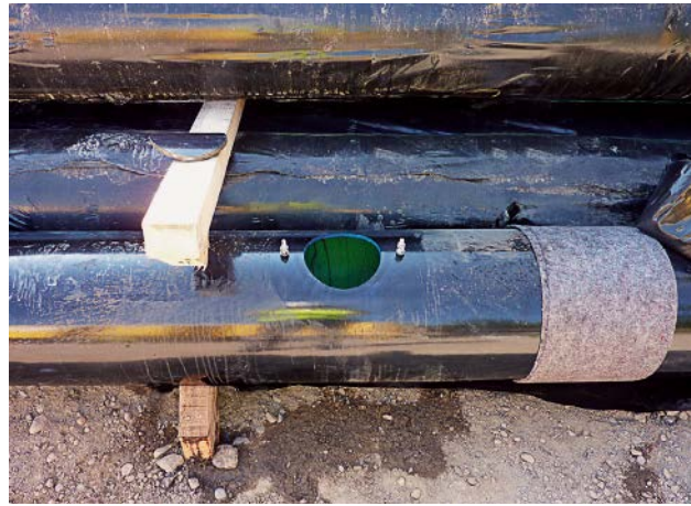
Bild 3: Kernbohrung in ein vonRoll ECOPUR-Rohr – die Schnittkante wird mit einem 2-Komponenten-Epoxidharz nachbehandelt
