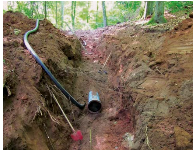
Bild 7: Duktile Gussrohre DN 300 – Einbau im Graben
