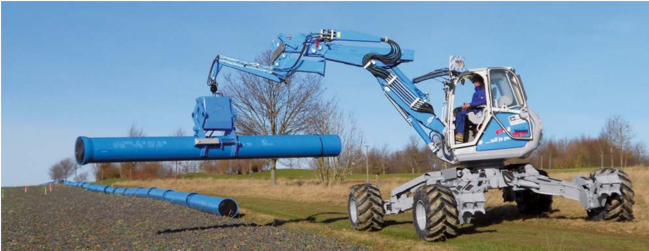
Bild 2: Auslegen der duktilen Gussrohre entlang der Trasse mit dem Schreitbagger
