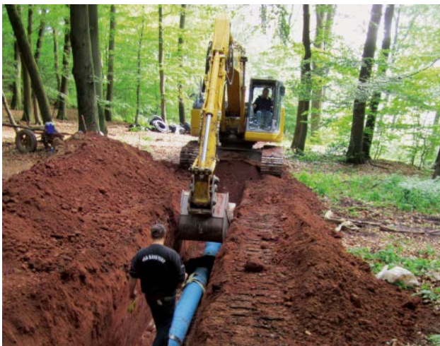
Bild 2: Einbau der Rohre in schmaler Trasse im Wald
