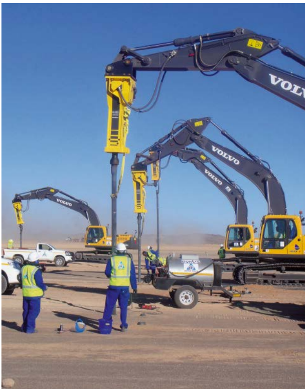
Bild 2: Vier Baumaschinen zum Abteufen der duktilen Guss-Rammpfähle
