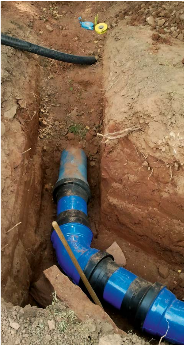
Bild 5: Knickpunkt am Übergang der BLS®- Steckmuffen-Verbindung zur BRS®- Steckmuffen-Verbindung
