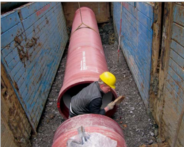
Bild 6: Rohreinbau im verbauten Rohrgraben
