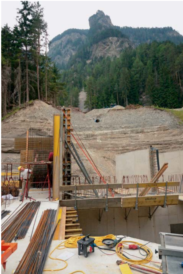
Bild 10: Bau des Maschinenhauses mit beachtlicher Dimension
