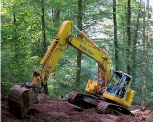
Bild 4: Tiefbauarbeiten in felsigem Gelände am Steilhang im Wald
