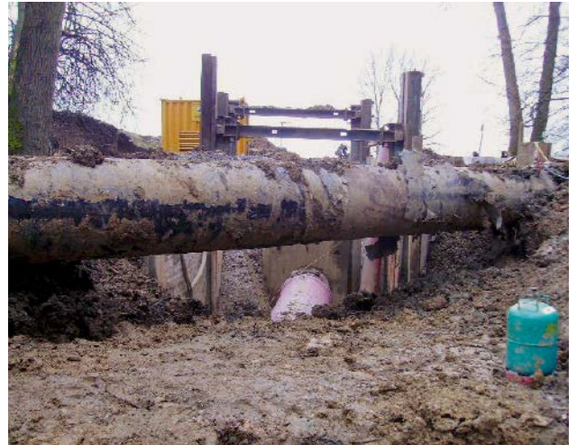
Bild 9: Krebsbachkreuzung mit angehobenem Sohlprofil
