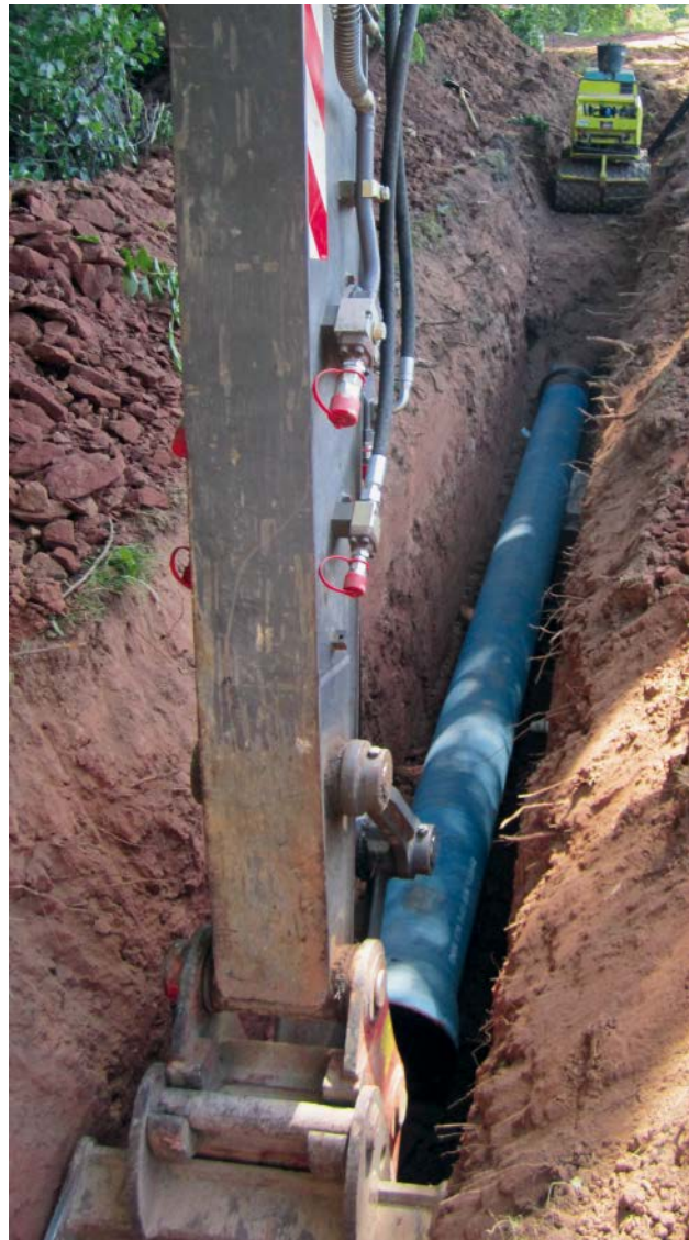
Bild 3: Einbau der duktilen Gussrohre DN 300 im flachen Bereich
