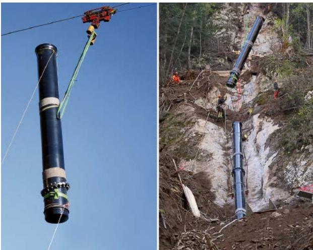
Bild 5: Rohreinbau der vonRoll ECOPUR-Vollschutzrohre mittels Baustellen-Drahtseilbahn in steilem, unzugänglichen Gelände
