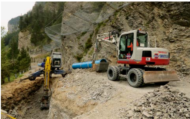
Bild 8: Gekonnter Einsatz eines Schreitbaggers mit Bohrmeißel in steilem Gelände
