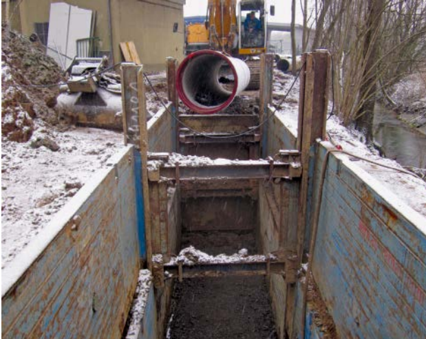
Bild 5: Sicherung des Grabens mit Hilfe von Graben- verbaugeräten
