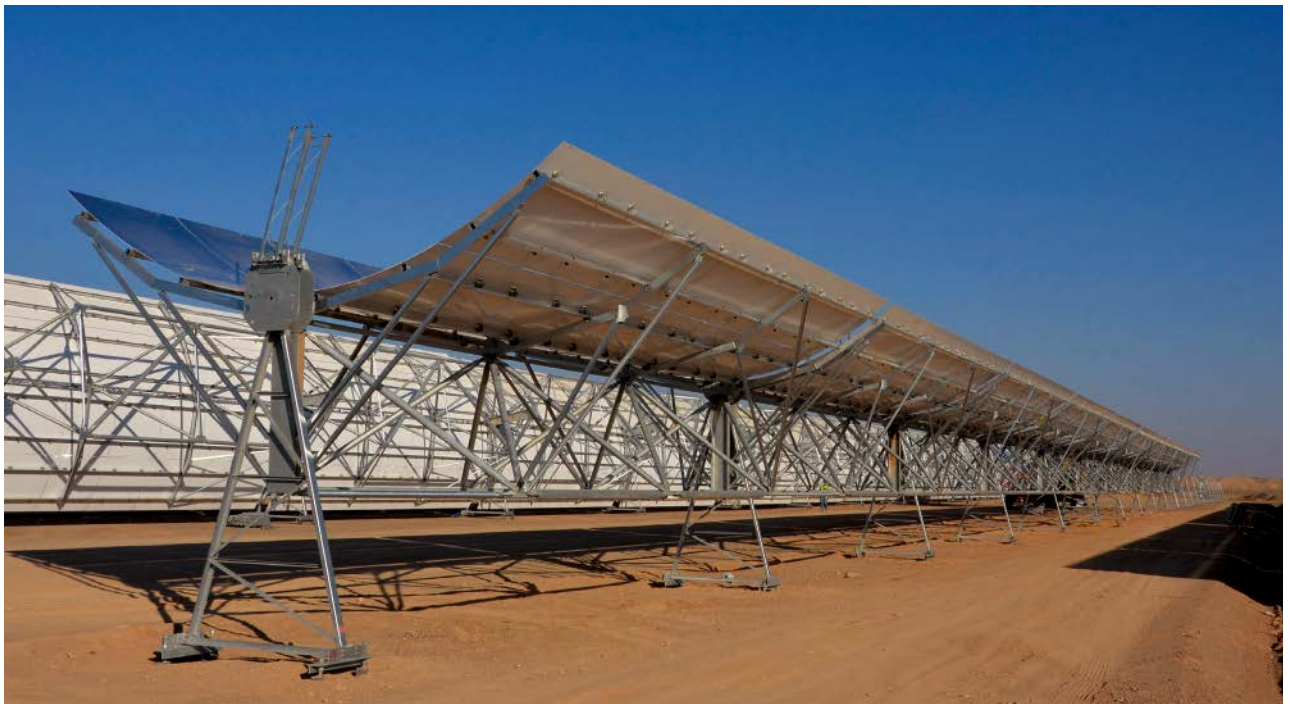
Bild 1: CSP-Kraftwerk – Parabolspiegel auf dem Gelände von KaXu Solar One
