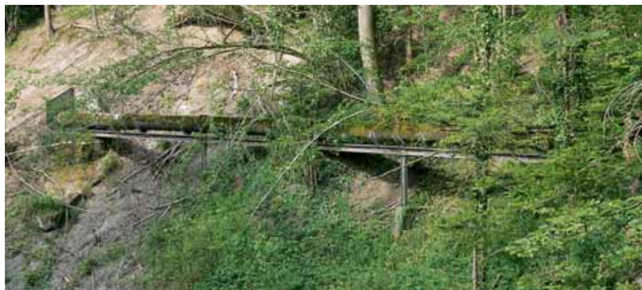
Bild 1: Der alte Viadukt „Gämpi“
