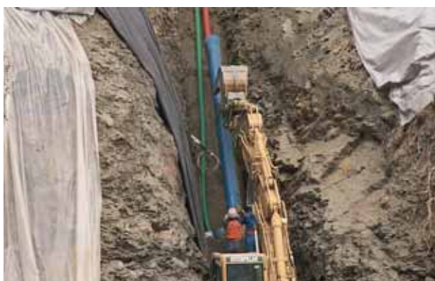
Bild 4: Arbeiten an der Turbinenleitung
