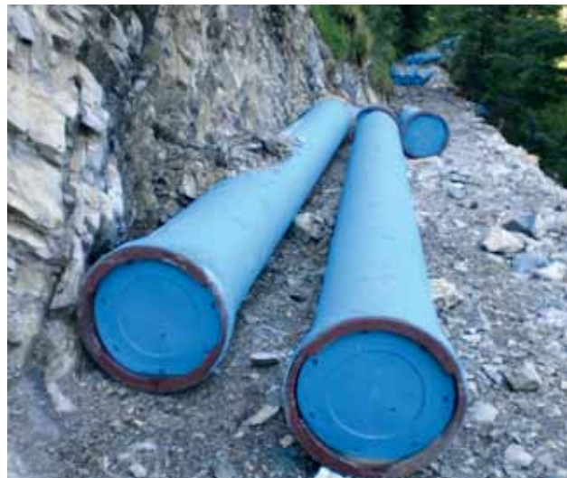
Bild 16: Duktile Gussrohre DN 400 – freigemachte Rohrtrasse quer zum Hang
