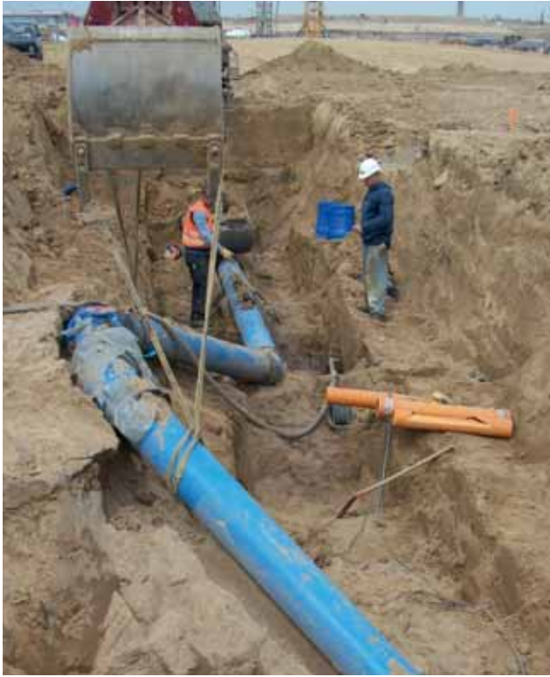
Bild 7: Nachträglich verschwenkter Leitungsabschnitt DN 300 für den Hydranteneinbau
