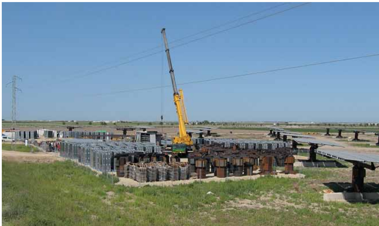
Bild 8: Errichtung des Solarenergieparks in Lebrija
