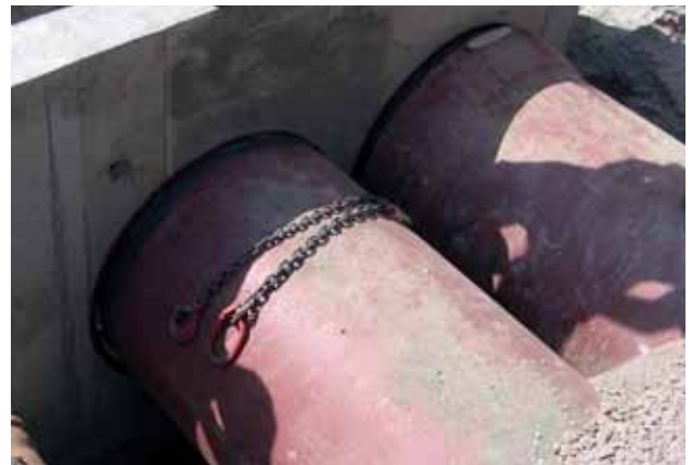
Bild 11: Stahlbetonfertigteilschacht mit Schachtanschluss- stücken aus duktilem Gusseisen
