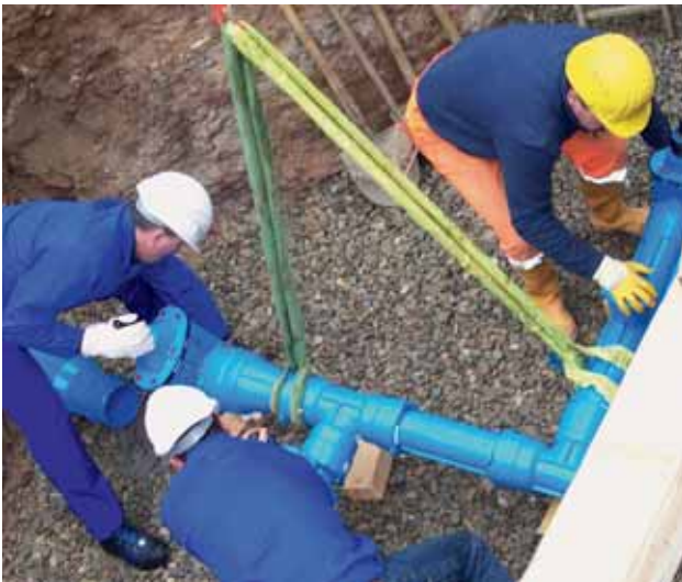
Bild 3: Positionierung des neuen Schieberkreuzes
