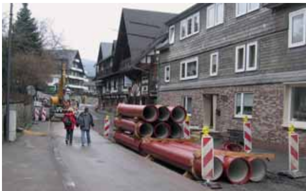
Bild 2: Duktile Kanalrohre mit Tonerdezementmörtel-Auskleidung als Innenschutz und Außenschutz mit Zinküberzug und Deckbeschichtung
