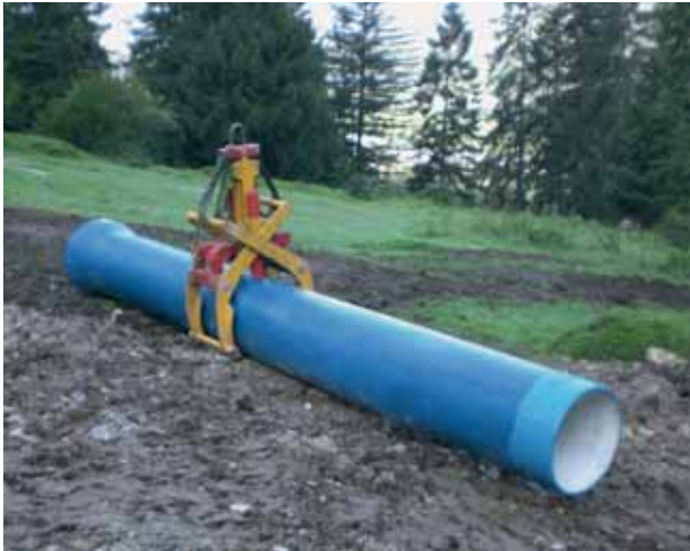
Bild 18: Gekürztes duktiles Gussrohr mit bauseitiger Schweißbrause
