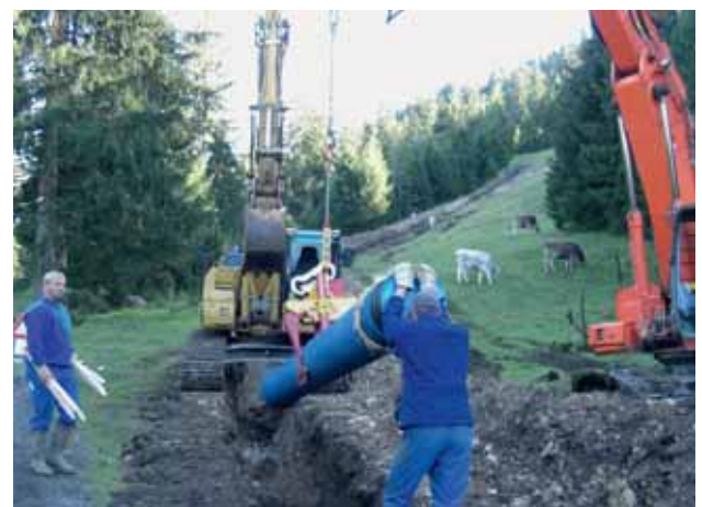
Bild 6: Einbau von duktilen Gussrohren mit Zementmörtel-Umhüllung im Skihang/Kuhweide
