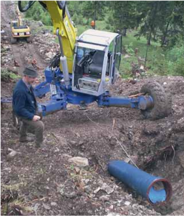
Bild 14: Schreitbagger im Einsatz
