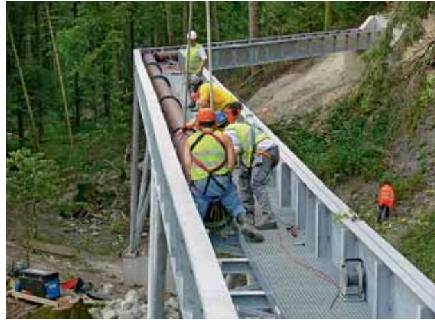
Bild 6: Der begehbare Abwasserviadukt „Gämpi“ mit geopur-Rohren DN 400 und deren Transport
