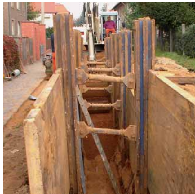
Bild 6: Baugrube mit Gleitschienenverbau
