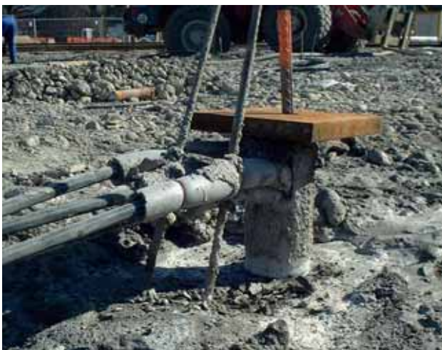
Bild 5: Gerammter und mit Beton verpresster duktiler Pfahl mit Pfahlkopfplatte
