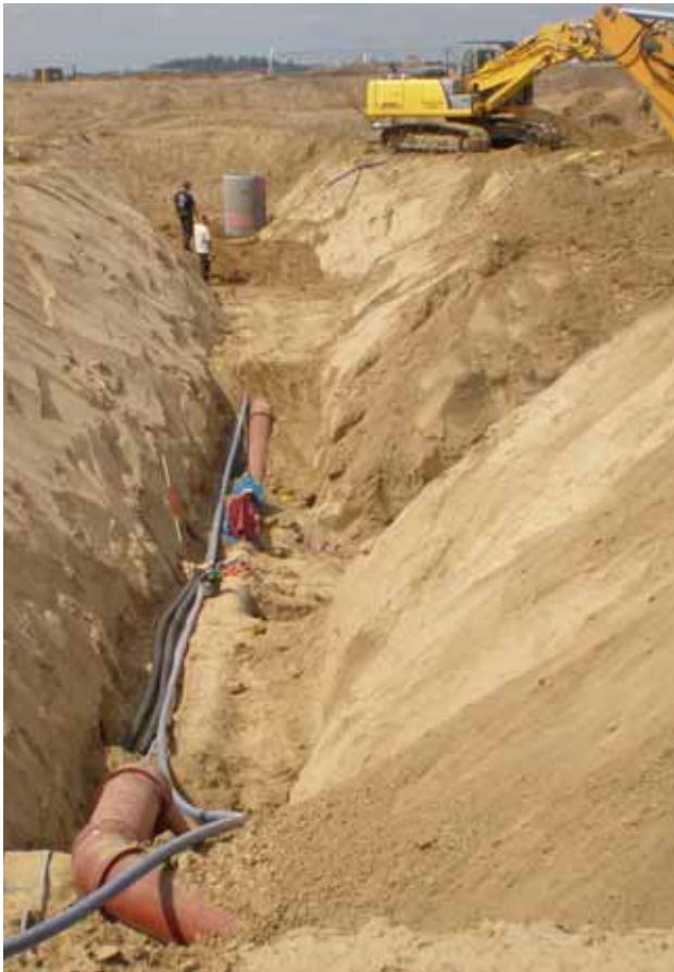
Bild 8: Dükerung einer späteren Baumaßnahme mit duktilen Kanal-Druckrohren DN 400
