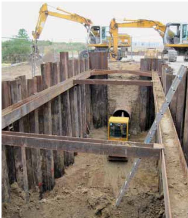
Bild 1: Baugrubensicherung mit Spundbohlen-Verbau
