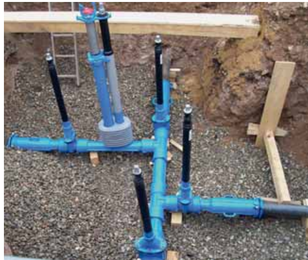
Bild 5: Schieberkreuz nach der Sanierung
