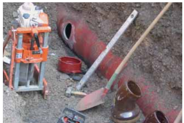
Bild 12: Herstellung von Kanalhausanschlüssen mittels Anbohrsatelstücken aus duktilem Gusseisen
