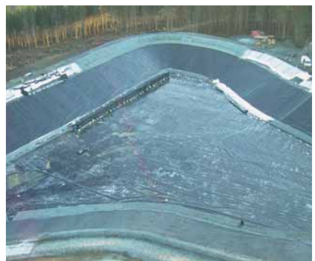
Bild 4: Wasserspeicher kurz vor der Fertigstellung
