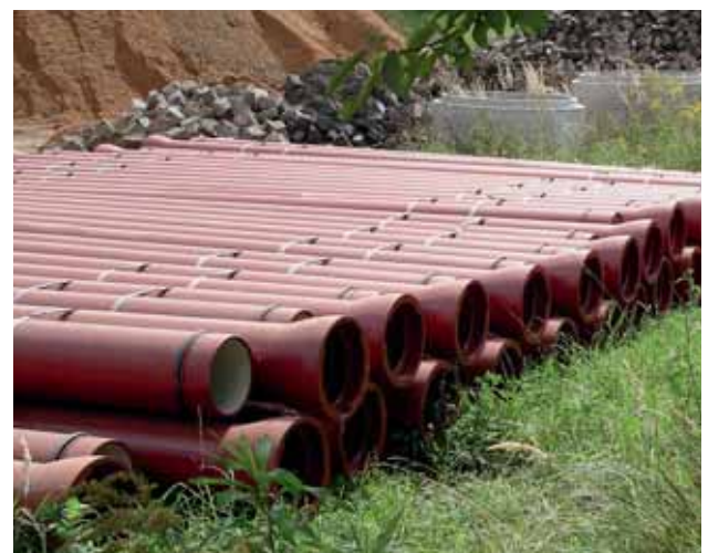
Bild 3: Duktile Gussrohre nach DIN EN 598 mit TYTON® - Steckmuffen-Verbindungen
