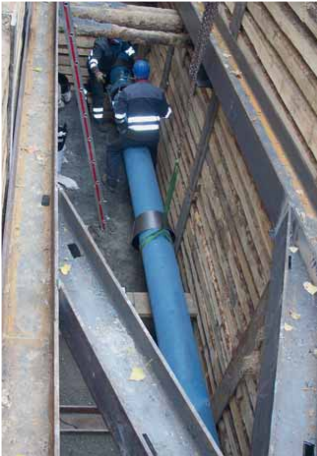
Bild 5: Einbringen der duktilen Gussrohre DN 300
