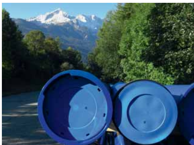
Bild 1: Duktile Gussrohre mit BLS®-Steckmuffen-Verbindung im Wettersteingebirge – im Hintergrund die 2.628 m hohe Alpispitze
