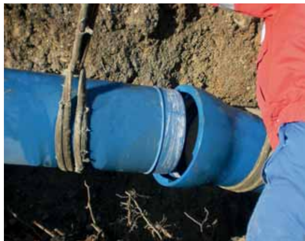
Bild 17: Einschwenken der Leitungsenden
