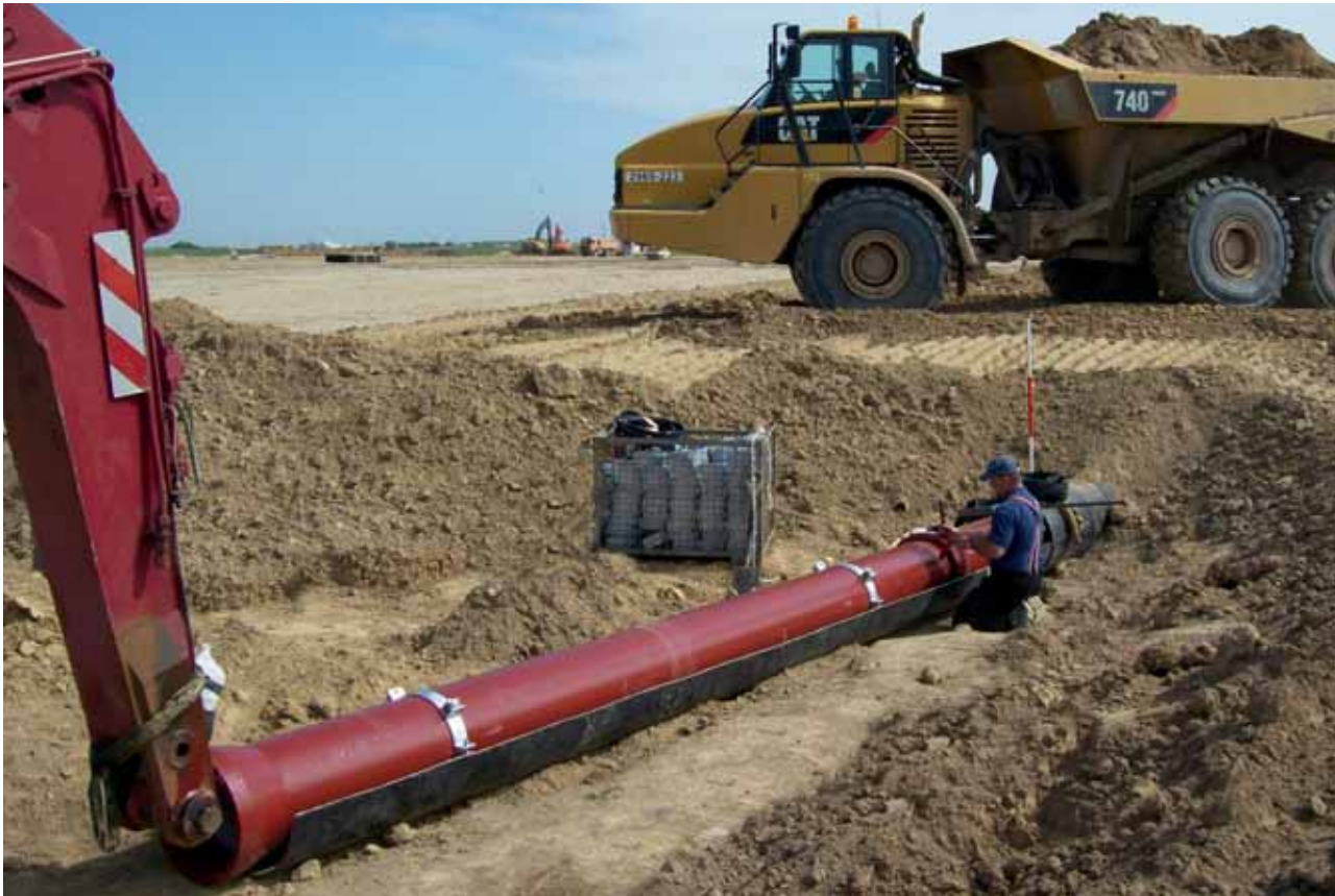
Bild 9: Einschub duktiler Kanalgussrohre DN 400 mit BLS® - Steckmuffen-Verbindung in eine Schutzrohrstrecke
