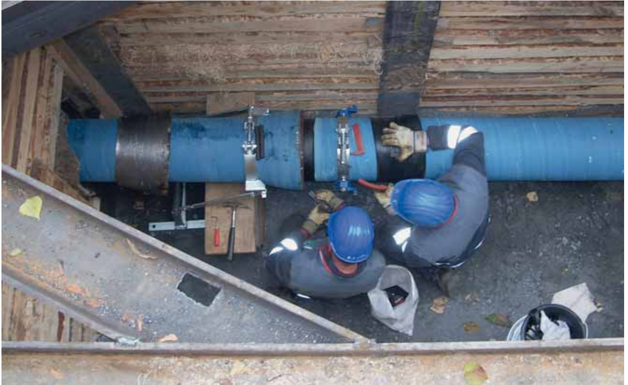
Bild 4: Montage der BLS® - Steckmuffen-Verbindung
