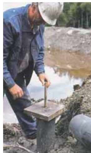
Bild 6: Setzen der Druckverteilerplatte
