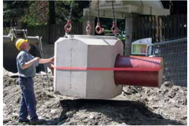
Bild 10: Stahlbetonfertigteile mit vormontiertem Gelenkstück aus duktilem Gussrohr DN 500
