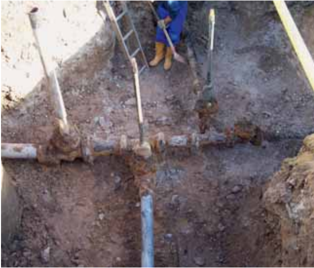
Bild 2: Bestehendes Schieberkreuz
