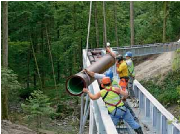
Bild 5: Einschweben der duktilen Abwasserrohre
