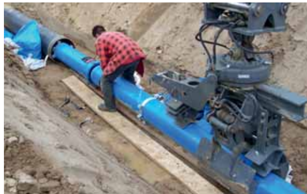
Bild 6: Montage und Einschub einer duktilen Trinkwasserleitung DN 300 mittels Spezialtechnik
