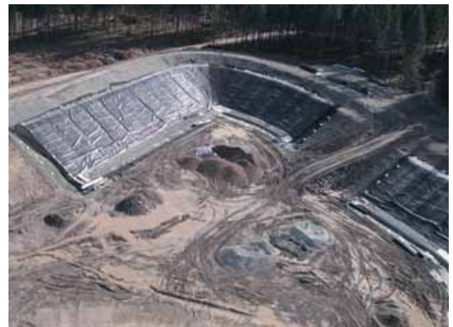
Bild 3: Aushub des zentralen Wasserspeichers
