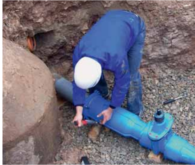
Bild 4: Längskraftschlüssiger Anschluss an Rohrenden
