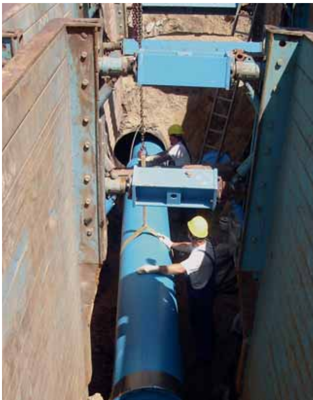
Bild 4: Montage eines BLS®-Rohres DN 600
