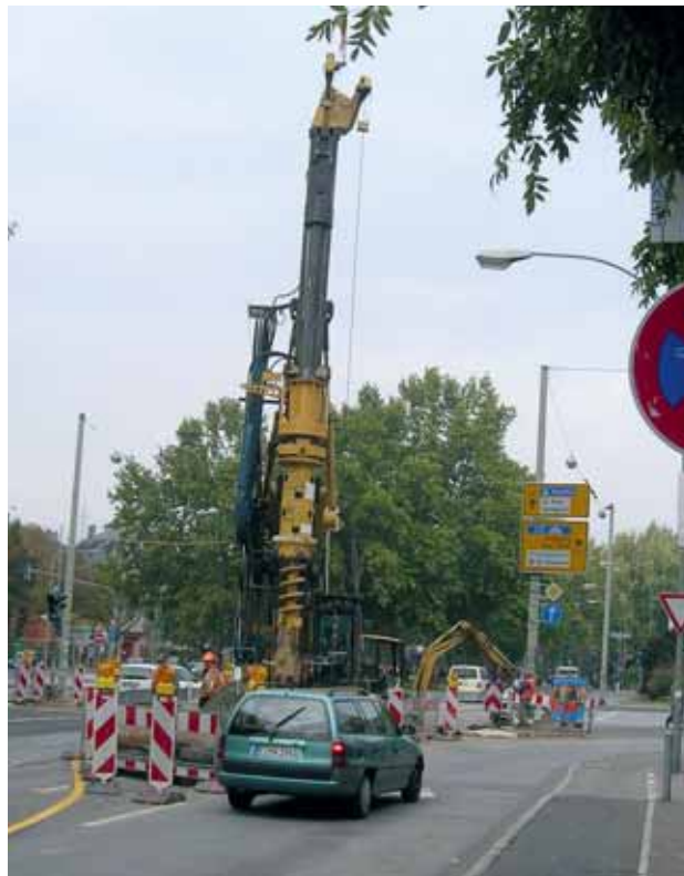
Bild 3: Herstellung des Bohrträgerverbau am Nibelungenplatz
