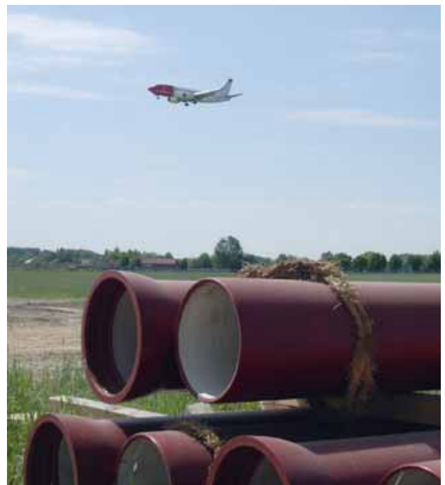
Bild 1: Aufrechterhaltung des Flugbetriebes trotz der Großbaustelle BBI
