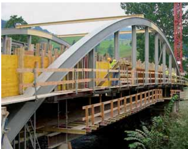
Bild 1: Rietwisbrücke im Bau
