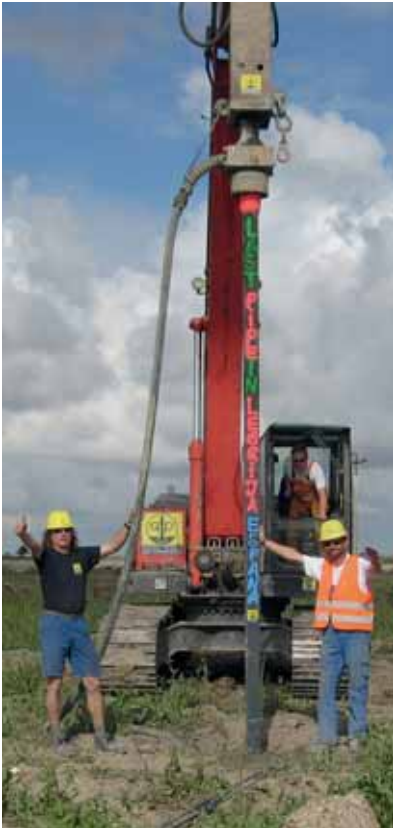
Bild 9: Einrammen des letzten Pfahls beim Solarenergieparks Lebrija
