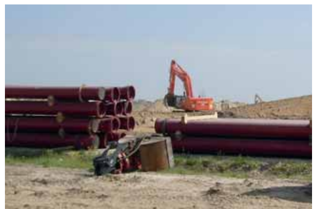
Bild 2: Leitungsumlegungen zur Vorbereitung des Baufeldes
