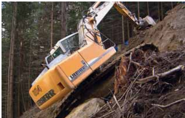
Bild 2: Anlegen des Rohrgrabens am Steilhang
