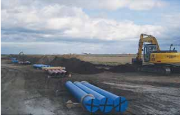
Bild 3: An der Trasse ausgelegte Trinkwasser- und Abwasserrohre DN 300 im Bereich des Paralleleinbaus
