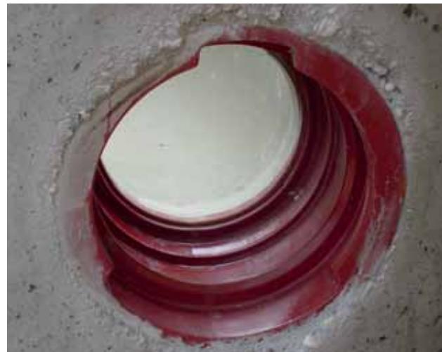
Bild 5: Betonschachtunterteil mit zugfestem VRS-Schachtanschlussstück
