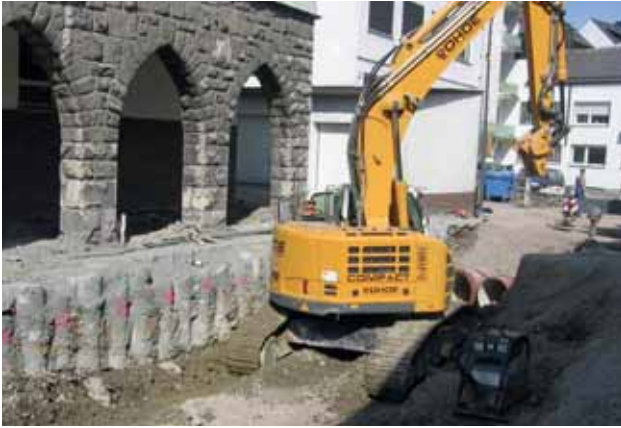
Bild 4: Sicherung des Ständerhauses mittels überschnittener Bohrfahlwand
