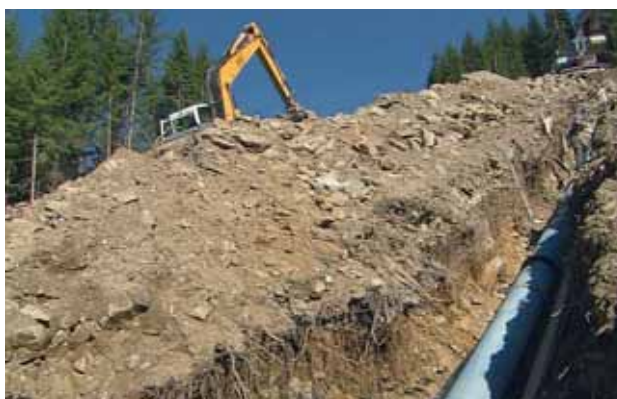
Bild 3: Einsatz eines ZMU-Rohres in hochalpinem Gelände
