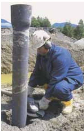
Bild 2: Abschneiden des überstehenden Pfahlstückes
