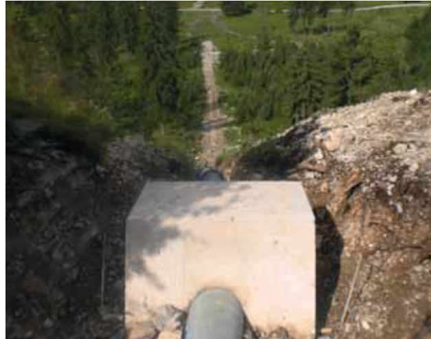
Bild 15: Betonwiderlager zur Fixierung der Steilhangleitung am oberen Ende
