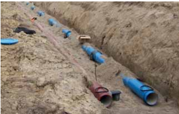
Bild 4: Paralleleinbau von duktilen Trinkwasser- und Abwasserrohren
