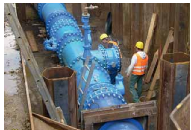
Bild 3: Montage eines Klappenkreuzes
