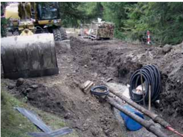
Bild 3: Alte Wasserversorgungsleitung – zwei Trinkwasserleitungen DN 100 aus Grauguss
