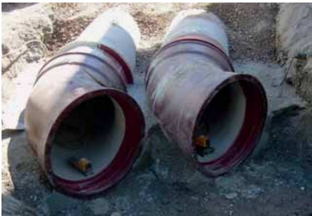
Bild 9: Eingebaute Doppelmuffenbögen DN 1000
