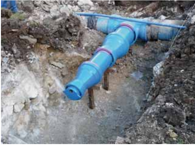
Bild 11: Abzweig Hochbehälter
