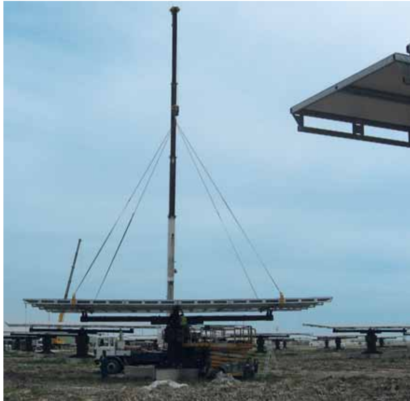
Bild 10: Montage eines Solarmoduls – hier sind die Größe eines einzelnen Moduls und damit die Dimensionen des Solarenergieparks zu erkennen.
