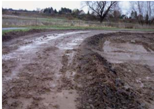
Bild 3: Baustraße mit aufgeweichten Auelehmschichten
