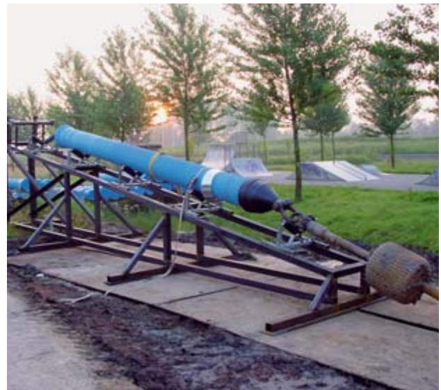
Bild 4: Montagerampe zur Einzelrohrmontage während des Einziehens
