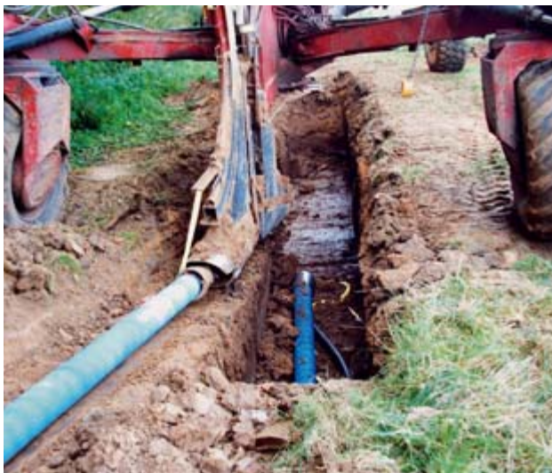
Bild 6: Vorziehen zur Startgrube
