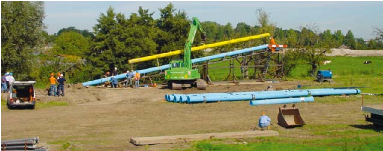
Bild 5: Einzug der Drillinge beim zweiten Pilotprojekt
