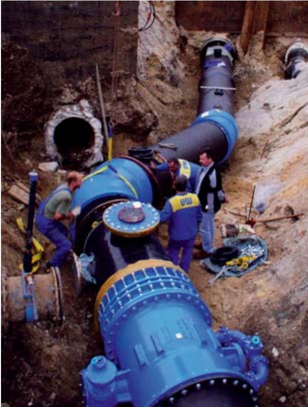
Bild 4: Einbau von Bögen
