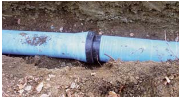
Bild 3: Rohre mit Zementmörtel-Umhüllung und Schutzmanschette
