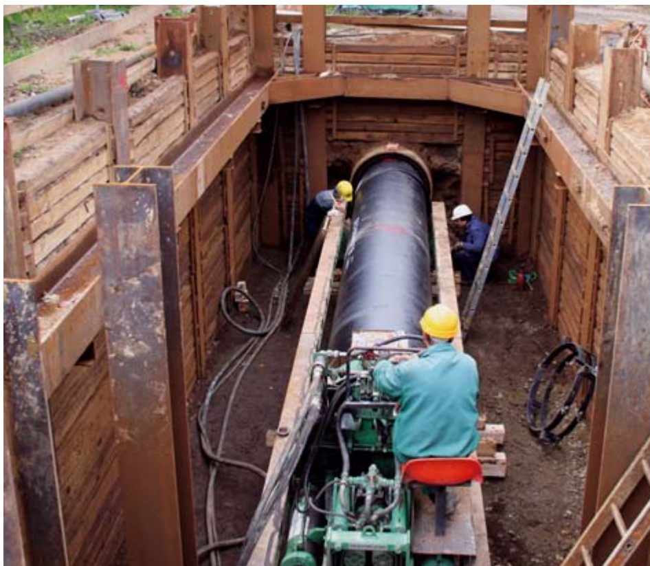
Bild 6: Einschieben der Rohre
