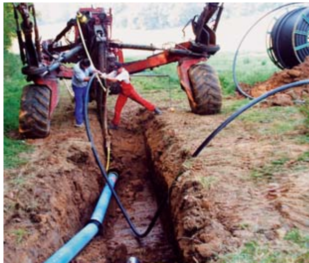
Bild 7: Einführung des Kabelschutzrohres
