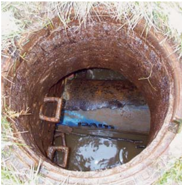
Bild 6: Oberflächenkontrolle in einem Zwischenschacht
