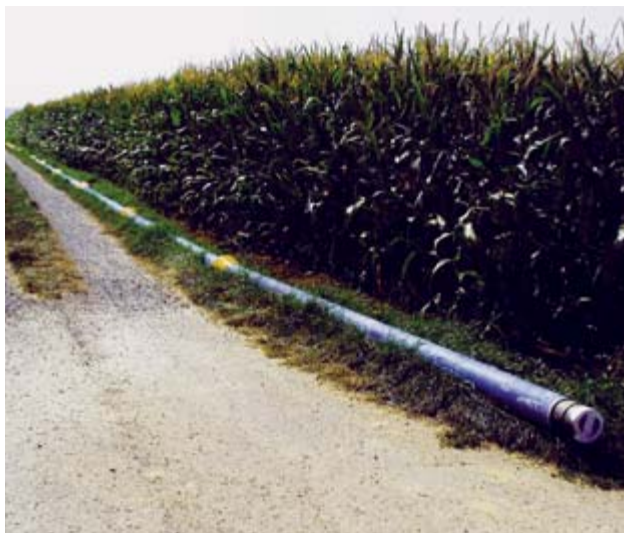
Bild 10: vormontierter Rohrstrang DN 150
