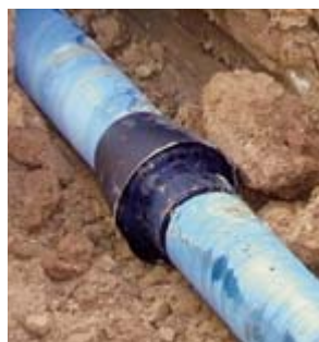
Bild 1: Schrupfmanschette mit Blechkonus
