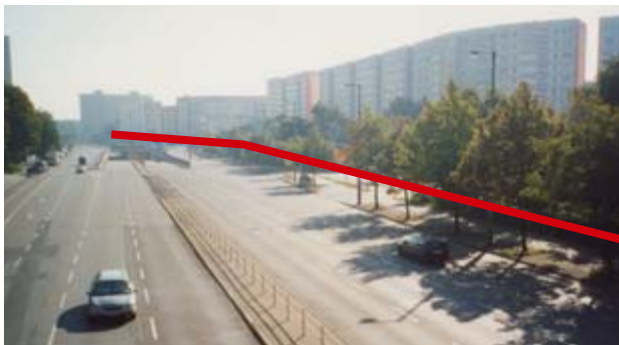
Bild 1: Unterirdischer Trassenverlauf im Seitenstreifen der B1/B5 (Alt-Friedrichsfelde)
