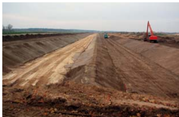
Bild 5: Bau der Versickerungsmulden (Voigt Ingenieure)
