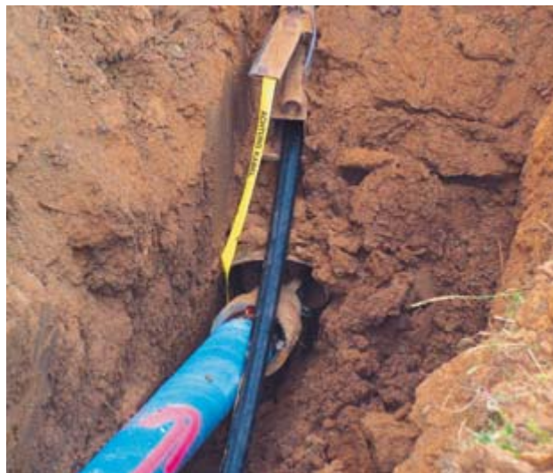
Bild 8: Einzug des Rohrstranges, des Kabelschutz- rohres und des Trassenwarnbandes
