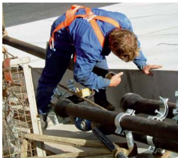
Bild 6: Montage in luftiger Höhe
