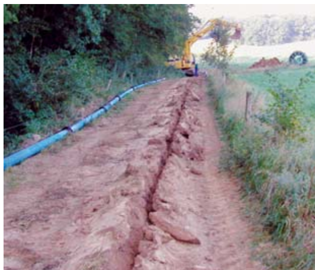
Bild 9: Oberfläche nach dem Einzug
