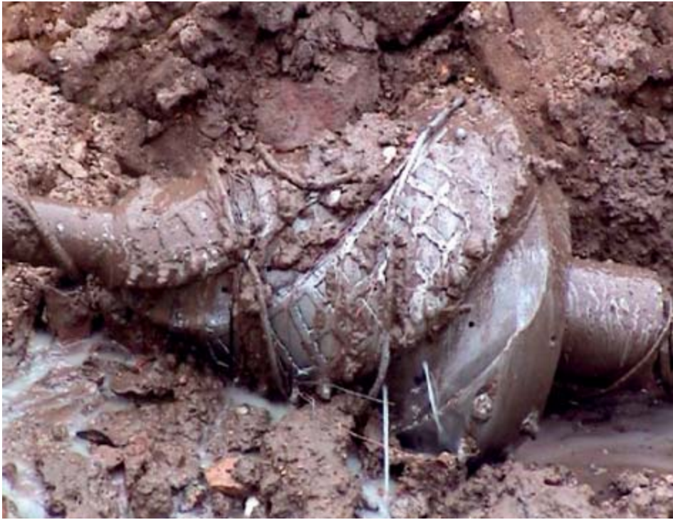
Bild 8: Armierung um HDD- Bohrkopf gewickelt
