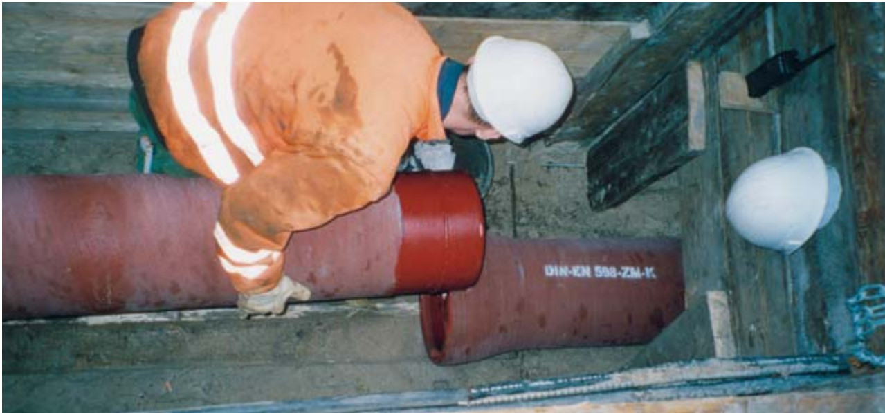
Bild 7: Verbindungsmontage der Produktrohre im Zielschacht
