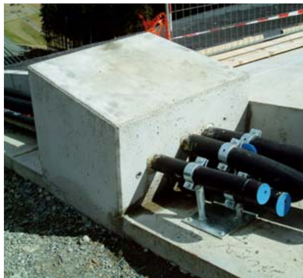
Bild 5: Verankerung der Rohrstränge
