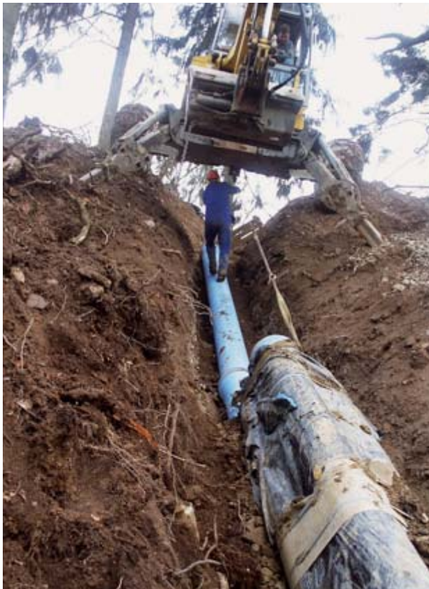
Bild 6: Rohrtransport im Steilhang
