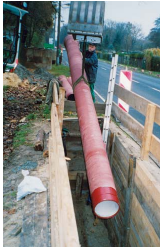
Bild 6: Ablassen des Rohres DN 300 in den Zielschacht.
