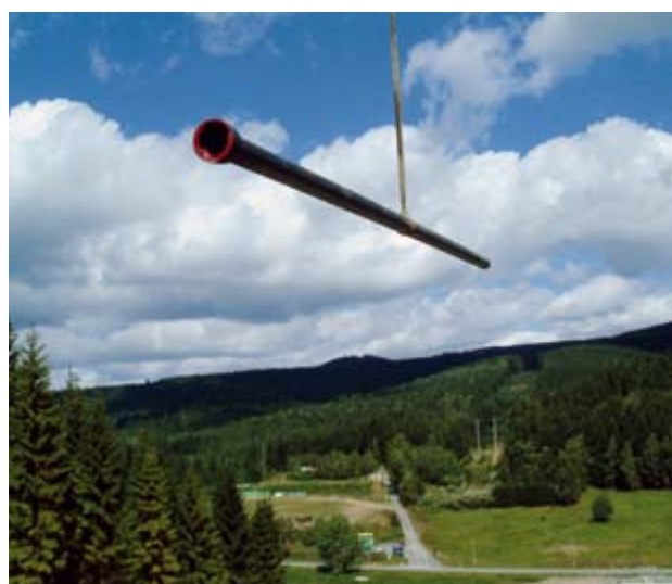
Bild 7: Rohrtransport per Kran
