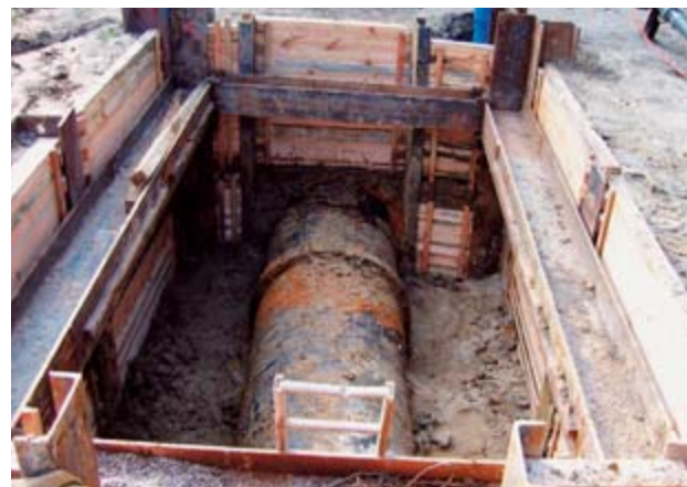
Bild 2: Baugrube mit freigelegter Altröhreleitung DN 1100
