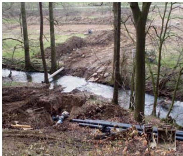
Bild 4: Bachunterquerung
