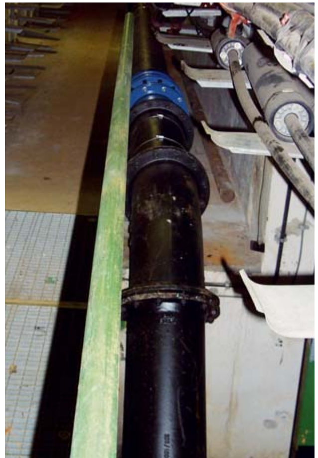
Bild 6: Leitungen im Kollektor nach Abschluss der Arbeiten
