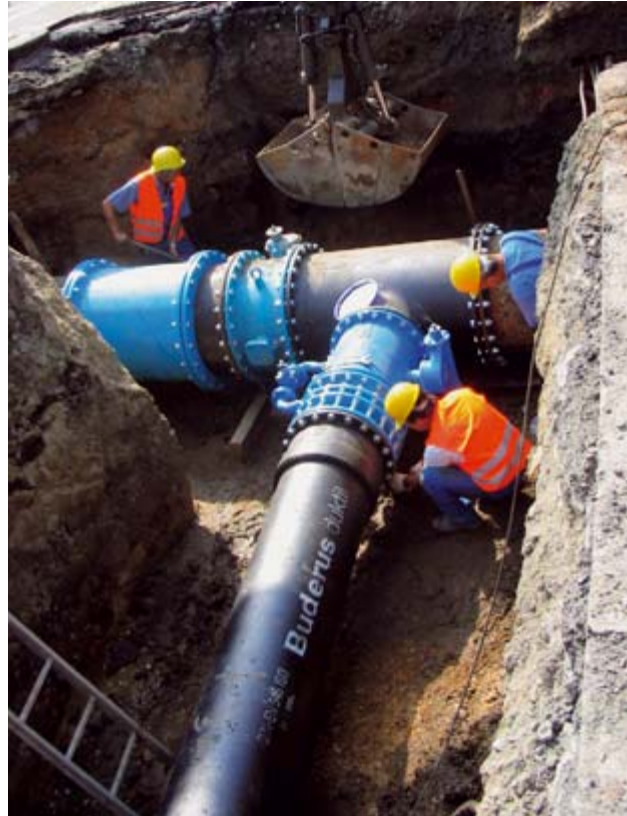
Bild 5: Schieberkreuz-Knotenpunkt
