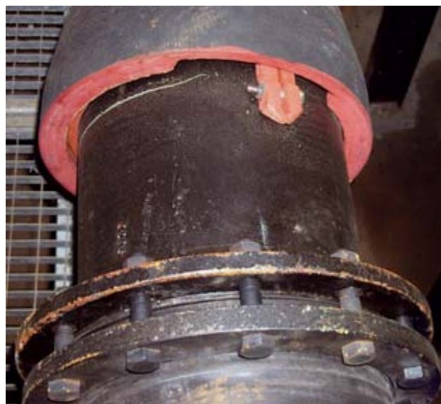
Bild 4: BLS-Klemmring an einem F-Stück
