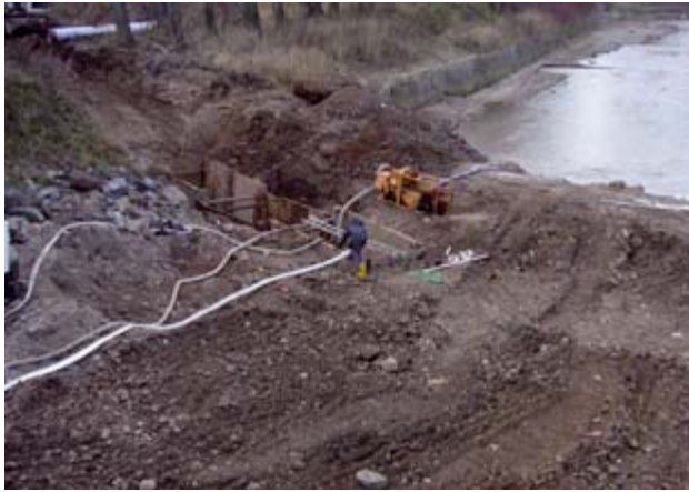
Bild 5: Bau des Müglitzdükers mit Hilfe eines Fangdammes
