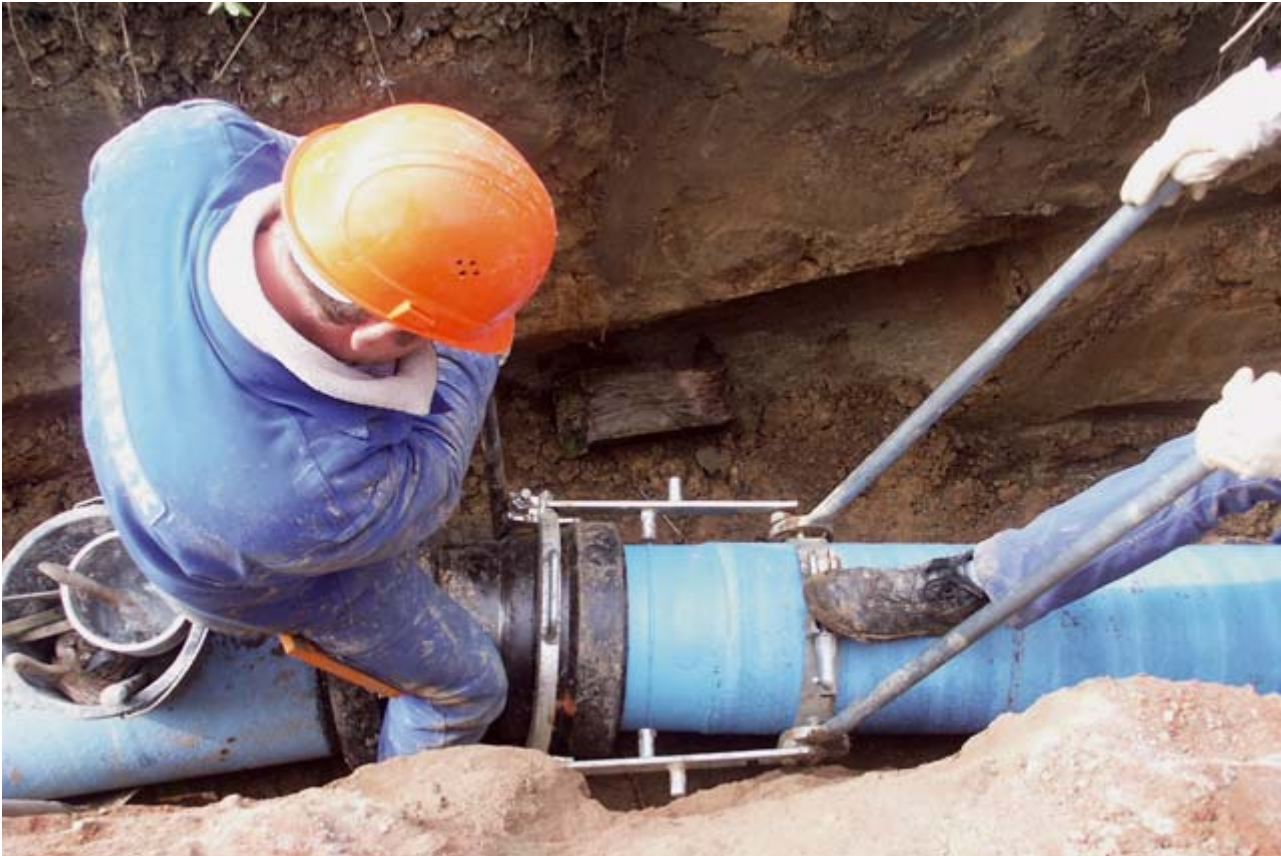
Bild 8: Formstückmontage mit zugfester Verbindung
