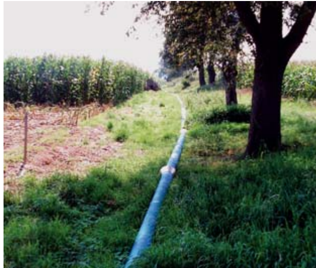
Bild 11: vormontierter Rohrstrang DN 150
