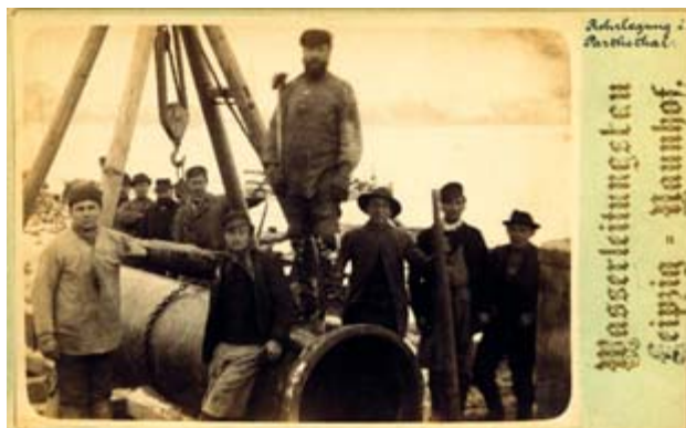
Bild 1: historische Aufnahme vom Wasserleitungsbau Leipzig-Naunhof (Quelle: Stadtgeschichtliches Museum Leipzig)
