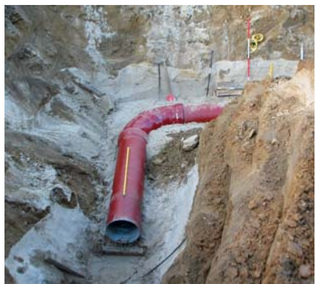
Bild 6: Richtungsänderung mit längskraftschlüssiger NOVO-SIT-Verbindung (Voigt Ingenieure)
