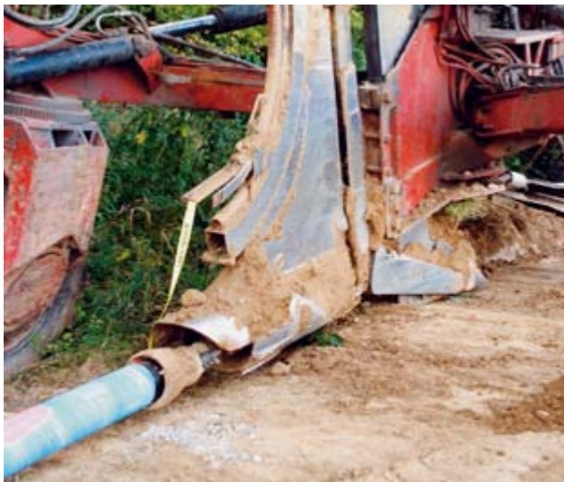
Bild 5: Ankoppeln des Rohrstranges
