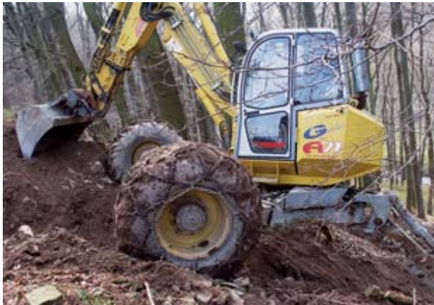
Bild 5: Schreitbagger im Steilhang
