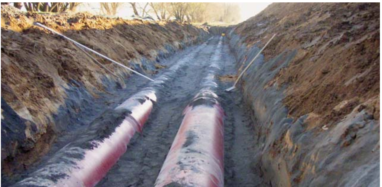
Bild 7: Einbau der Doppelleitung im geböschten Graben
