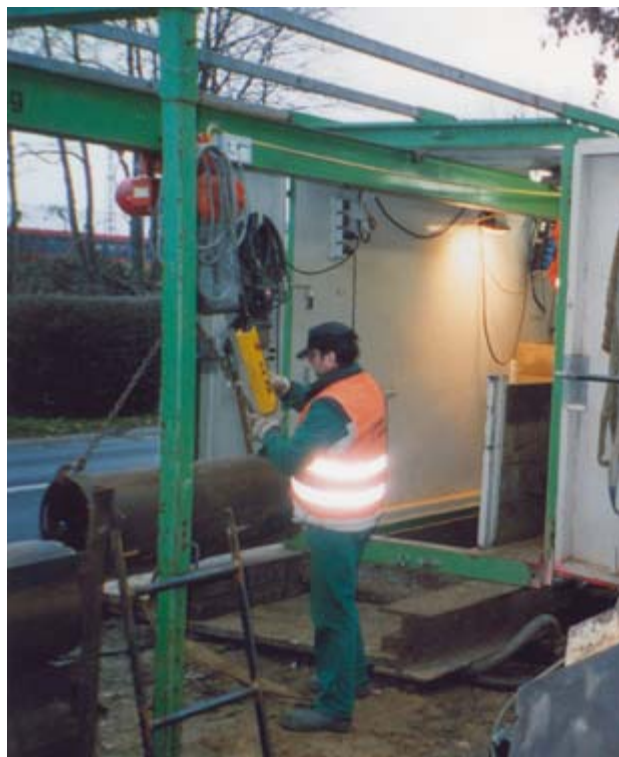
Bild 3: Absenken eines Stahlschutzrohres
