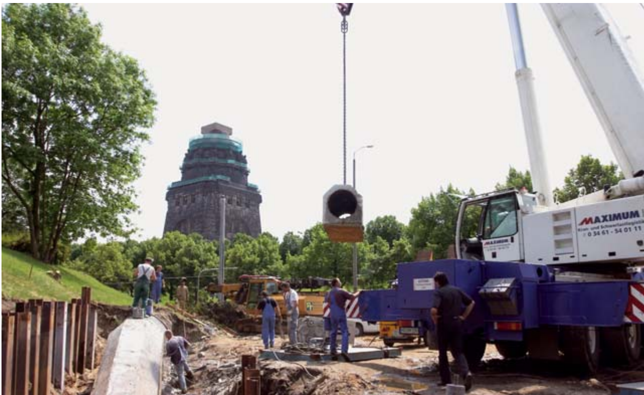
Bild 3: Rückbau des Altrohrsystems (Stahlrohr mit Betonmantel)
