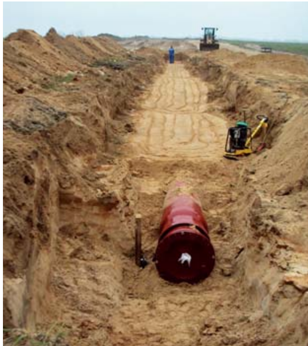
Bild 8: Einbau der Rohre im geböschten Graben (Voigt Ingenieure)
