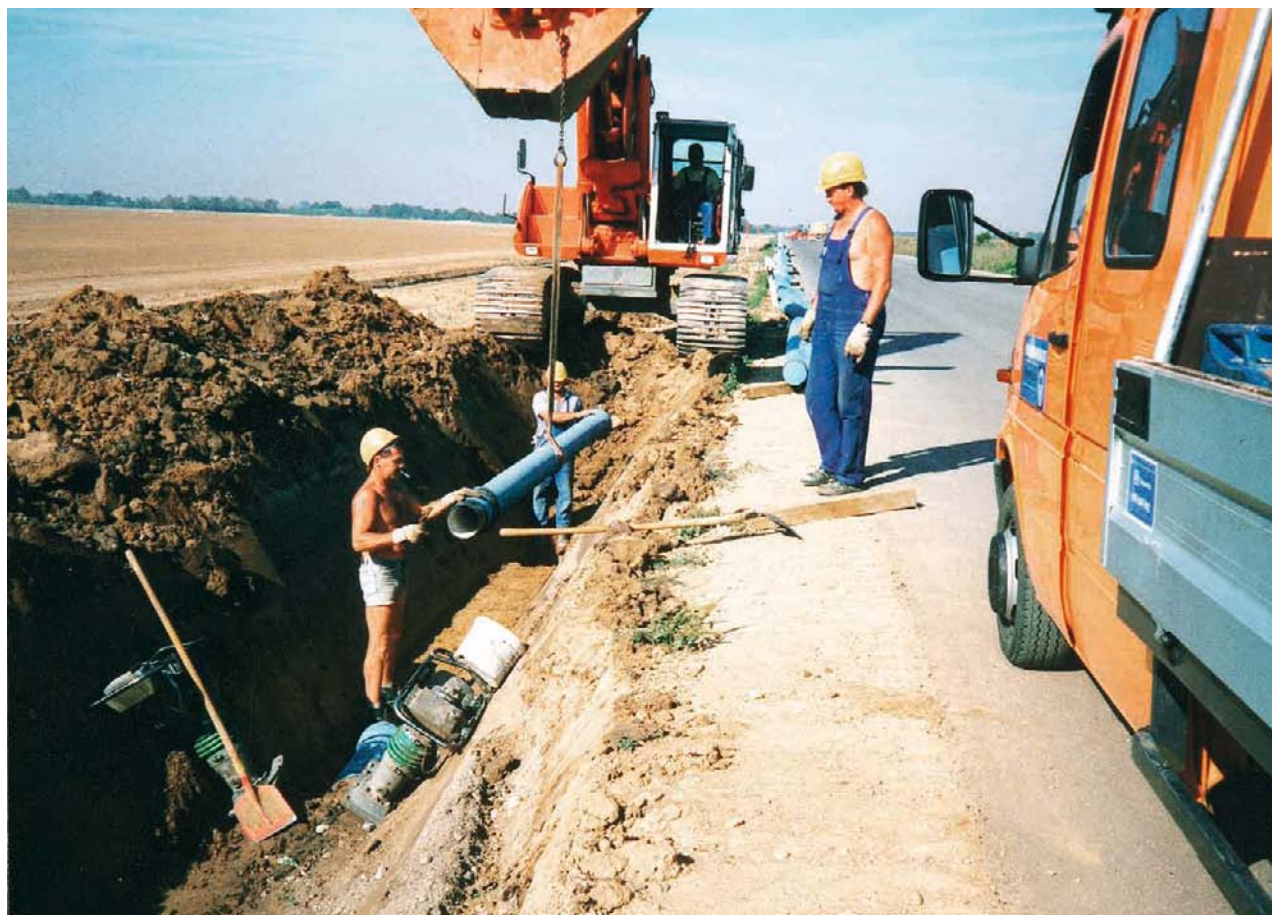
Bild 1 Wiedereinbau des Grabenaushubmaterials
