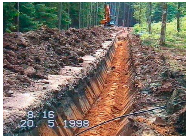
Bild 4 Trapezquerschnitt des Grabens nach Überschüttung der Rohrleitung
