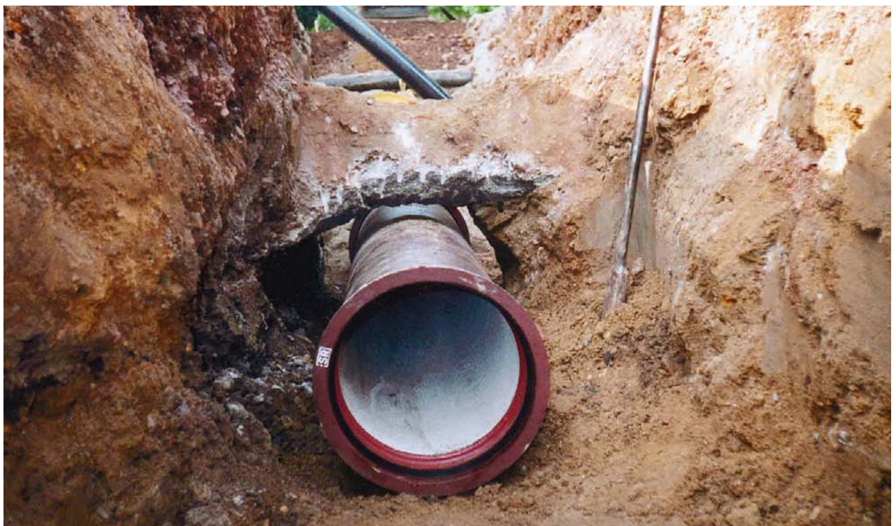
Bild 4 Unterfahrung eines unvorhergesehenen Betonfundaments
