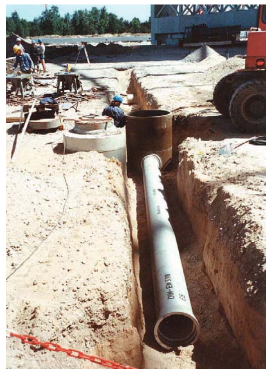
Bild 4 Anbindung von 6 m langen Rohren am Kontrollschacht
