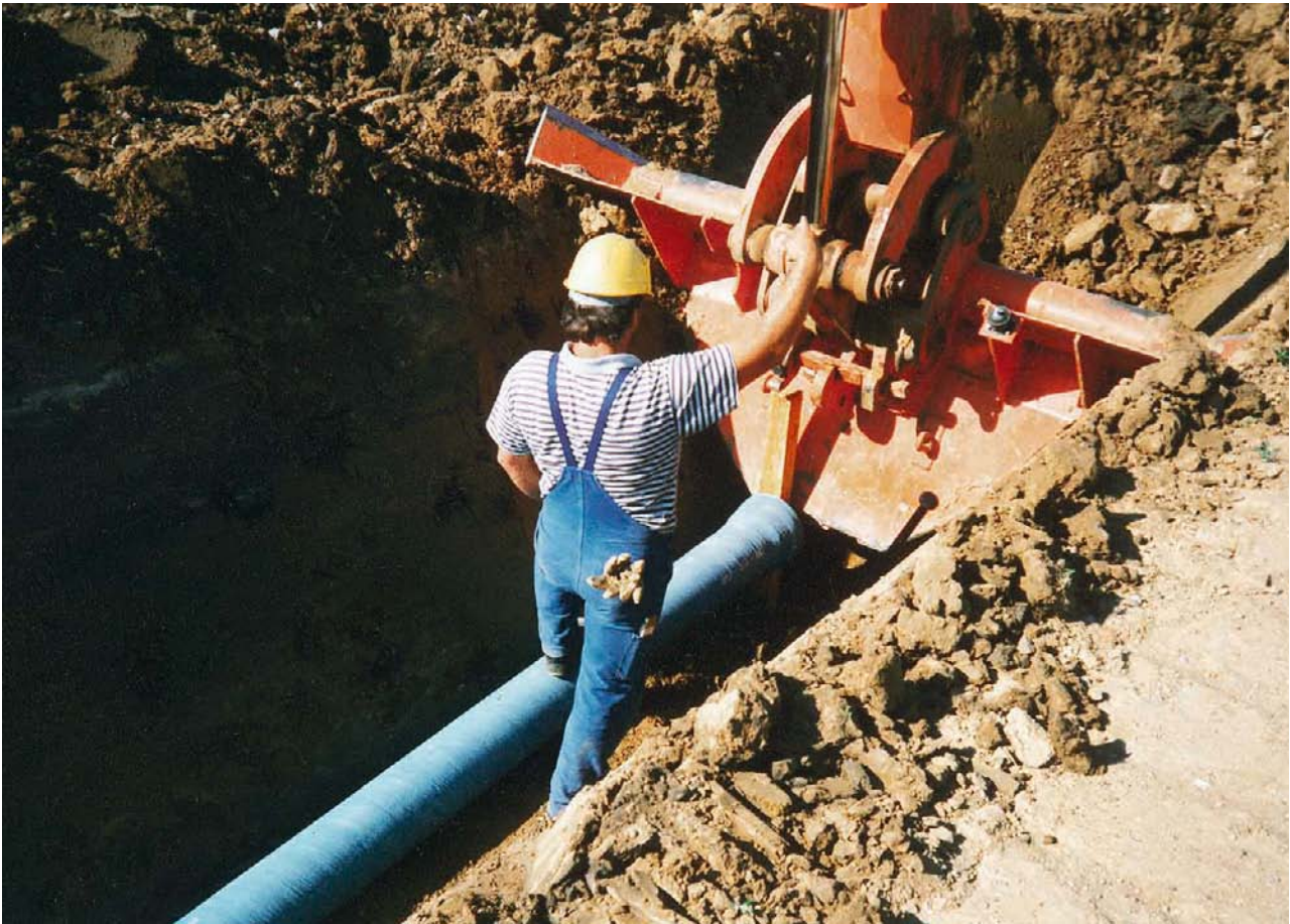
Bild 2 Vorkopf-Einbau der Rohre mit dem Grabenpflug
