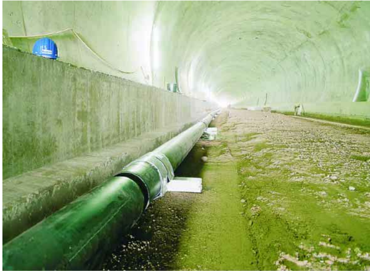
Bild 3 Montage der Feuerlöschleitung
