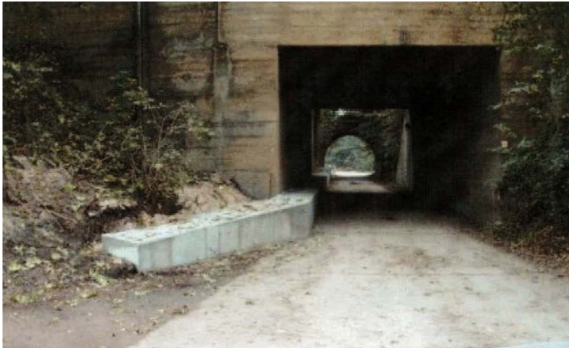
Bild 3 Betonarmierung der oberirdisch liegenden Leitung
