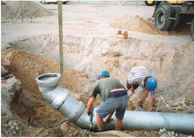
Bild 5 Montage der Doppelmuffenbögen MMK 45° mit dem Montagegerät V 301
