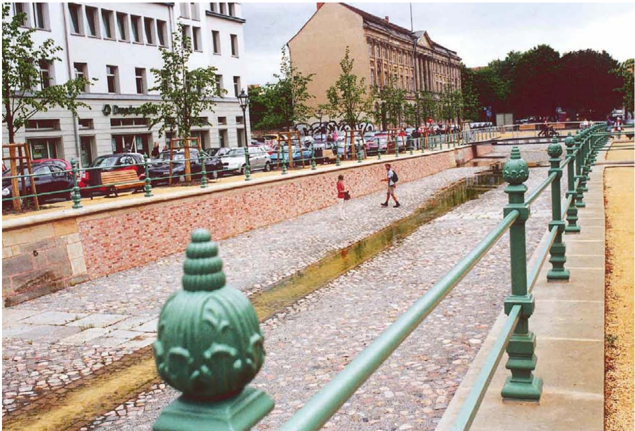
Bild 6 Wiederhergestellter Stadtkanal, Gesamtansicht
