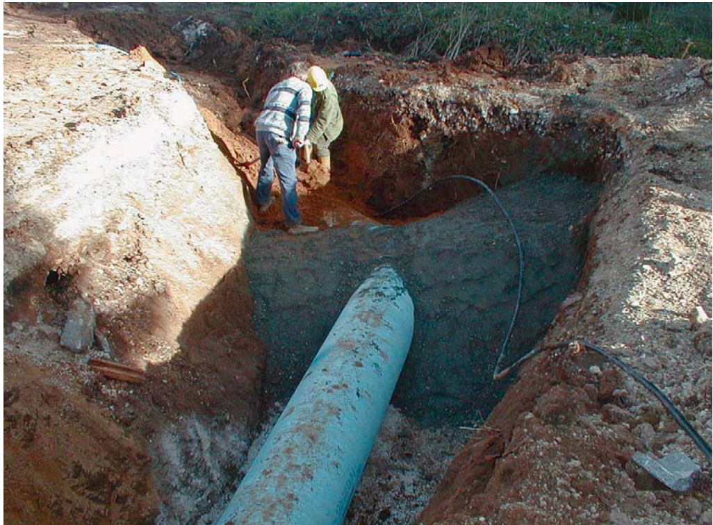
Bild 6 Betonwiderlager an Winkelpunkt
