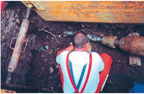
Bild 4 Ankoppeln des Berstkegels an das Berstgestänge
