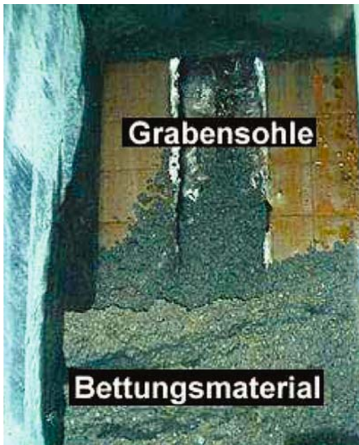
Bild 2 Blick in den Bettungskasten
