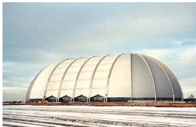
Bild 2 Werfthalle in Brand – Länge: 360 m, Breite: 210 m, Höhe: 107 m
