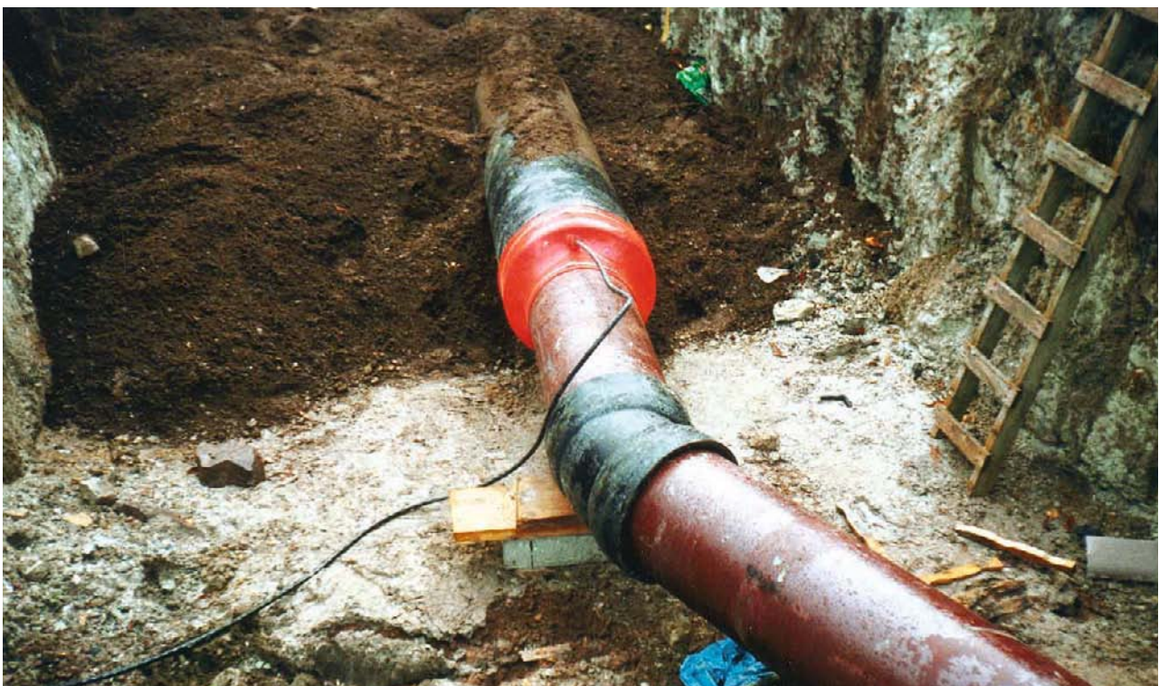
Bild 2 Durchörterung mit Mantelrohren aus Stahl mit PE-Umhüllung
