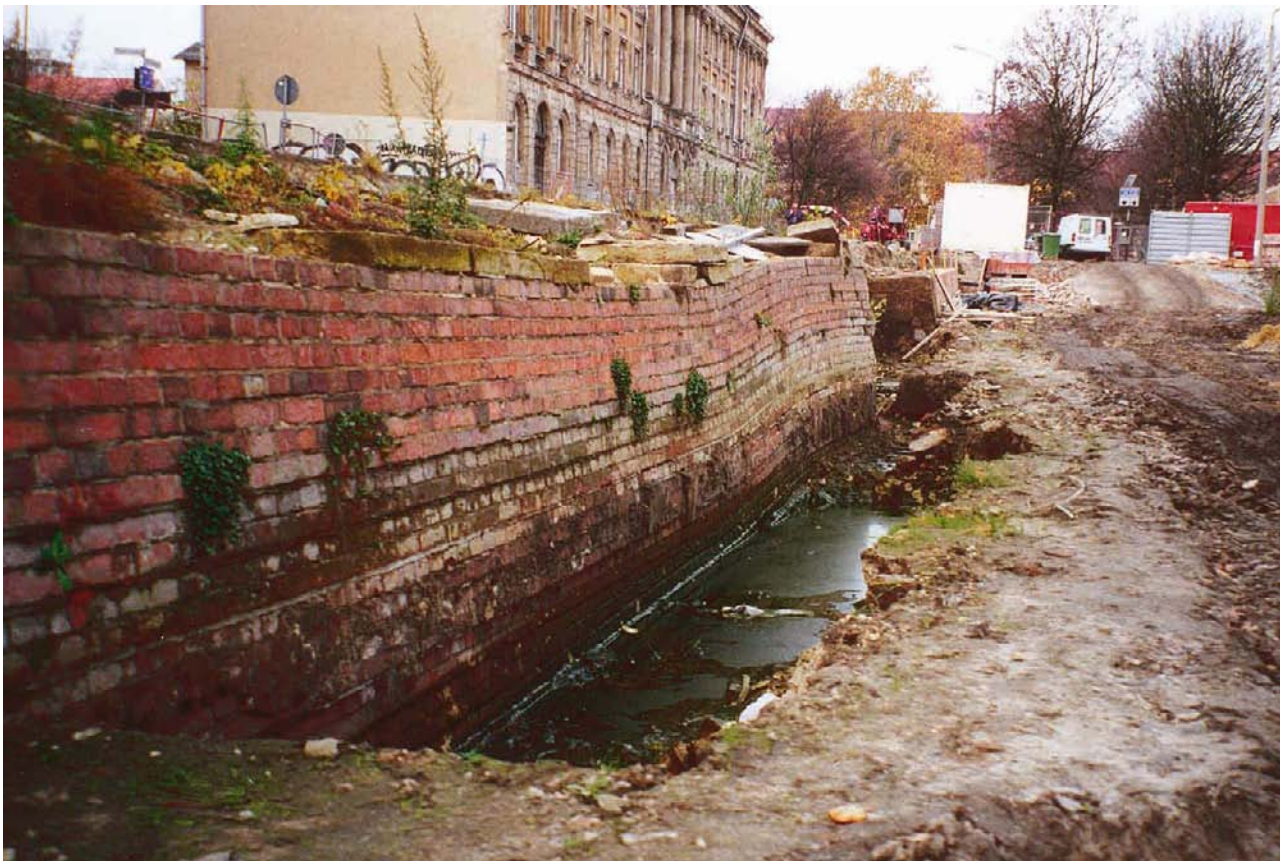
Bild 1 Setzungserscheinungen am Mauerwerk des 300 Jahre alten Stadtkanals
