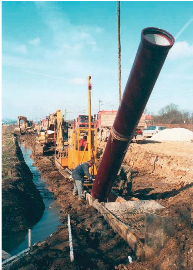
Bild 5 Einfädeln der duktilen Gussrohre in den Rohrkasten
