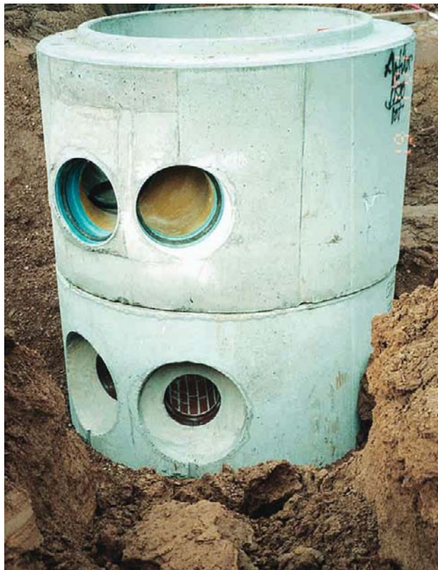
Bild 5 Trennkanaal-Schacht
