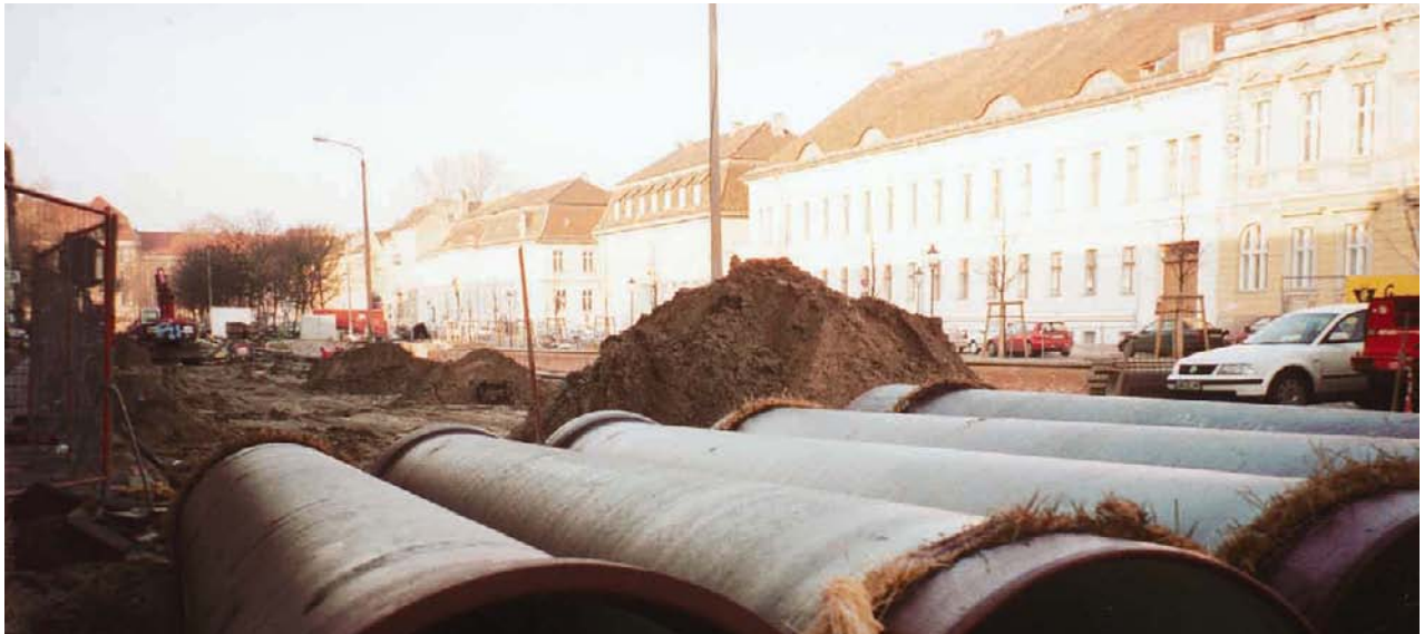
Bild 2 Rohre auf der Baustelle
