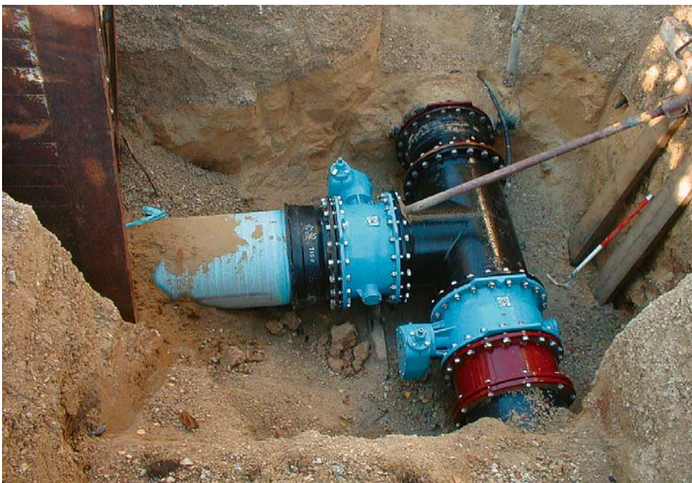
Bild 8 Anbindung an die vorhandene Leitung
