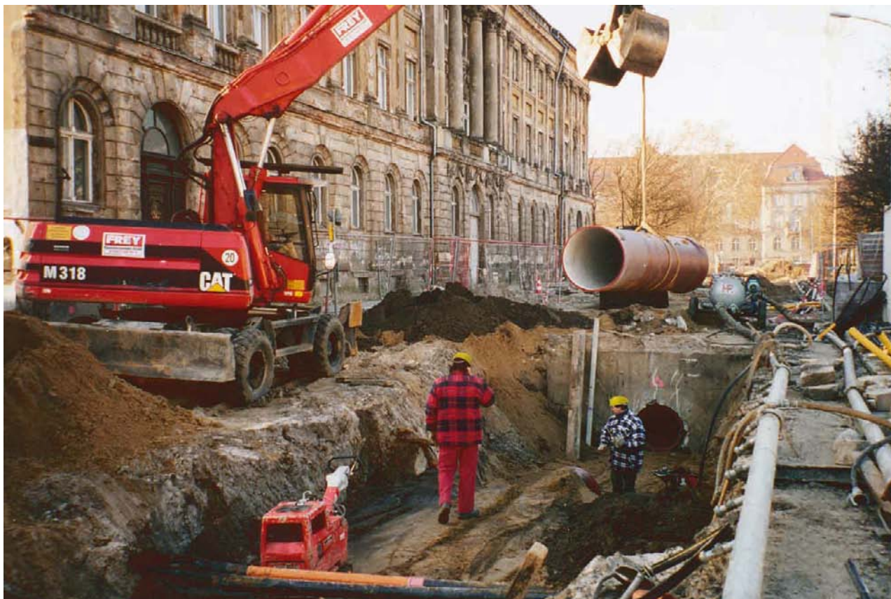
Bild 4 Einbau der Kanalrohre DN 800
