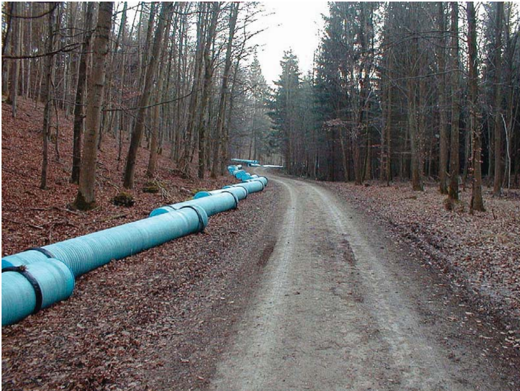
Bild 3 Verstreckte Rohre am Rand eines Waldweges
