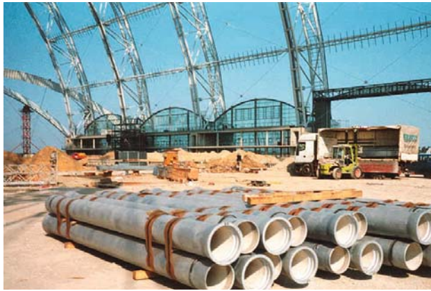
Bild 3 Zwischenlagerung der Rohre auf der Hallenbaustelle
