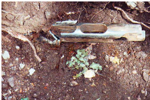
Bild 3 Ankunft des Berstgestänges in der Einziehgrube
