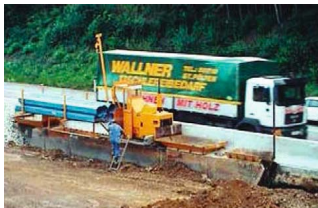
Bild 1 Gesamtansicht des Gleitverbaus PLR
