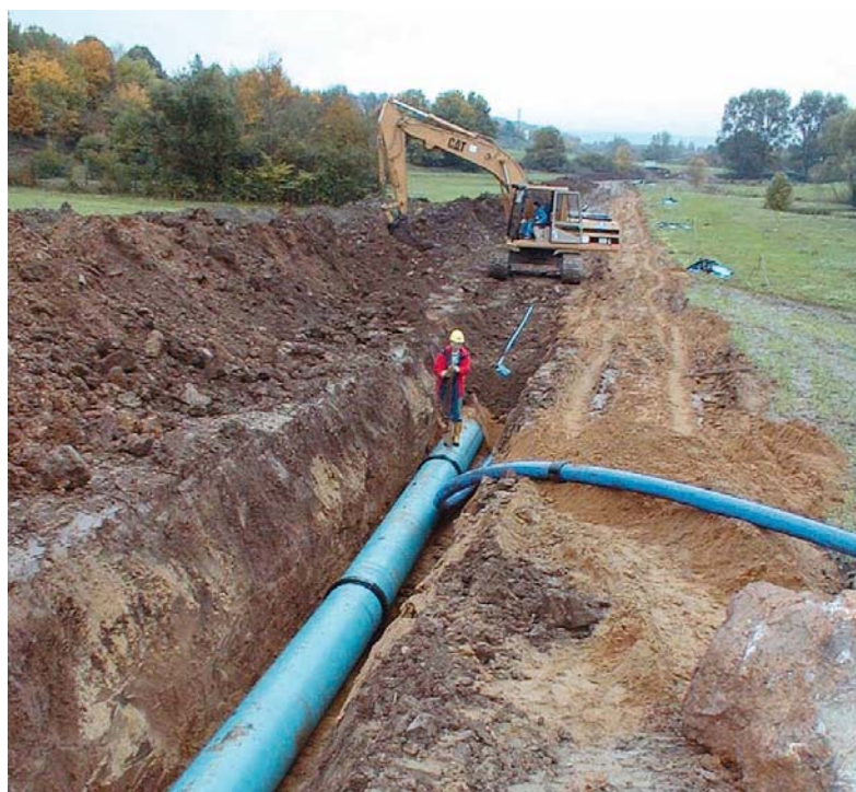
Bild 5 Einbau der mitlaufenden Ortsnetzanschlussleitung
