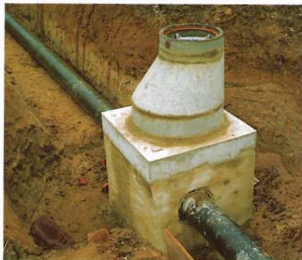
Bild 4: Fertiges Schachtbauwerk mit aufgesetztem Schachthals und Abdeckung
