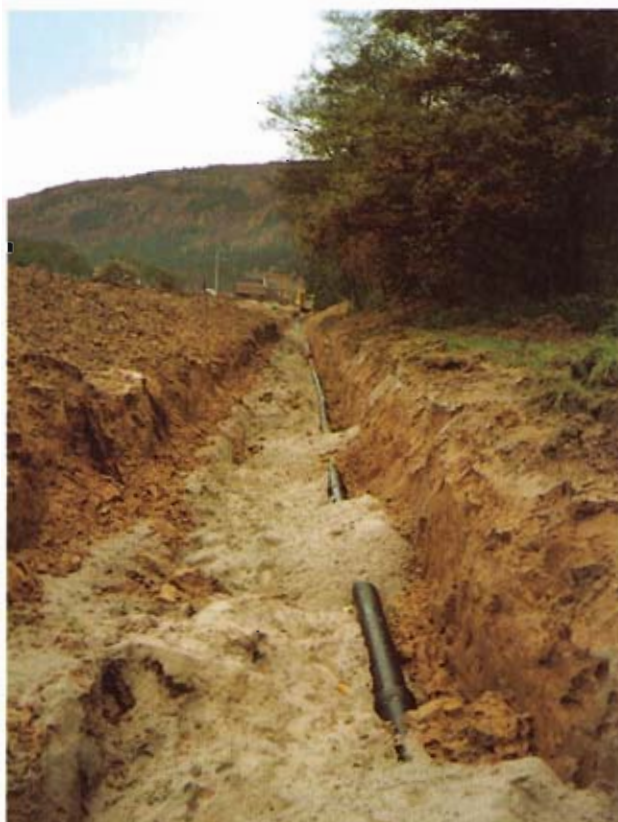
Bild 8: Das duktile Gußrohr der Abwasserleitung ist bereits vollständig mit Sand abgedeckt, das duktile Wasserleitungsrohr ist zur Druckprobe vorbereitet
