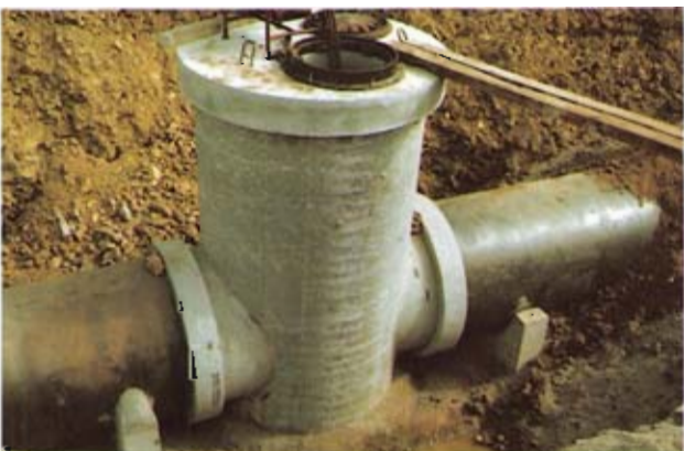
Bild 8: Schacht mit Bodenplatte und Auflager
