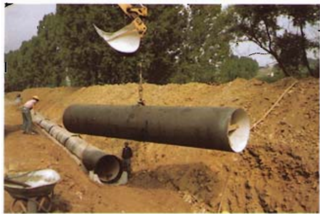
Bild 9: Ablassen des Rohres in den Graben; unter dem verlegten Rohr ist das Rohraufleger ersichtlich
