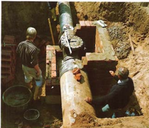
Bild 3: Herstellung eines Schachtbauwerkes mit Reinigungsöffnung
