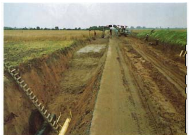
Bild 2: Verfüllen des Rohrgrabens
