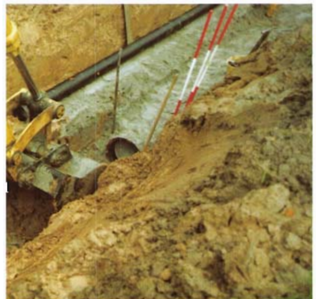
Bild 7: Nach Verlegung und Absandung der duktilen Abwasser- und Wasserleitungsrohre erfolgt der weitere Rohrgrabenaushub
