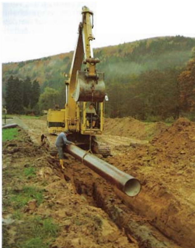
Bild 6: Verlegung des duktilen Gußrohres im Stufengraben vor Verlegung der Gas- und Wasserleitung
