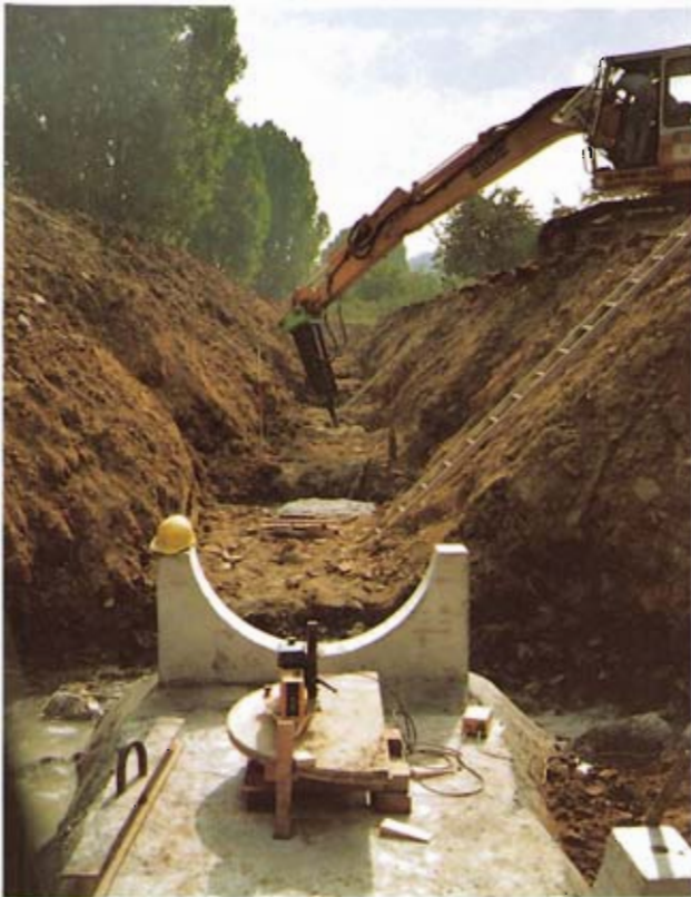
Bild 7: Pfahlkopf mit Rohraufleger
