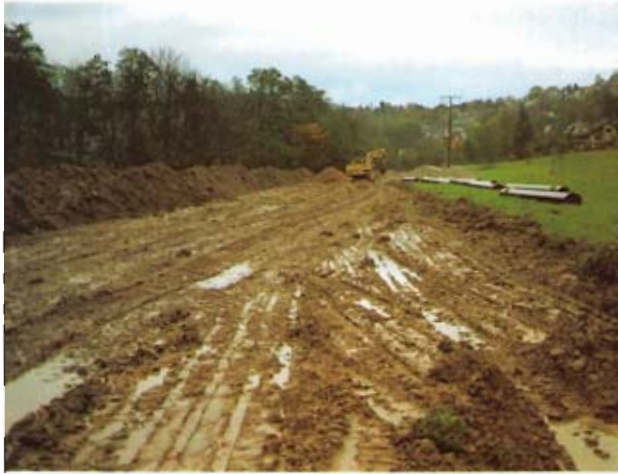
Bild 5: Das Gelände im Wasserschutzgebiet der engeren Schutzzone (Zone II) nach Abtrag des Mutterbodens und Längsverteilung der duktilen Gußrohre
