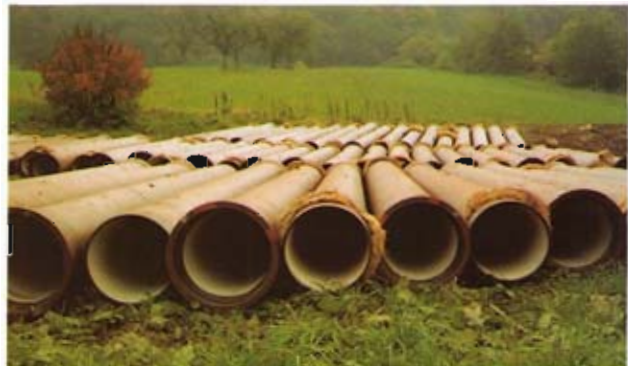
Bild 3: Lagerung der duktilen Gußrohre im Baugelände vor der Rohrverlegung
