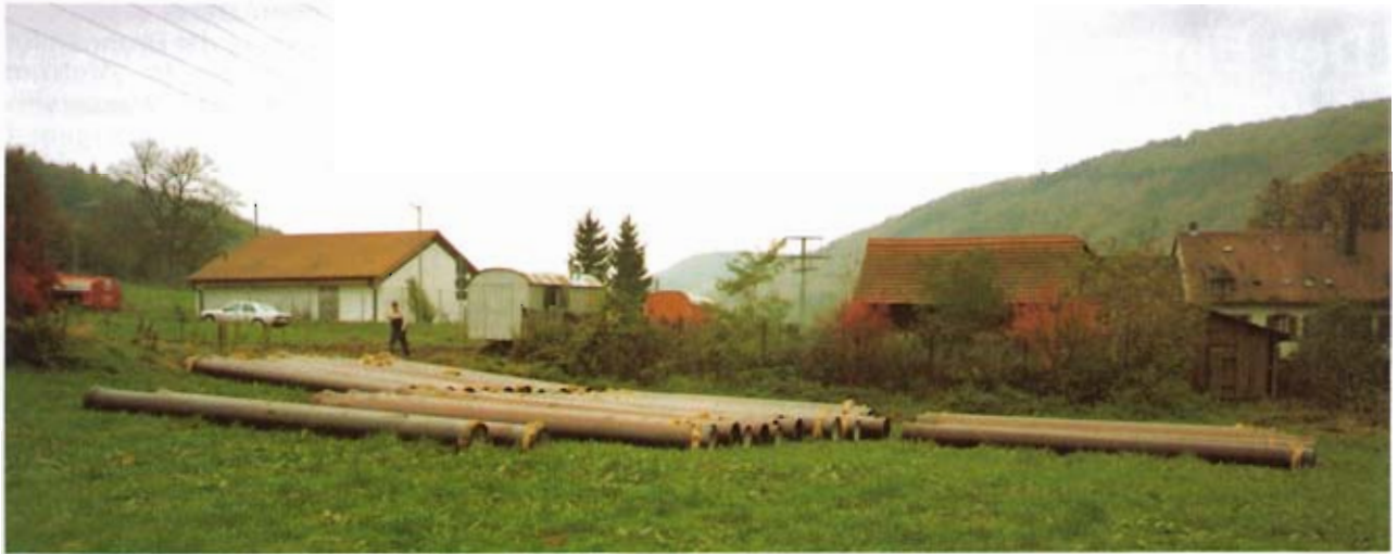
Bild 2: Zwischen den beiden Tiefbrunnen liegt rechts das Gebiet der ehemaligen Mühle und links die Pumpstation mit Wasseraufbereitungsanlage der Stadtwerke
