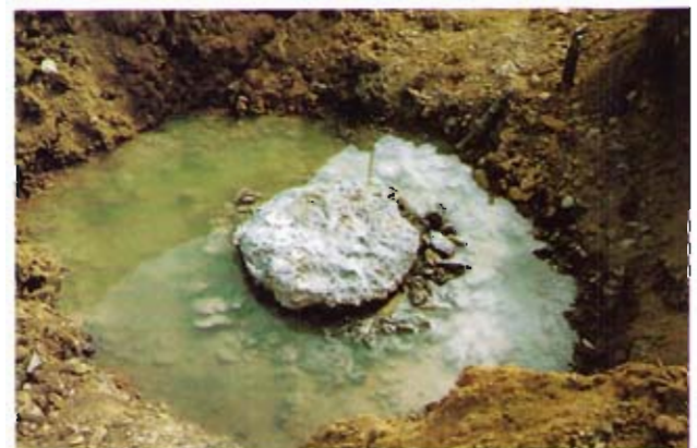
Bild 6: Pfahlkopf im Grundwasser
