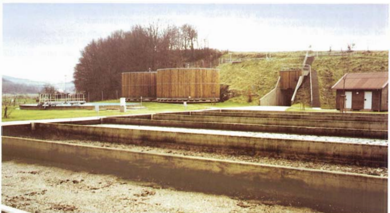
Bild 2: Kläranlage Unteres Werratal; mechanisch-biologische Anlage. 4400 Einwohnergleichwerte (EGW)
