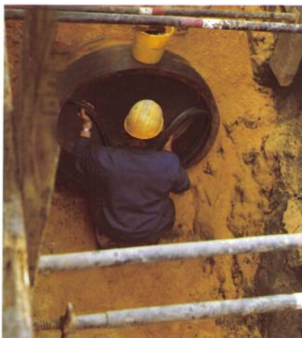
Bild 2: Einlegen eines TYTON®-Ringes während der Verlegung einer Leitung
