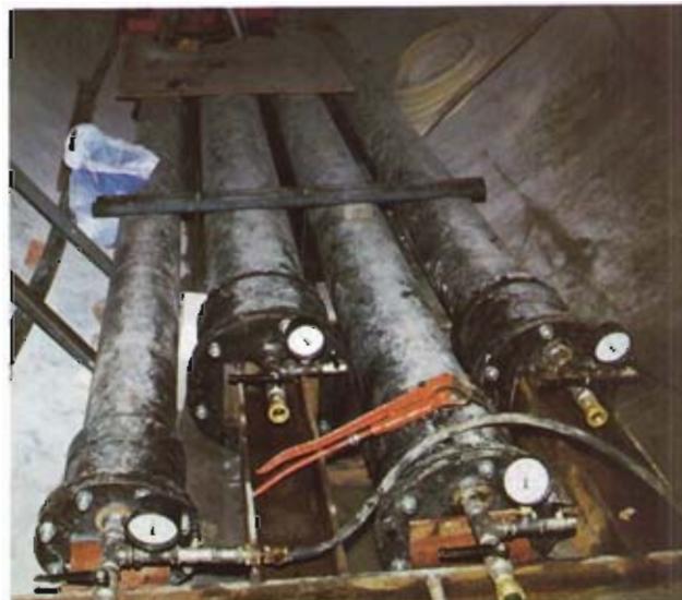
Bild 5: Druckprobe im Horizontalstollen
