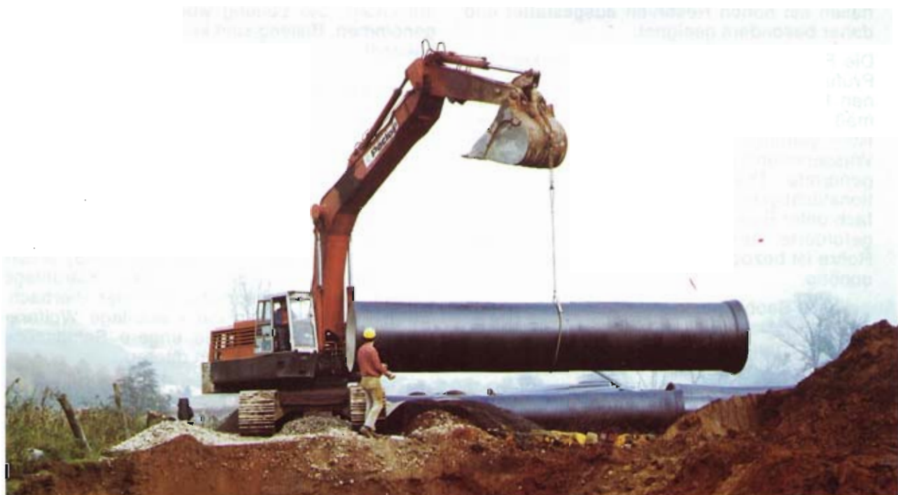
Bild 1: Verlegung duktiler Gußrohre DN 1400 bei der Abwasserentsorgung Mittleres Bliestal
