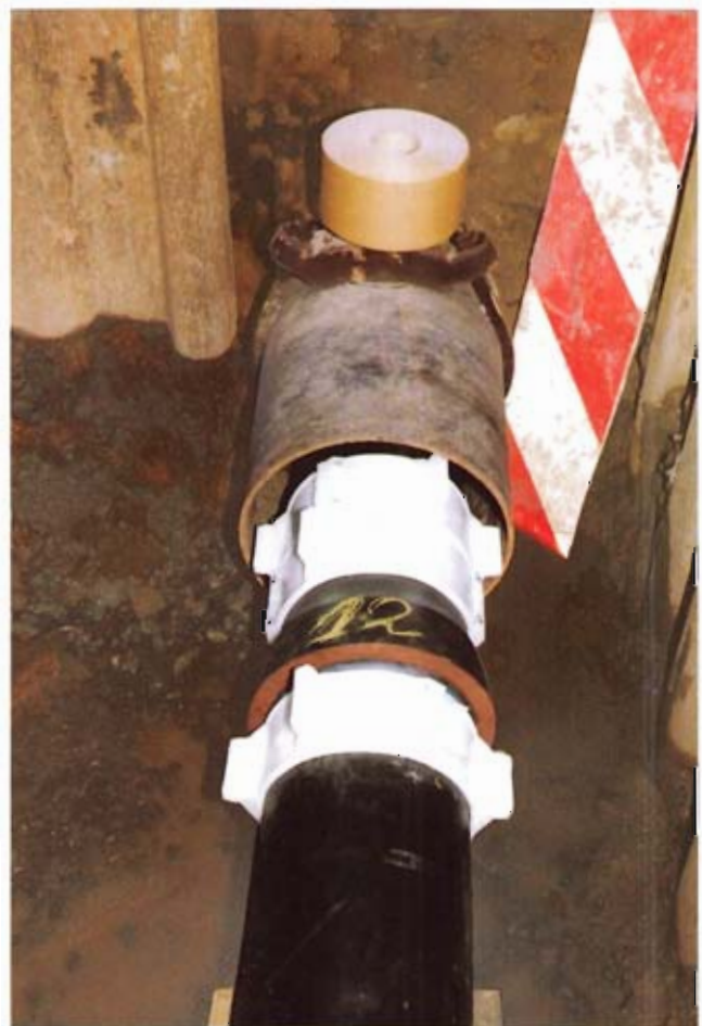
Bild 4: Drei Gleitkufen je Rohr
