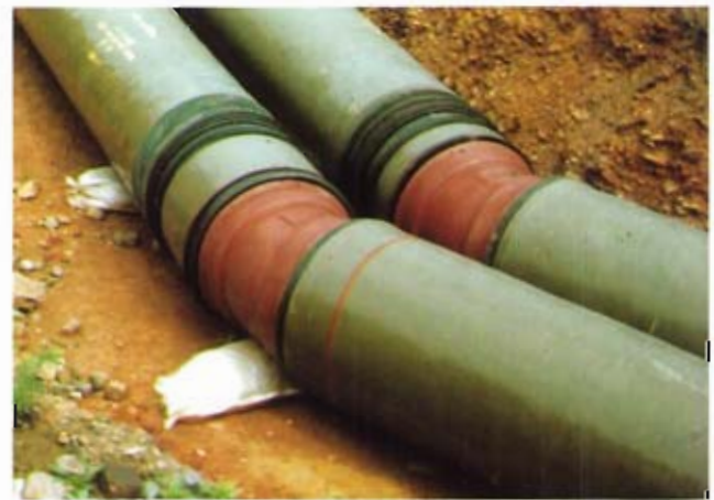
Bild 9: Einbau von Bogen
