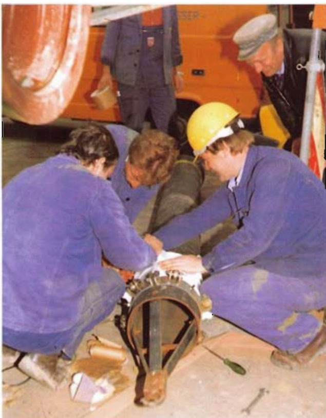
Bild 3: Führungsrohr mit Stahlgleitkufe und Zuganker
