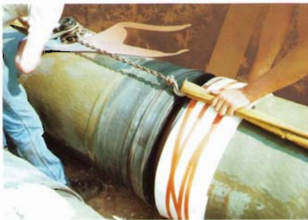
Bild 5: Einhängen der Zugratsche und Zusammenziehen der Leitung
