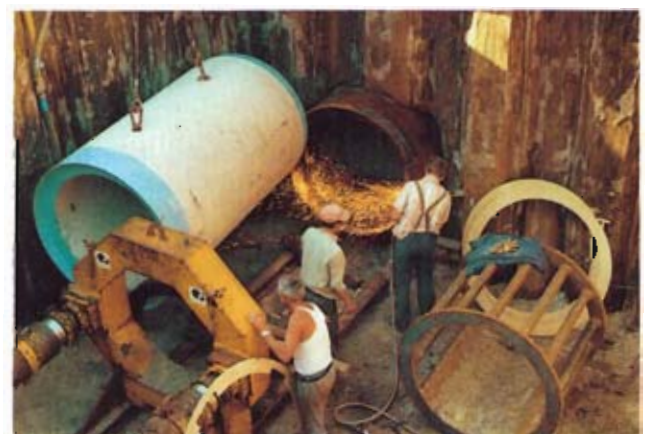
Bild 3: Vor der Durchpressung der B 188: Schweißung einer Aussparung in die Spundwand für den Schneidkopf und Montage des ersten Stahlbetonpreßrohres DN 1200
