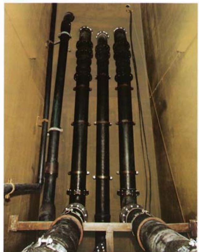
Bild 10: Blick von der Vorpreßstrecke in den Zielschacht
