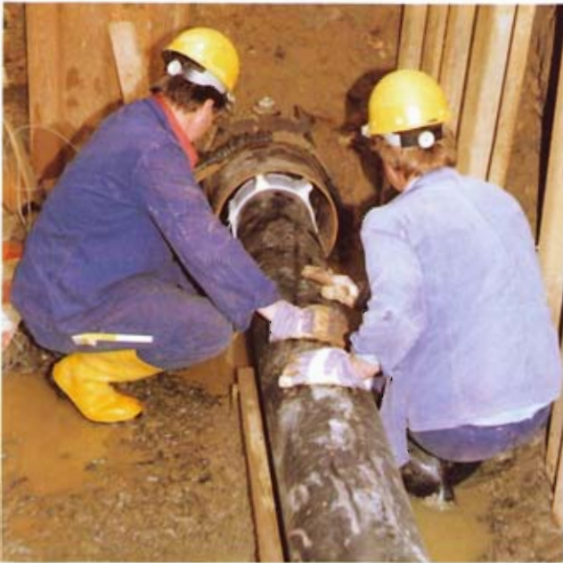
Bild 2: Einziehen des Versuchsrohres DN 250
