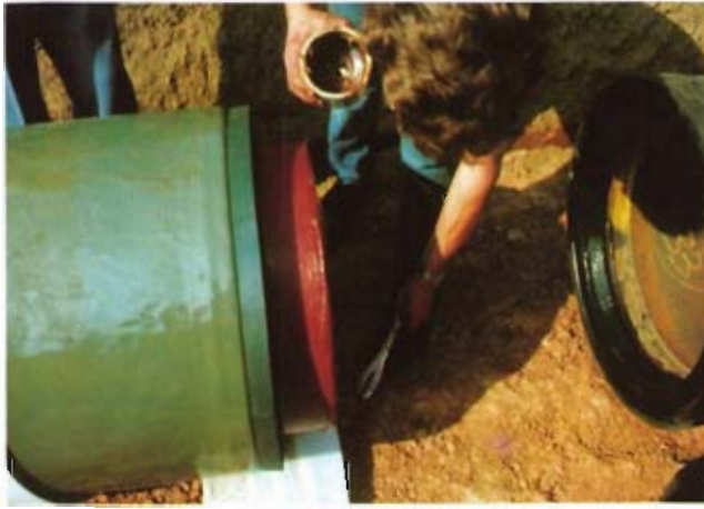
Bild 4: Vorbereiten der Verbindung: Gummiring einlegen, Ring und Spitzende einschmieren.
