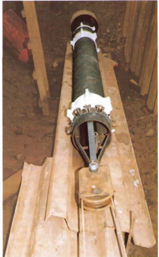
Bild 6: Führungsrohr nach dem Durchziehen
