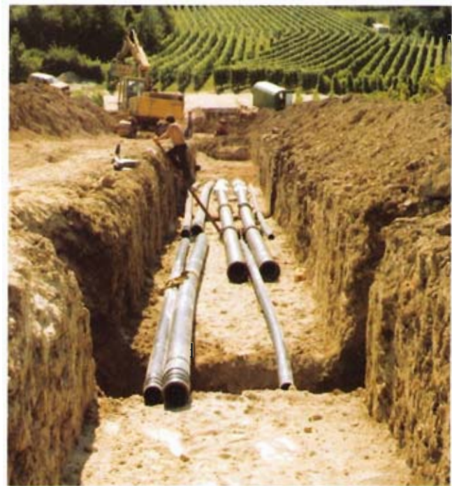
Bild 13: Verlegung der Rohre am Hang des Wartbergs
