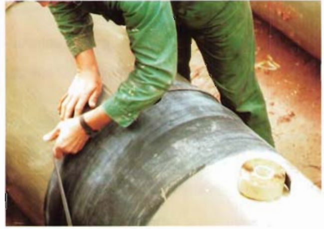
Bild 7: Umklappen der Dichtmanschette und Befestigen mit dem Spannband
