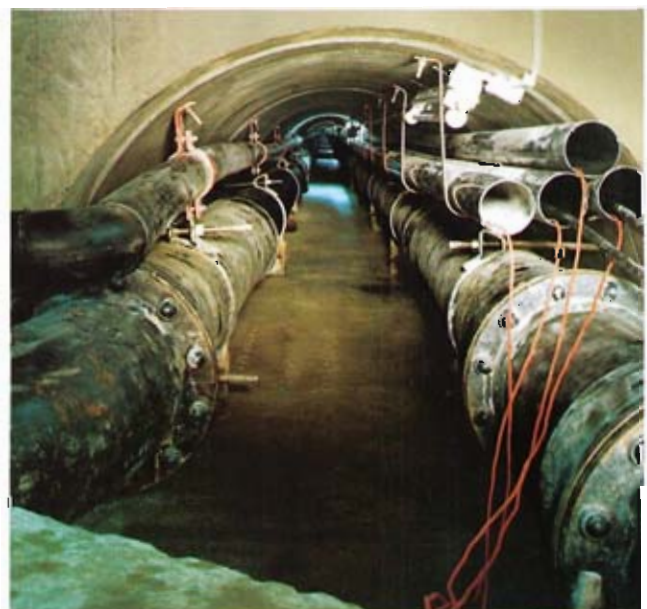
Bild 14: Anordnung der Rohrleitungen in der Vorpreßstrecke
