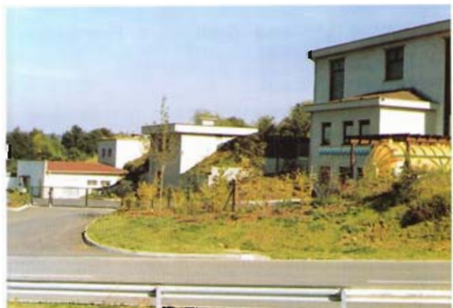
Bild 4: Außenansicht von Aufbereitungsgebäude und Reinwasserspeicher
