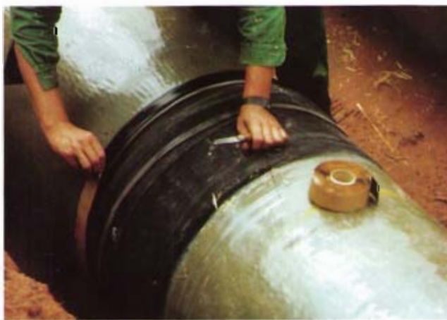
Bild 6: Anbringen des dauerplastischen Dichtbandes
