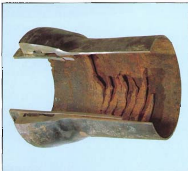
Bild 4: Muffenrohrstück DN300 mit hineingepreßtem Einsteckende
