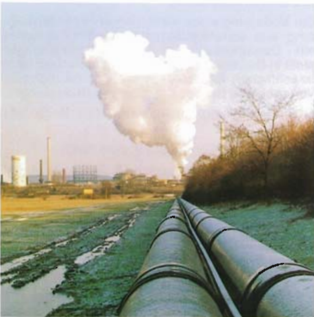
Bild 11: Verlegte Leitung mit Zuganker
