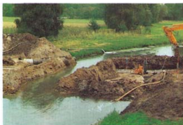
Bild 6: Allerkreuzung: Teilweise Öffnung des Erddammes nach abgeschlossener Rohrverlegung. Davor Sicherung der Rohrleitungen mit Betonplatten gegen Auftrieb und mechanische Beschädigungen
