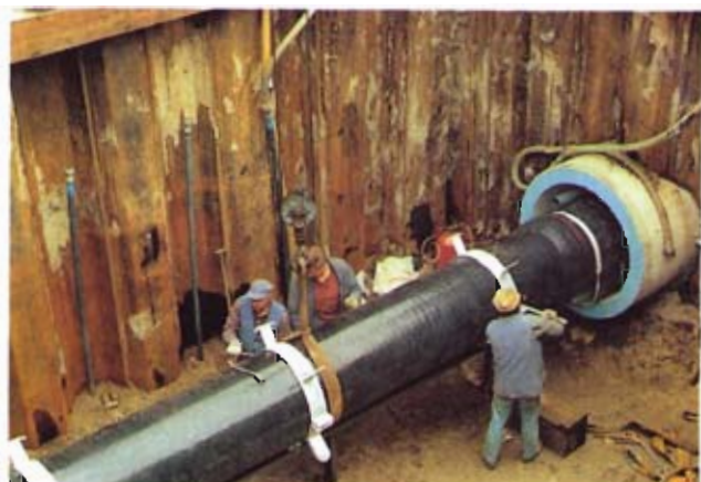
Bild 4: Einziehen des Medienrohres DN 700 und Montage des Schlittens zur zentrischen Fixierung der Leitung im Preßrohr DN 1200
