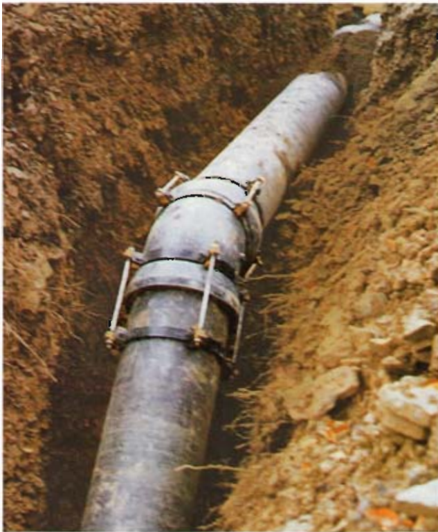
Bild 5: Transportleitung DN 500 Sicherung eines Überbogens
