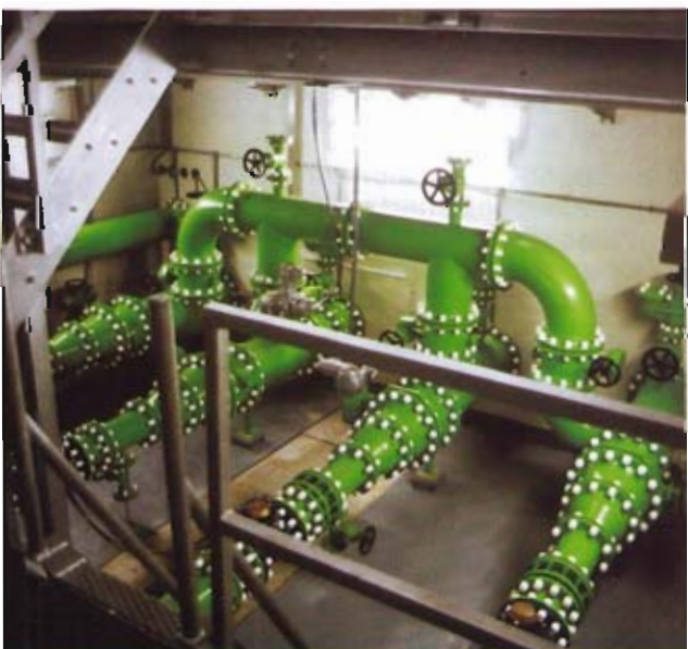
Bild 4: Rohrinstallation im Hochbehälter Brunnscheid
