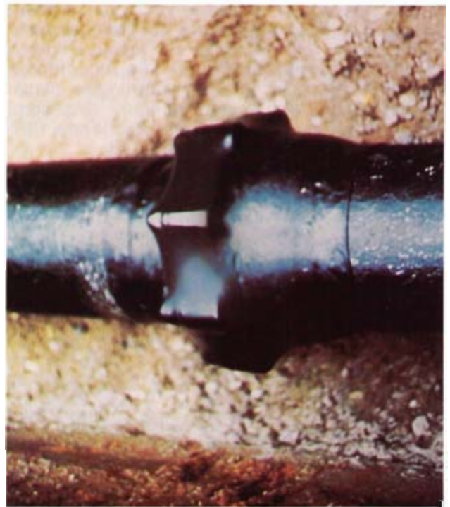
Bild 9: Schutz einer TYS-Verbindung
