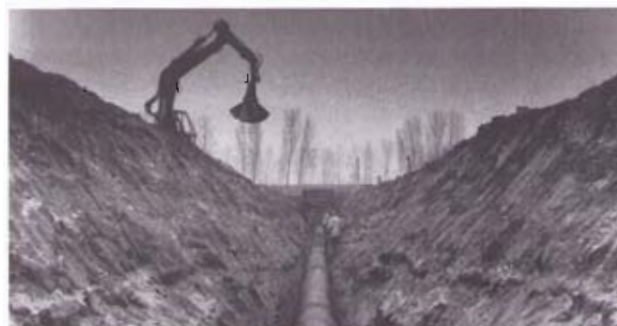
Bild 5: Verlegung der Dükerleitung auf der rechten Neckarseite
