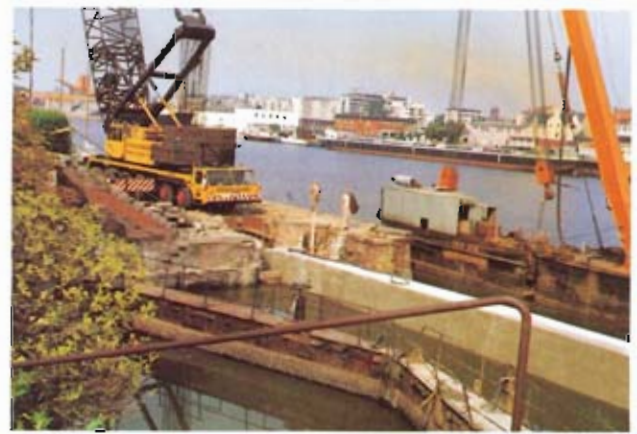
Bild 9: Altes Schleusentor und abgesenkte Rohrbrücke
