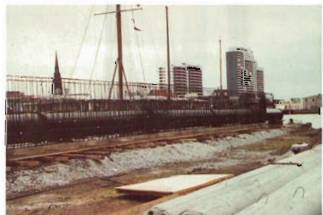
Bild 7: Stahlbewehrung der Rohrbrücke
