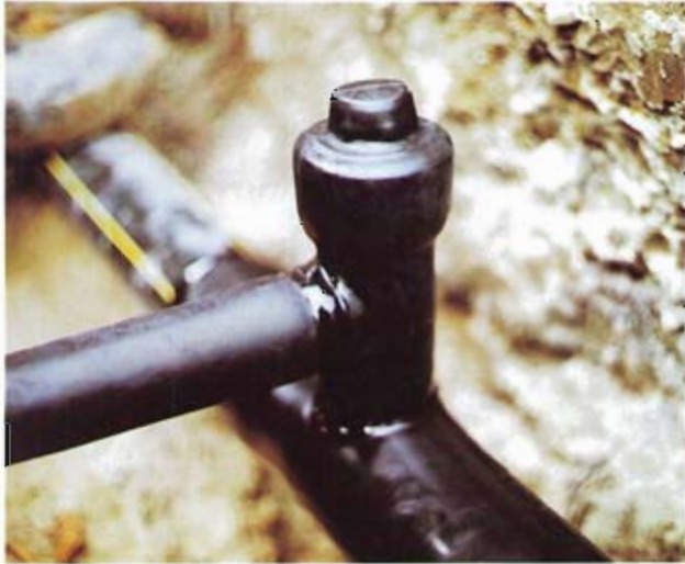
Bild 10: Schutz eines Anschweißstutzens
