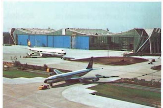
Bild 3: Flugzeugwartungshalle V Nutzer: Deutsche Lufthansa Länge: 320 m; Tiefe: 100 m; Höhe: 34 m
