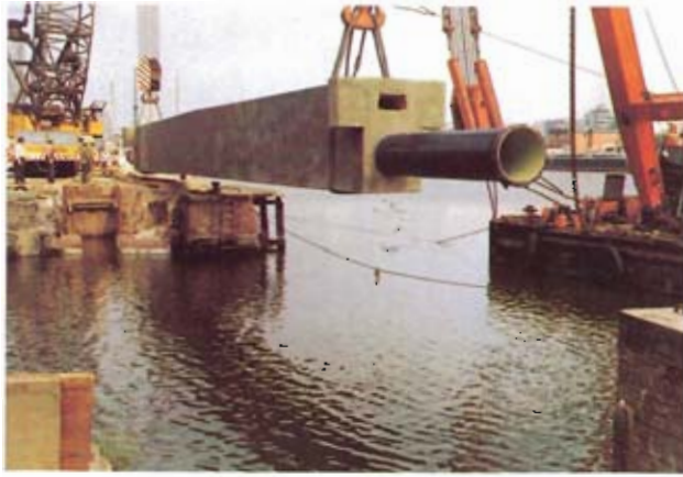
Bild 8: Einheben der Rohrbrücke
