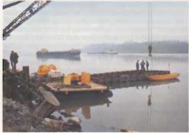
Bild 7: Übergabebauwerk mit Auslaufleitung in den Rhein
