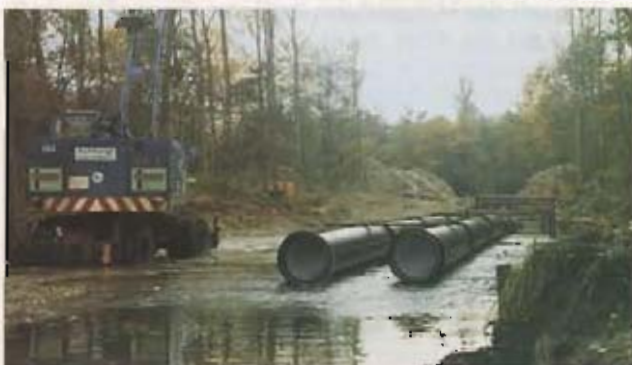
Bild 3: Montage der Leitung auf den Traversen
