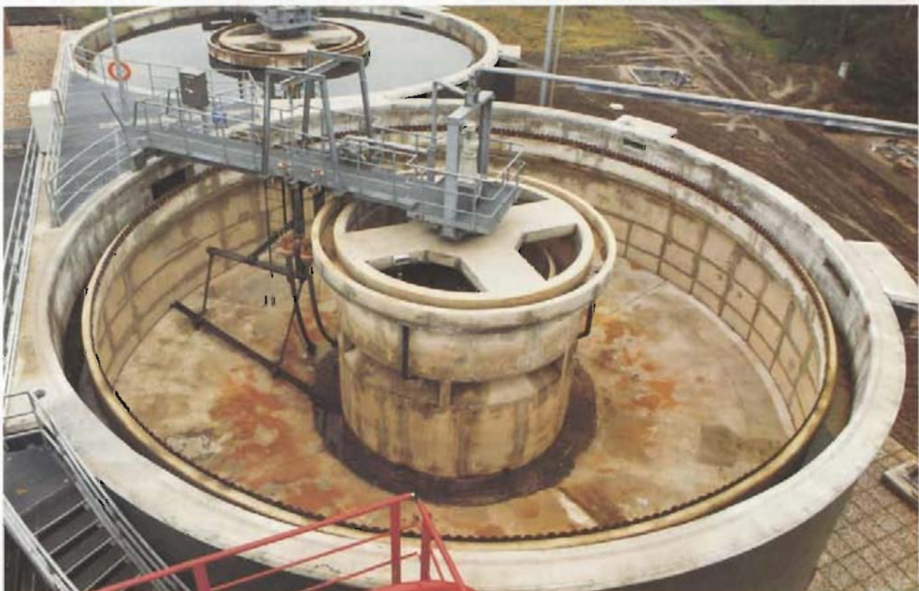
Bild 4: Reaktionsbehälter und Sedimentationsbecken
