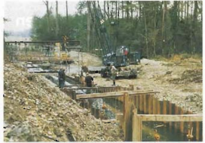
Bild 4: Absenken der Leitung
