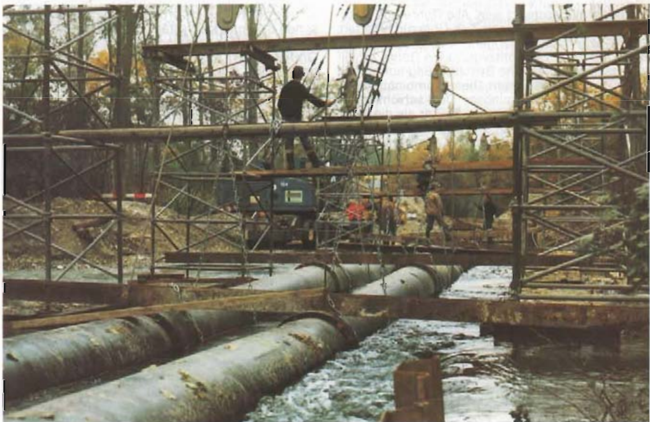
Bild 6: Einschwimmen der Leitung im Altrhein
