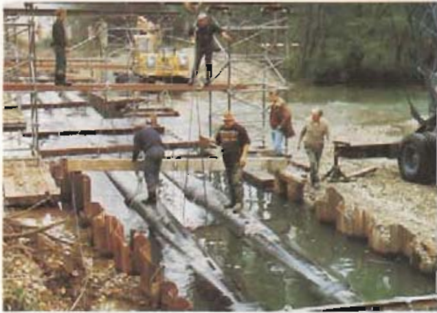
Bild 5: Hilfskonstruktion zur Absenkung der Rohre
