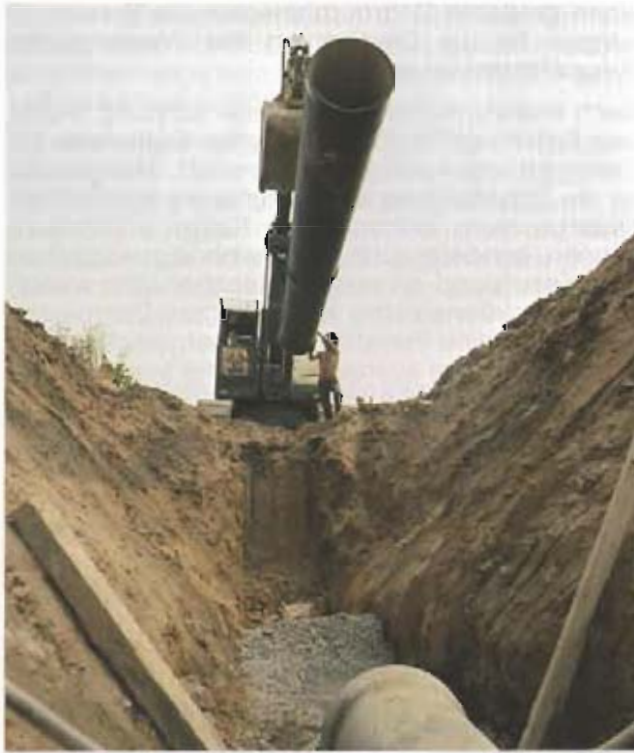
Bild 5: Verlegung duktiler Gußrohre DN 500 für die Niestefalleitung
