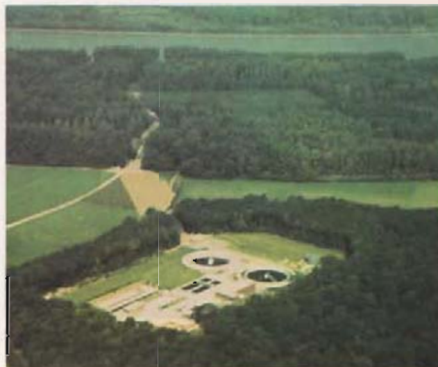
Bild 1: Kläranlage mit Trasse zum Rhein
