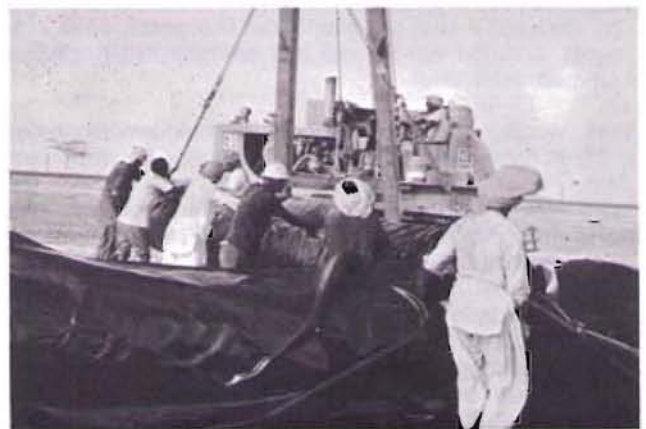
Bild 2: Verkleben der aufgezogenen PE-Schlauchfolie mit Klebebändern
