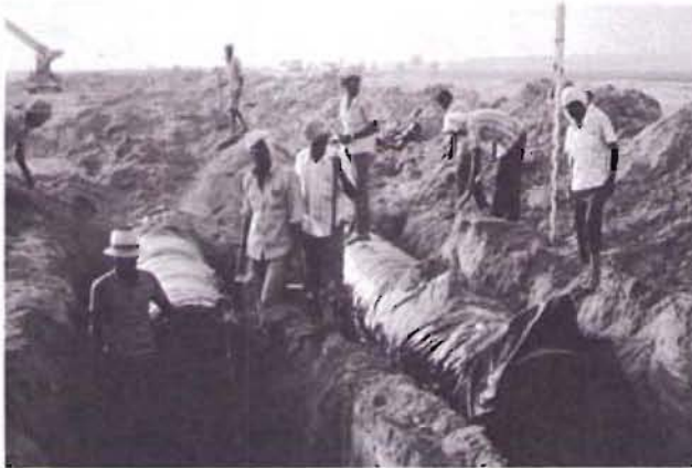
Bild 6: Verfüllen der ersten Lage
