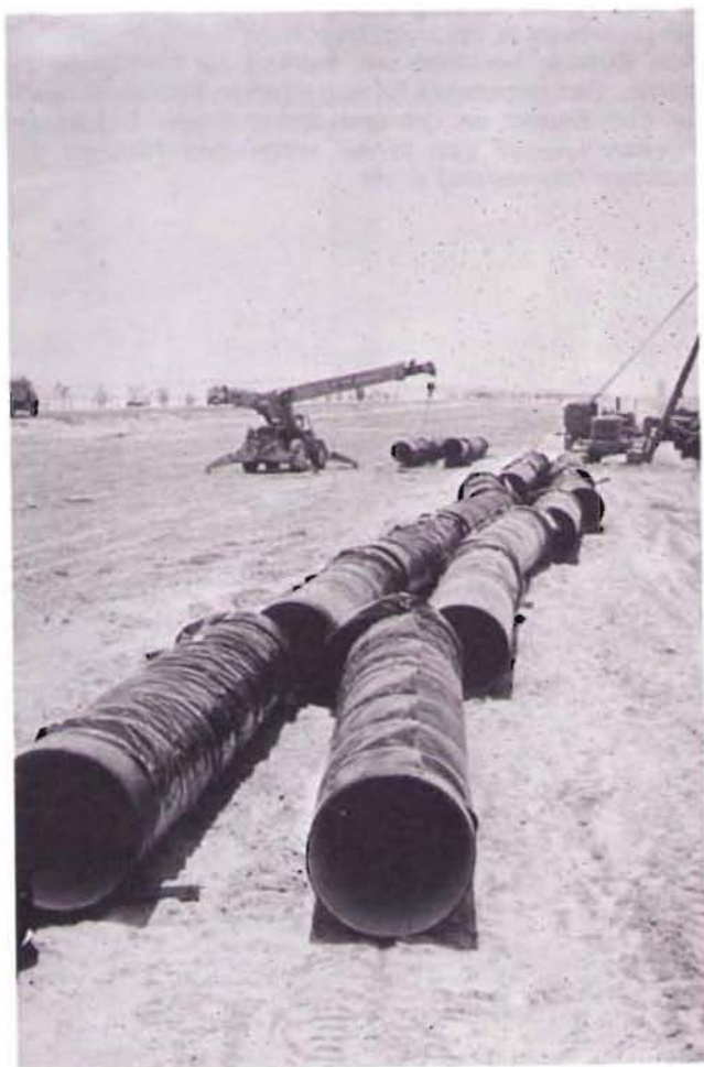
Bild 3: Zur Verlegung vorbereitete Rohre, mit PE-Schlauchfolie umhüllt
