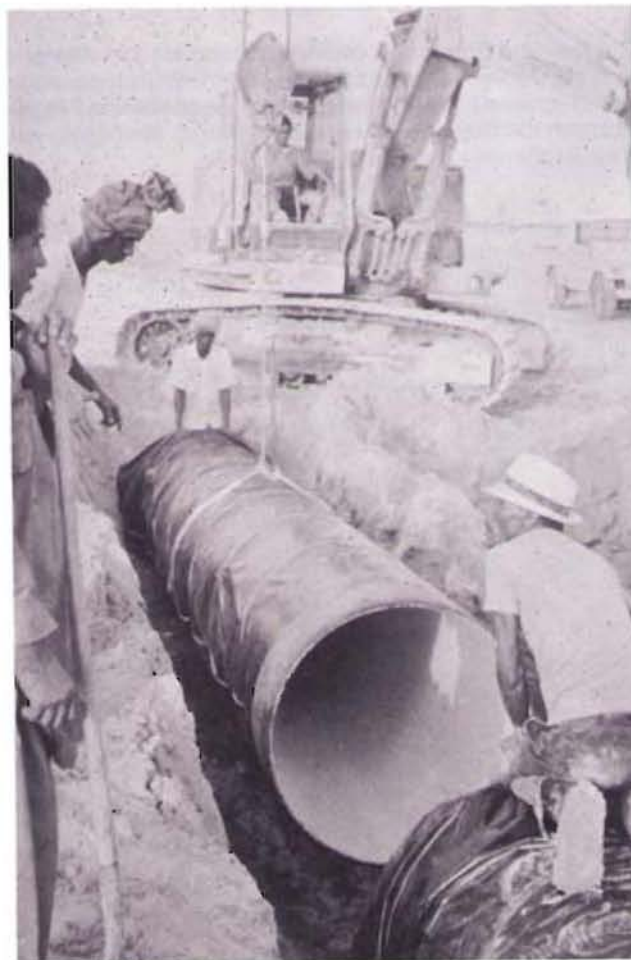
Bild 5: Ausrichten eines Rohres zum Einschub mit der Baggerschaufel
