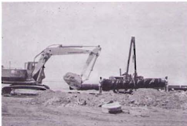
Bild 4: Verlegefahrzeug mit Seitenbaum und Bagger
