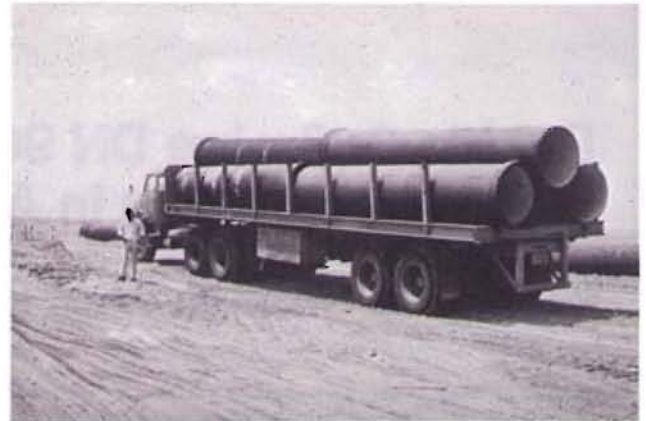
Bild 1: Rohrtransport vom Zwischenlager zur Trasse
