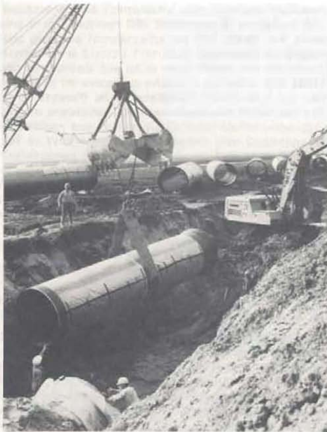
Bild 4: Verlegung von Großrohren, mit Folienbahnen als Sonderschutz
