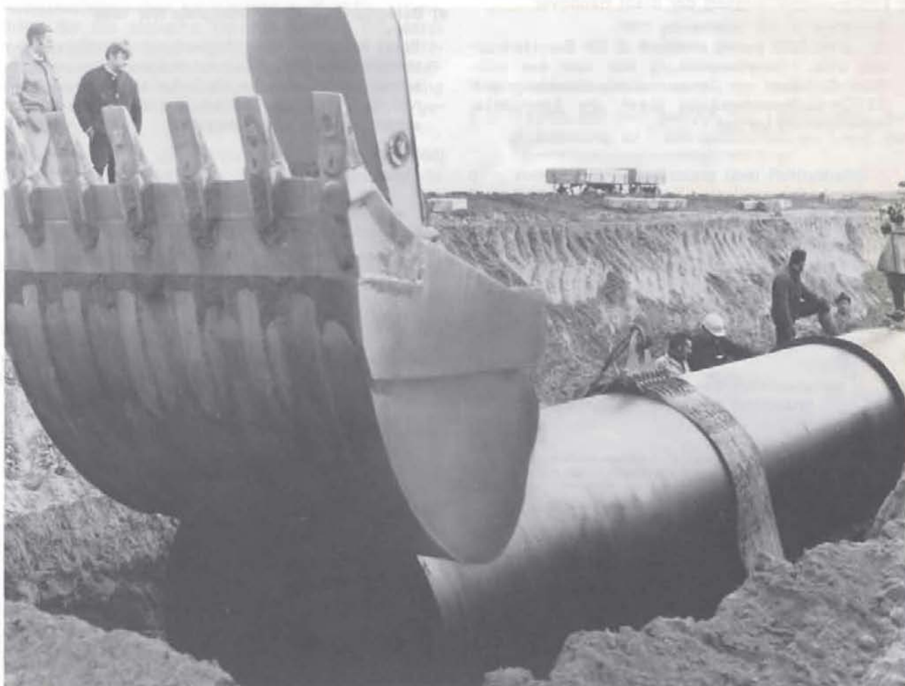
Bild 5: Verlegung von Großrohren mittels Baggerlöffel
