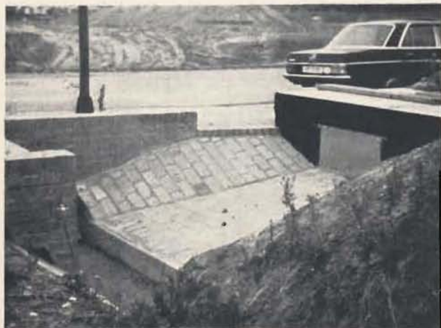
Bild 7: Überlaufbauwerk mit Rückschlagklappe
