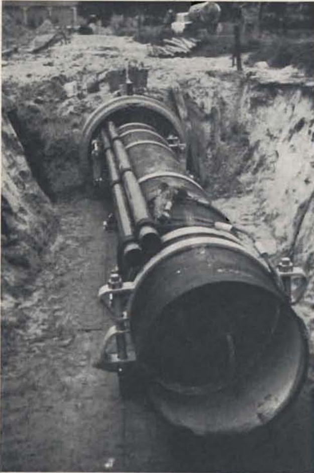
Bild 5: Straßenkreuzung mit eingezogenem Produktenrohr und Kabelschutzrohren
