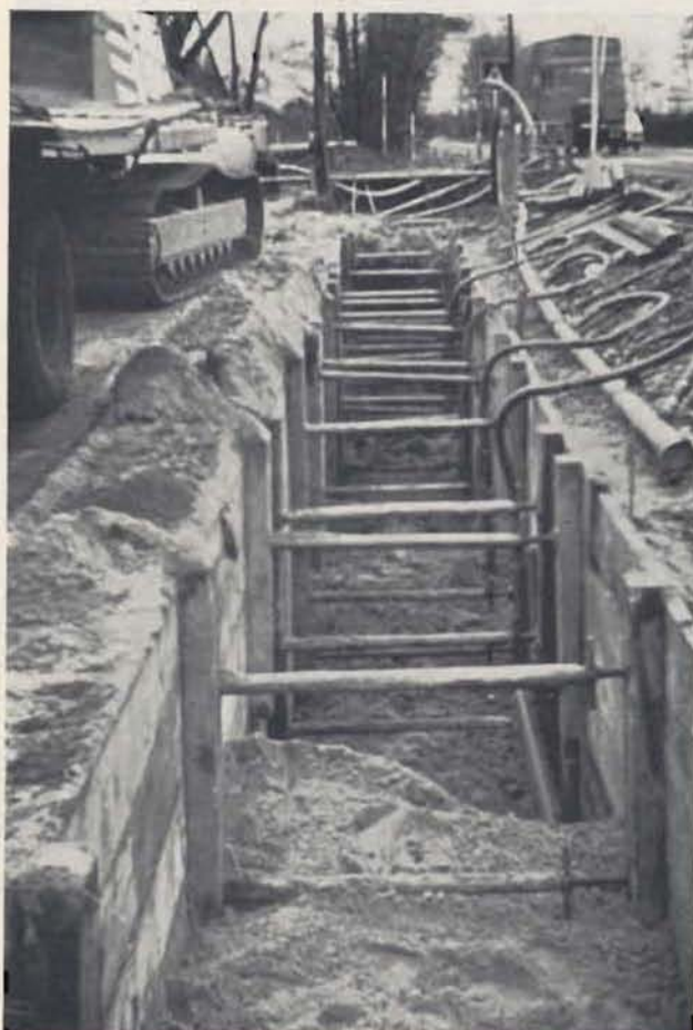
Bild 4: Rohrgraben mit gerader Seitenwand und Aussteifung
