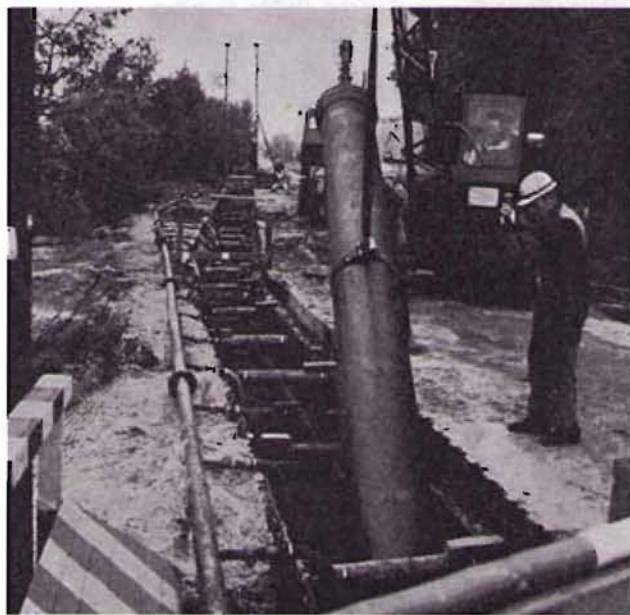
Bild 1: Abwasserdruckleitung NW 500 mit Schraubmuffenverbindungen
