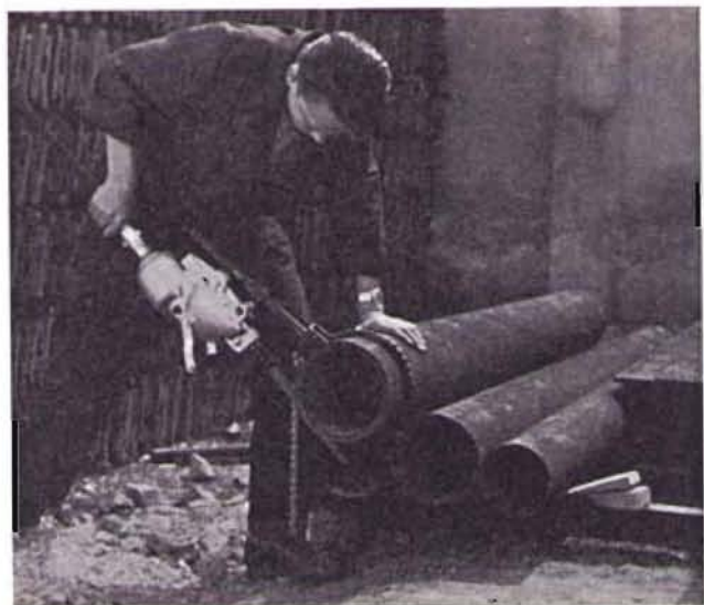
Bild 3: Stichsäge mit Druckluftmotor im Einsatz
