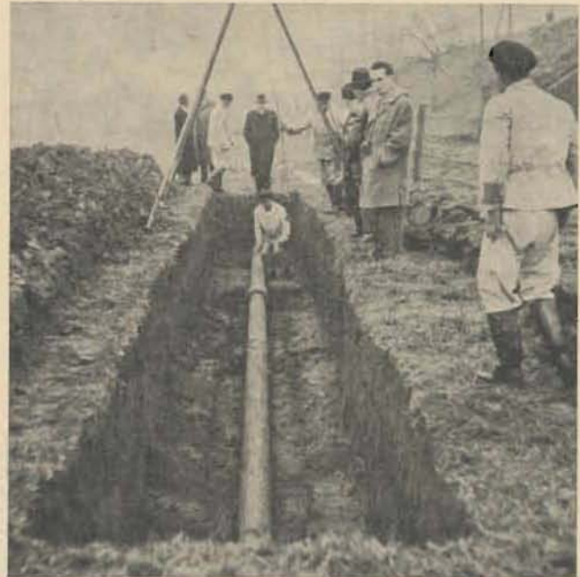
Bild 1: Aufgrabung der Kokereigas-Hochdruck-Versuchsleitung Wetzlar
