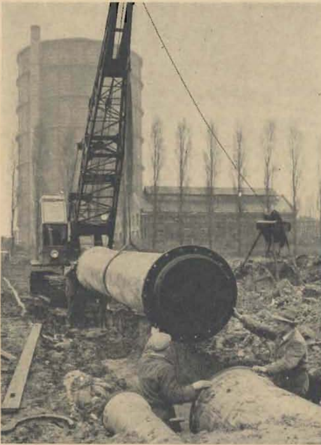
Bild 3: Verlegung von 2 Gasleitungen NW 800 und 300 mm mit Rohren aus duktilem Gußeisen
