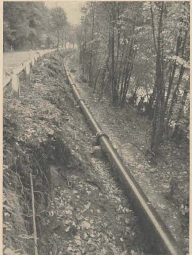
Bild 7: Wasserleitung NW 250 mm auf Betonstützen parallel zu einer Bundesstraße
