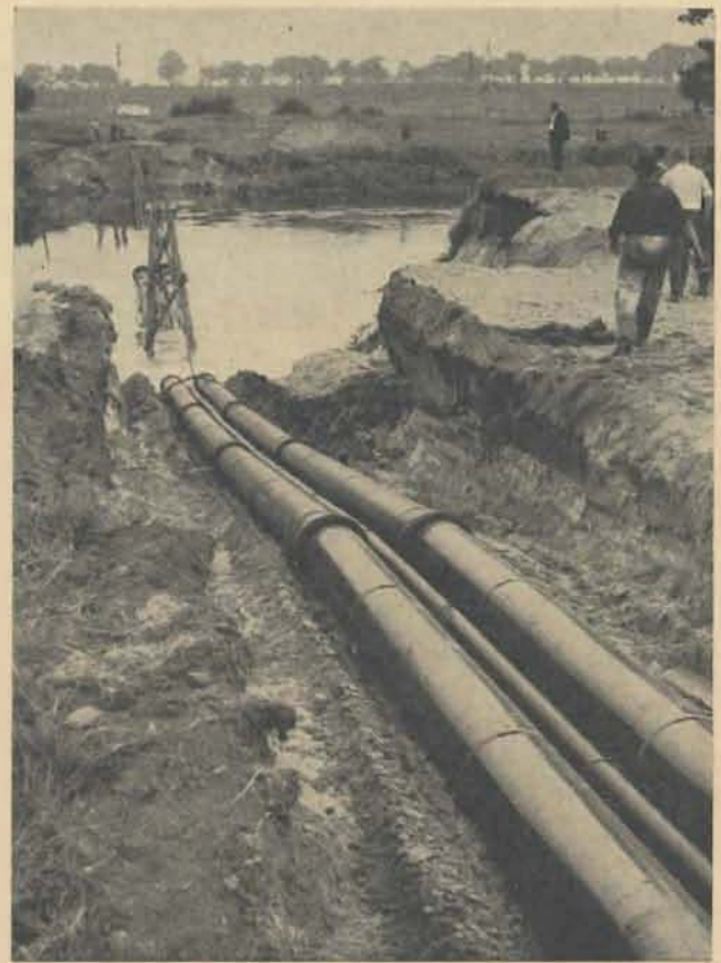
Bild 4: Doppeldüker NW 350 mm, Schraublangmuffe, durch die Lippe
