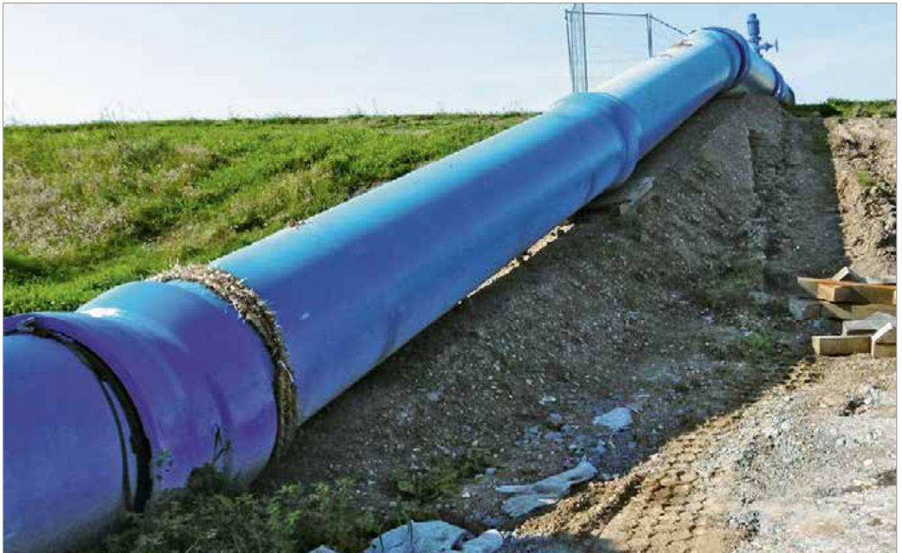
Verlauf der Interimsleitung DN 800 über den Hochwasserschutzdeich zwischen Mulde und Wasserwerk Canitz
