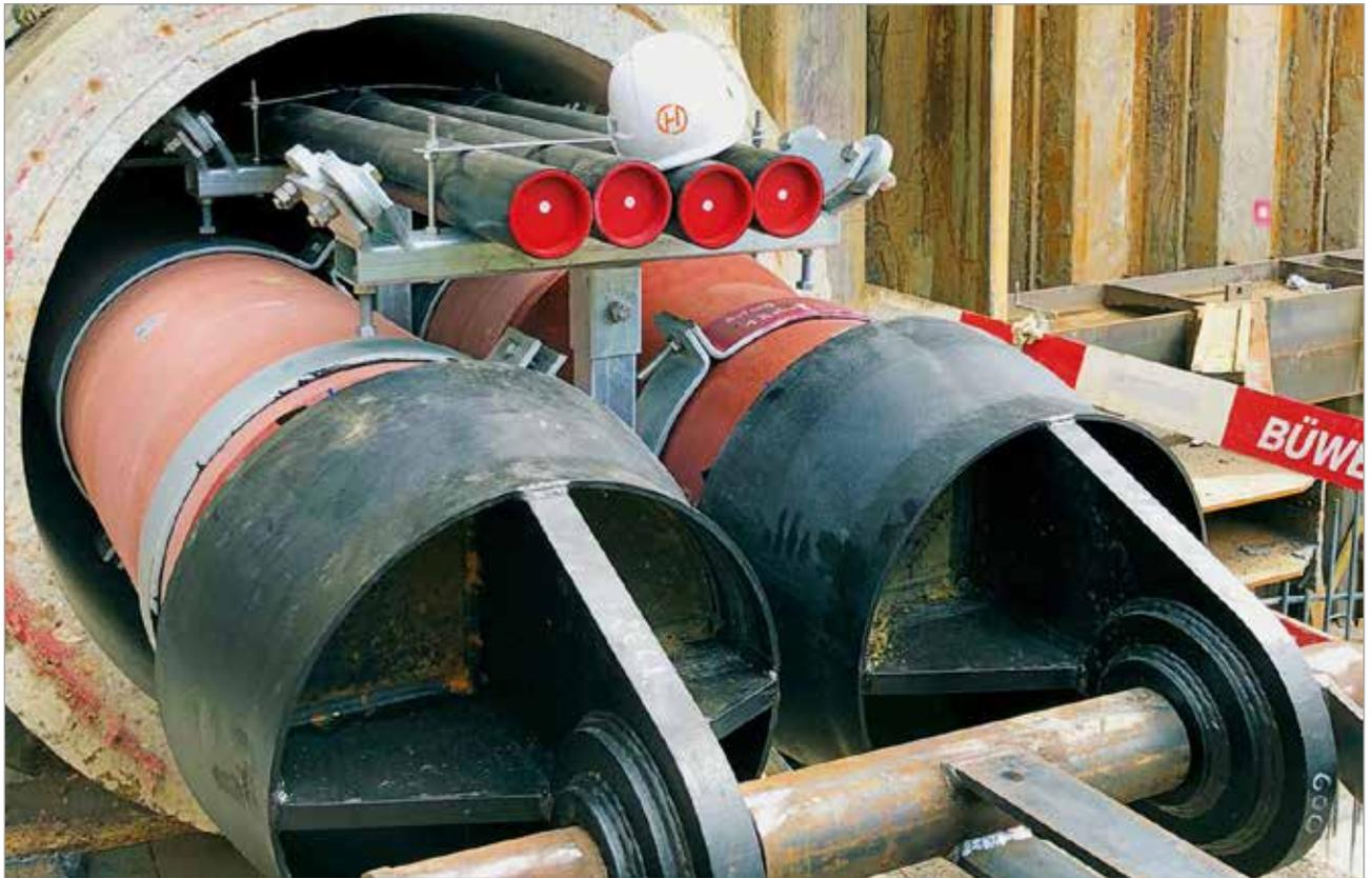
Ankunft am Zielschacht: Deutlich erkennt man die äußerst engen Platzverhältnisse im Microtunnel.
