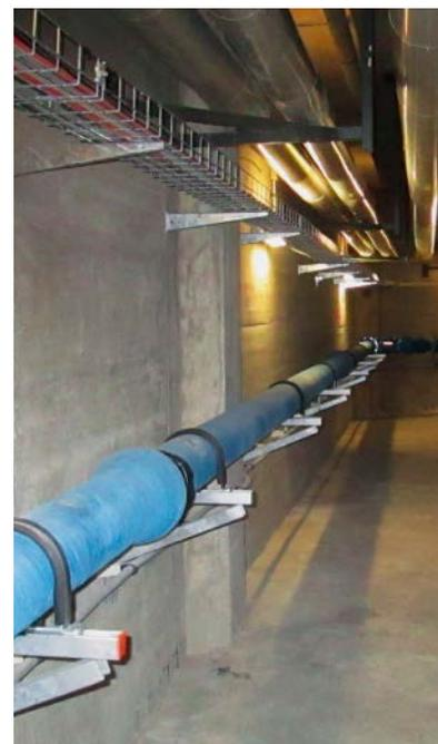
Darüber hinaus mussten in diesen Bereichen Passstücke vorbereitet und zur Herstellung der formschlüssigen Steckmuffen-Verbindungen auf den Spitzenden jeweils Schweißraupen aufgebracht werden. Nach kurzer Anlaufzeit wurden diese Arbeiten schnell und qualitätsgerecht ausgeführt.
