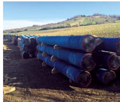
DN 250 bis DN 500 sowie Steckmuffen-Verbindungen der Typen VRS®-T und TYTON®. Das grenzüberschreitende Projekt wird auf österreichischer Seite finanziell mit Mitteln der Europäischen Union über die Europäische Investitionsbank unterstützt. Die Fertigstellung dieses Projektabschnittes ist für Ende 2017 geplant.
