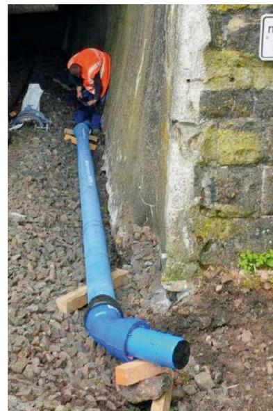
Leitung beträgt 8 bar. Der Fließdruck bei Entnahme von Löschwasser muss 5 bar betragen. Eingebaut wurden 624 m Rohre aus duktilem Gusseisen DN 125, BLS®, ZM-U, K10, mit FZM-Kombimanschette. Ein FM-Approval liegt vor.
