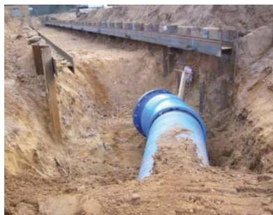
◆ Der maximale Betriebsdruck der Leitung beträgt 9 bar. Im Kreuzungsbereich ist für die Straße eine Dammschüttung geplant, die die vorhandene Riedleitung mit etwa 5,0 m Höhe überbauen würde. Die Hessenwasser hat deshalb auf einer Länge von rund 145 m ihre Trinkwasserleitung aus dem Gefahrenbereich der Dammschüttung herausgenommen. Aus Sicherheitsgründen entschied sich die
