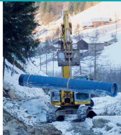
eine reine Winterbaustelle. Duktile Gussrohre können jedoch auch bei Minusgraden, Schnee und Eis sicher eingebaut werden. Das rehabilitierte Kleinwasserkraftwerk Walten wurde im Frühjahr 2010 in Betrieb genommen.
