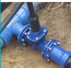
Eine über 100 Jahre alte Grauguss-Rohwasserleitung der Brunnenfassung „Hintermark“ im Kreis Offenbach zeigte in zunehmendem Maße Rohrschäden. Der Zweckverband Wasserversorgung Stadt und Kreis Offenbach (ZWO) bereitet deswegen den Austausch von etwa 800 m der Nennweiten DN 100 bis DN 250 vor.
