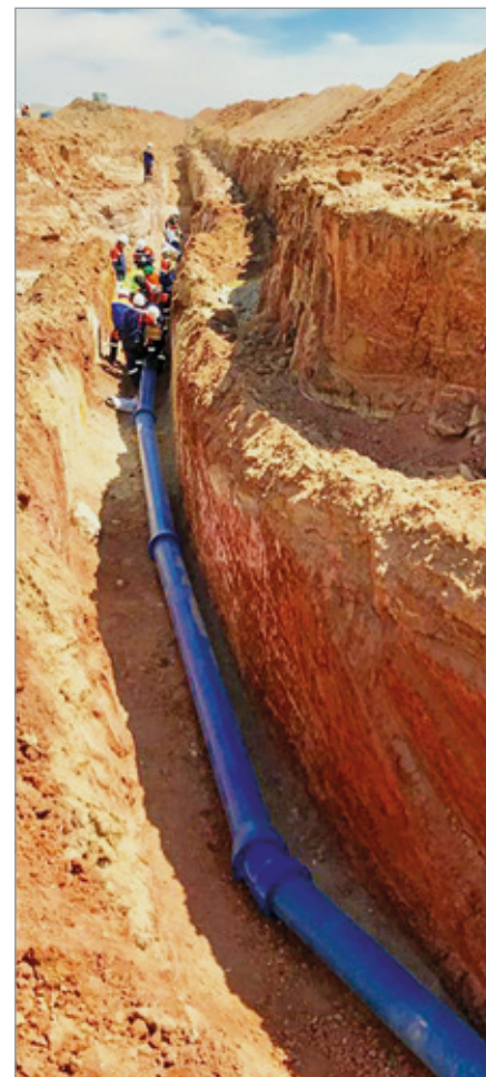
Die bis zu -40\text{ }^{\circ}\text{C} , die im mongolischen Winter herrschen und den Boden bis in 3,5 m Tiefe gefrieren lassen, machen es notwendig, die Rohre 4 m tief zu verlegen.
