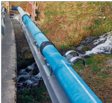
Offene Bachquerung mit beidseitigen Widerlagern.
