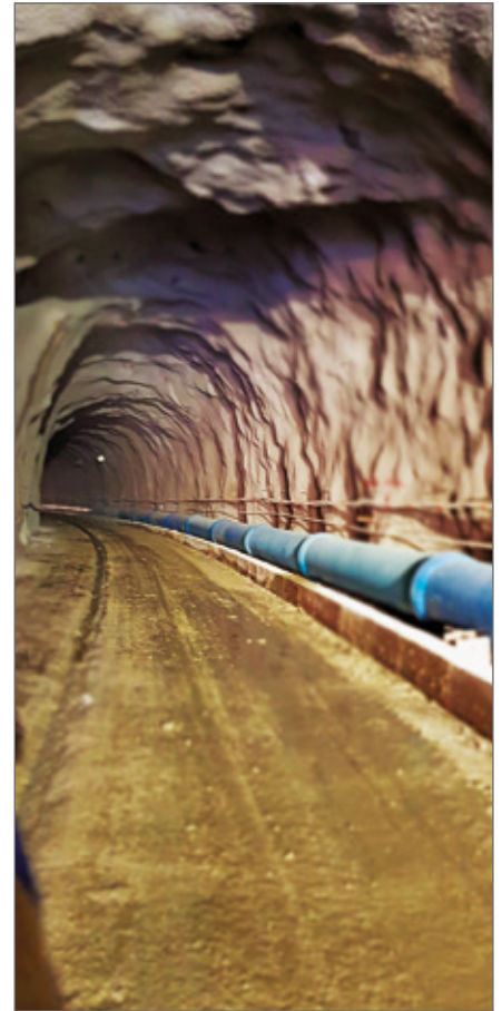
Arbeiten unter beengten Platzverhältnissen: Links oben: Transport zur Montage mit einem Teleskopklader. Links unten: Betonierarbeiten. Rechts: Turbinenleitung DN 800 nach dem Einbau im Kämpferbereich des Versorgungstunnels.
