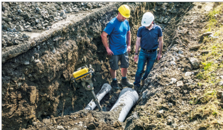
Dank der hohen mechanischen Belastbarkeit ist kein spezielles Bettungsmaterial erforderlich, in der Regel kann das Aushubmaterial als Bettungsmaterial verwendet werden.
