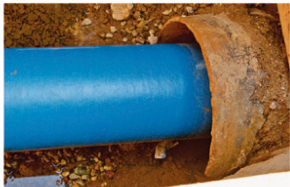
Der Rohrstrang wurde, auf dem Betonkonus schiefelnd, um jeweils 6 m in die alte Leitung gezogen.
