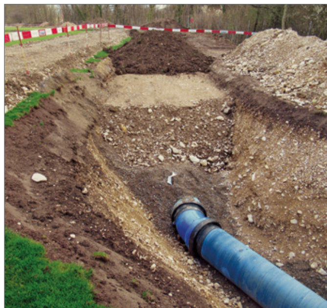
Gut ersichtlich sind die verschiedenen Erdmaterialien, doch das duktile Gussrohr mit der Zementmörtel-Umhüllung (ZM-U) ist jeder Situation gewachsen. Unverschmutztes Aushubmaterial kann auch wieder zum Verfüllen des Grabens verwendet werden.
