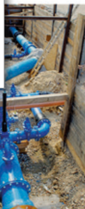
Punktuell wurde zur Einbindung von Armaturen und Hydranten sowie Abzweigen und Anschlüssen der Einbau in offenen Baugruben notwendig.
