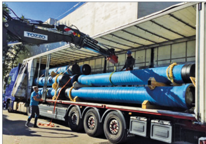
Transport der Rohre ab Werk direkt auf die Baustelle.
