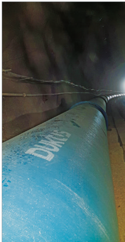
Abgewinkelte Rohre im gekrümmten Verlauf des Tunnels.
