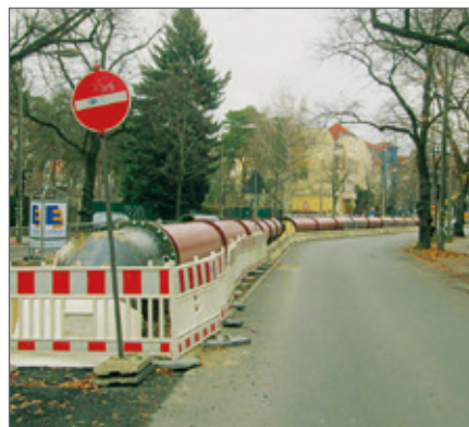
Blick über die Baustelle.
