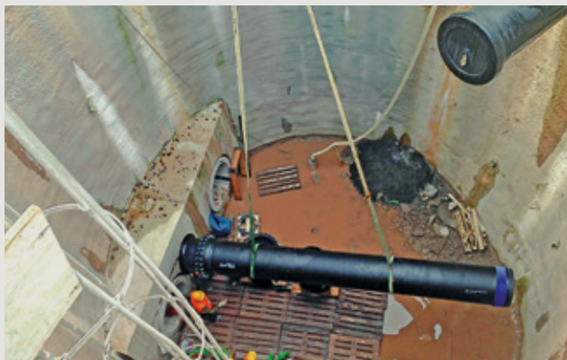
Doppelleitung DUCPUR DN 700 im Schacht, Einzug in Microtunnel.
