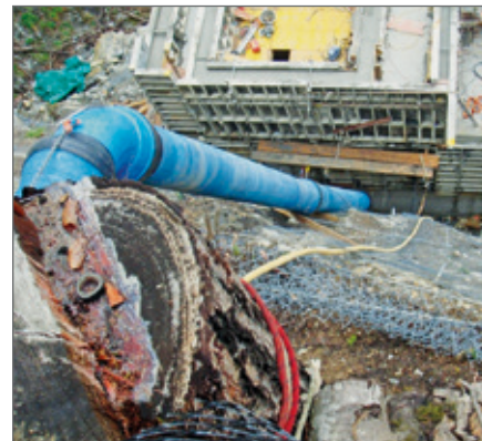
Die versetzt neu erstellte TBZ in schwer gangbarem Gelände mit fast senkrecht abfallender Zuleitung.
