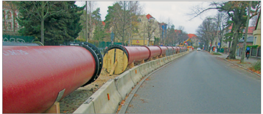
Abschnittsweise Dichtheitsprüfung der Interimsleitung.
