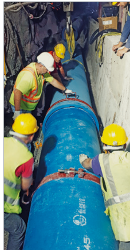
Montagetrupp beim Einbau eines Rohres DN 800.
