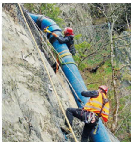
Voller Körpereinsatz in steilem Gelände. Die BLS®-Verbindung von Hagenbucher nimmt die senkrecht wirkenden Zugkräfte problemlos auf. Die Rohre wurden per Helikopter angeflogen.
