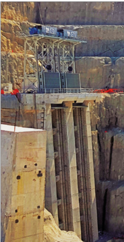
Absperrschott zum Triebwassertunnel.
