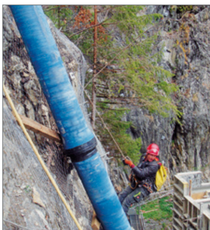
Voller Körpereinsatz in steilem Gelände. Die BLS®-Verbindung von Hagenbucher nimmt die senkrecht wirkenden Zugkräfte problemlos auf. Die Rohre wurden per Helikopter angeflogen.
