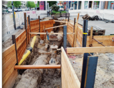
Der Betrieb ist die Graugussleitung DN 700 in einem sehr passablen Erhaltungszustand.
