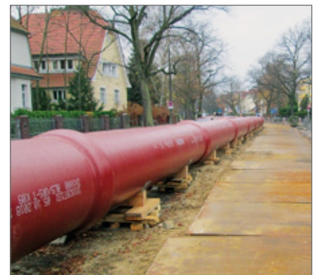
Rohrstrang mit Auflagern und ausgelegten Stahlplatten.
