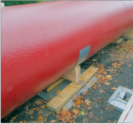
Hartholzaufleger mit Gleitblech und Lastverteilungsplatte.
