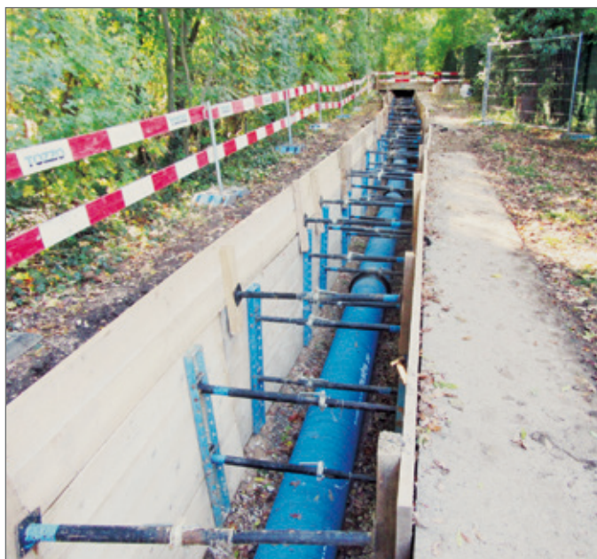
Die Rohre mussten unter erschwerten Bedingungen eingebaut werden: Enge Zufahrtswege, schmaler Graben und eng verstrebt Grabenwände. Dennoch ging deren Einbau problemlos vonstatten.
