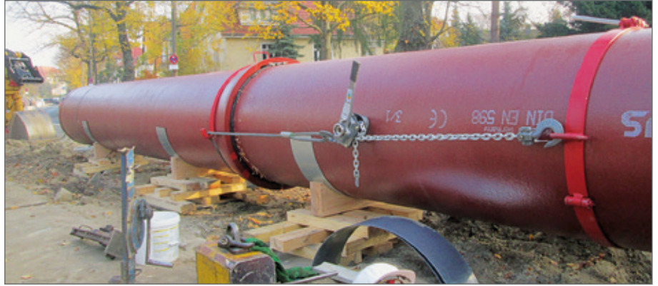
Montierte BLS®-Verbindung mit Rohrauflegern.
