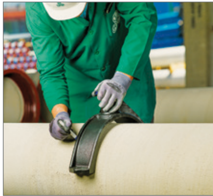
Für das Anbringen der TRM-Anbohrschelle wird die Zementmörtelschicht partiell entfernt.
