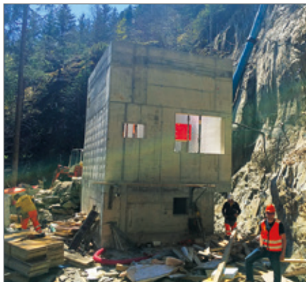
Die versetzt neu erstellte TBZ in schwer gangbarem Gelände mit fast senkrecht abfallender Zuleitung.
