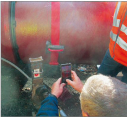
Beim Recken der BLS®-Verbindung.
