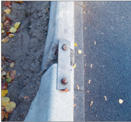
Verbindung zwischen den Anfahrtschutz- elementen.
