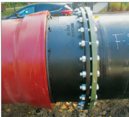
In die Rohrmuffe montiertes F-Stück mittels BLS®-System.
