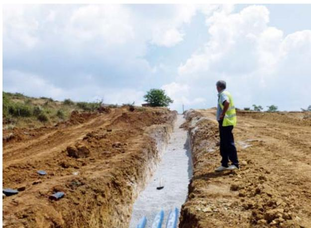
**Bild 5:** Ein Großteil der duktilen Gussrohre mit PUR-Longlife-Deckbeschichtung ist bereits eingebaut; 2013 wird das Projekt abgeschlossen.
