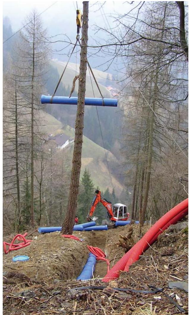
**Bild 7:** Transport der duktilen Gussrohre mittels Materialseilbahn
