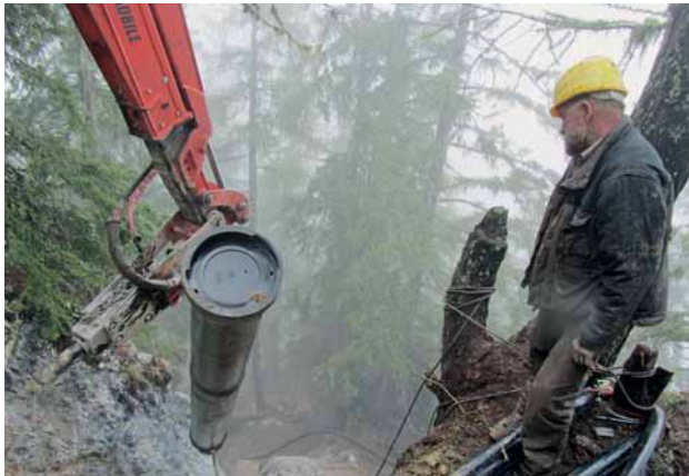
Bild 9: Projekt 3 – Kraftwerk Furkelbach in Südtirol: Einbau im 65° Steilhang
