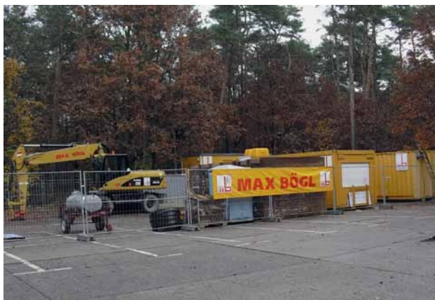
Bild 1: Baustelleneinrichtung der Firma Max Bögl
