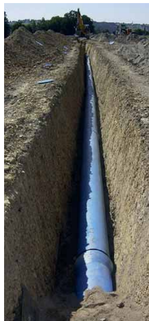
Bild 4: Trassengleicher Einbau der duktilen Trinkwasserrohre DN 400 in längskraftschlüssiger Ausführung BRS®
