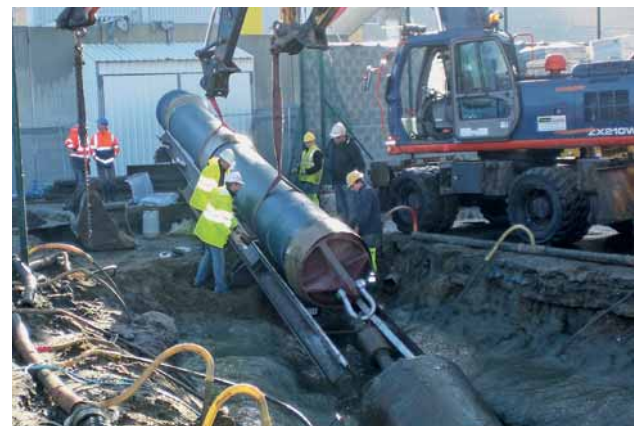
Bild 6: Rohrmontage auf einer Montagerampe
