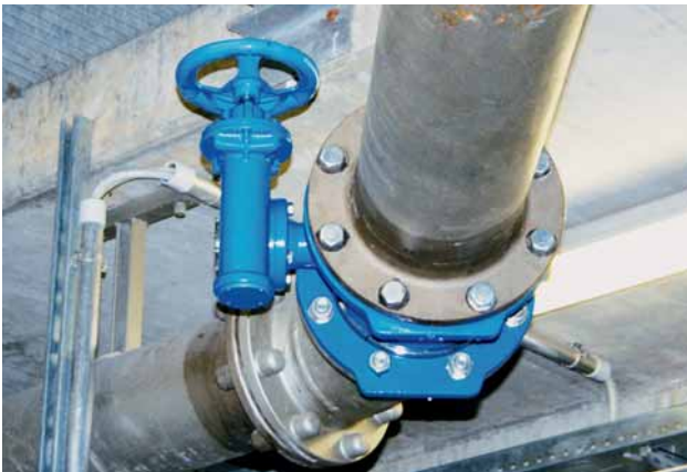
Bild 4: Erleichterter Armaturentausch durch Heranziehen des Losflansches – das Spreizen zwischen Armaturenflansch und Rohrleitungsflansch zum Einbau der Dichtung entfällt.
