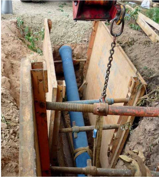
Bild 6: Absenken eines duktilen Gussrohres DN 200 in die Montagegrube (Startbaugrube)
