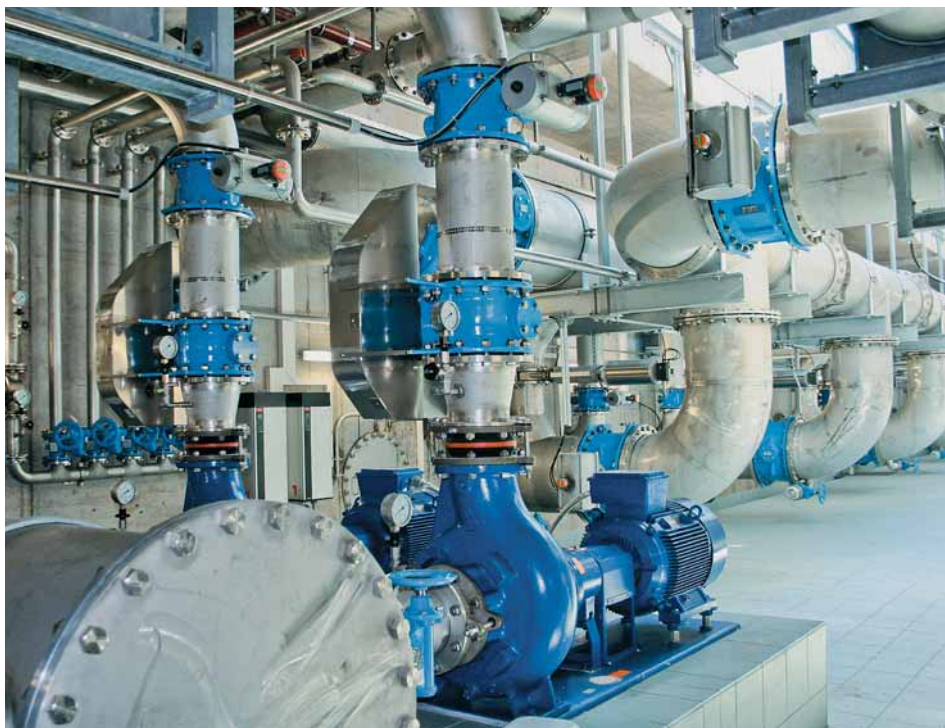
Bild 2: Losflanschklappe DN 400 – problemloser Einbau in senkrechte Rohrleitungen; kein aufwendiges Unterbauen der Armatur während der Montage, da die Armatur beim Einbau zuerst am Festflansch befestigt wird.
