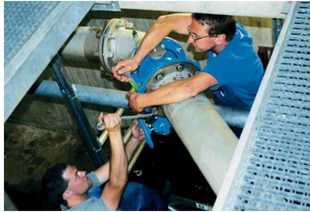
Bild 5: Perfekter Sitz der Armatur garantiert beste Bedienbarkeit in allen Einbausituationen. Die Armatur kann im eingebauten Zustand nachträglich noch gedreht werden.
