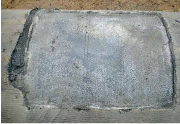
Bild 2: Projekt 1: duktiles Gussrohr DN 400 – ZM-U mit Epoxidharz-Haftbrücke und Zink-Überzug; keinerlei Korrosionsangriffe sichtbar
