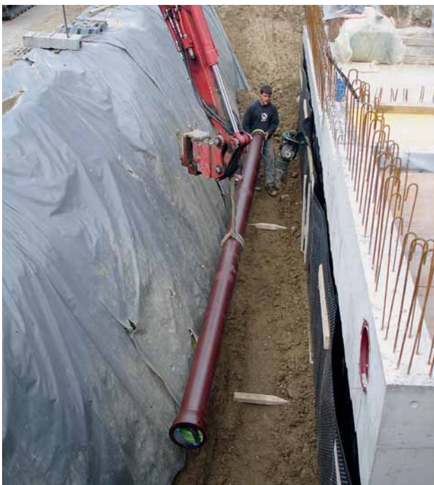
Bild 1: Montage der Erdwärmekollektor-Luftleitung – duktiler Gussrohre Typ geopur DN 200
