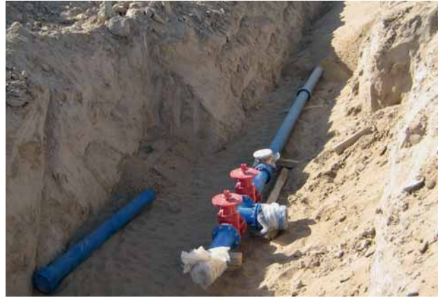
Bild 6: Erdleitungsring teilweise abgedeckt
