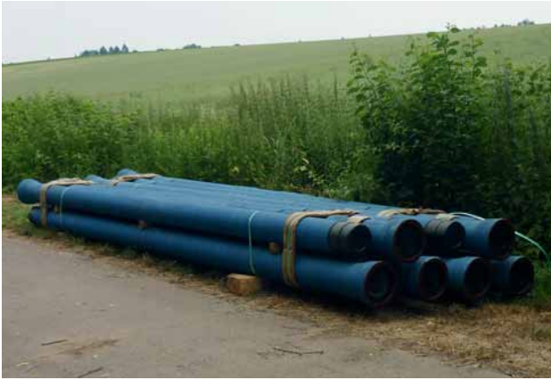
Bild 2: Rohrlagerung – duktile Gussrohre DN 200 mit Zementmörtel-Umhüllung
