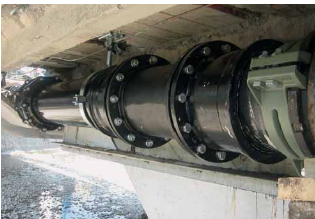
Bild 8: Zusammenschluss der ecopur -Rohre mit der bestehenden Schraubmuffenleitung auf der Seite der Stadt Luzern
