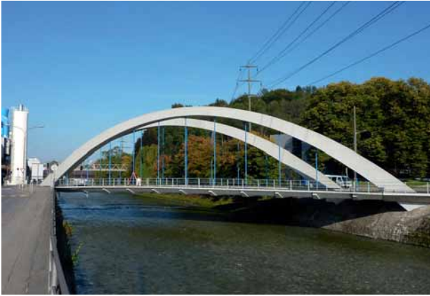
Bild 1: Ansicht der Bogenbrücke über die „Kleine Emme“
