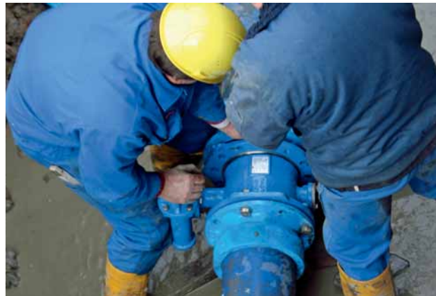
Bild 6: Ob im Anlagenbau oder im Rohrgraben – die Absperrklappe mit Losflansch ist überall die richtige Lösung.
