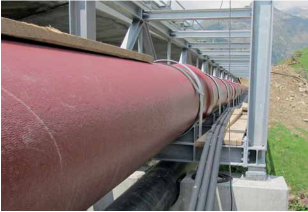
Bild 4: Projekt 1 – Kraftwerk Vernagtsee in Südtirol: Befestigung der duktilen Triebwasserleitung mittels Halteschellen
