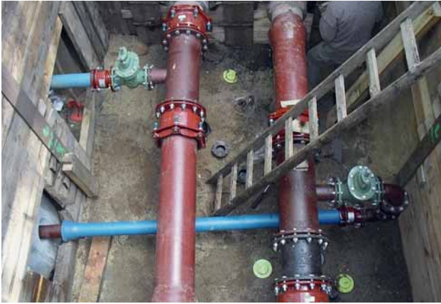
Bild 7: Doppelleitung DN 250 aus duktilem Gusseisen – offene Bauweise
