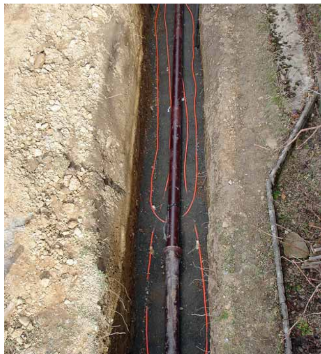
Bild 2: Abwasserleitung Typ geopur DN 125 mit in der Rohrbettung eingelegten mit Kunststoff umhüllten Kupferrohren für den Kühlmittelkreislauf
