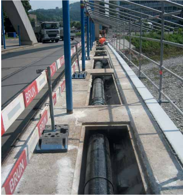
Bild 3: Offene Montageöffnungen des Werkleitungskanals, Standardlängen 3,40 m
