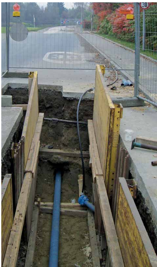
Bild 4: Abschnitt mit eingezogenem duktilen Gussrohr
