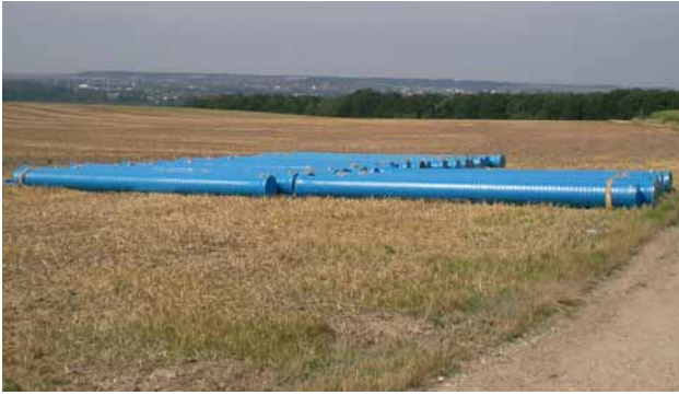
Bild 2: Duktile Gussrohre DN 400 an der Trasse
