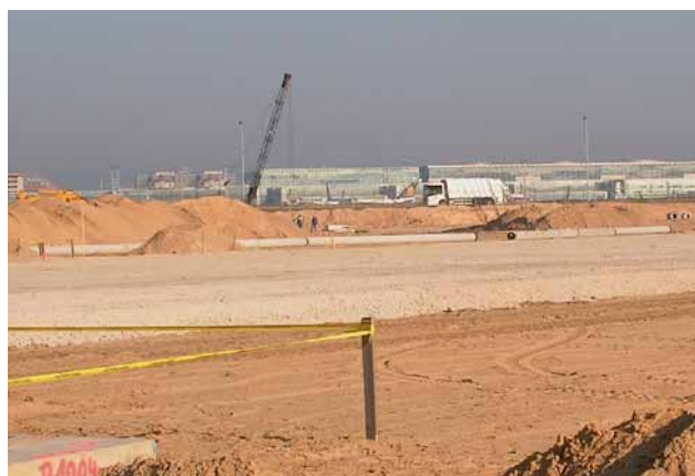
Bild 1: Vorfeldflächen des Terminals 3 im Bau
