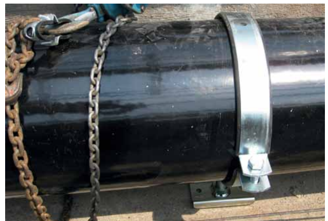
Bild 6: Befestigungspunkt für das duktile Gussrohr Typ ecopur mit Rohrschelle und integrierter Fußplatte
