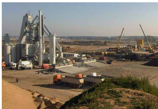
Bild 2: Mobile Betonmischanlage auf dem Vorfeld des neu zu errichtenden Terminals 3
