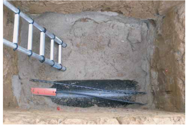
Bild 4: Projekt 2: Aufgrabung – Heilbronn, Böllinger Höfe, verlängerte Grundäckerstraße – duktiles Gussrohr DN 500, Einbaujahr 1979
