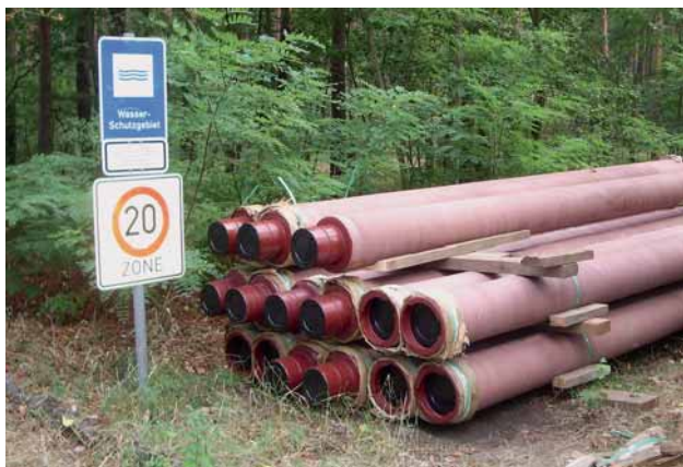
Bild 1: Zum Einbau vorbereitete Sonderrohre aus duktilem Gusseisen ZMU-PLUS mit BLS® - Steckmuffen-Verbindung
