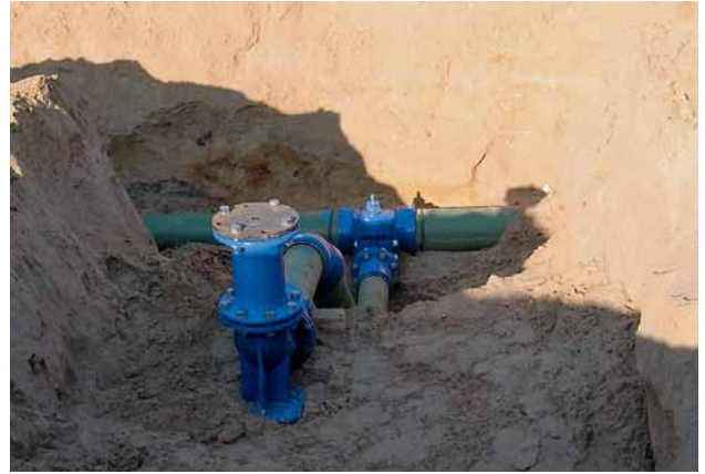
Bild 5: Formstücke aus duktilem Gusseisen zum Anschluss eines Unterflurhydranten
