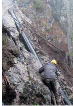
Bild 8: Projekt 3 – Kraftwerk Furkelbach in Südtirol: extreme Bedingungen beim Rohreinbau
