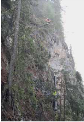
Bild 7: Projekt 3 – Kraftwerk Furkelbach in Südtirol: Transport der Rohre mittels Standseilbahn
