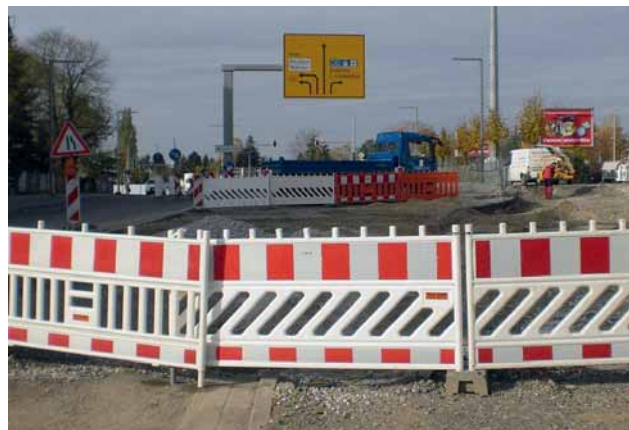
Bild 1: Straßenbaumaßnahme „Mittlerer Ring Nord“ in Leipzig
