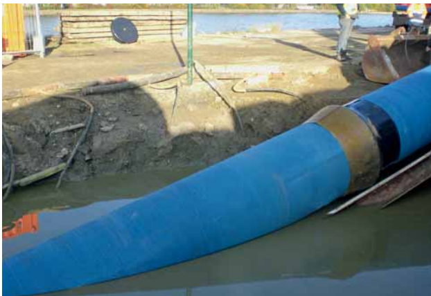
Bild 9: Einzug der Rohre; die Steckmuffen-Verbindung ist mit Schrumpfmantel und übergeschobenem Blechkegel geschützt.
