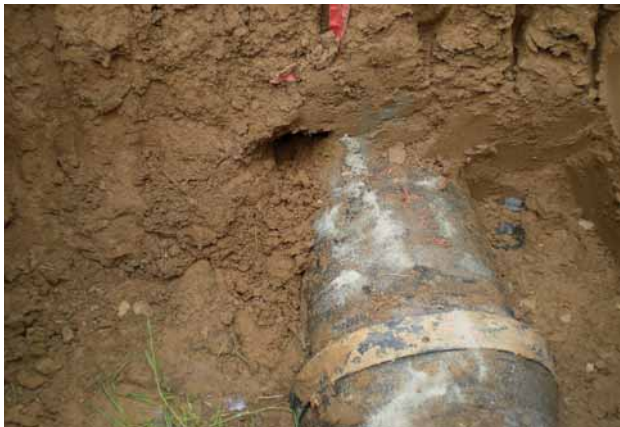
Bild 3: Projekt 1: duktiles Gussrohr DN 400 – Umhüllung mit schwach aggressivem Boden
