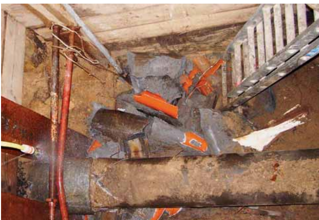
Bild 5: Berstvorgang in Verbindung mit dem Press-/Ziehverfahren
