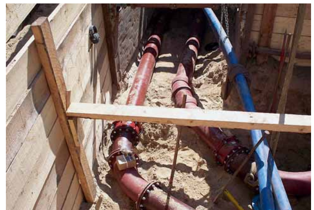
Bild 6: Ausführung der Doppelleitung DN 250 in einem Bogenbereich
