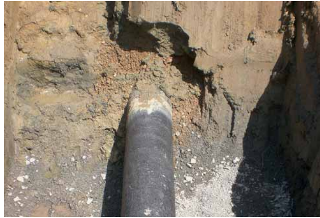
Bild 7: Projekt 3: Aufgrabung – Zweckverband Mittelhessische Wasserwerke ZMW, Anschluss Gladenbach, Abschnitt Lohra – duktiles Gussrohr DN 300, Einbaujahr 1978/1979
