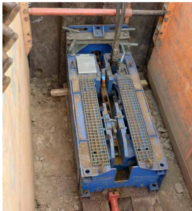
Bild 4: Zielbaugrube mit hydraulischer Berstlaffete
