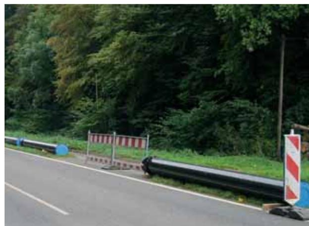
**Bild 1:** Ausgelegte duktile Trinkwasserrohre an der Rohrleitungstrasse der Kreisstraße K 12
