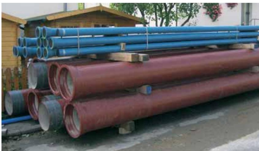
**Bild 1:** Duktile Trinkwasserrohre DN 100 (blau) und duktile Abwasserrohre DN 600 (rot) vor dem Einbau
