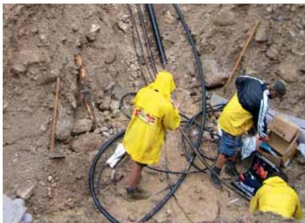
**Bild 3:** Anschlussleitung DN 80 für Schneischacht mit Kabeln
