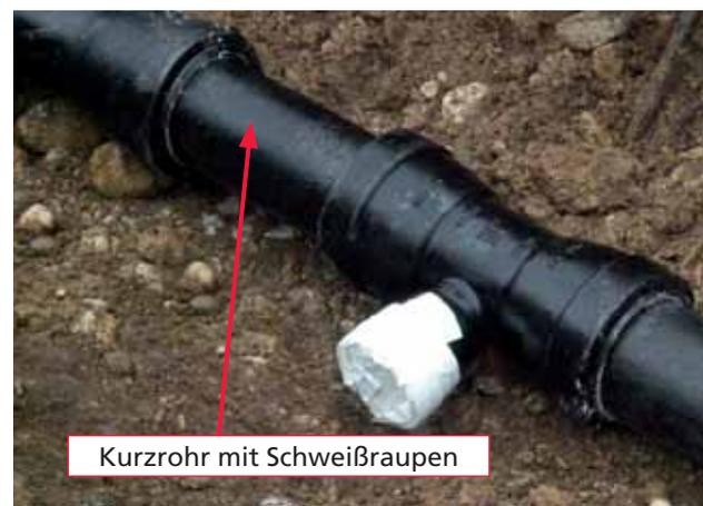
**Bild 5:** Angeschlossenes Formstück MBB DN 250/80 – Vorbereitung einer Stichleitung zum Schneischacht
