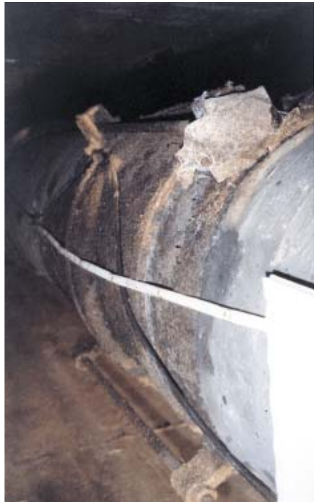
Bild 3: Zuganker an der alten Graugussleitung
