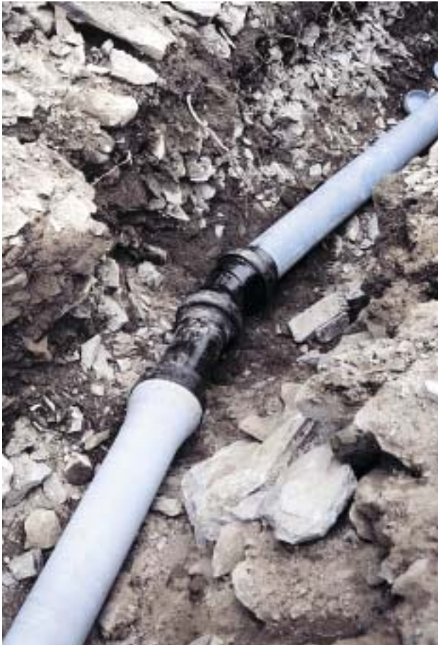
Bild 4: Formstück mit VRS-Schubsicherung
