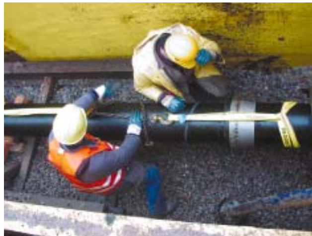
Bild 3: Montage der TIS-K-Verbindung
