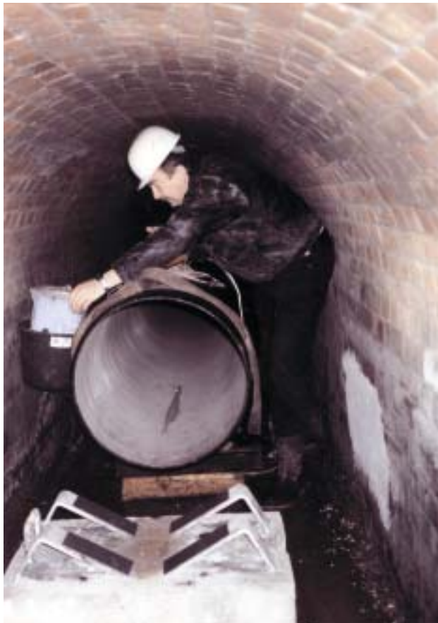
Bild 6: Betonsockel mit integriertem Auflager
