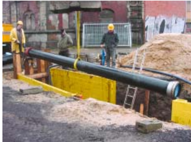
Bild 2: vorbereitetes Rohr mit Ziehkopf und Gleitblech
