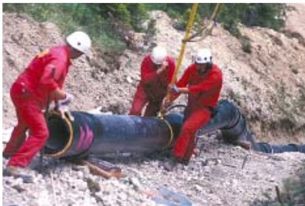
Bild 6: Rohrmontage mit Hubschrauberhilfe
