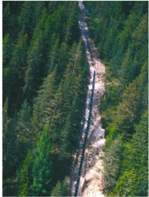
Bild 9: Rohrtrasse zur Mittelstation in einem steilen Gelände
