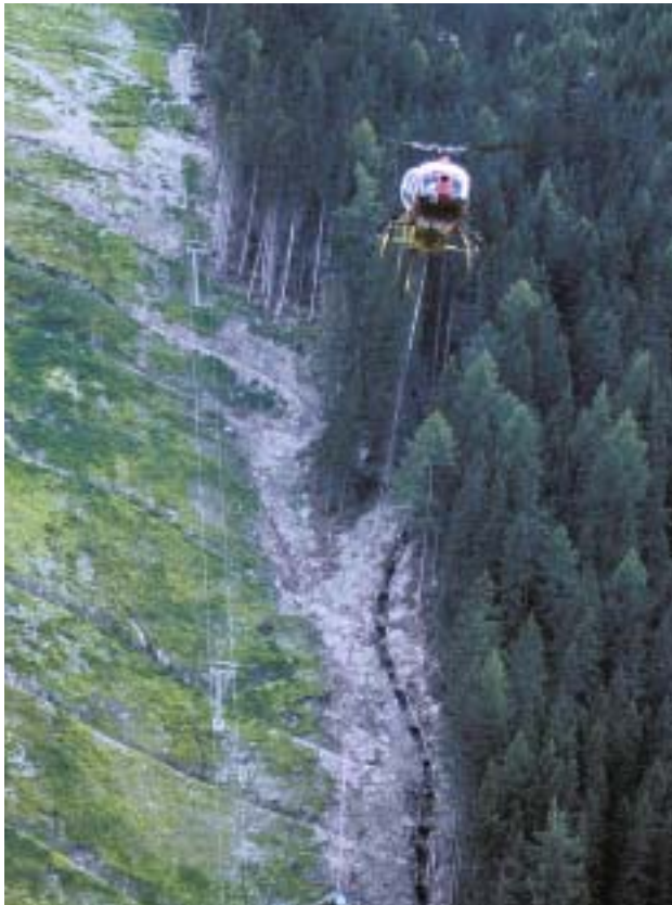
Bild 8: Rohrtransport mittels Hubschrauber im schwierigen Gelände
