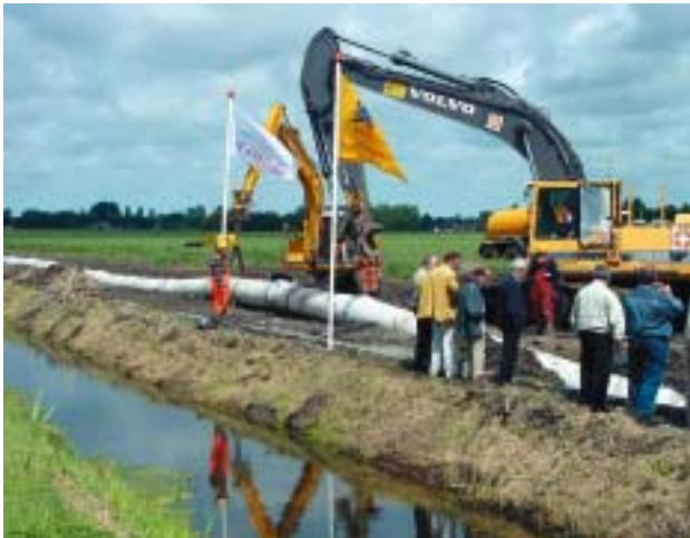
Bild 4: Der Rohrstrang wird mit einem Bagger über den Damm gehoben.
