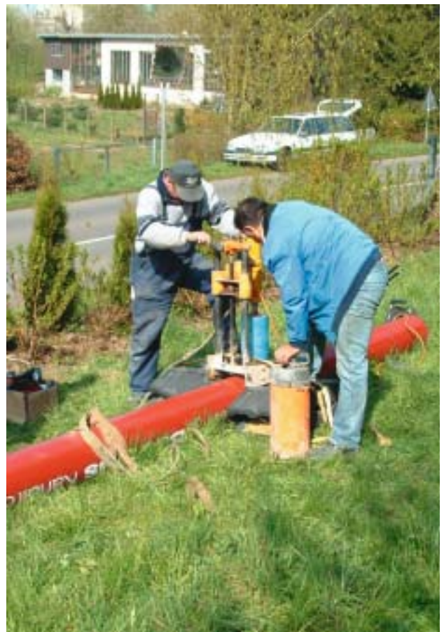
Bild 1: Praktische Einweisung in die Einbautechnik duktiler Kanalrohre
