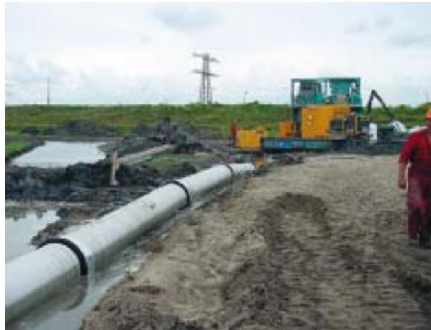
Bild 6: Rohrstrang während des Einziehens
