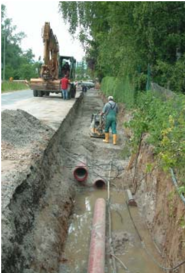
Bild 2: Einbau von Schmutz- und Regenwasserkanal mit Höhen- und Seitenversatz in gemeinsamen Graben
