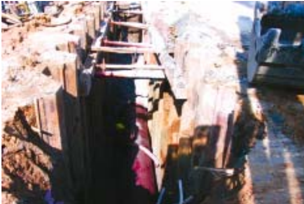
Bild 3: Verbaute Baugrube in 5,00 m Tiefe
