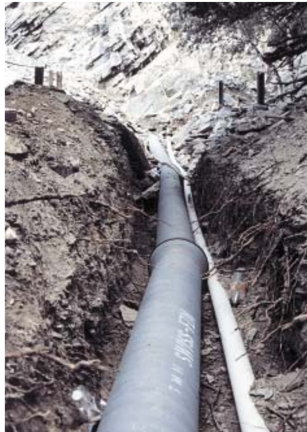
Bild 2: Anpassung an das Gelände durch Abwinkelung
