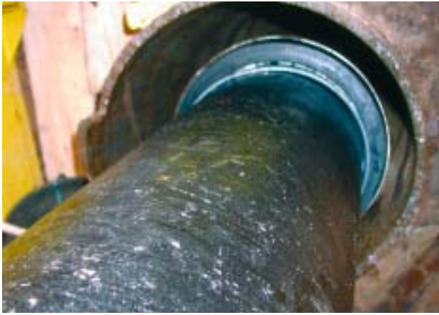
Bild 4: Rohrstrang beim Einziehvorgang
