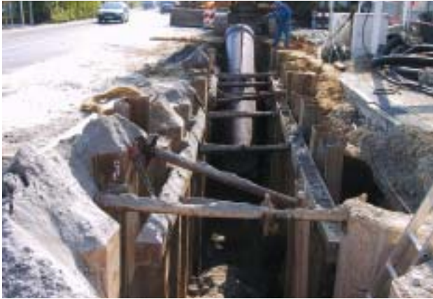
Bild 3: Verbaute Baugrube in 5,00 m Tiefe
