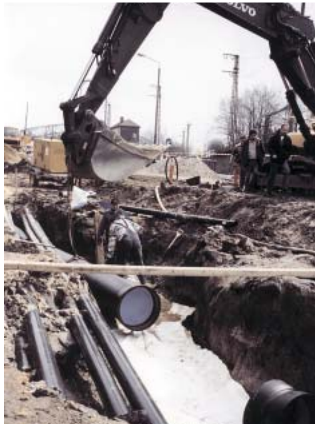
Bild 4: Parallel verlaufende Kabel und Leitungen
