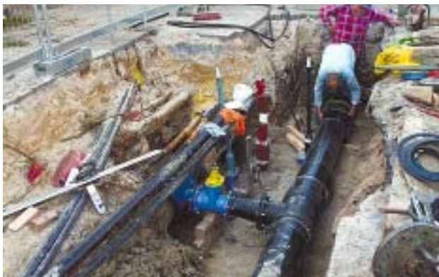
Bild 4: Einbau der Gasleitung DN 300 GGG im Bereich von Versorgungsleitungen
