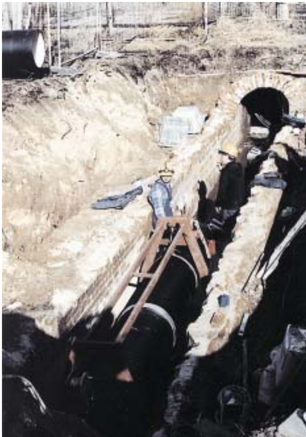
Bild 7: Transport der Rohre mit Hubwagen
