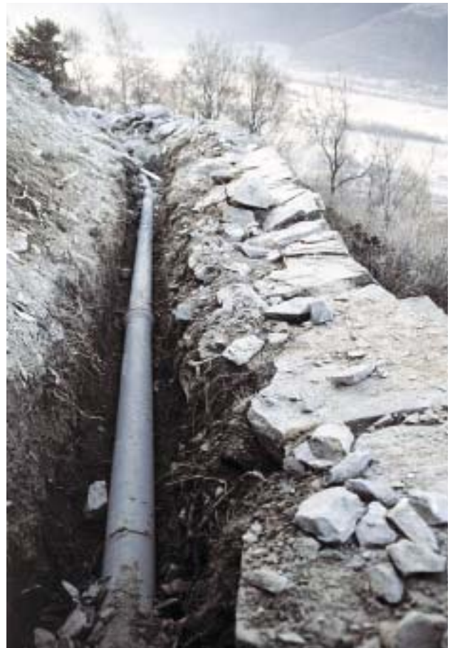
Bild 5: Leitungseinbau in steinigem Gelände
