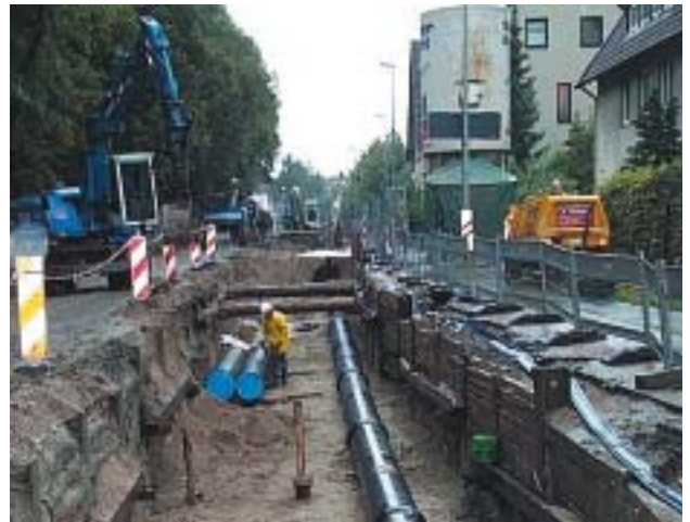
Bild 2: Einbau der Hauptwasserleitung DN 500 GGG im Rohrgraben des Regen- und Schmutzwasserkanals
