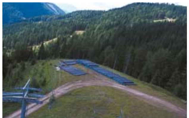
Bild 7: Rohrlagerung an der Mittelstation in 1750 m Seehöhe
