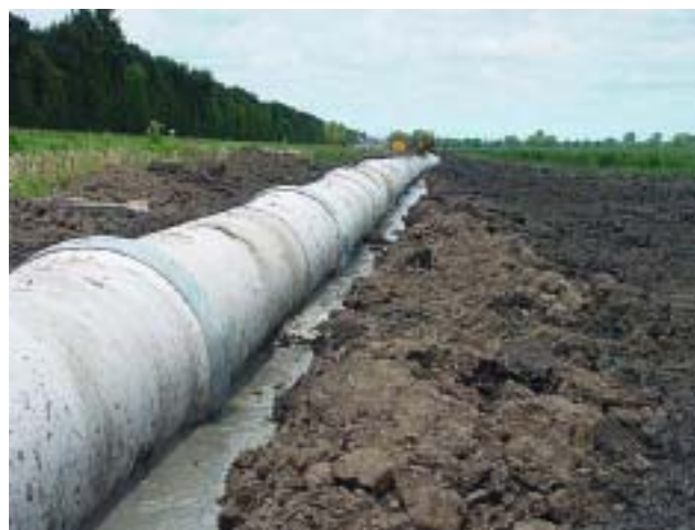
Bild 3: Rohrstrang vor dem Einziehen
