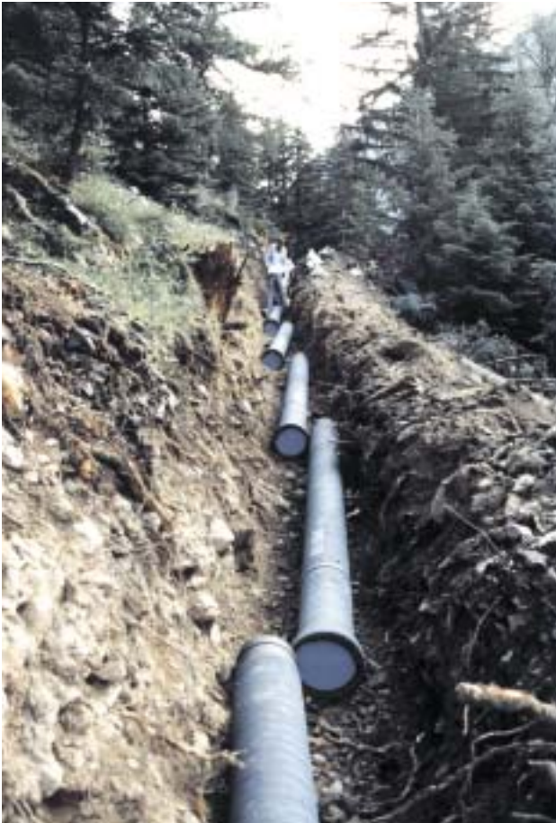
Bild 7: Einbaurichtung von oben nach unten
