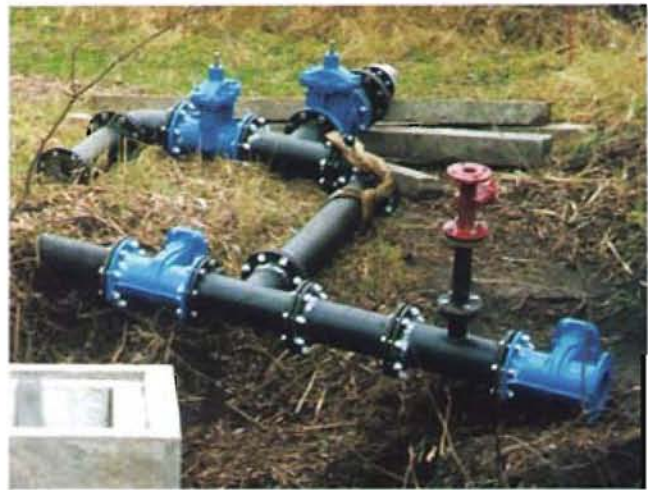
Bild 3: Montierter Heberkopf vor Einbau am Auslauf des Tonsees
