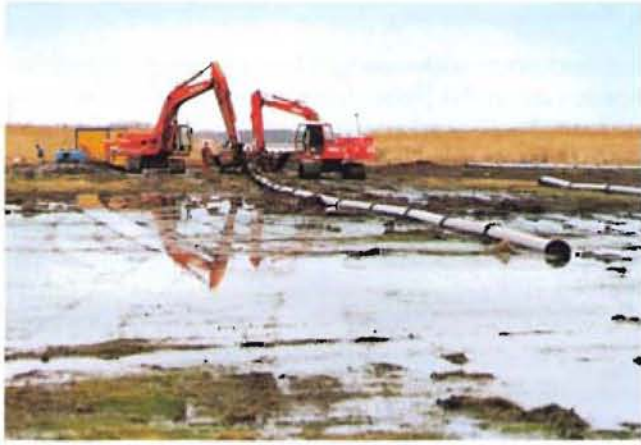
Bild 4: Vorgefertigter Rohrstrang beim Einziehen
