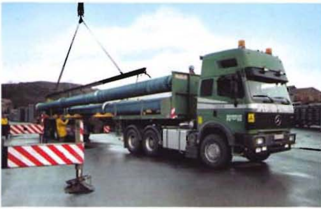
Bild 6: Verladen der 18 m langen Rohrstränge DN 600/DN 300 im Herstellerwerk
