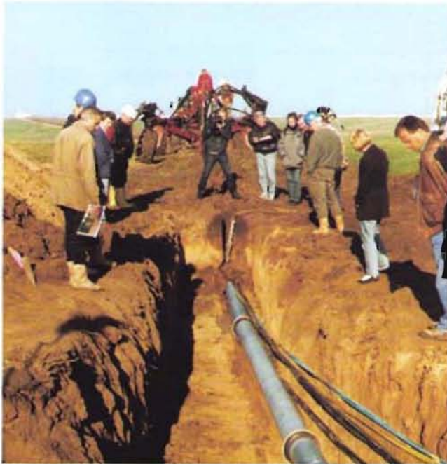
Bild 8: Einpflügen der duktilen Gußleitung mit Warnband und HDPE-Leerrohren
