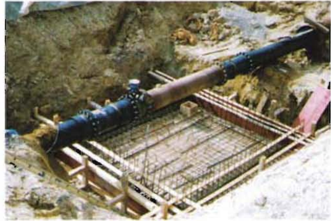
Bild 7: Sonderbauwerk vor der Durchpressung durch die Autobahn A 61
