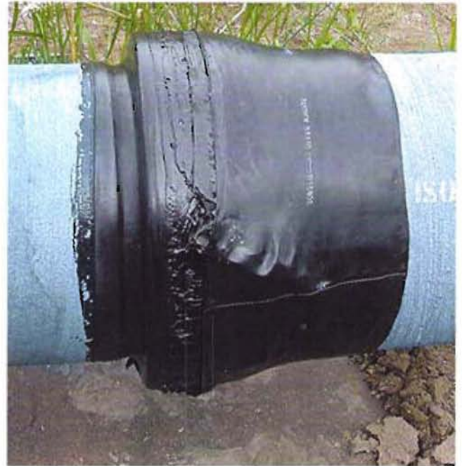
Bild 4: Umhüllung mit Schrumpfmanschette
