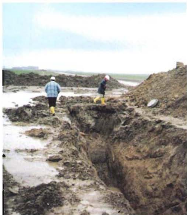
Bild 1: Charakteristische Aufnahme des Baufeldes in der Schlechtwetterperiode Februar/März 2000
