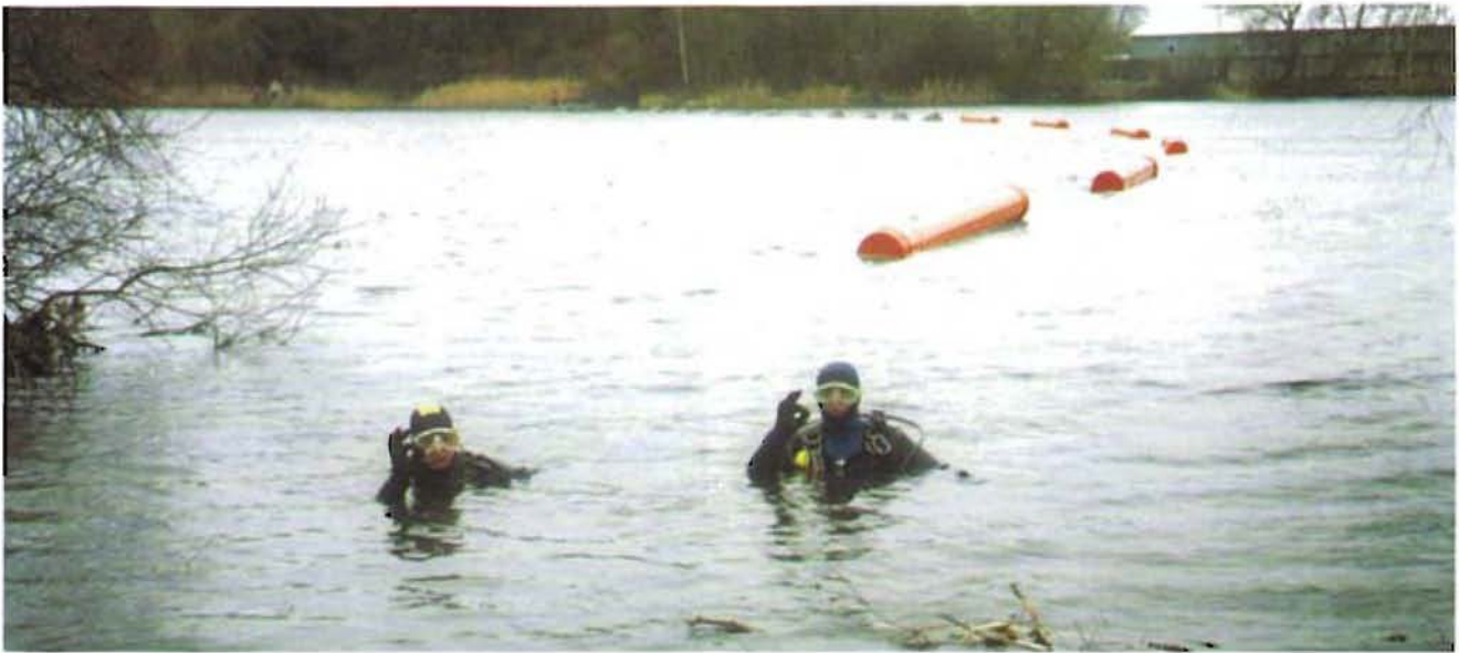
Bild 8: Einschwimmen der Gußrohre – Kontrolle unter Wasser
