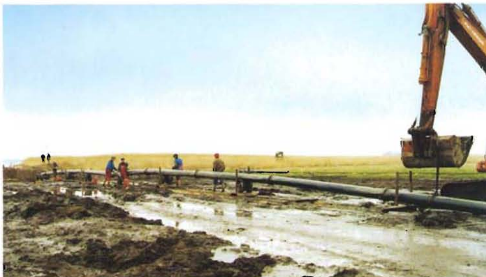
Bild 5: Einziehen der Rohre über luftbereifte Tragkonstruktionen
