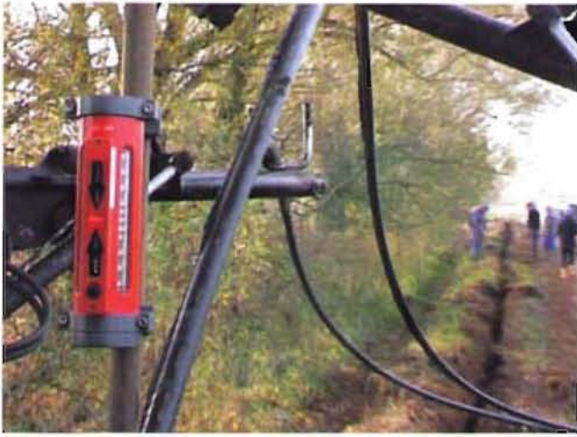
Bild 4: Rundumlaser (Empfänger) am Raketenpflug
