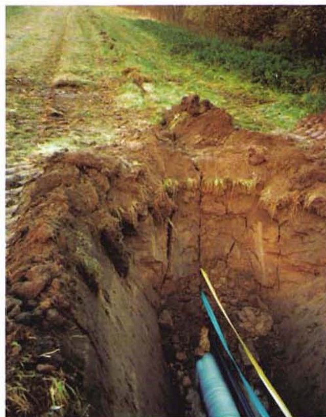
Bild 9: Rohrtrasse nach dem Einpflügen
