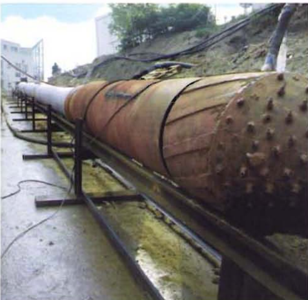
Bild 7: Räumler mit fixiertem Führungsrohr und angekuppeltem 1. Rohrstrang, unmittelbar vor dem Einzug
