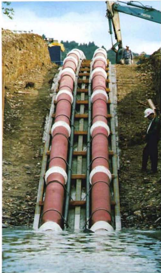
Bild 9: Mit dem vorgeplanten Biegeradius überwindet der Düker das Niederwerther Ufer
