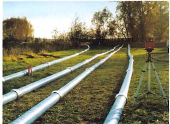
Bild 5: Vormontierte Rohrstränge
