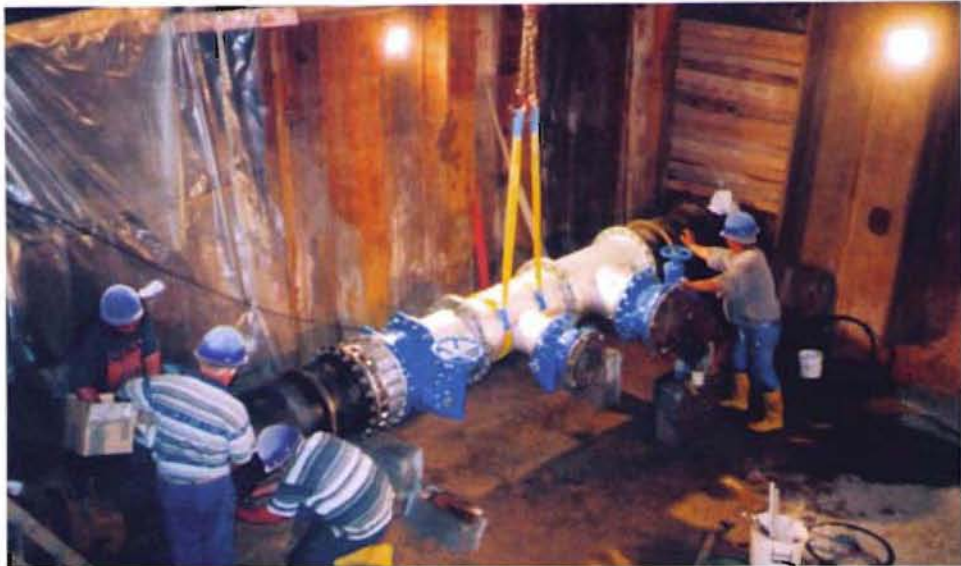
Bild 7: Nachteinbindung in die bestehende Förderleitung DN 500 in Neu- lußheim
