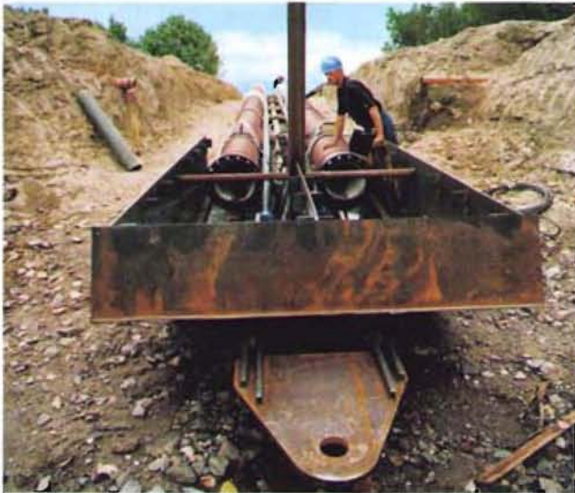
Bild 6: Der Zugkopf (Gleitschlitten) wird angebracht
