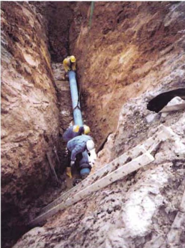
Bild 4: Verlegung der duktilen Gußrohre direkt im „gewachsenen“ Boden
