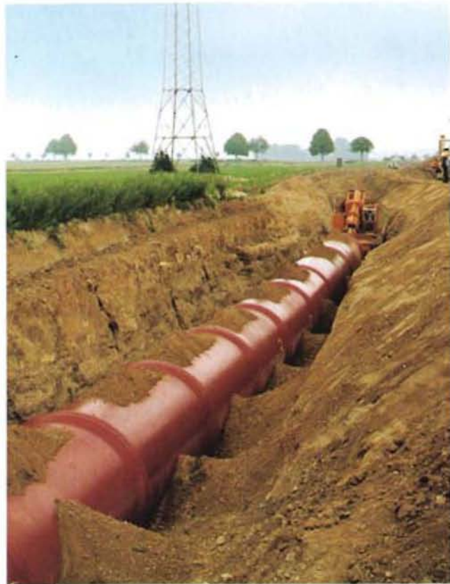
Bild 3: Einbau der Rohre im offenen Graben
