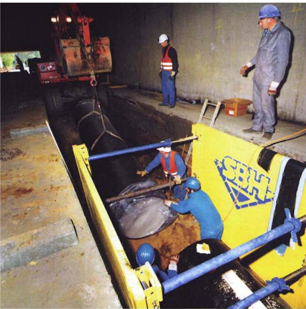
Bild 5: Vor-Kopf-Einbau unter der Brücke
