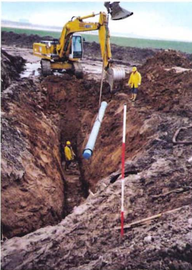
Bild 3: Einbau duktiler Gußrohre mit Zementmörtelummhüllung in 5 m Tiefe unter extremen Witterungsbedingungen
