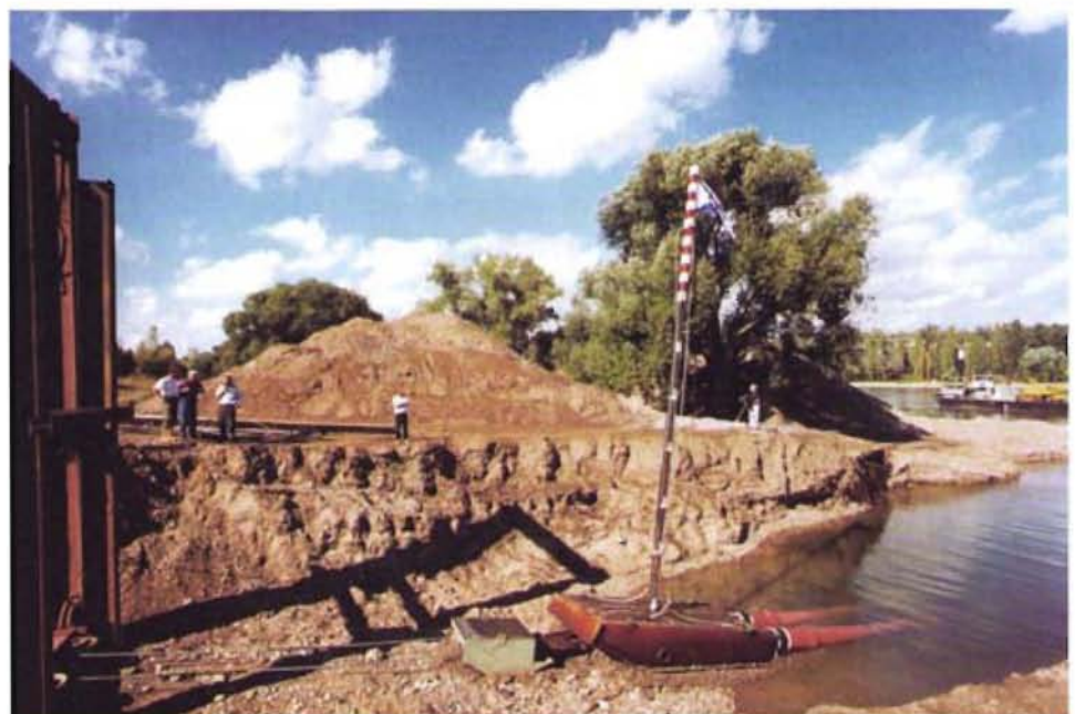
Bild 7: Der Zugschlitten kommt am Koblenzer Rheinufer an
