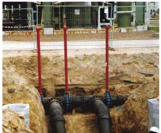
Bild 7: Absperrklappen
