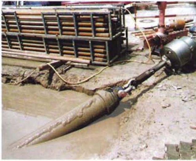
Bild 8: Der ankommende Rohrstrang nach dem Einziehen
