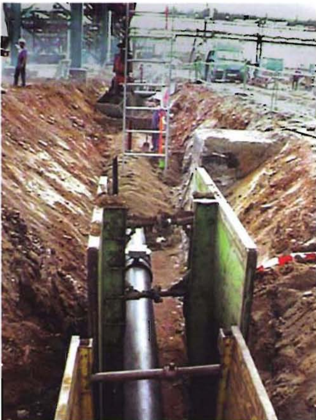
Bild 3: Trasse mit Fundamenten
