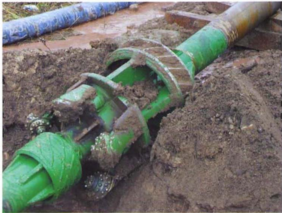
Bild 5: Aufräumer vor dem Einfahren in den Bohrkanal
