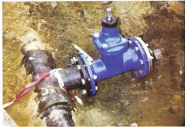
Bild 5: Armaturen mit Flanschverbindungen aus duktilem Gußeisen
