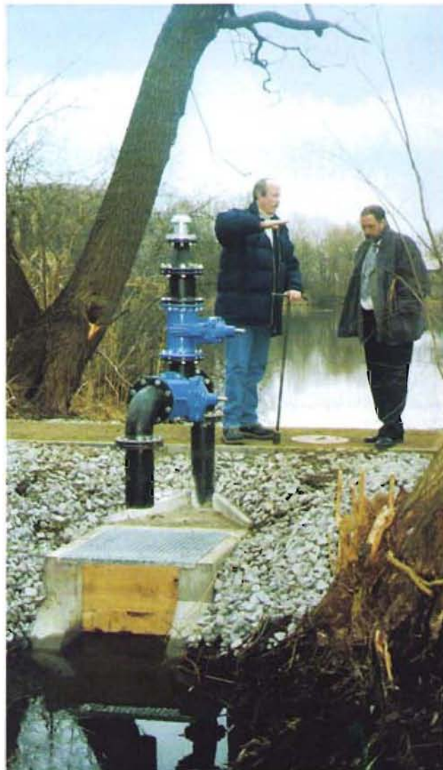
Bild 9: Einlaufbauwerk mit Heberkopf
