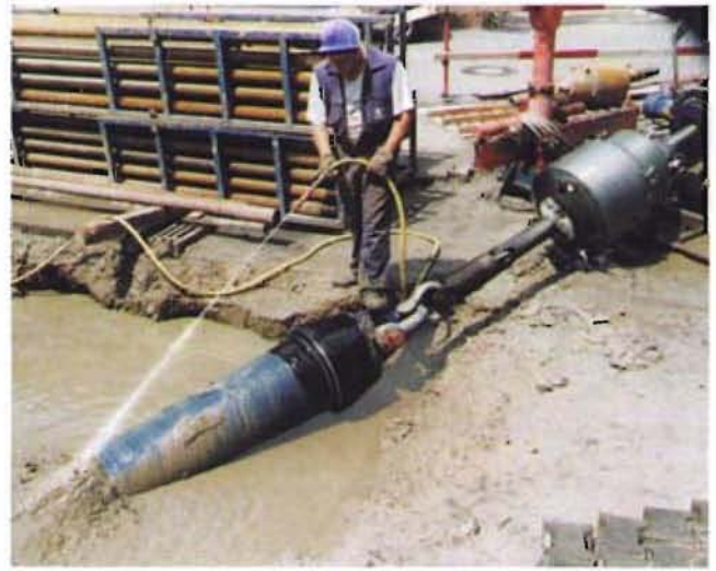
Bild 9: Keine Beschädigungen der Schrumpfmanschette
