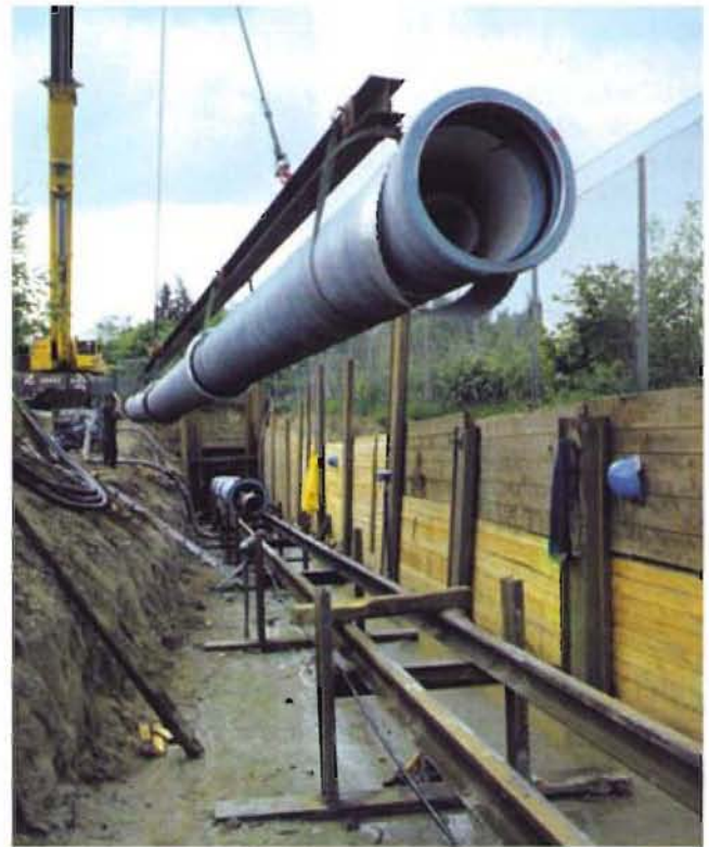
Bild 8: Einrichtung des 2. Rohrstranges
