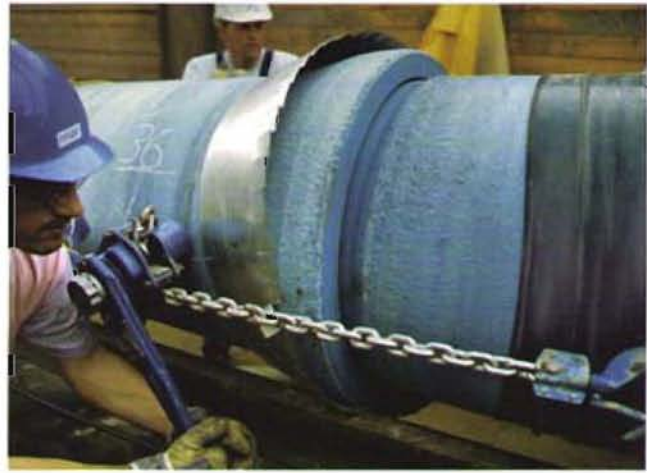
Bild 10: Montage des Mediumrohres DN 600
