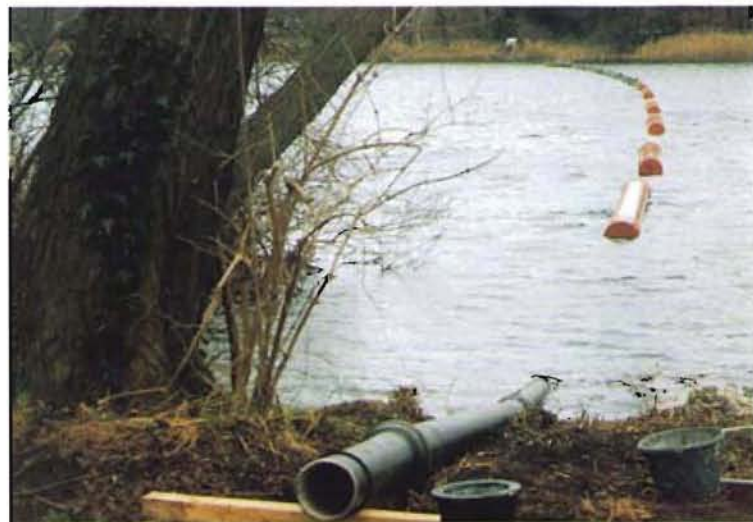
Bild 6: Einschwimmen der Gußrohre - landseitig
