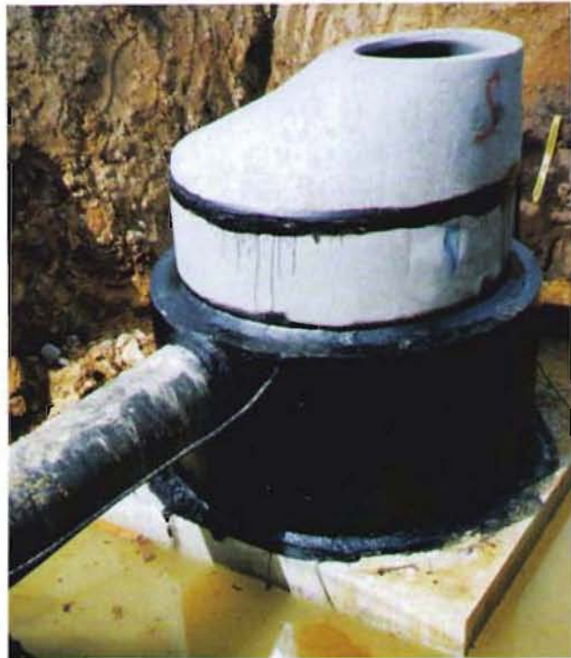
Bild 3: Rohbau eines Be- und Entlüftungsbauwerks tungsinwendendurchmesser von 400 mm. Um den Hochpunkt an der Landesgrenze NRW/RLP zu überwinden, mußte ein Pumpwerk im Bereich des HB „Wachtberg“ geplant werden.
