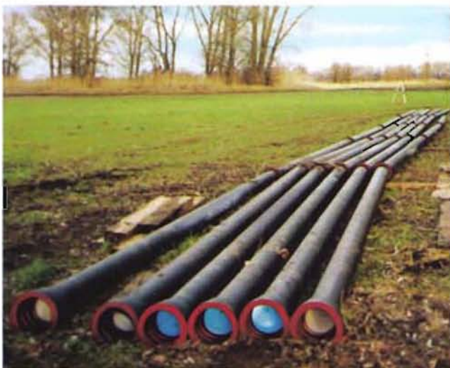
Bild 5: Vormontierte Rohrstränge
