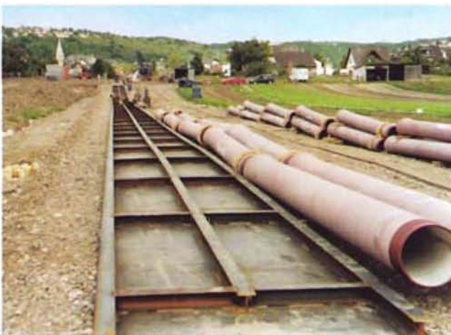
Bild 3: Die Stahlunterkonstruktion des Dükerbündels wird an Land montiert
