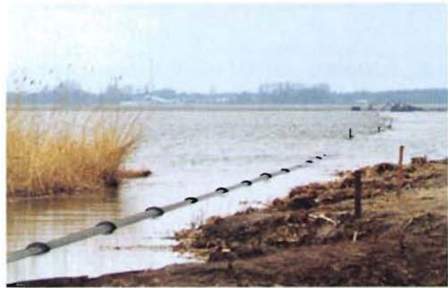
Bild 6: Schwimmender Strang auf der Fitt. Im Hintergrund die eingespülten Bohrpfähle zur Fixierung der Rohrleitung
