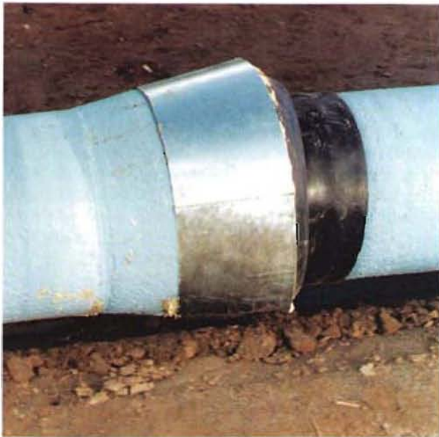
Bild 6: Rohrverbindung mit Blechkonus
