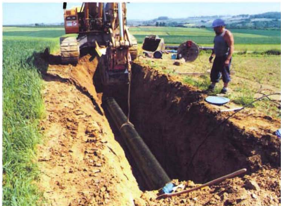
Bild 8: Vor-Kopf-Verlegung
