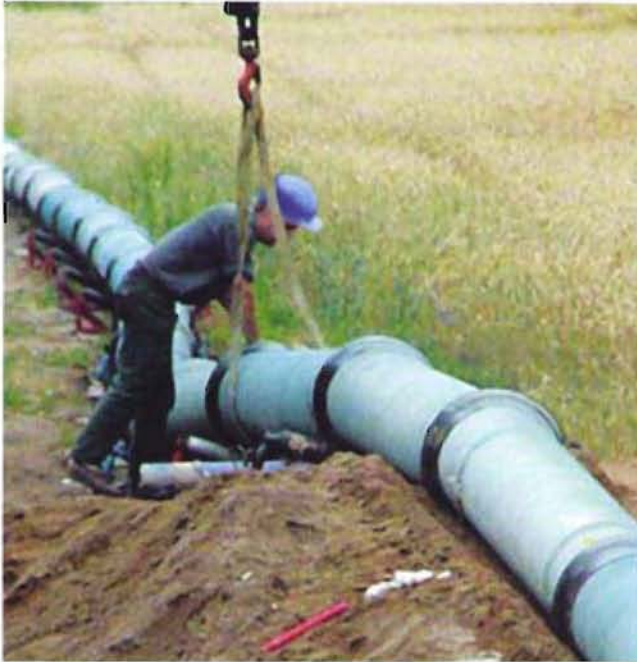
Bild 3: Rohrstrang vor dem Einziehen. Die Abwinkelbarkeit der Muffenverbindungen ist deutlich erkennbar
