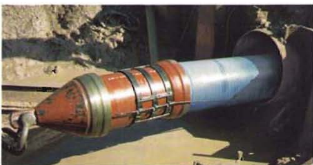
Bild 11: Im Schacht angekommener Zugkopf
