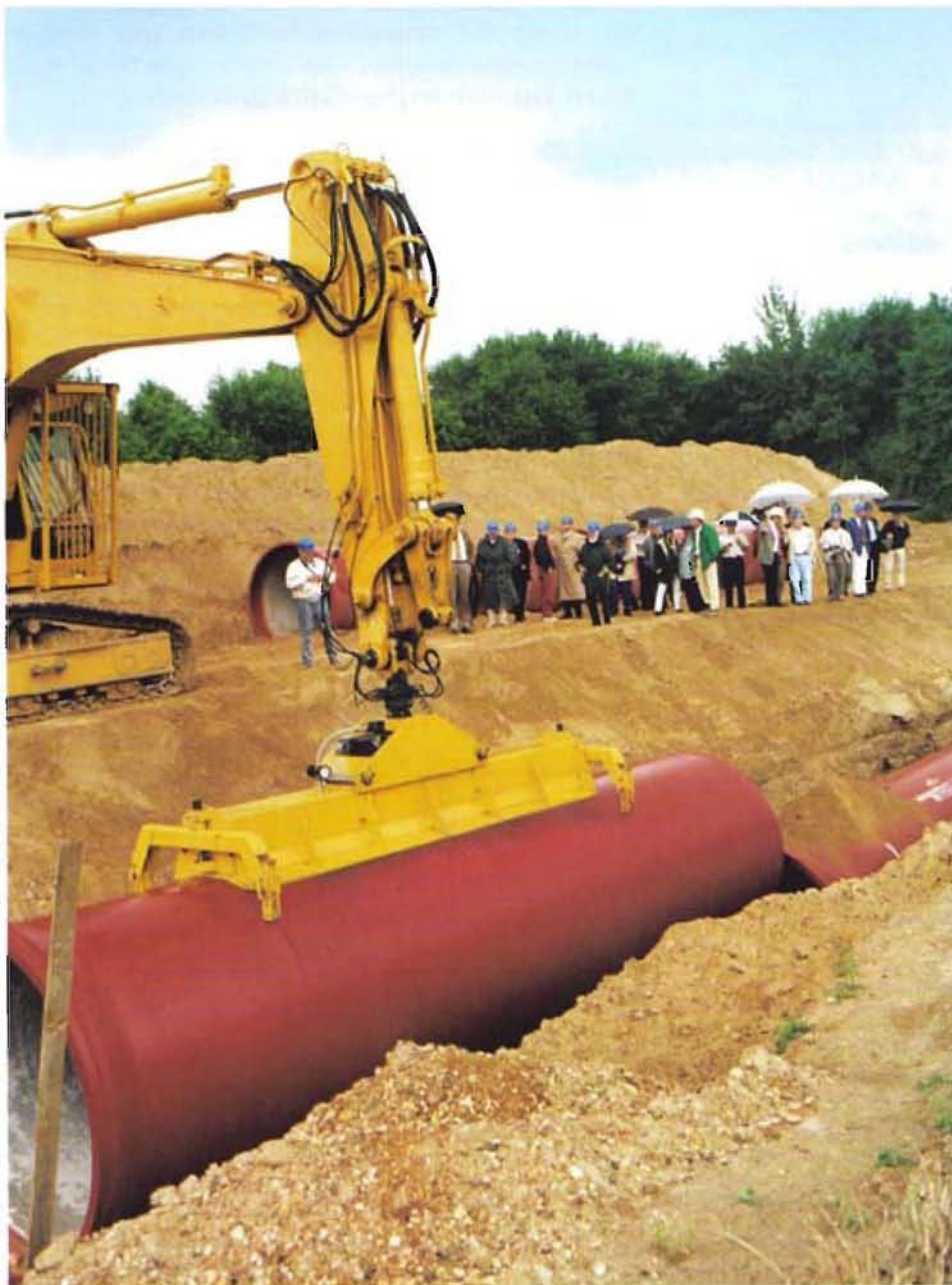
Bild 2: 10 t duktilen Gußrohrs hängen am Unterdruckheber
