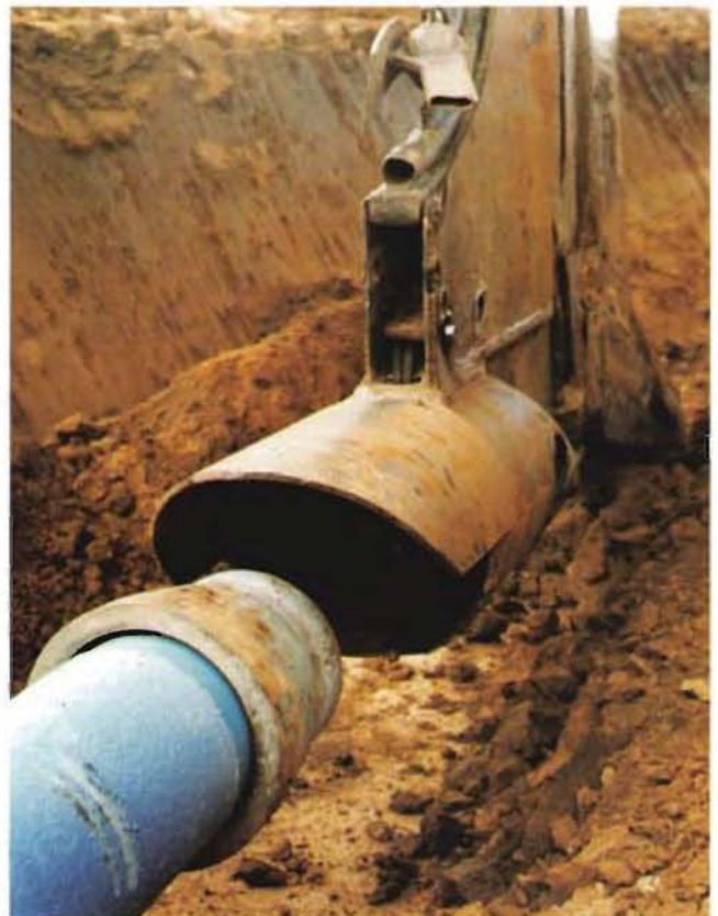
Bild 7: Angekoppelter Rohrstrang
