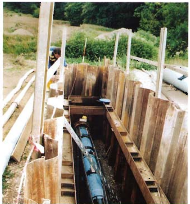
Bild 6: Dükergrube im Tal mit Schutzrohr DN 800
