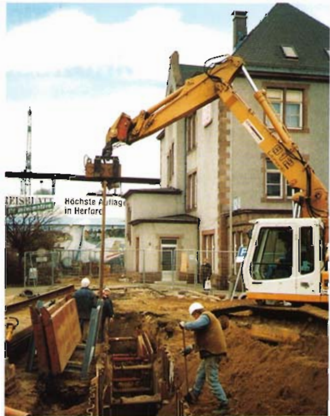
Bild 5: Baustelle am Bahnhof
