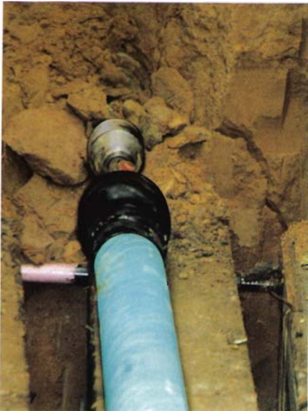
Bild 3: Der hinter dem Aufweitkopf montierte Zugkopf wird in den Bohrkanal eingezogen
