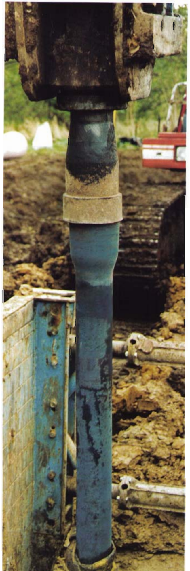
Bild 2: Duktiler Rammpfahl
