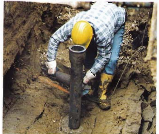
Bild 5: Abschneiden der Einbauhöhe
