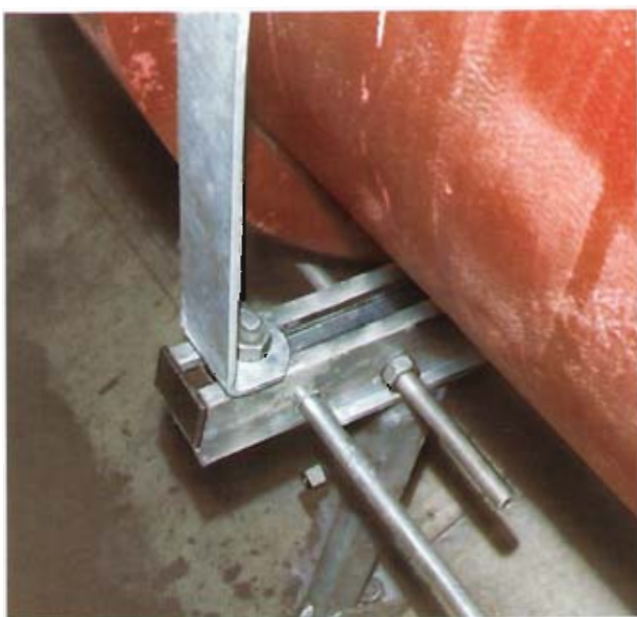
Bild 5: Auflagerkonstruktion im Tunnel
