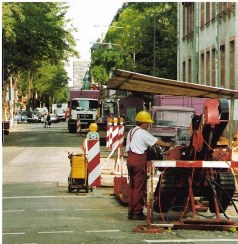
Bild 5: Textorstraße mit Bohreinrichtung
