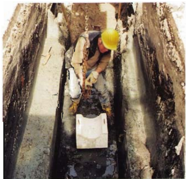
Bild 6: Aufsetzen des Beton-Auflagers
