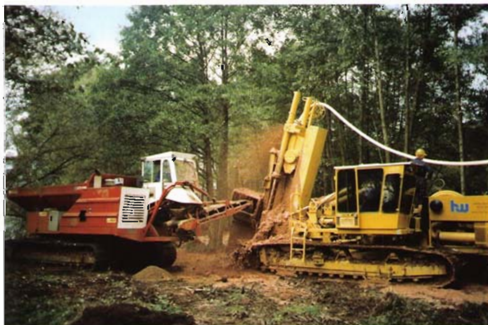
Bild 4: Geräte beim Einfräsen des Drainageschlauches
