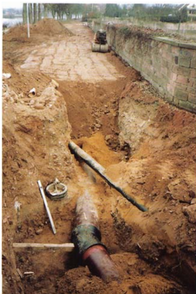
Bild 3: Unterquerung der Gasleitung DN 150, PN 16
