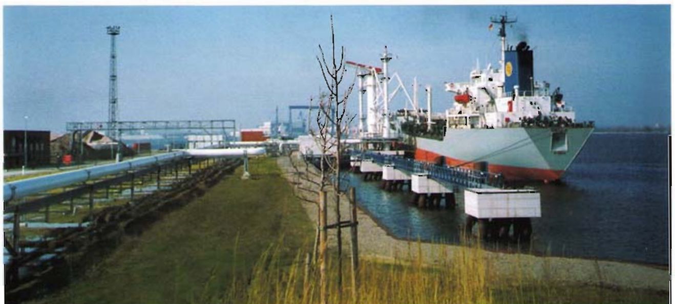
Bild 3: Direkt neben dem Schiffsanleger befindet sich die Entnahmestelle für das Löschwasser
