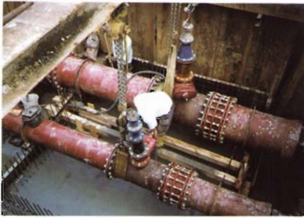
Bild 8: Be- und Entlüftungsbauwerk
