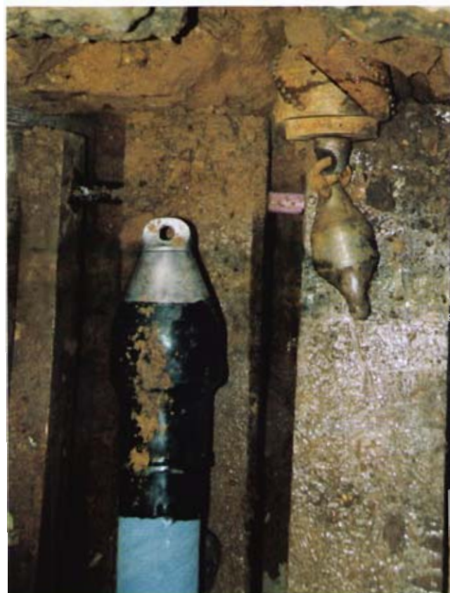
Bild 2: Zugkopf am Beginn des Rohrstranges
