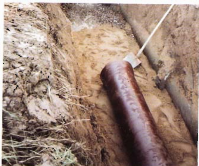
Bild 2: Rohrverlegung parallel dem Wallstadt-Sammler
