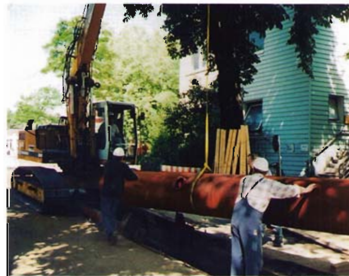
Bild 4: Einbau der Rohre DN 700
