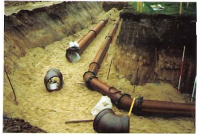
Bild 3: Bauabschnitt Reideburger Landstraße/Diemitzer Graben
