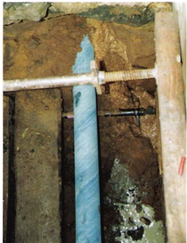
Bild 4: Das erste Rohr wird in den Bohrkanal eingezogen
