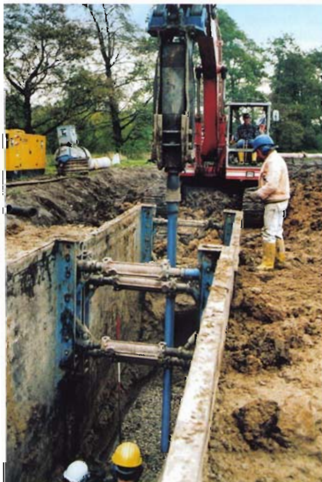
Bild 4: Rammen der duktilen Pfähle
