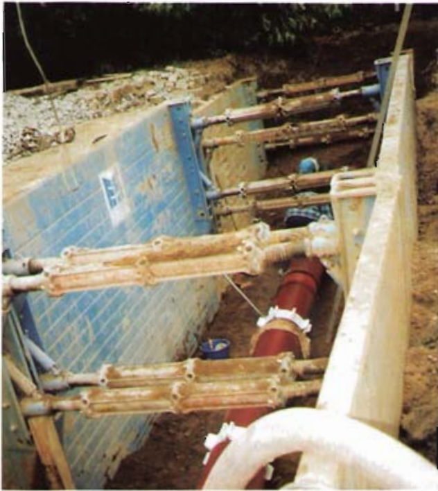
Bild 5: Mediumrohr vor dem Einführen in das Schutzrohr
