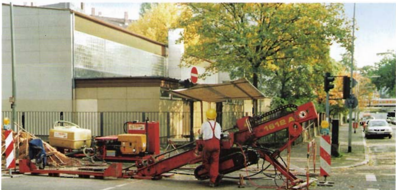
Bild 1: Bohreinrichtung beim Einziehen des Rohrstranges
