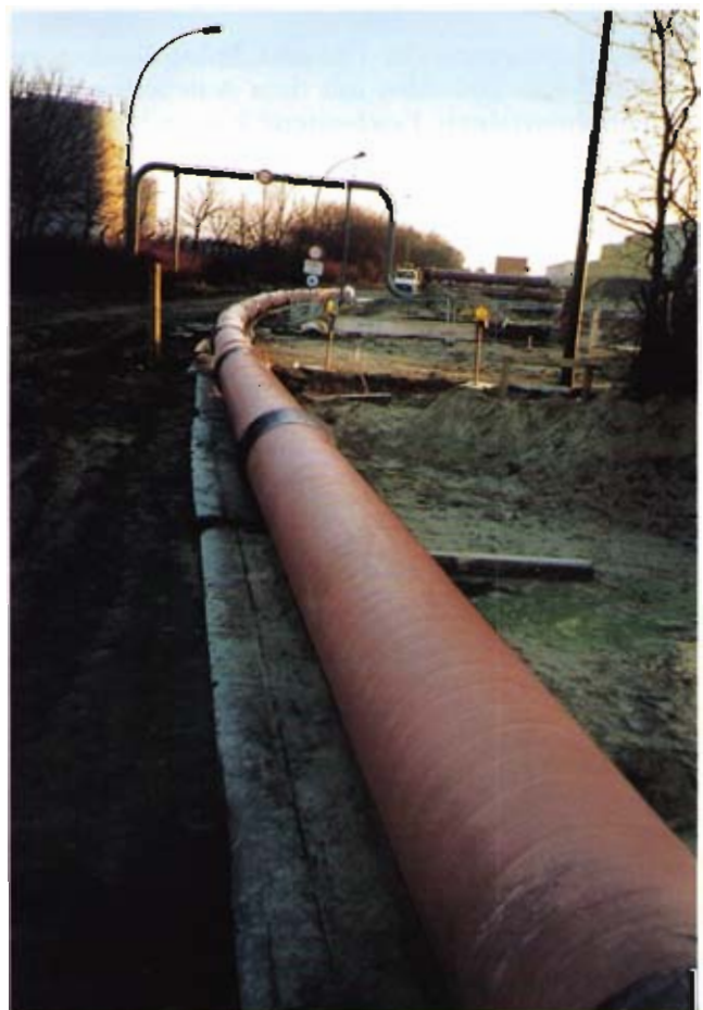
Bild 6: Auf einer Gleitbahn vormontierter Düker
