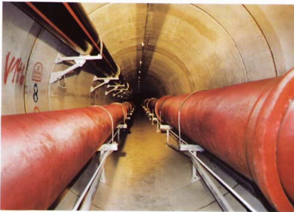
Bild 4: Montierte Rohrstränge im Schutzrohr
