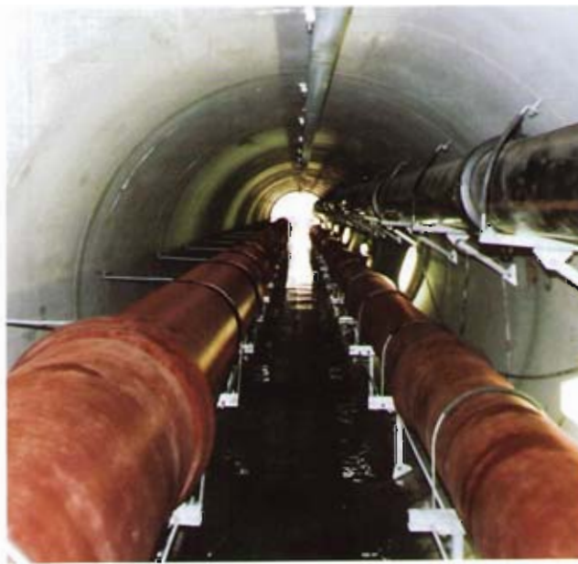
Bild 7: Tunnel mit eingebauten Rohren
