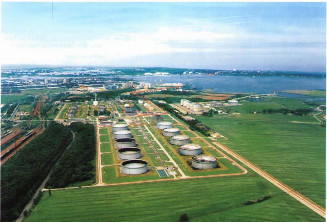
Bild 1: Das Hafengebiet von Rostock mit der Rohrtrasse, im Vordergrund das Tanklager
