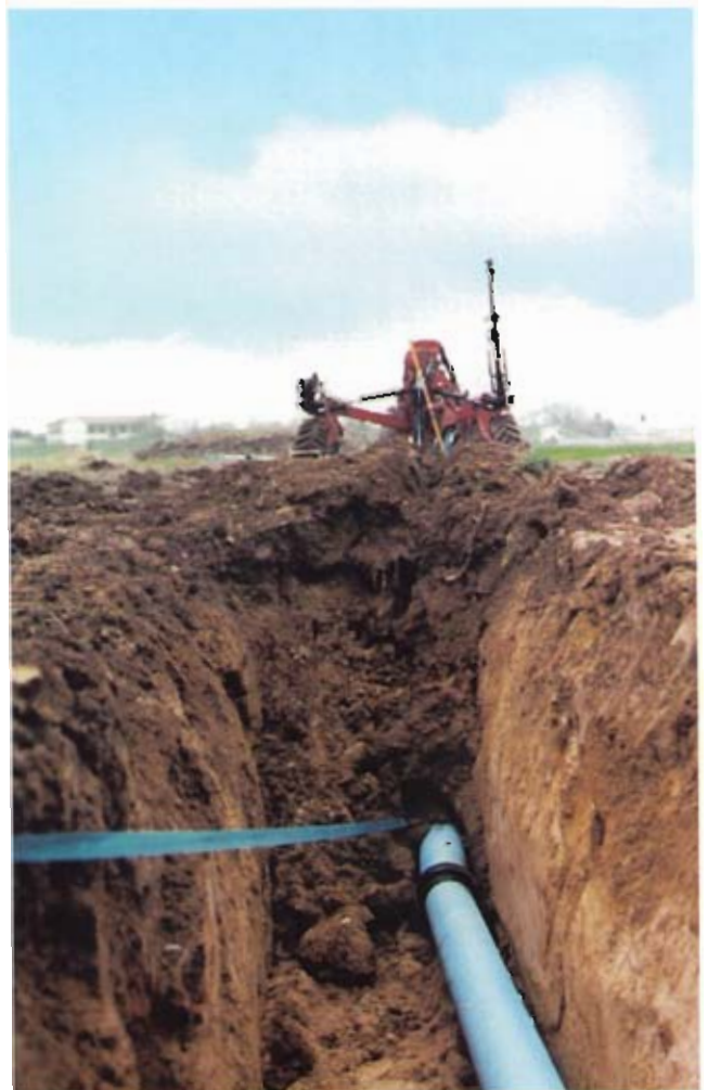
Bild 8: Einziehen der Gußrohrleitung DN 150 mit etwa 7 m/min.
