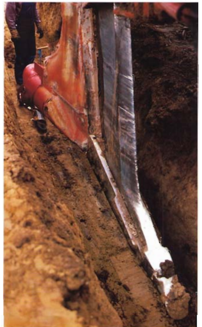
Bild 3: Pflugschwert mit Aufweitkörper
