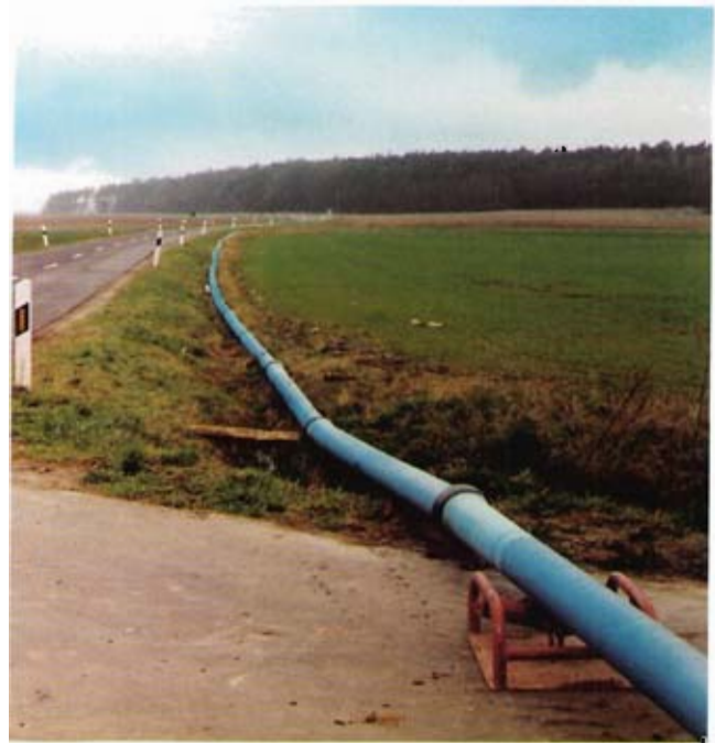
Bild 5: Vormontierte längskraftschlüssige Gußrohrleitung
