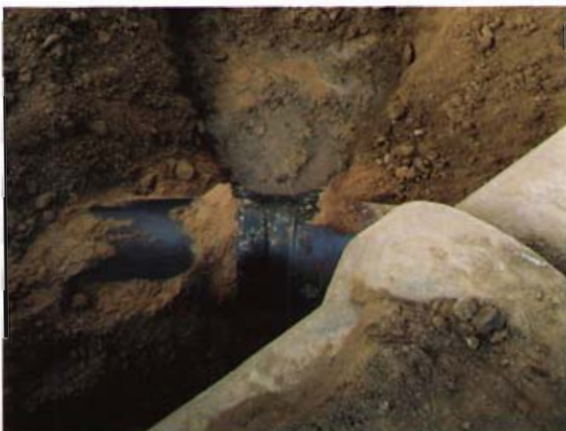
Bild 6: Vorbereitung eines Krümmerwiderlagers
