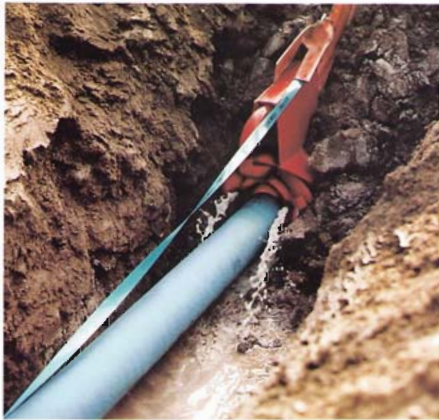
Bild 7: Einsetzen des Pflugschwertes in der Startgrube
