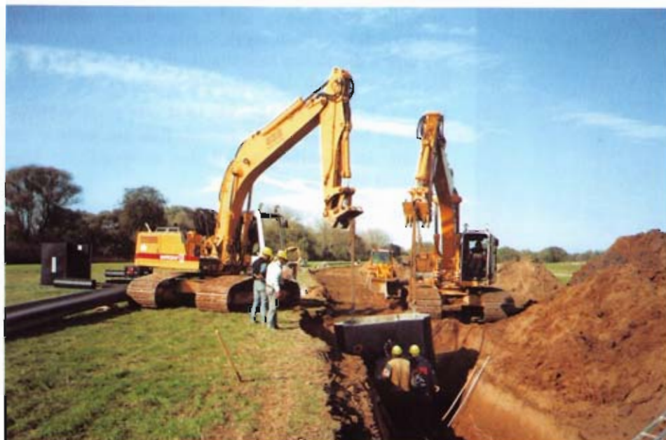
Bild 8: Geräte beim Setzen eines Revisionsschachtes
