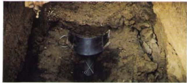
Bild 6: Temporäre längskraftschlüssige Befestigung
