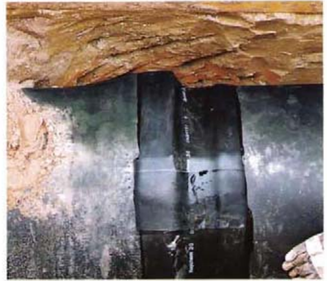
Bild 4: Schrumpfschlauch über TYTON-TKF-Verbindung
