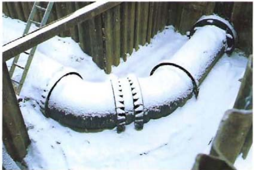
Bild 4: Im Winter zeigten sich die Vorzüge duktiler Gußrohre
