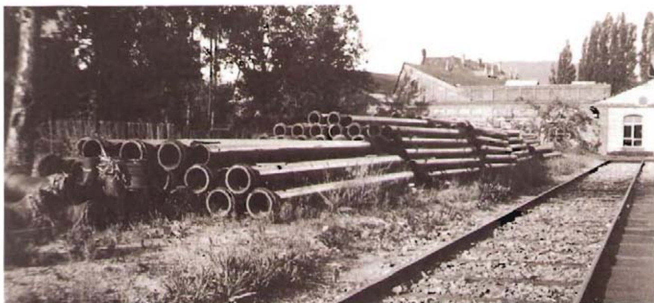
Bild 9: Rohrlager im Werksgelände
