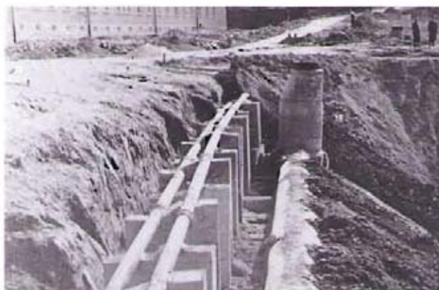
Bild 10: Rohrverlegung zu den neuen Kasernen
