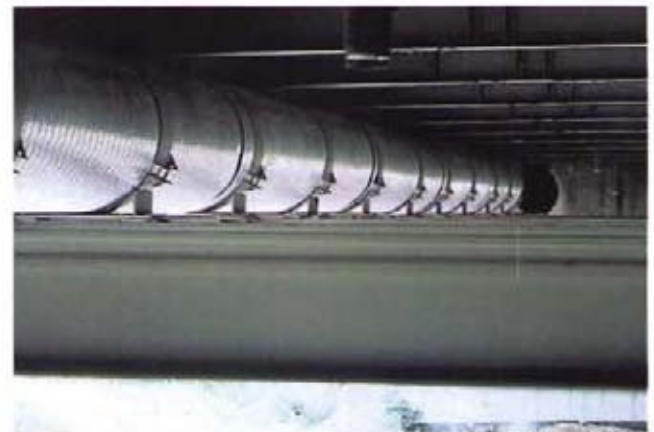
Bild 11: Montierte Leitung im Bildraffer
