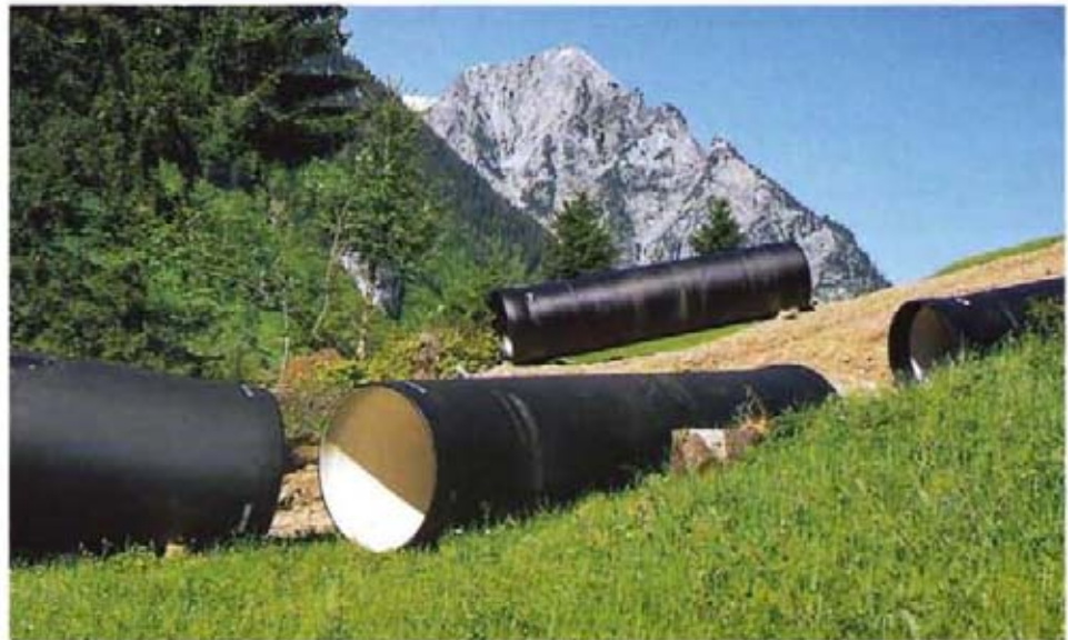
Bild 2: Duktile Gußrohre DN 1600 neben der Trasse
