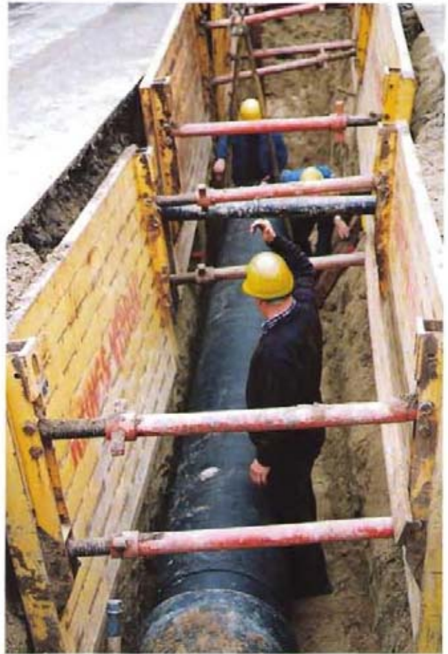
Bild 5: Sichere Verbautechnik hatte Vorrang
