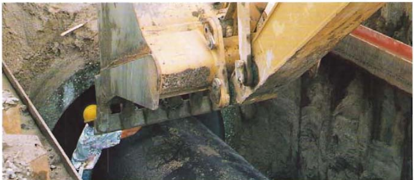
Bild 6: Unterquerung durch vorgepreßte Stahlbetonrohre
