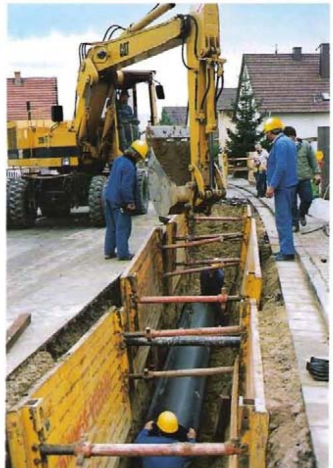
Bild 7: Einbau im Ortsbereich
