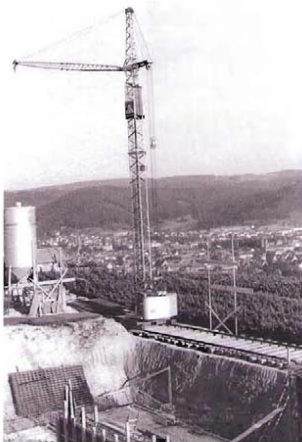
Bild 11: Bau des neuen Scheitelbehälters 1000 m 2 auf dem Schutterlindenberg 1961
