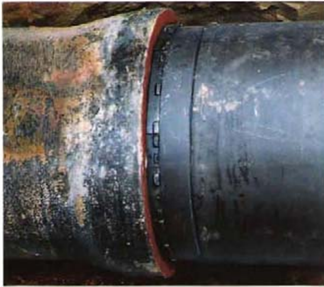
Bild 2: Steckmuffenverbindung TKF
