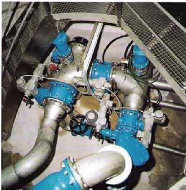
Bild 11: Installation eines „Mittelpunkt“-Hochbehälters
