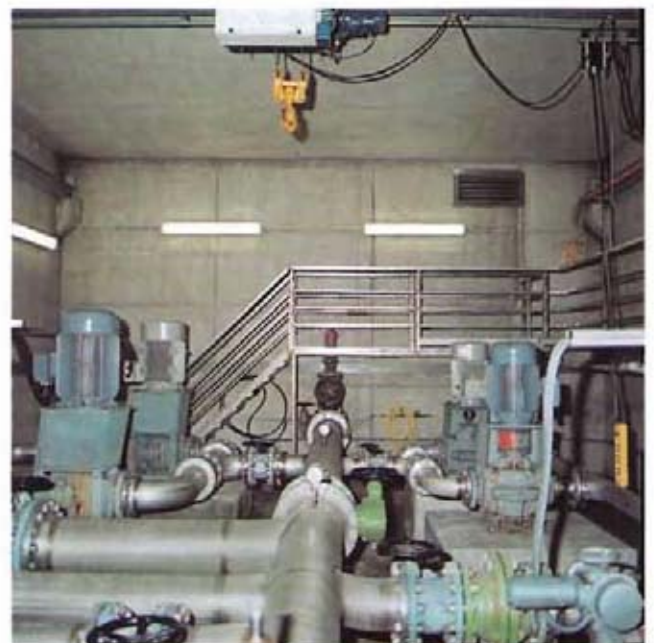
Bild 9: Installation einer zentralen Pumpstation
