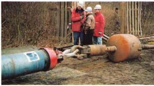
Bild 8: Dükerröhrenstrang fertig zum Einziehen
