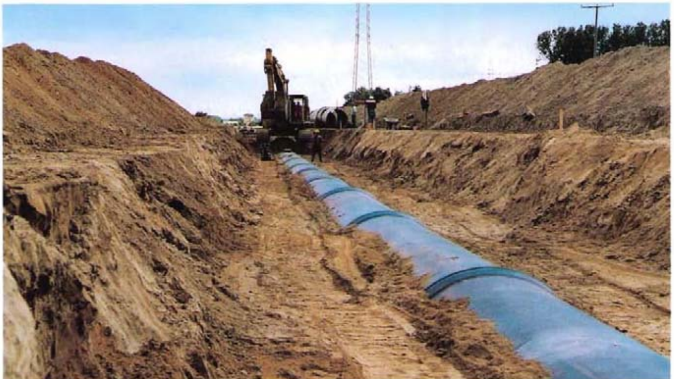
Bild 2: Leitungstrasse vor dem Verfüllen
