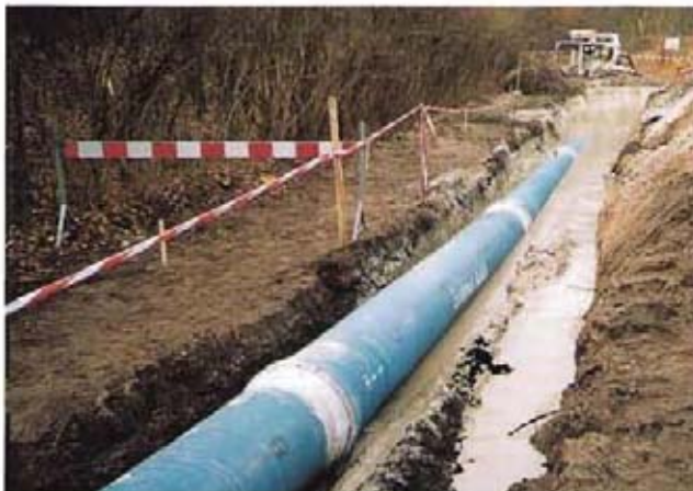
Bild 9: Abgeschrägter Graben
