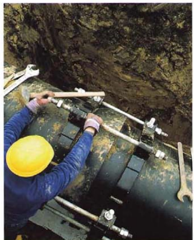
Bild 7: Montage der Auszugssicherungen
