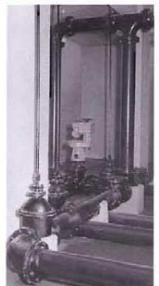
Bild 12: Blick in die Behälter-Vorkammer des Wasserhochbehälters
