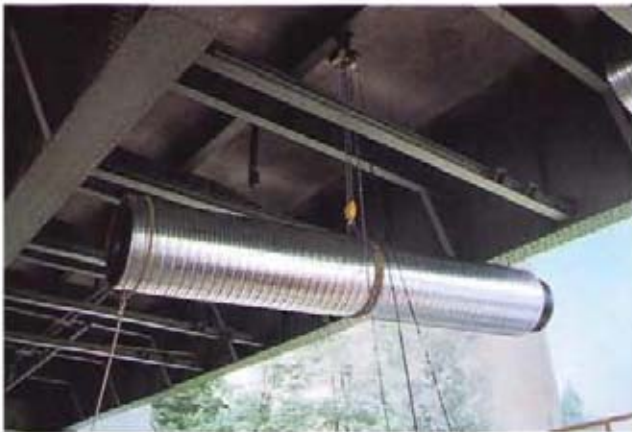
Bild 8: Anheben auf Leitungshöhe
