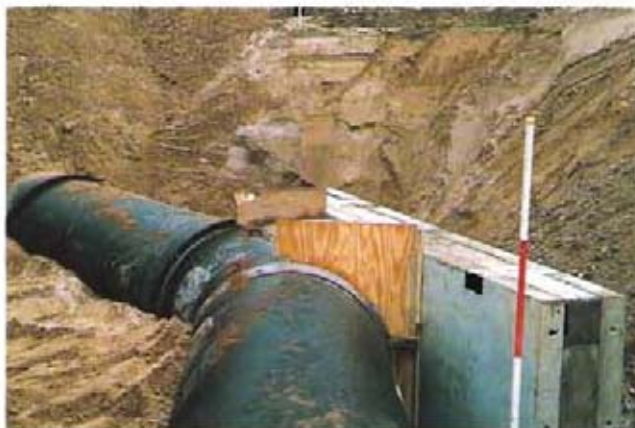
Bild 5: Einleiten der Bogenkräfte mit bewehrten Flügellagerplatten
