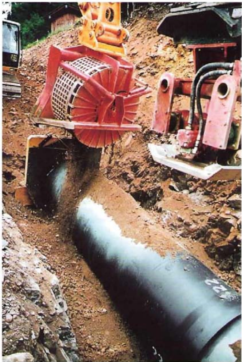
Bild 10: Gewinnung von Bettungsmaterial mit einem Drehsieblöffel
