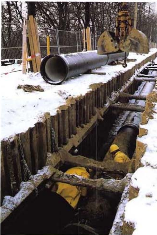
Bild 5: Einbau im geraden Teil der Trasse
