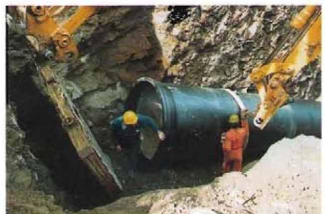
Bild 9: Rohrleitungsbau im alpinen Gelände
