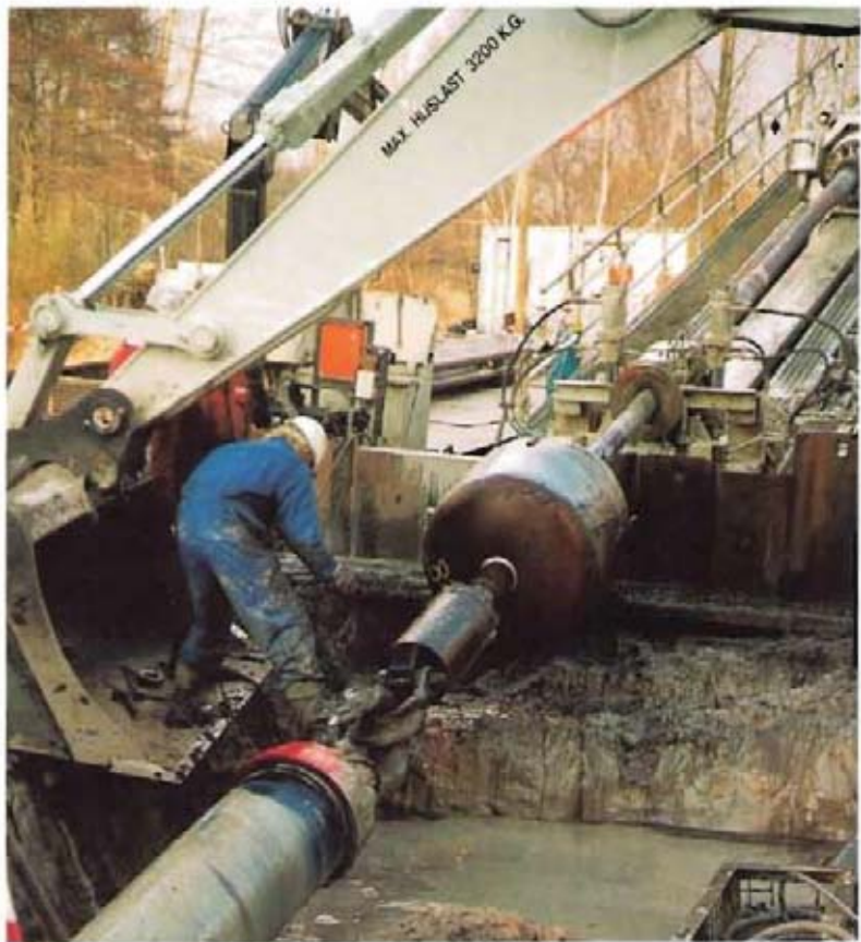
Bild 11: Eintreffen des Dükerstrangs an der Startgrube
