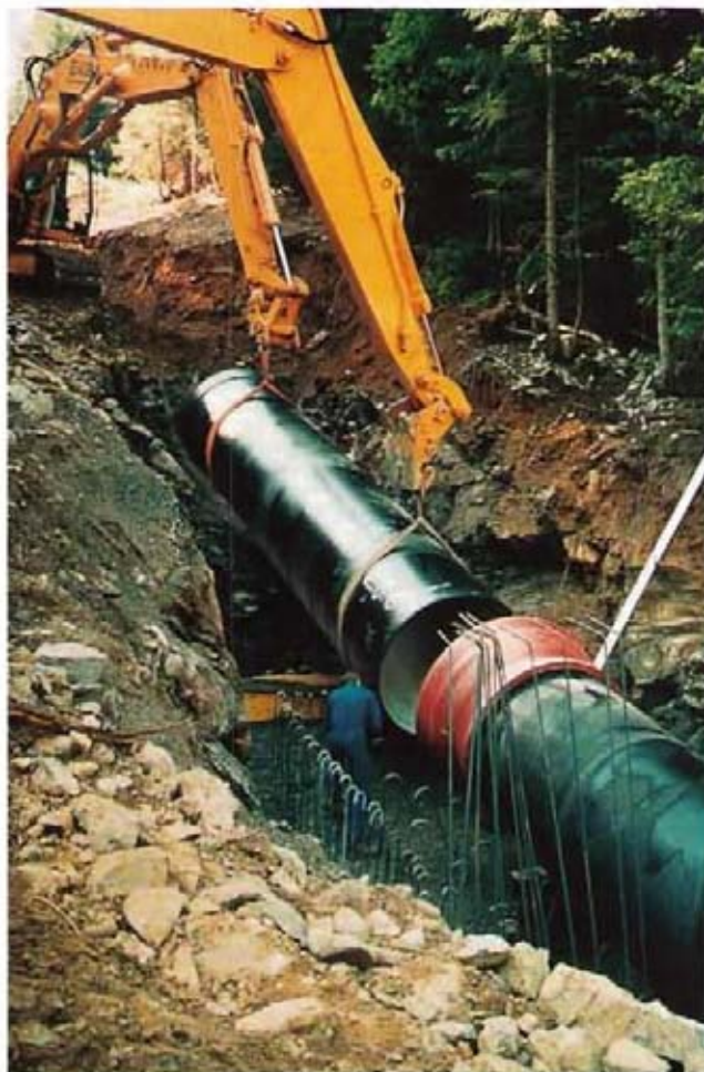
Bild 3: Übergang von DN 1600 auf DN 1400
