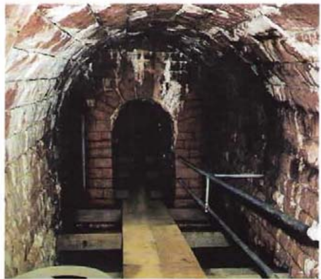
Bild 4: Innenansicht der Giesen-Sicker-galerie
