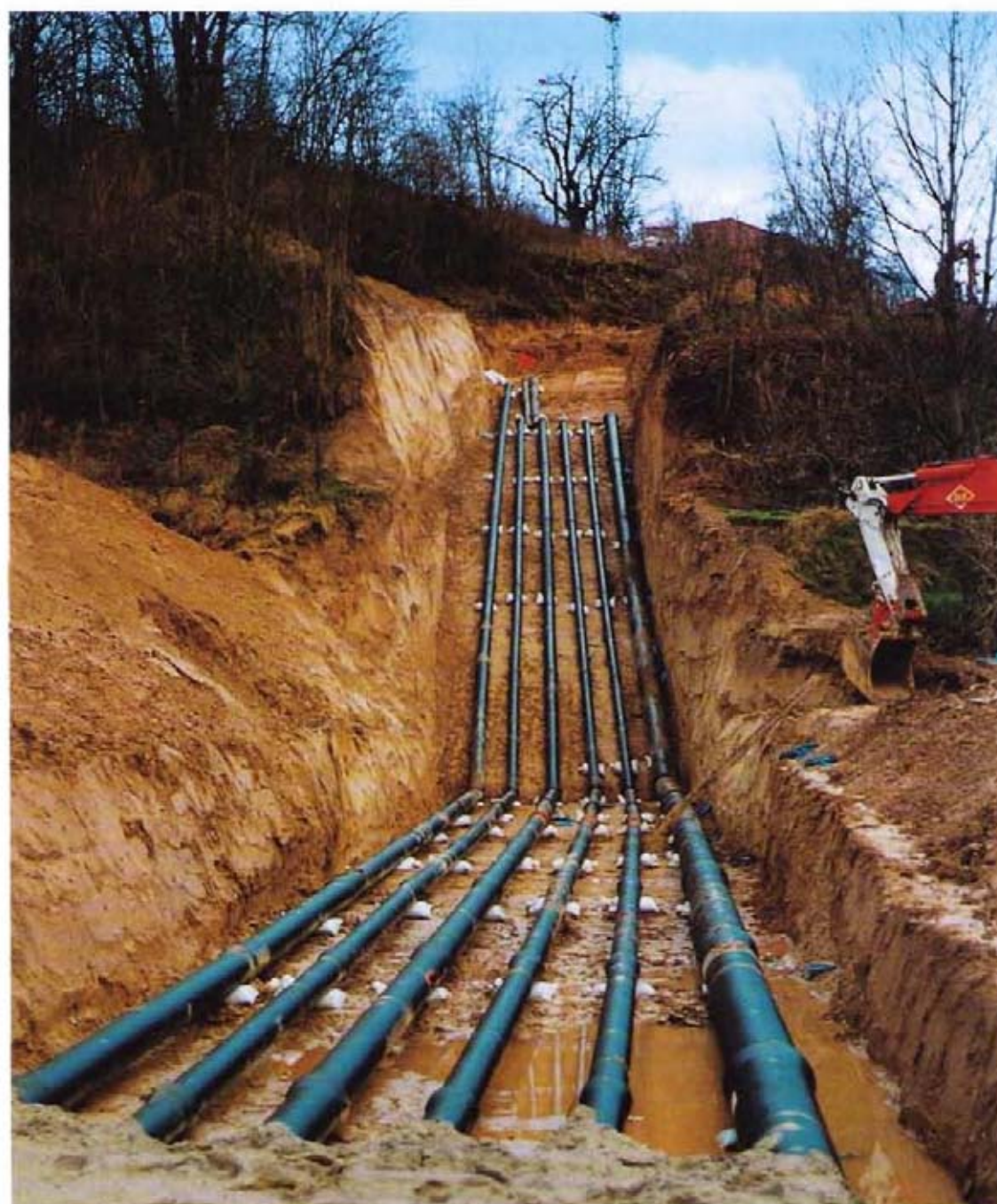
Bild 6: Steilstrecke ( I \approx 50\% ) kurz vor der Einbindung in das Wasserwerk
