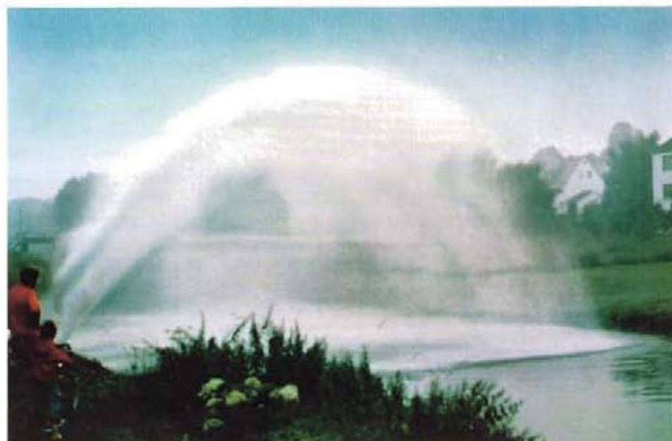
Bild 3: Spülung einer Hauptversorgungsleitung im Siegtal
