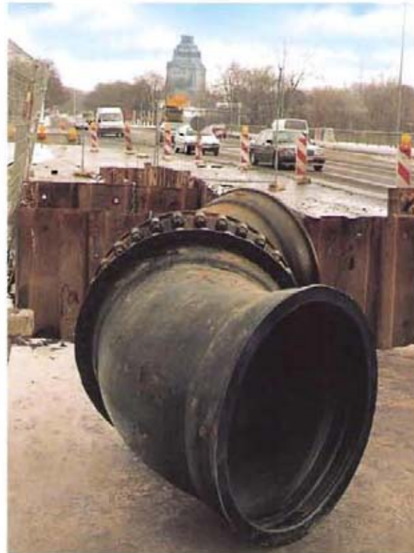
Bild 3: Bögen mit TIS-Verbindungen
