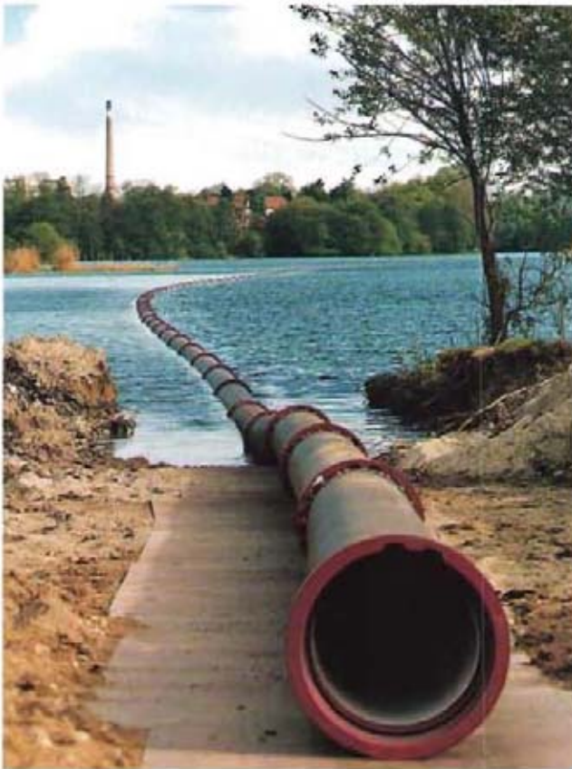
Bild 3: Arbeitsfläche für die Montage der Rohrverbindungen
