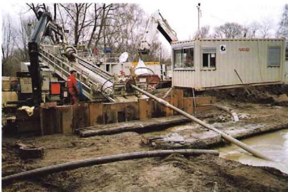
Bild 6: Horizontal-Bohrmaschine, Zugkraft 2500 kN
