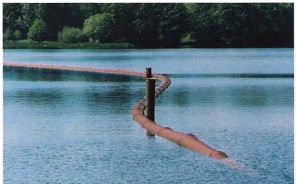
Bild 6: Fluten der fertigen Leitung
