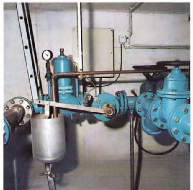
Bild 6: Automatische Druckregulierung bei Defekt des Druckminderventils mit Fernschalter
