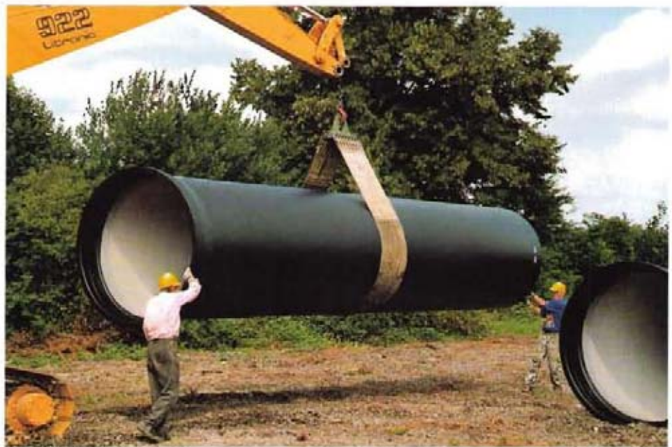
Bild 3: Duktile Gußrohre DN 1600, 8,15 mm lang, mit Standard-Muffe
