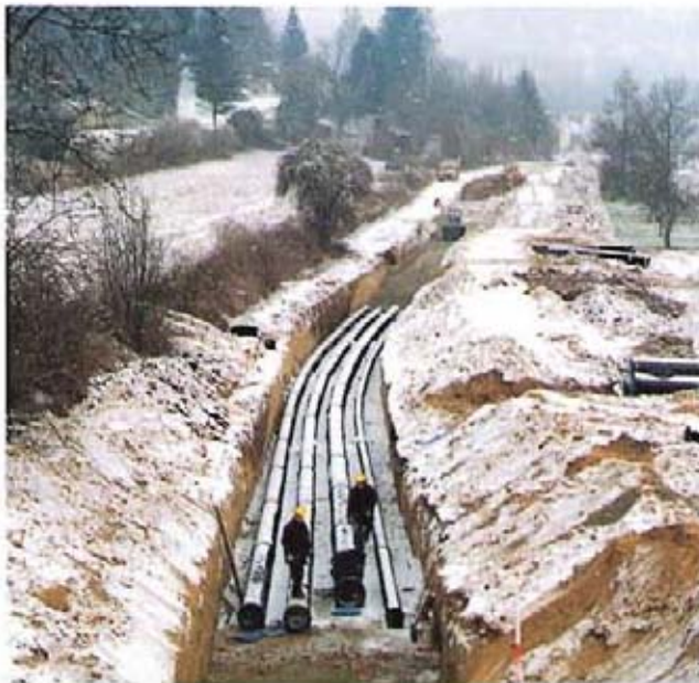
Bild 2: Los 1 - Parallelverlegung von Zu- und Abgangsleitungen der Nennweiten DN 250 bis DN 500
