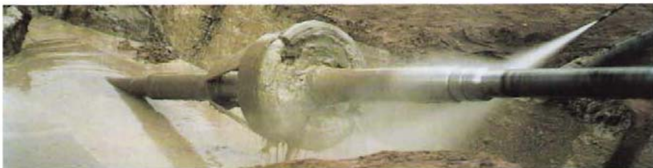
Bild 7: Eintreffen des Aufweitkopfes an der Bohrmaschine
