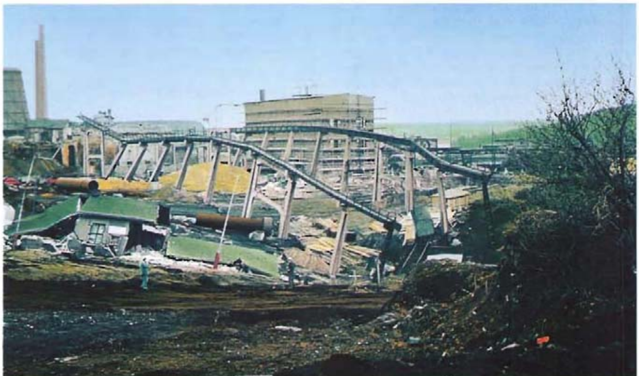
Bild 1: Zerstörungen einer Hüttenanlage nach Gebirgsschlägen
