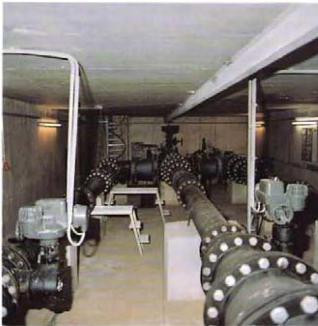
Bild 5: Installation eines Übergabeschachtes GGG DN 600 mit 3 Meßstrecken
