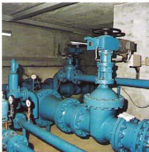
Bild 4: Installation eines Verteilerbauwerkes GGG DN 600 mit Übergabe-Einrichtung
