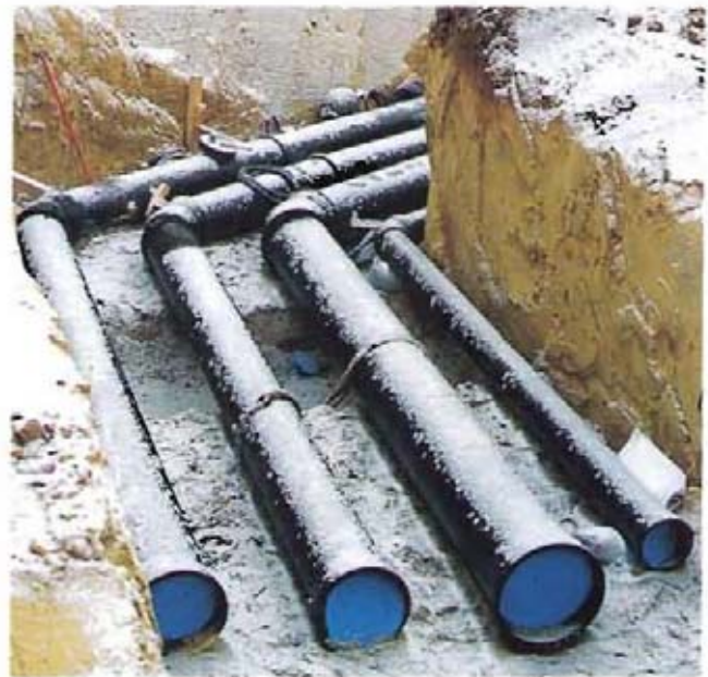
Bild 5: Los 1 - Zeitweise mußten wegen Frost und Schnee die Einbauarbeiten eingestellt werden.
