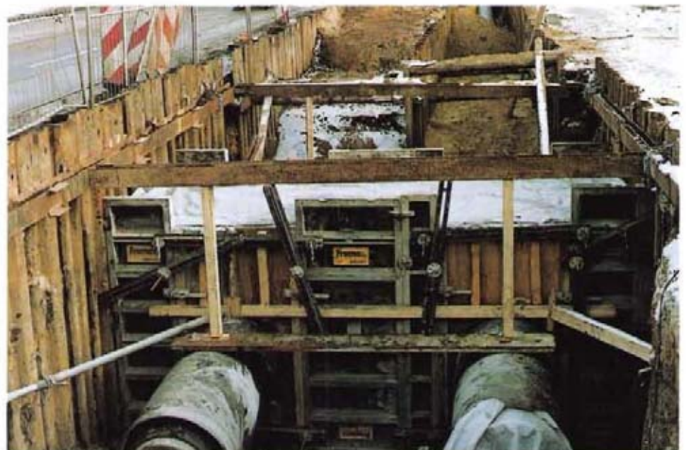
Bild 6: Betonwiderlager zur Sicherung beider Leitungen
