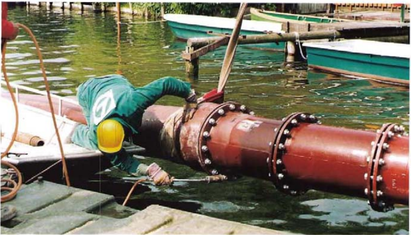
Bild 5: Aufsteigender Dükerast zum Pumpwerk
