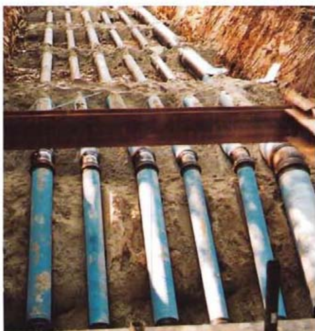
Bild 7: Leitungseinführung vor dem Entleerungsbauwerk „Dammenmühle“
