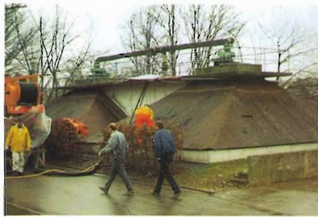
Bild 3: Die alten Faulbehälter, an deren Stelle das neue Pumpwerk errichtet wurde.
