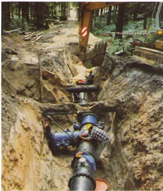
Bild 8: Bauabschnitt 04, Schieberkreuz Strietwald zum Hochbehälter
