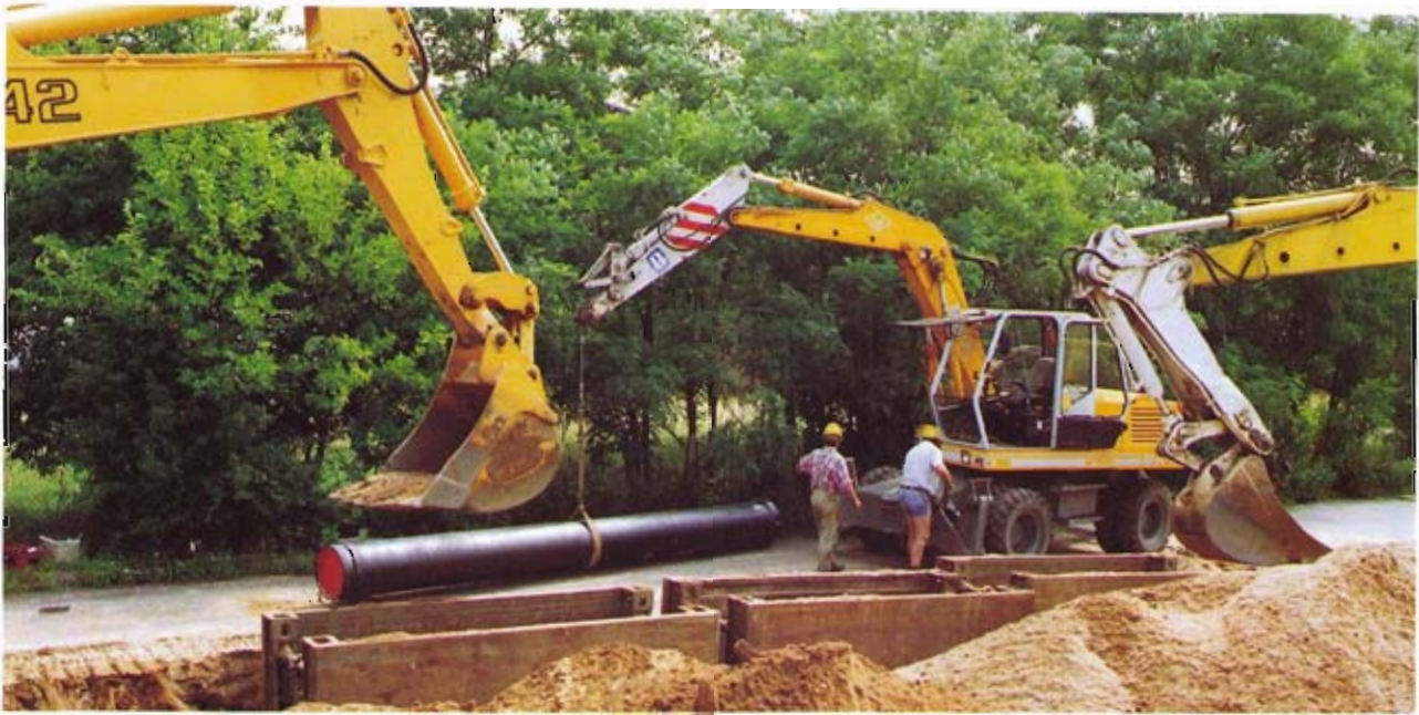
Bild 2: Bauabschnitt 01, am Niedernberger Weg
