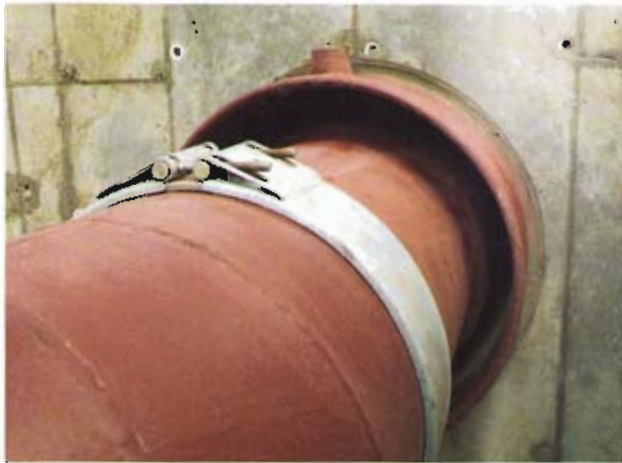
Bild 7: Mantelrohr-Ende und Kontrollstutzen, noch offen
