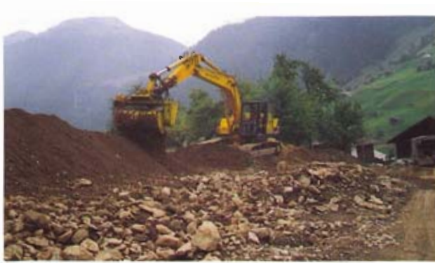
Bild 7: Sieben des Einbaumaterials für die Bewuchsdecke mittels Rotar-Cleaner
