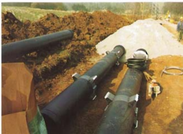
Bild 5: Duktile Gußrohre vor der Verlegung (zum Teil mit Gleitkufen zum Einzug in ein Schutzrohr versehen).
