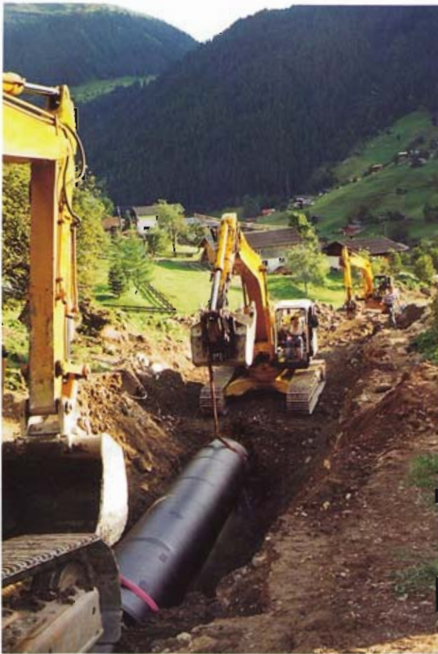
Bild 4: Verlegung der neuen duktilen Gußeisen-Rohre im „Auf-zu-System“
