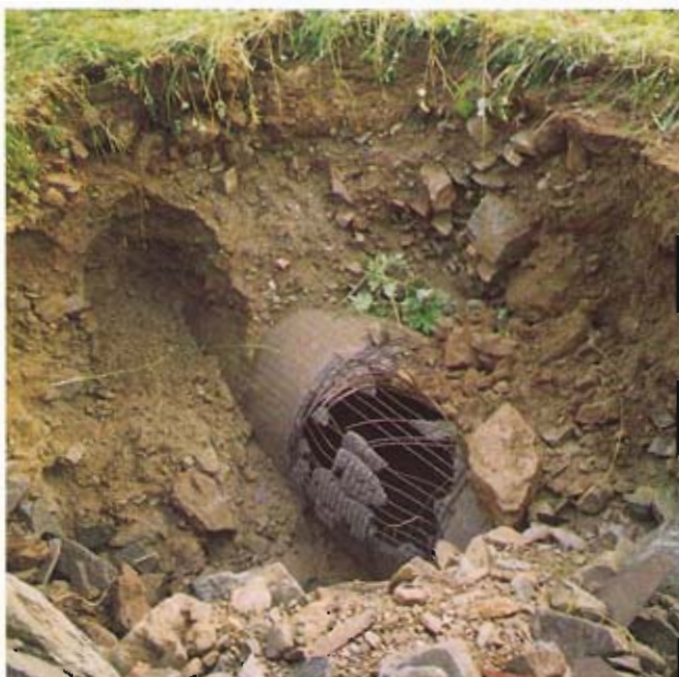
Bild 1: Rohrbruchstelle
