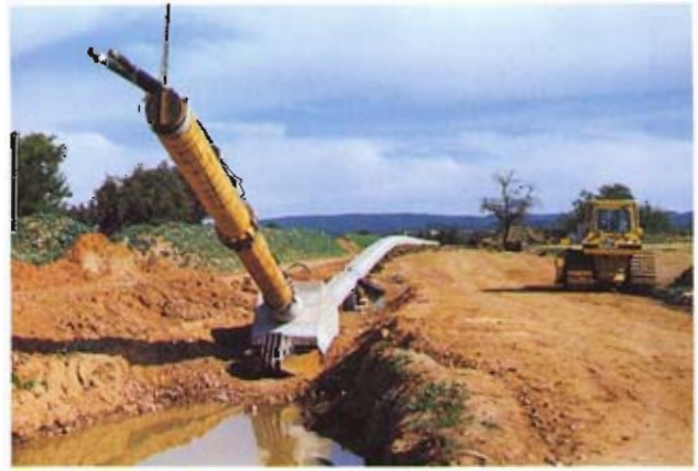
Bild 6: Beim Bau des Mainedükers
