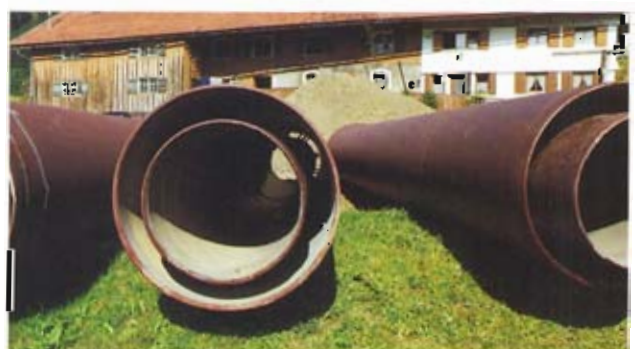
Bild 9: Doppelrohre vor der Verlegung
