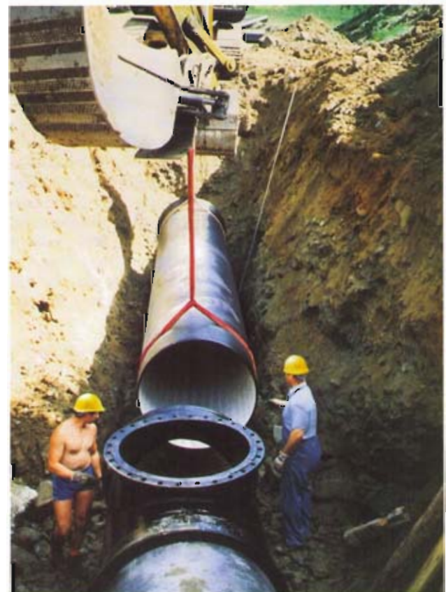
Bild 3: Verlegung eines 8 m langen Rohrschusses im Anschluß an einen Mannlocheinstieg
