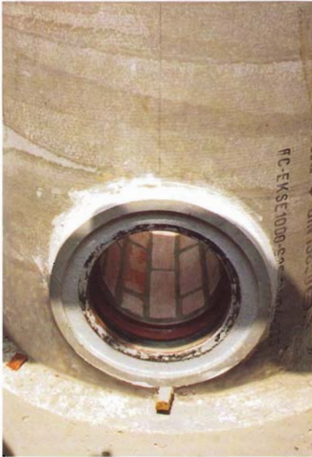
Bild 6: FZ-Schacht mit eingeklebtem Schachtanschlußstück
