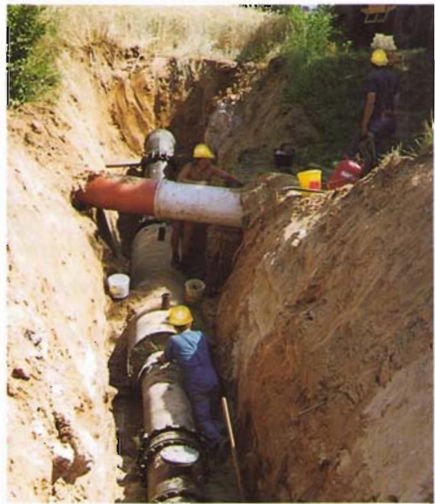
Bild 9: Bauabschnitt 05, Bachkreuzung mit Schutzrohr
