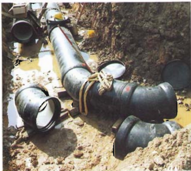
Bild 3: Doppelleitung DN 600. Auflösung des Winkelpunktes 90° in 2 x 45°
