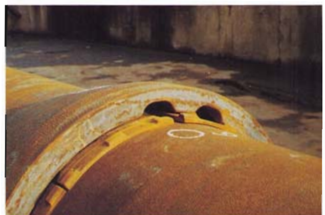
Bild 7: Fertig montierte Verbindung DN 400
