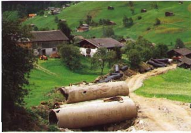
Bild 2: Ausbau der alten Spannbetonrohre und Vorlagerung der neuen duktilen Gußeisenrohre
