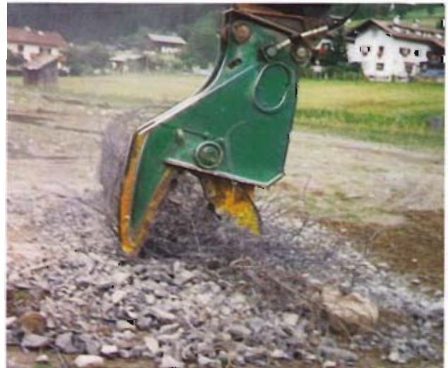
Bild 9: Überreste des Betonrohres nach der Bearbeitung mit dem Concrete-Smasher
