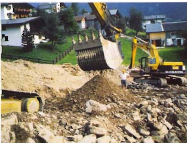
Bild 5: Korngrößentrennung mittels Sieblöffel für die Hinterfüllung der Rohre
