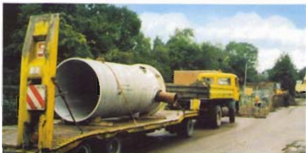
Bild 9: Transport der Schächte
