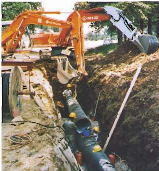
Bild 1: Verlegung DN 600
