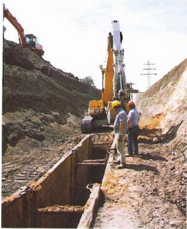
Bild 5: Rohrgraben im Bereich der Übertiefen
