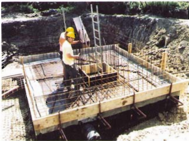
Bild 3: Schachtbauwerk mit durchgeführter Leitung
