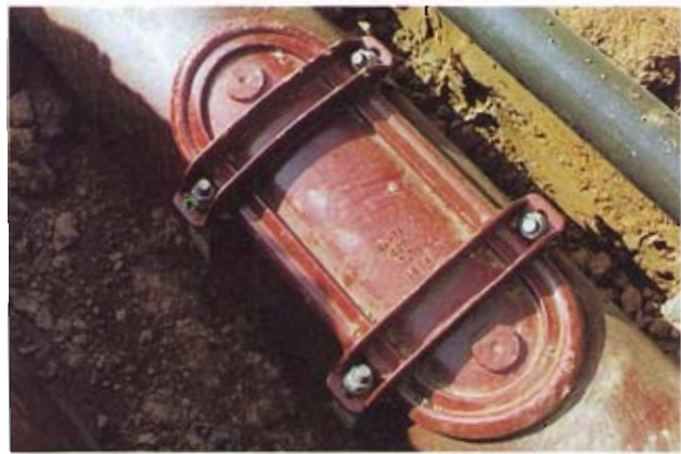
Bild 6: Verschluss einer Inspektions- und Reinigungsöffnung
