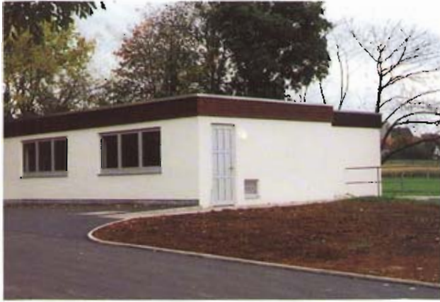
Bild 4: Das neue Pumpenhaus.
