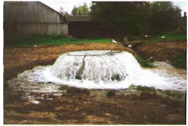
Bild 6: Spülwasser fließt aus einem der Pralltöpfe in den Vorfluter
