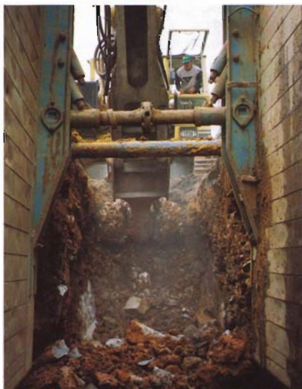
Bild 11: Felsfräse im Einsatz
