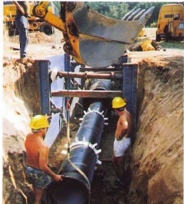
Bild 7: Bauabschnitt 04, Verlegung im Schutzrohrpreßverfahren mit Stahlschutzrohren DN 900 vorgenommen. Die Wasserleitung DN 500 wurde mit Gleitkufen in das Schutzrohr eingezogen. Auf dieser Strecke sind ein Lüftungsbauwerk und ein
