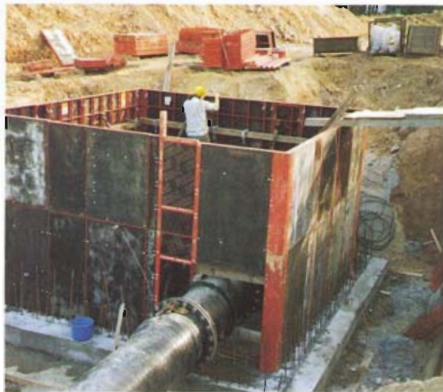
Bild 4: Im Bau befindliche Abgabestation
