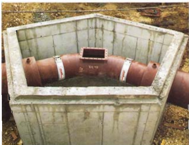
Bilder 4 (links), 5 und 6: Kontrollschacht mit Reinigungsöffnung
