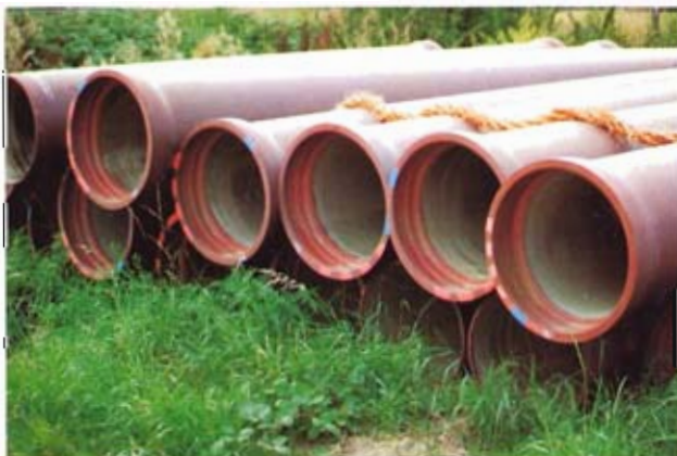
Bild 4: Lagerung der duktilen Gußrohre an der Baustelle
