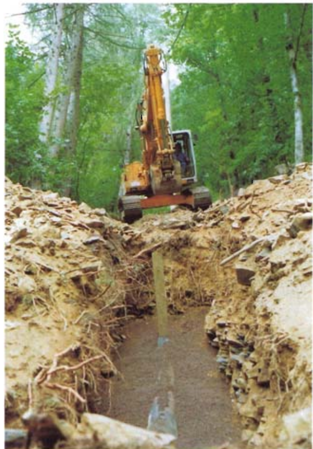
Bild 9: Verlegung nach dem „Auf-Zu-System“
