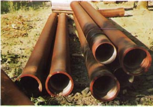
Bild 4: Rohrlagerung auf der Baustelle
