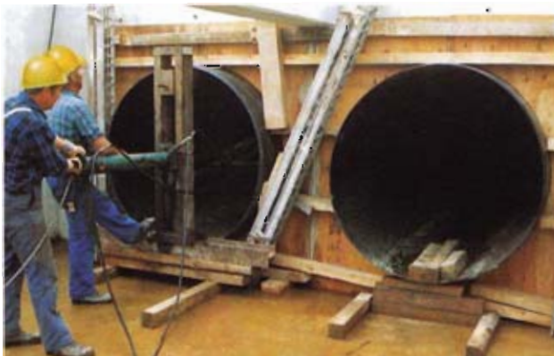
Bild 7: Einziehen eines Rohres mittels Hydraulikhubzugs
