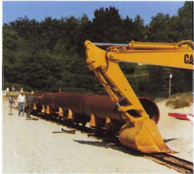
Bild 2: Lorenbahn zum Verfahren der Rohrstränge einen geplanten Leichtflüssigkeitsabscheider ausgebildet wurde.
