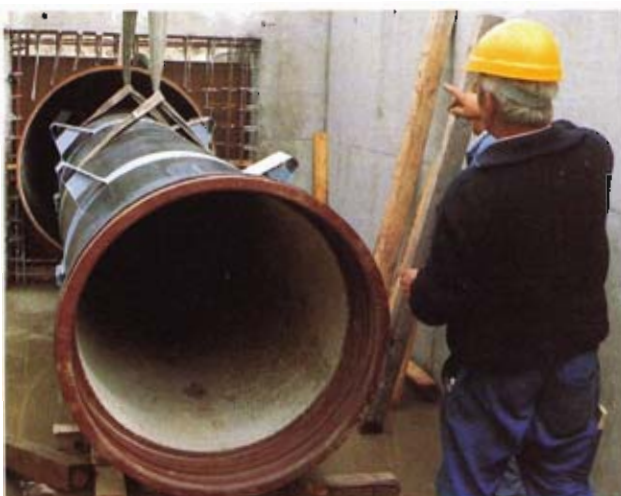
Bild 9: Das Mediumrohr wird in das Schutzrohr eingebracht
