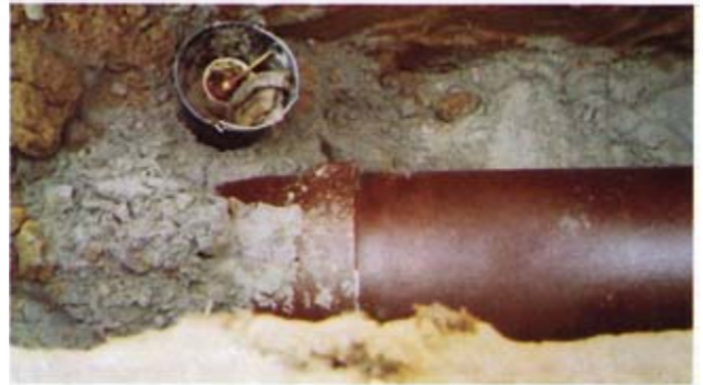
Bild 4: Zuletzt wird das Rohr bis zur Markierung vorgeschoben
