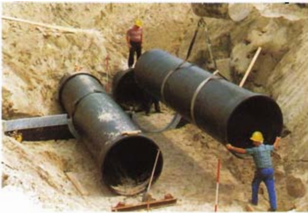
Bild 3: Verlegung der Schutzrohrleitung DN 1400
