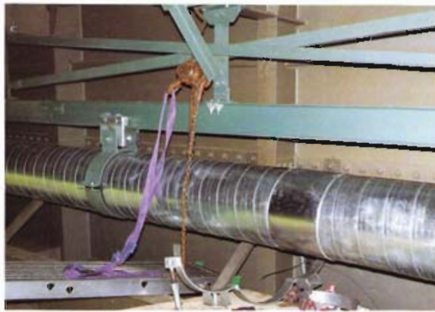
Bild 6: Fertig montierte Verbindung
