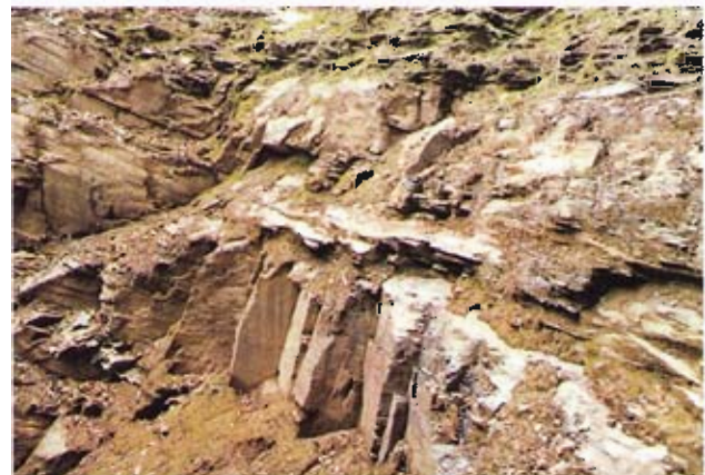
Bild 5: Bodenstruktur der Baugrube des Energieumwandlungsbauwerkes
