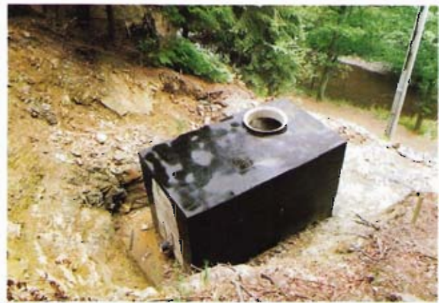
Bild 13: Energieumwandlungsbauwerk am Fuß der Steilstrecke
