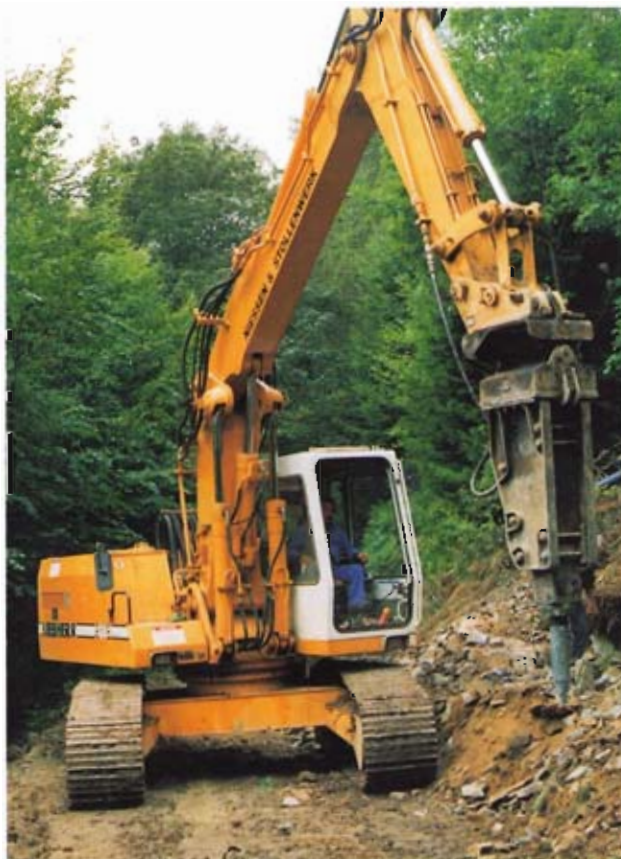
Bild 6: Bagger mit Felsmeißel auf dem die Steilstrecke kreuzenden Waldwirtschaftsweg
