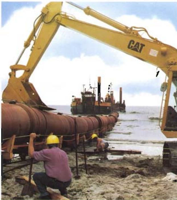
Bild 7: Die Leitung rollt in das Wasser
