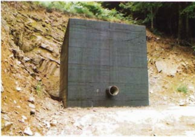
Bild 12: Energieumwandlungsbauwerk am Fuß der Steilstrecke
