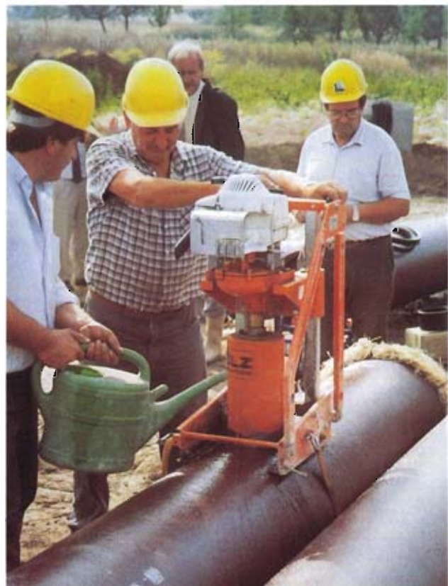
Bild 7: Anbohren des Rohres zur Montage eines Sattelstücks
