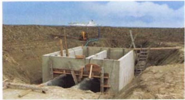
Bild 6: Schacht im Außendeich
