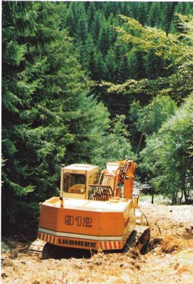
Bild 8: Bagger in der Steilstrecke, Sicht zum Rur-tal
