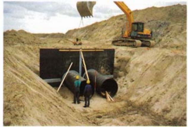
Bild 4: Montage der Umläufigkeitswand
