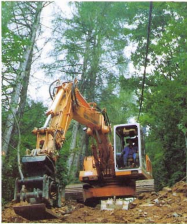
Bild 10: Einsatz eines baggergeführten Verdichtungsgerätes
