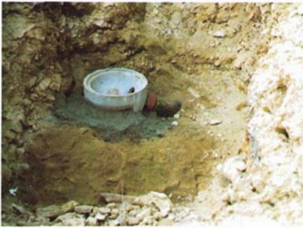
Bild 5: Anbindung eines Straßeneinlaufs
