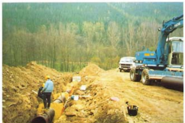
Bild 7: Verlegung duktiler Kanalrohre DN 600
