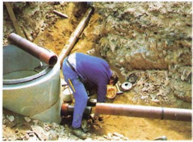
Bild 6: Anbindung zweier Grundleitungen
