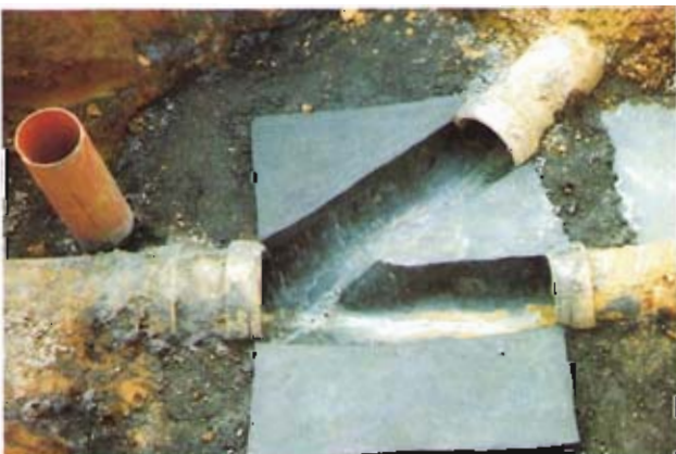
Bild 8: Schachtanschlüsse mit Unterbeton
