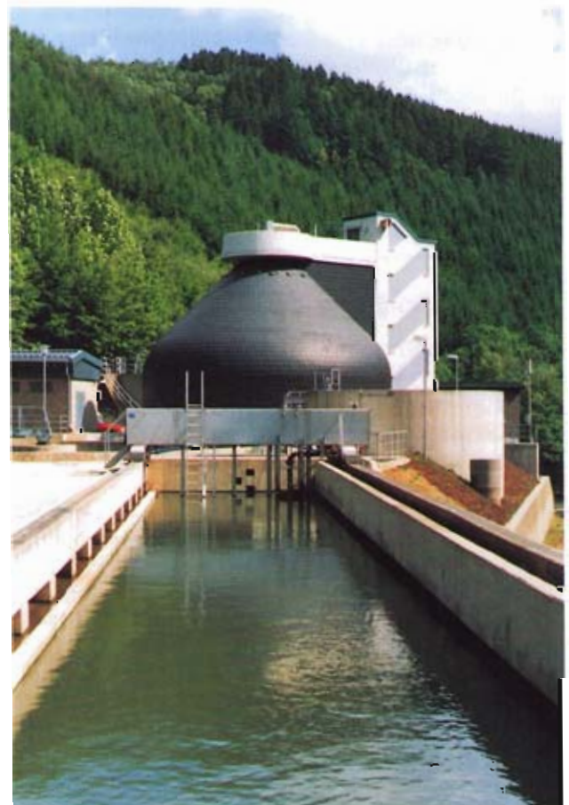
Bild 1: Zentralkläranlage Monschau mit Steilstrecke am linken Berghang
