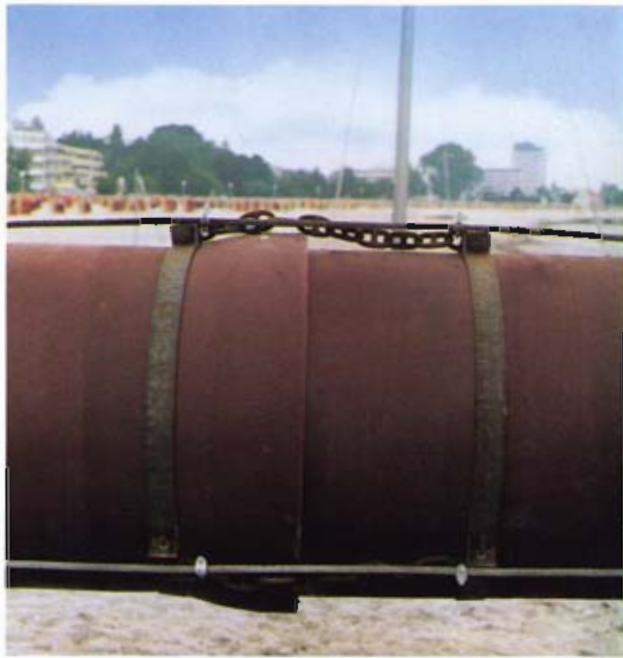
Bild 4: Transportsicherung der Verbindungen
