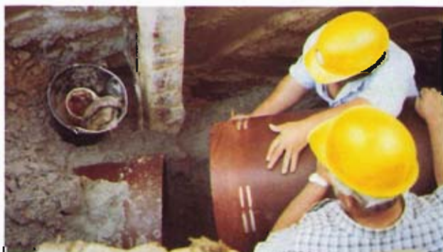
Bild 2: Das Einsteckende des Rohres wird zur Muffe hingeführt
