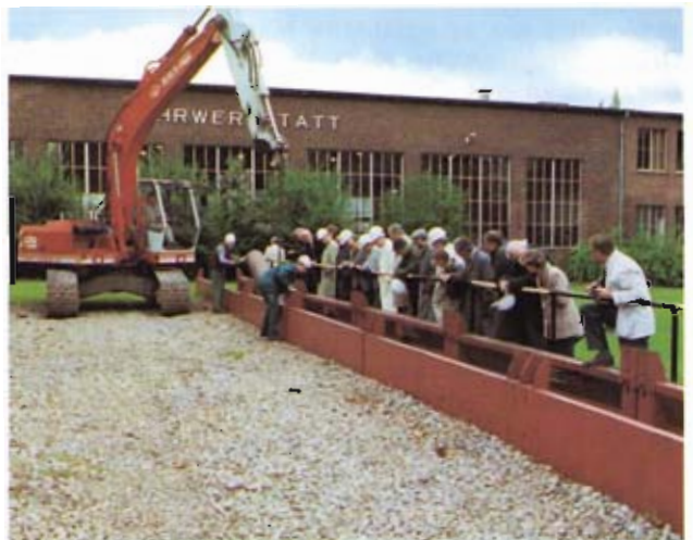
Bild 7: Herablassen des 6 m langen Rohres zwischen den Verstreben
