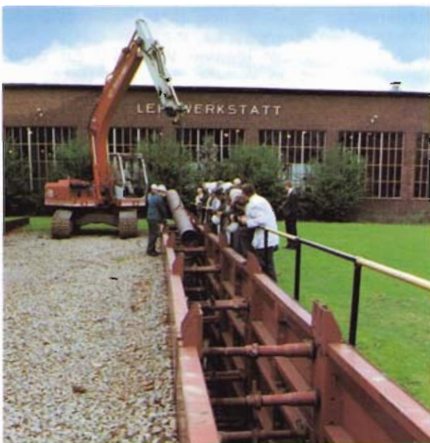
Bild 6: Blick auf die vielen Verstreben des Grabenverbaues
