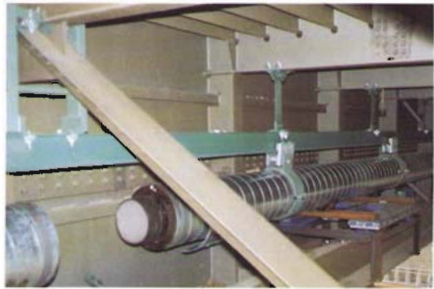
Bild 4: WKG-Rohr vor dem Zusammenfügen
