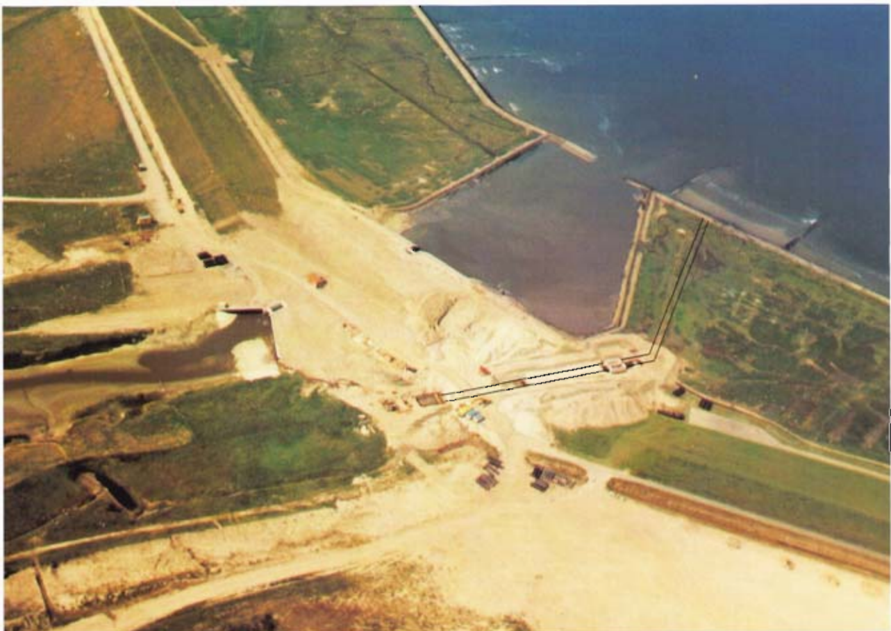
Bild 1: Blick über die Deichbaustelle mit den Doppelleitungen
