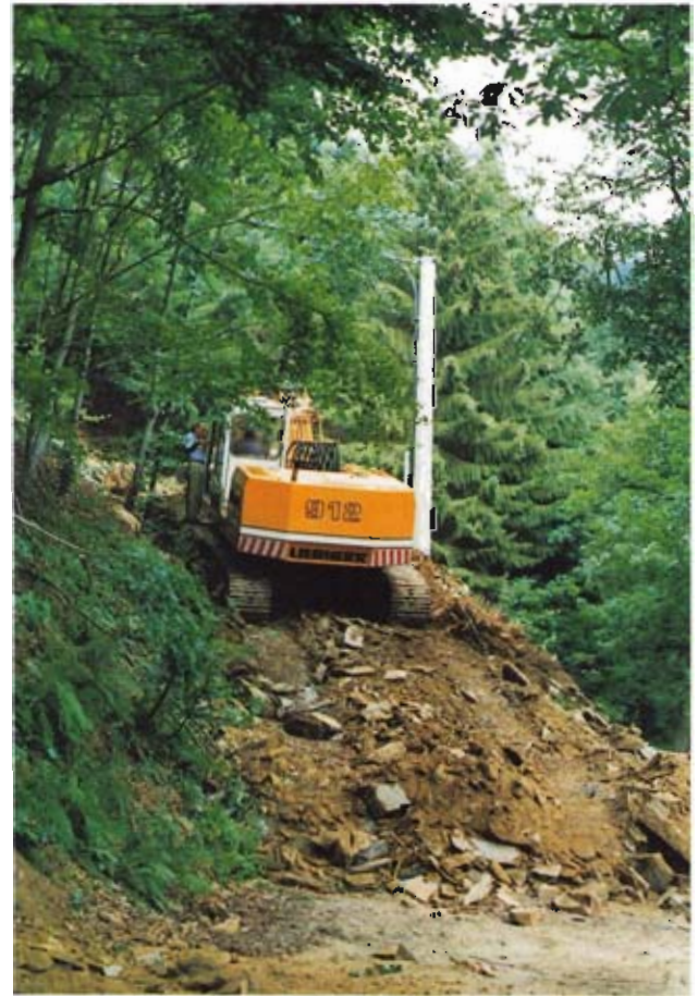
Bild 7: Tiefpunkt der Steilstrecke im Rurtal
