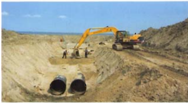
Bild 5: Rohrtrasse und Anordnung der Schutzrohrleitungen
