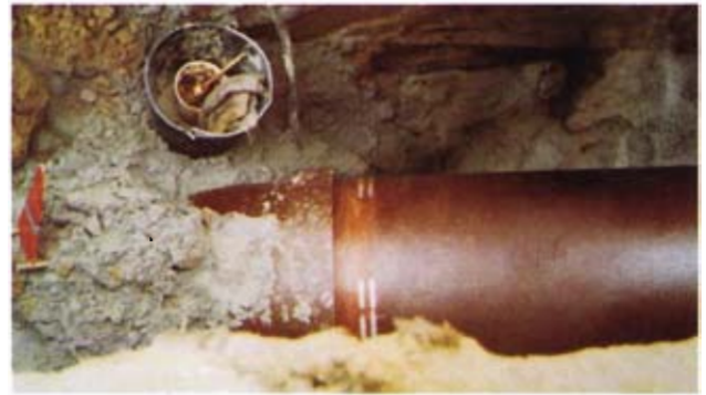
Bild 3: Das Rohr wird in die Muffe eingesetzt
