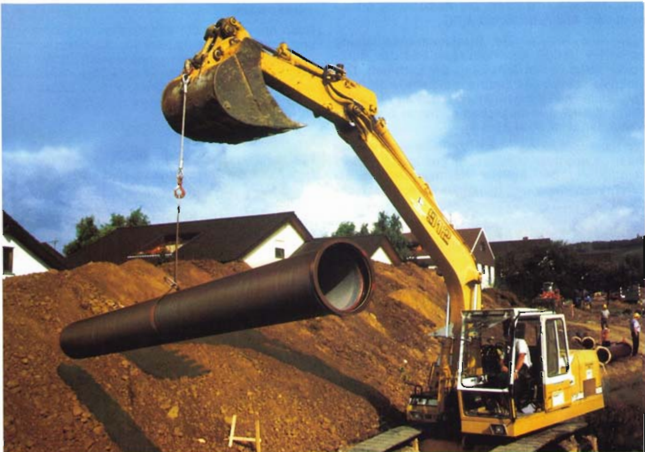
Bild 1: Verlegung der duktilen Gußrohre
