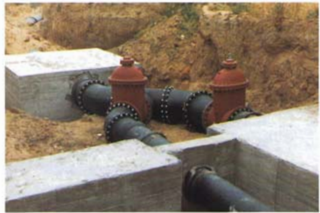
Bild 4: Vereinigung der beiden Laufleitungen DN 500 mit Absperrarmaturen und Betonwiderlagern. Im Hintergrund DN 600 zum Wasserwerk
