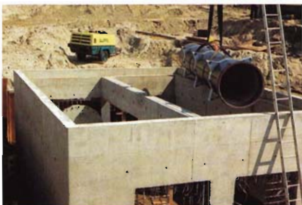
Bild 8: Links zu erkennen, wird die zweite Schutzrohrleitung zur Vakuumprüfung vorbereitet. Indessen ist das Einschleiben der Mediumleitung DN 900 für die rechte Leitung bereits angelaufen.
