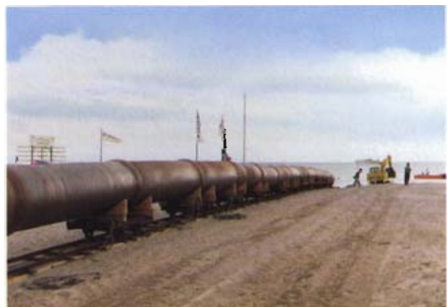
Bild 3: Rohrstrang vor dem Einschwimmen
