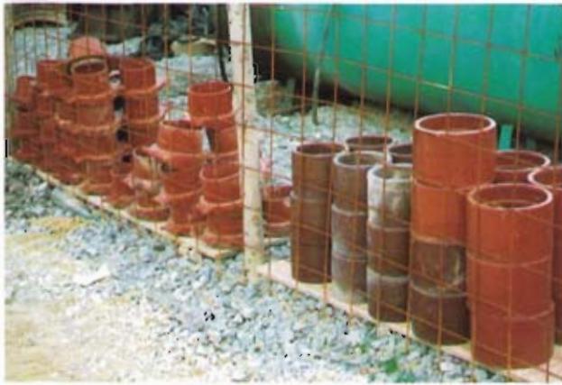
Bild 3: Formstücklager, hier TYTON-Kupplungen und Anbohrsatelstücke 90°
