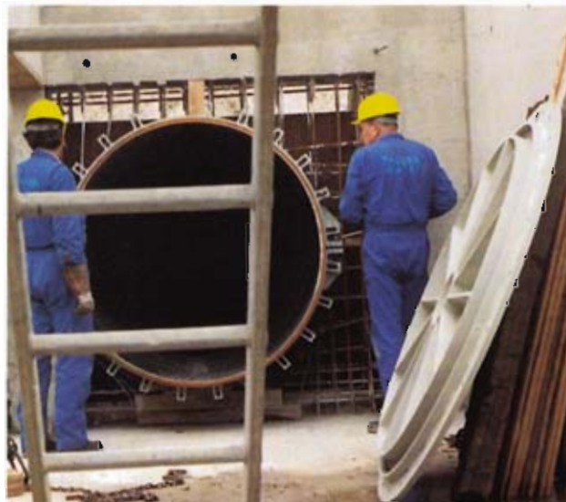
Bild 10: Rohrschelle wird aufmontiert. Rechts der Verschlussdeckel mit der Anordnung der Verrippung auf der Innenseite
