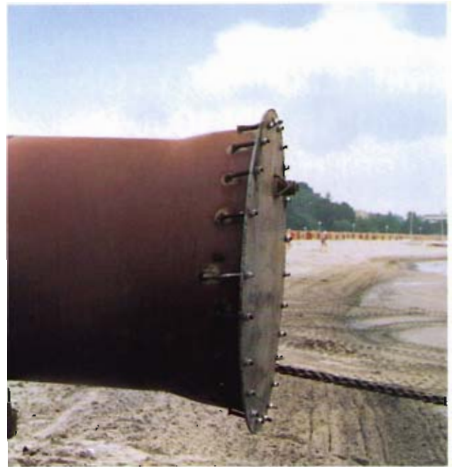
Bild 6: Verschluß des Leitungsendes
