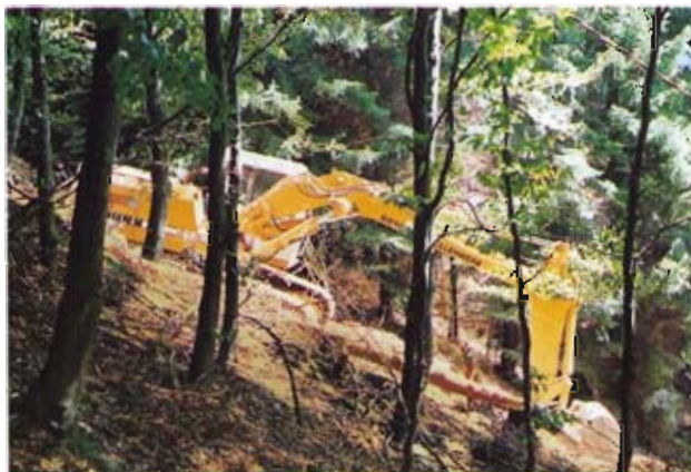
Bild 11: Bagger in der Steilstrecke
