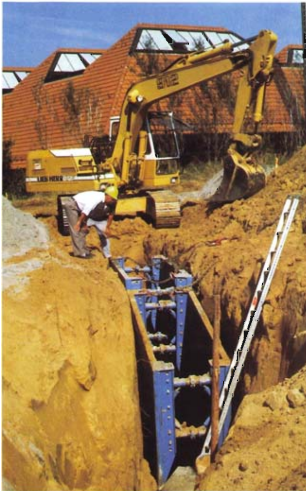
Bild 5: Schmales Graben mit Verbau: Kein Problem für Gußrohre
