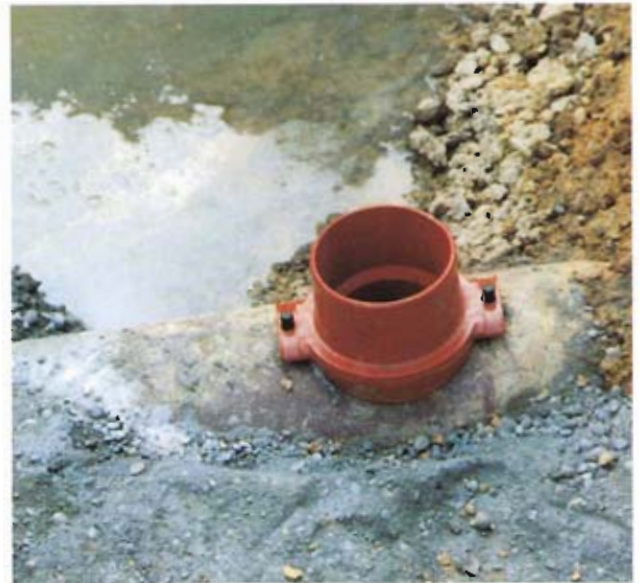
Bild 12: Anbohrersattelstück 90°, DN 150
