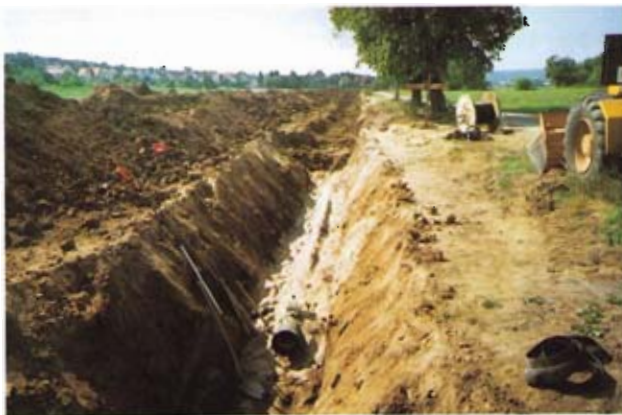
Bild 4: Blick über die Trasse der Trinkwasserleitung nach Salz
