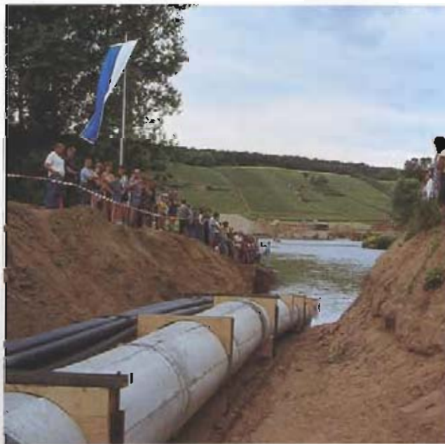
Bild 7: Einziehen des Dükers
