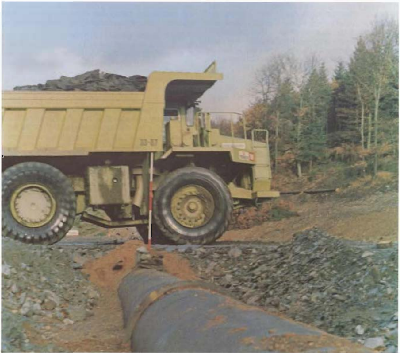
Bild 2: Duktile Gußrohre DN 1000, Klasse K 8, mit einer Überdeckung von 30 cm
