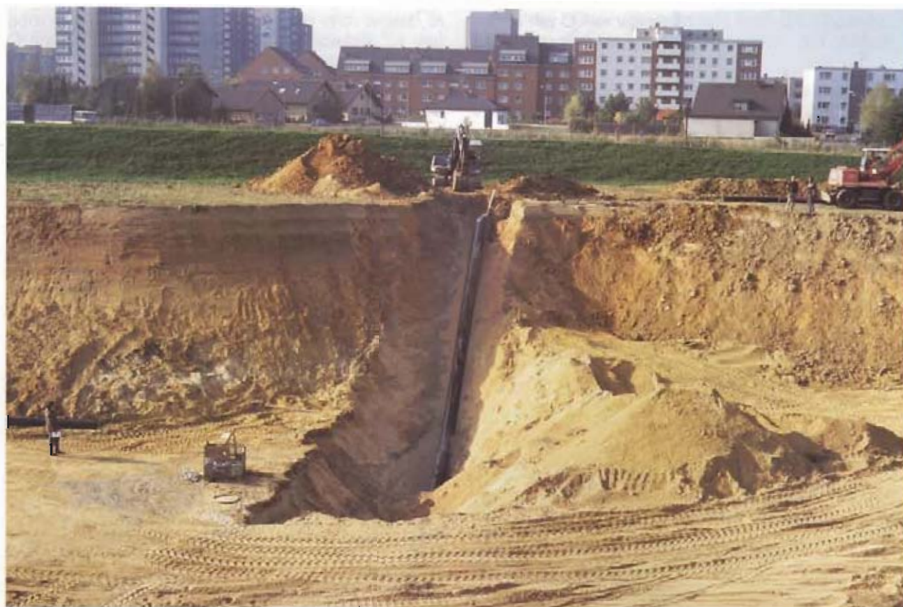
Bild 1: Verlegung eines Dükers im normalen Rohrgraben
