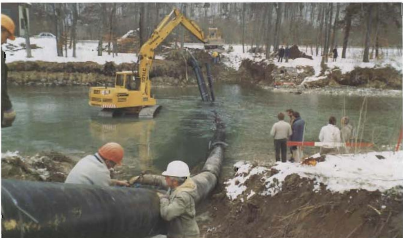
Bild 5: Traundücker im Bau
