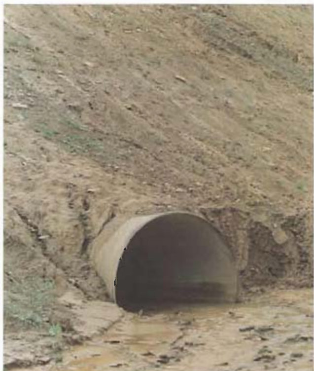
Bild 1: Duktile Gußrohre DN 1400, Klasse K 8, mit einer Erdüberdeckung von 30 m
