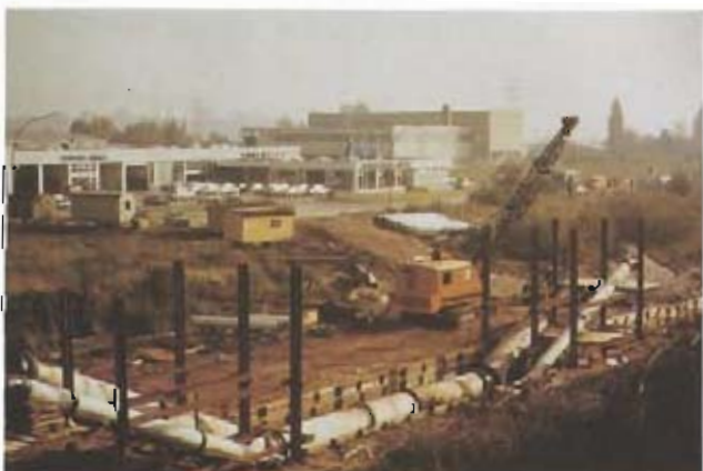
Bild 2: Düker DN 500 und DN 1000 im Montagegerüst
