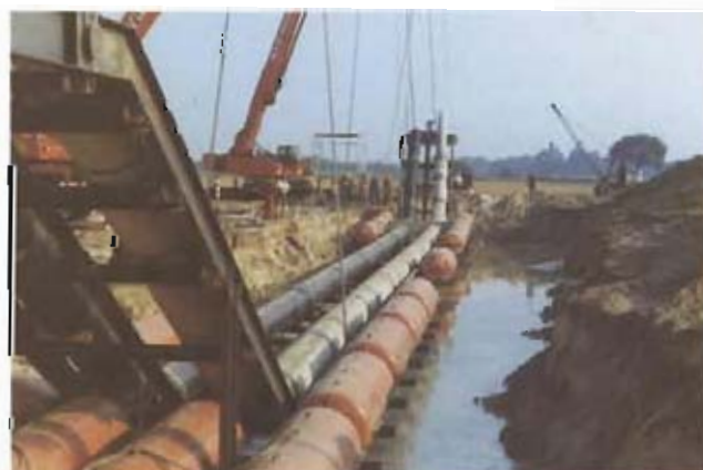
Bild 3: Fertigmontierter Düker DN 600 und DN 700 mit Pontons vor dem Einschwimmen
