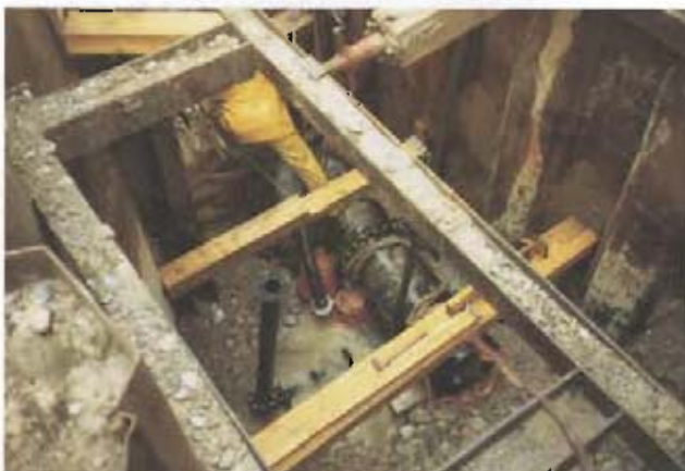
Bild 7 + 8: Aufwendige Spundarbeiten im grundwasserdurchströmten Kiesboden
