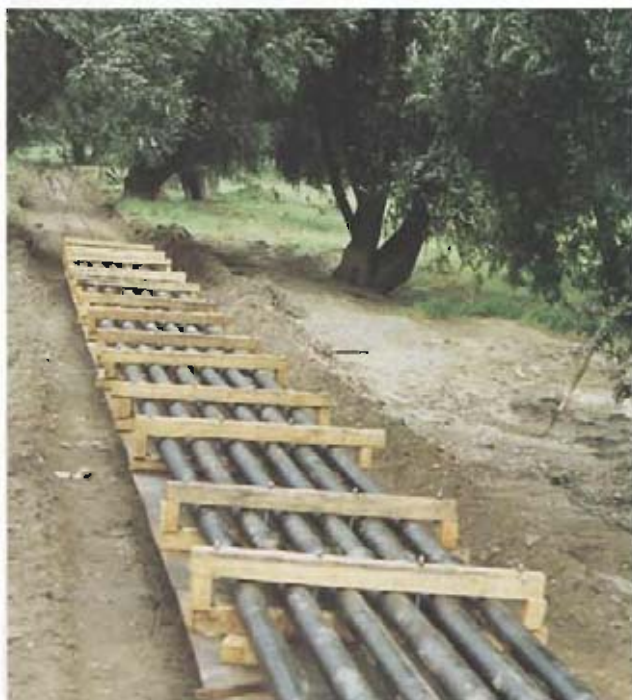
Bild 4: Montage des 6fach-Dükers DN 150
