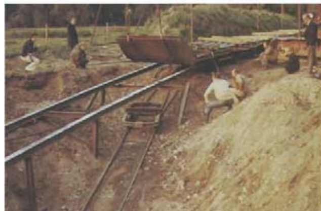
Bild 5: Auflegen des Zugkopfes auf die Gleitbahn
