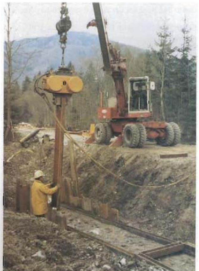
Bild 7 + 8: Aufwendige Spundarbeiten im grundwasserdurchströmten Kiesboden
