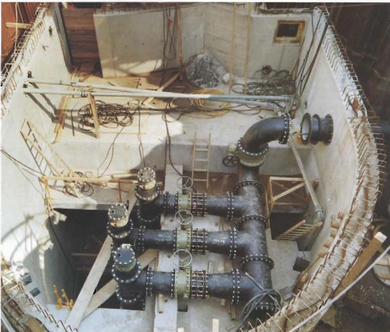
Bild 5: Blick in das rechtsrheinische Dükerhaupt während der Bauphase
