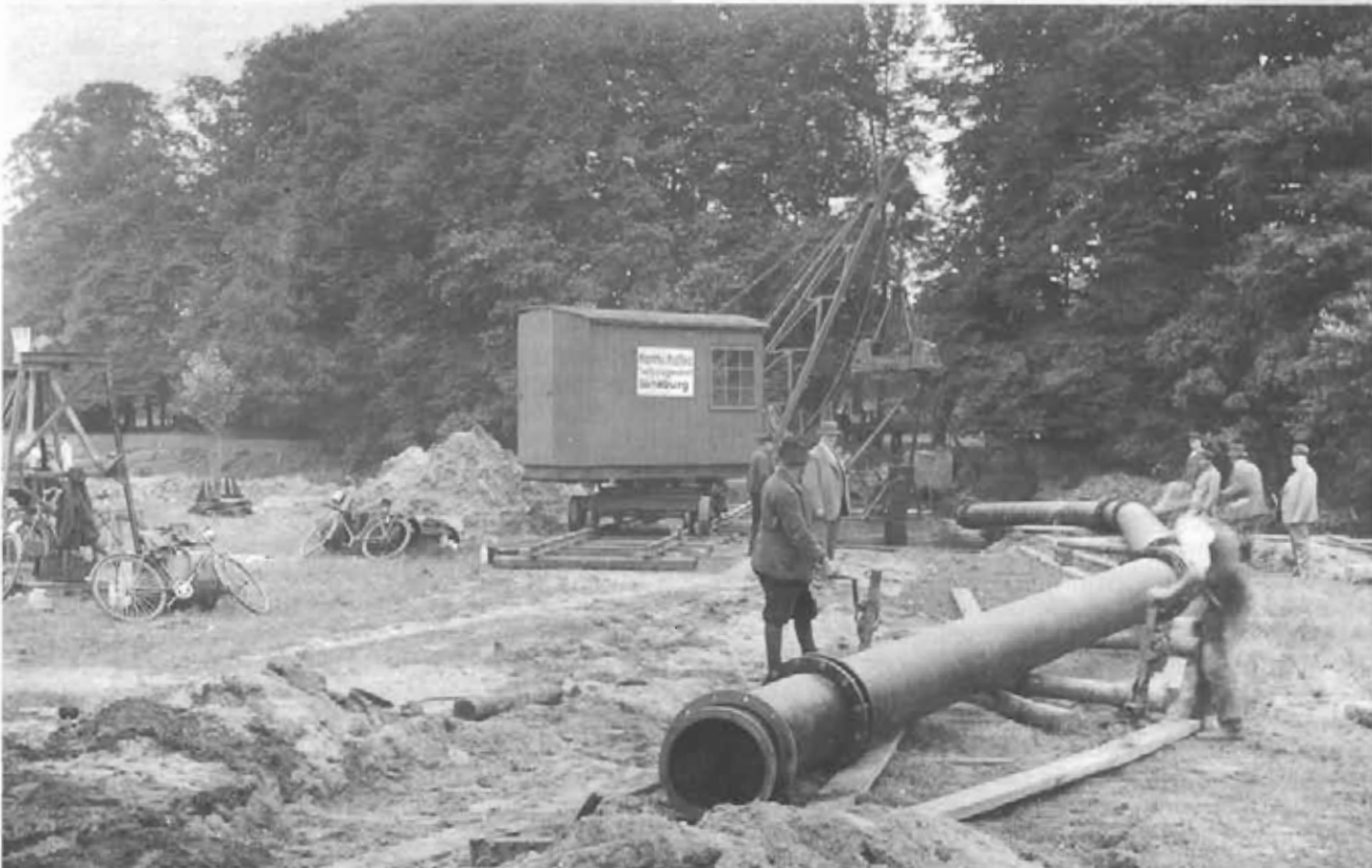
Bild 1: 1936: Düker DN 450 durch die Ilmenau; Verlegearbeiten
