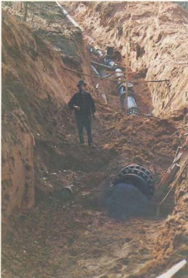
Bild 3: Ausschnitt aus der Abwasserleitung in der Steilstrecke
