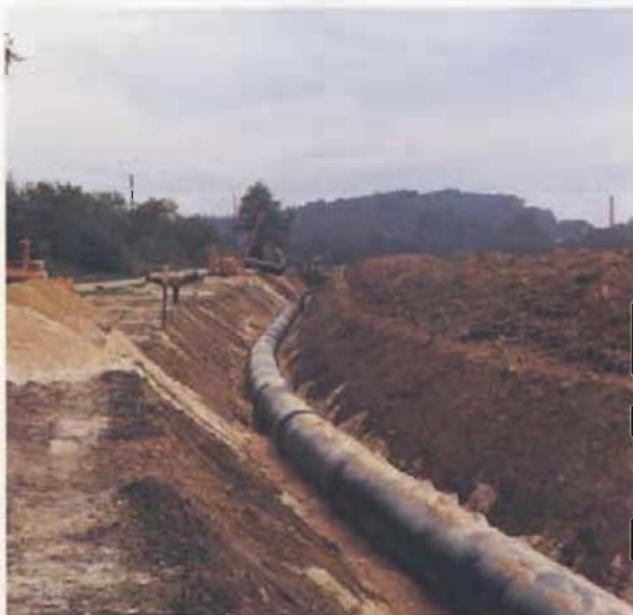
Bild 4: Verlegung der Zubringerleitung – im abgeböschten Graben –
