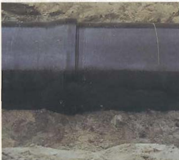
Bild 8: Fertig isolierte Verbindung DN 1200
