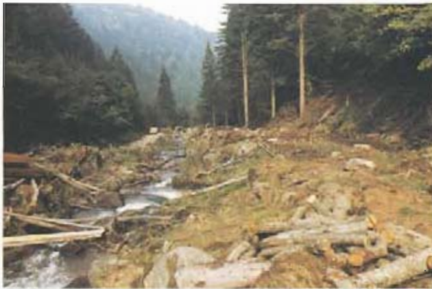
Bild 2: Roden der Trasse
