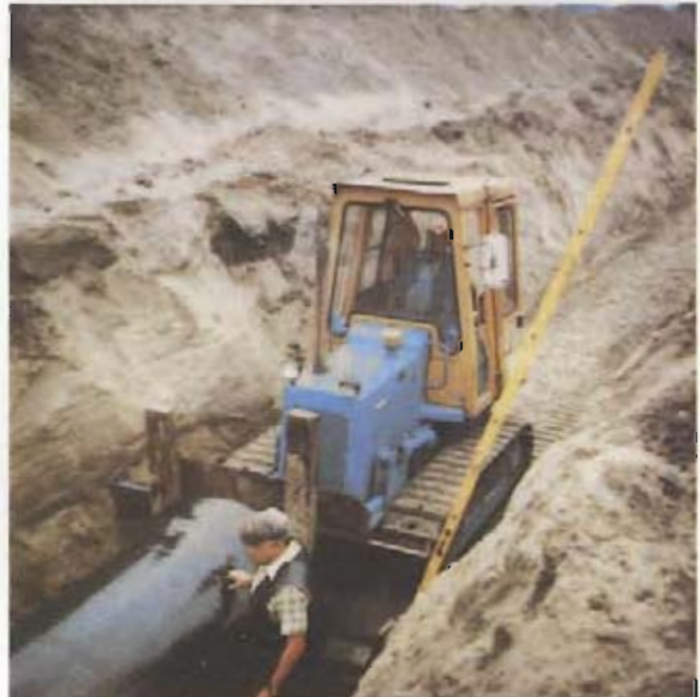
Bild 6: Einschleiben eines Rohres DN 1200 mittels Raupe
