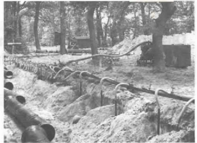
Bild 3: Verlegung der neuen Druckrohre DN 450 mit Grundwasserabsenkung
