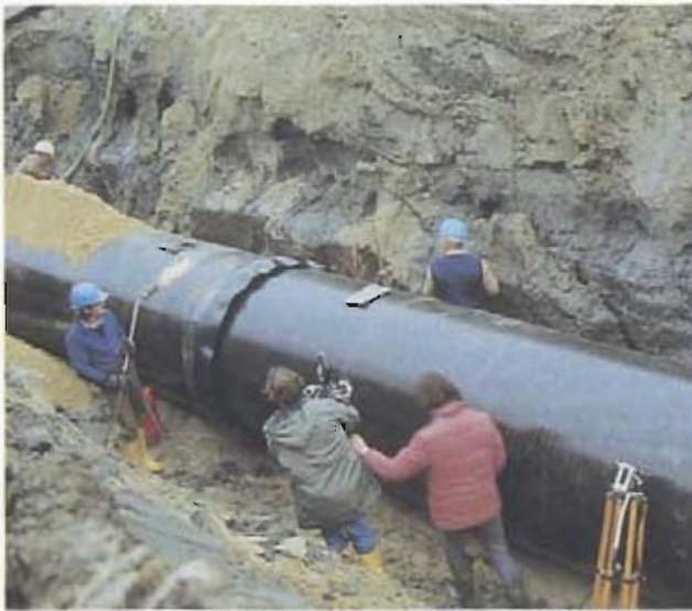
Bild 7: Nachisolieren der Verbindung
