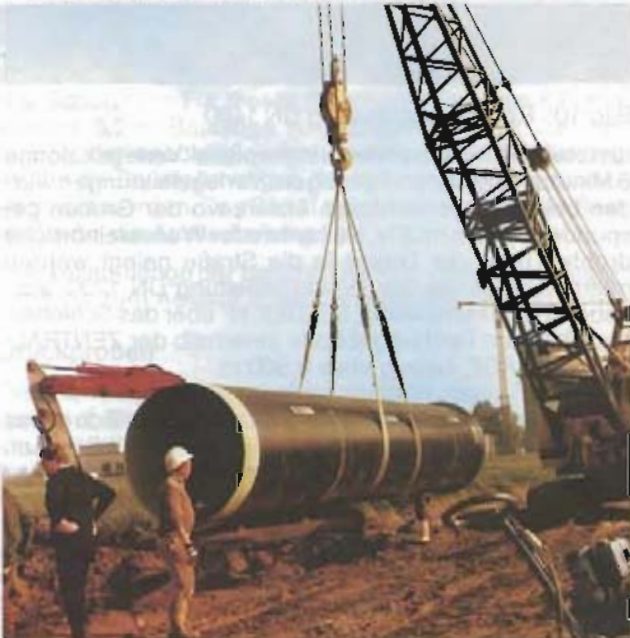
Bild 5: Absenken eines Rohres DN 1400
