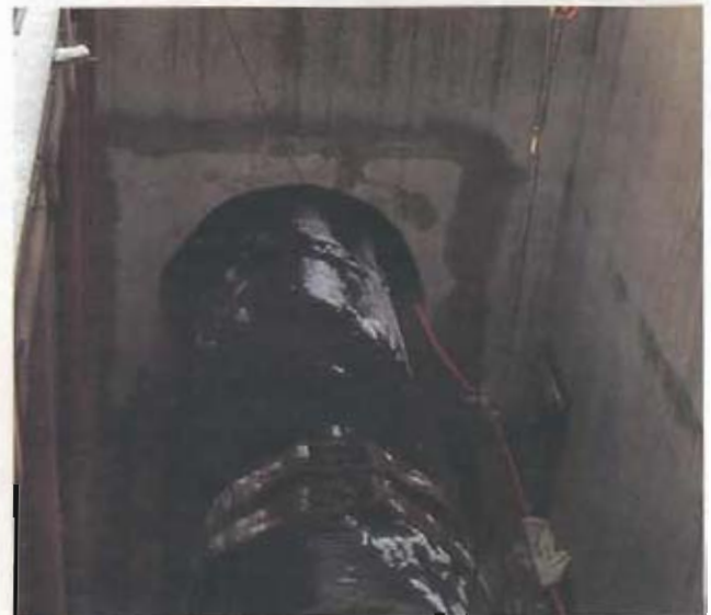
Bild 10: Rohrdurchpressung DN 1400
