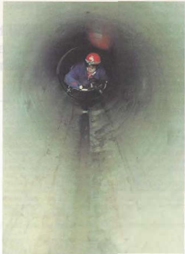
Bild 10: Kontrolle der Rohrleitung DN 700
