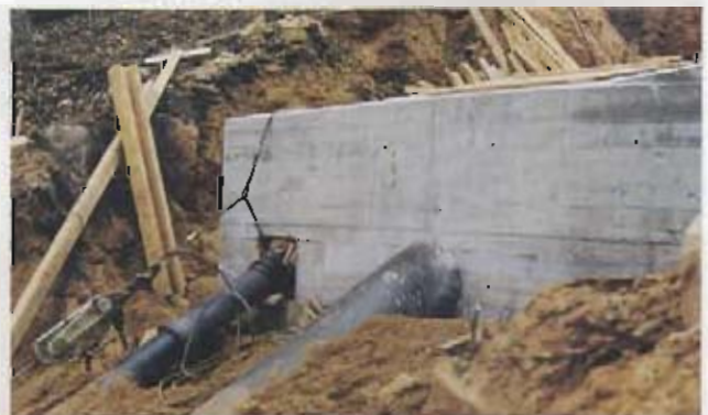
Bild 8: Einbindung der Wasserversorgungsleitung in die Schachtbauwerke
