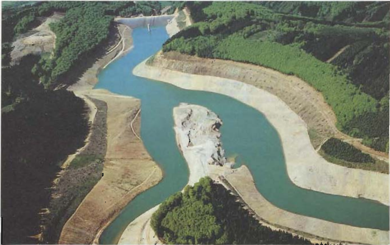
Bild 3: Verlauf des Staubereichs bis zum Abschlußdamm (freigeg. Nr. 317/81)
