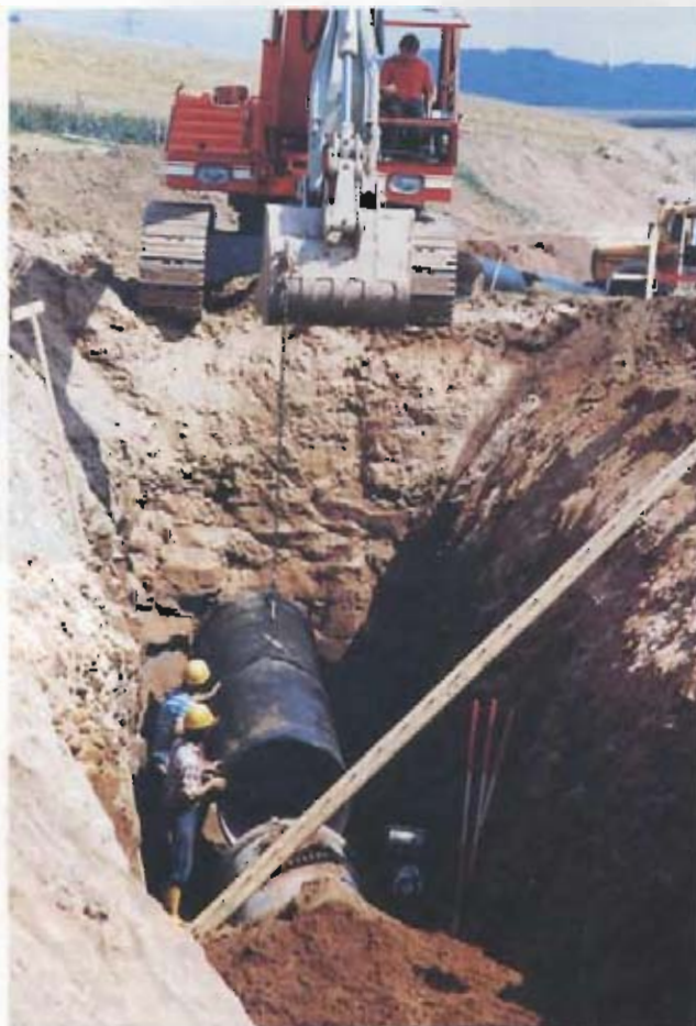
Bild 5: Verlegung der Zubringerleitung – im felsigen Gelände –
