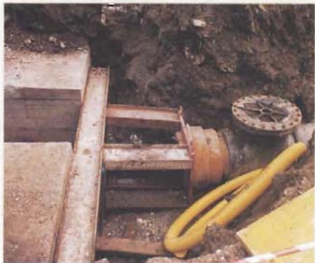
Bild 11: Abdrück-Element für den Bereich DN 500 bis DN 800
