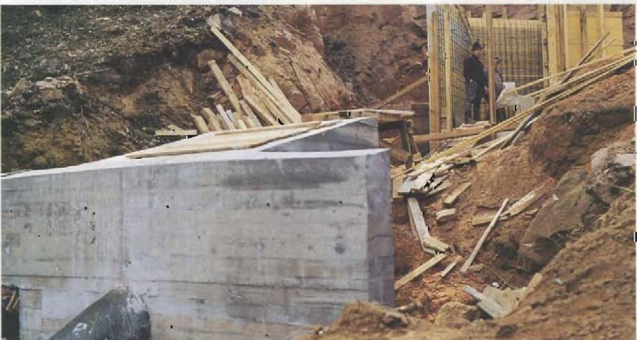
Bild 6: Schachtbauwerk in der Steilstrecke
