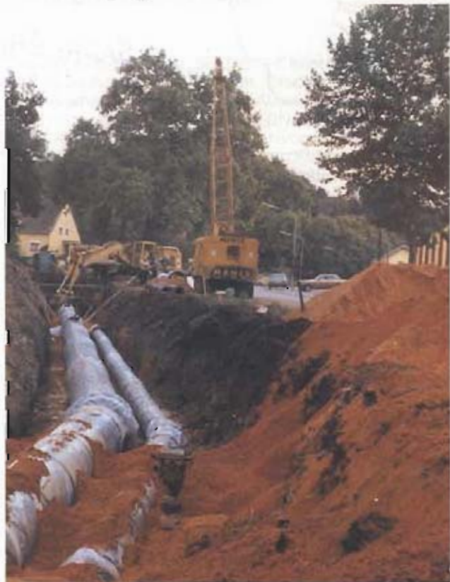
Bild 6: Verlegung der Entnahme- und Rückführleitung
