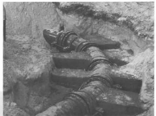
Bild 4: Sicherung von 4 Bögen 22 1/2°
