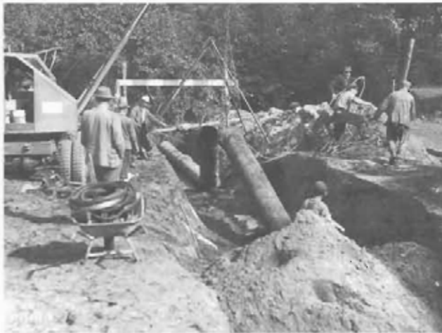
Bild 2: Aufnahmen der alten Leitung
