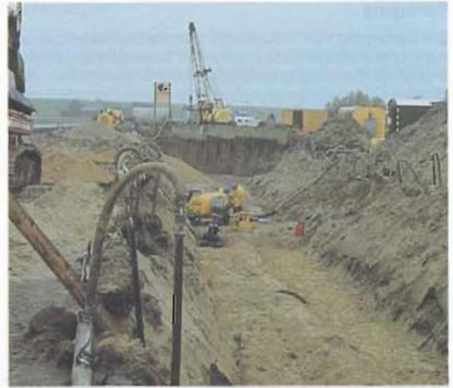
Bild 9: Gemeinsamer Rohrgraben DN 1400 und DN 1200
