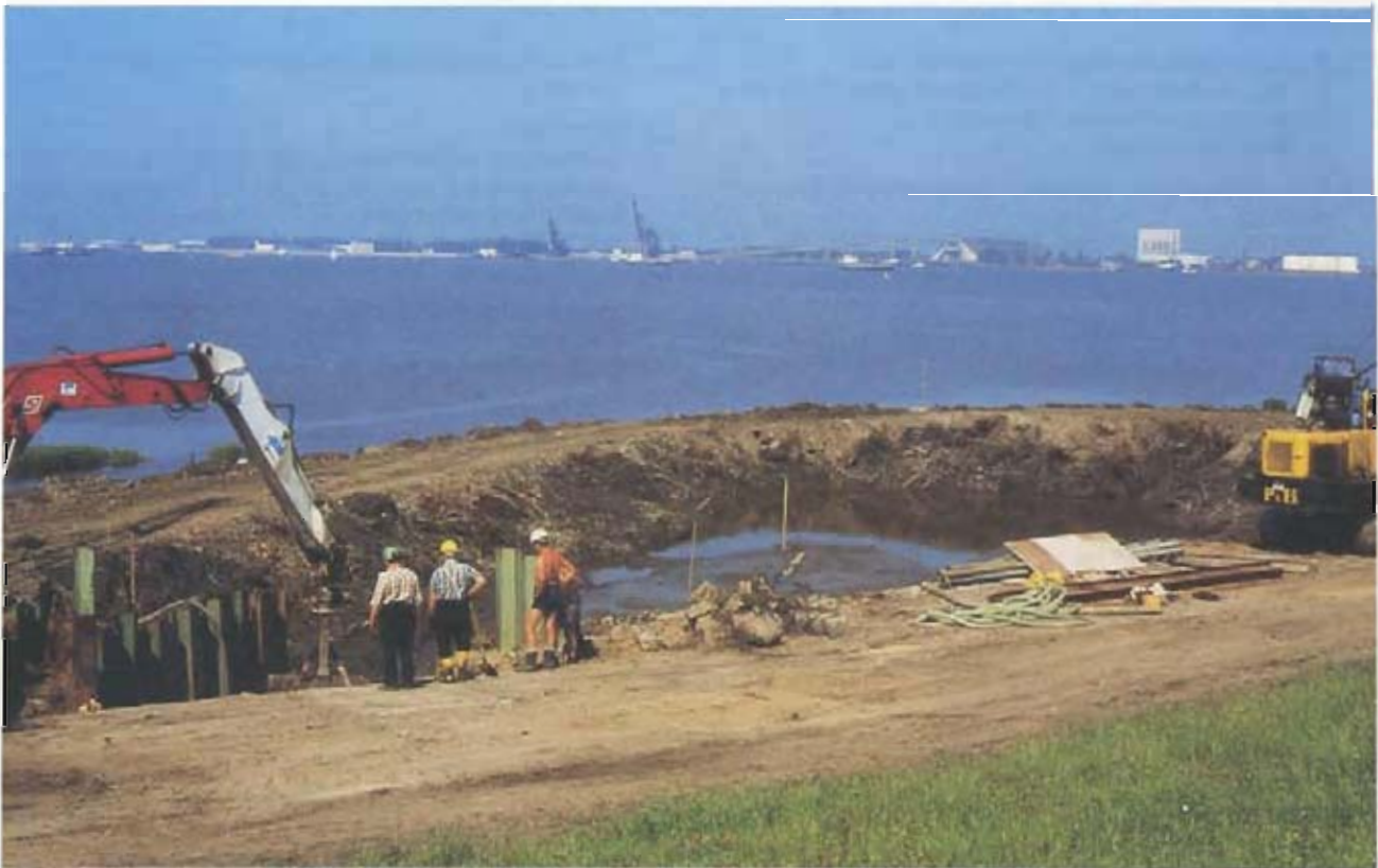
Bild 11: Auslaufleitung hinter dem Deich
