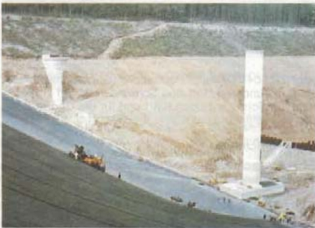
Bild 1: Talsperre Nonnweiler – im Bau –
