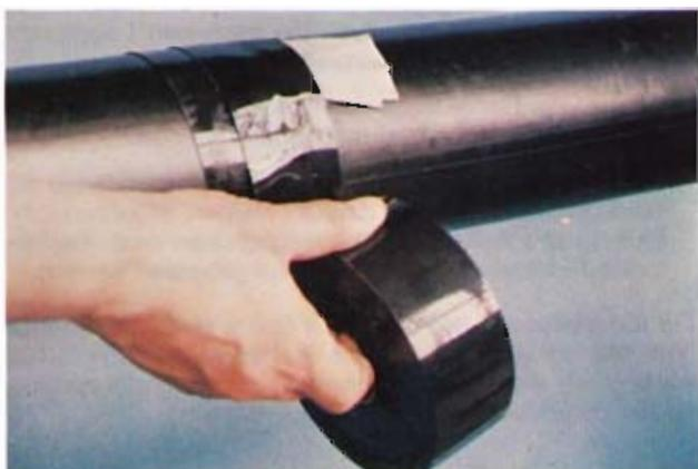
Bild 13: Ausbessern einer Verletzung der Polyethylen-Umhüllung mittels selbstklebendem Polyethylen-Band
