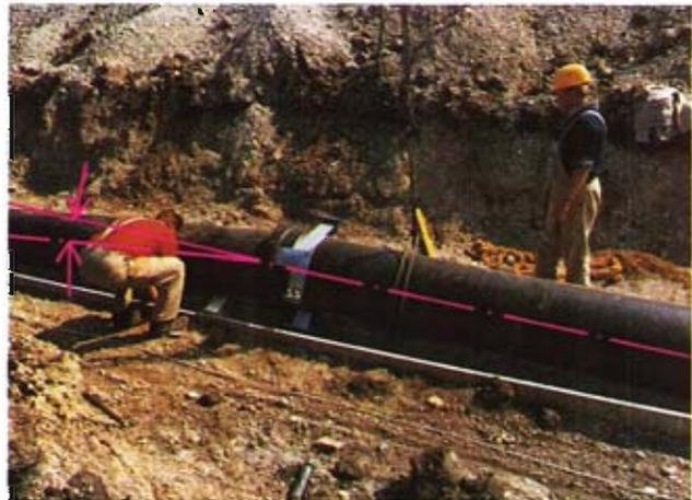
Bild 4: Abwinkelung einer TYS-K-Verbindung beim Anheben durch Kran
