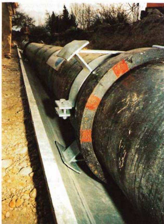
Bild 6: Transportleitung mit Gleitkufenschelle in Montage-
