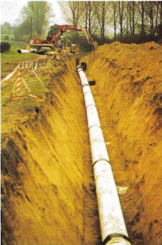
Bild 2: Verlegung der duktilen Gußrohre DN 500, PN 16 zwischen Wolfenbüttel und Klein Denkte
