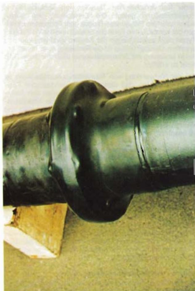
Bild 10: Mit Polyethylen-Schrumpfschlauch isolierte Flanschverbindung
