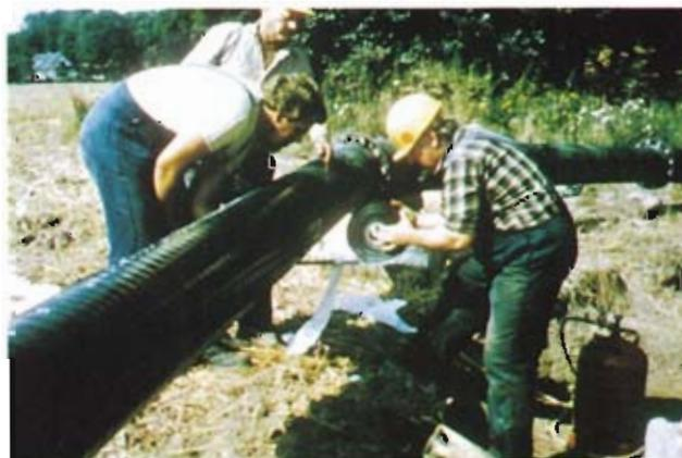
Bild 11: Isolieren eines Flanschenrohres DN 300 auf der Baustelle
