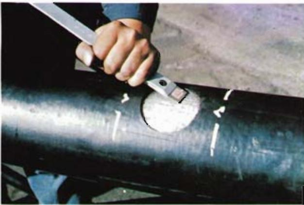
Bild 8: Freischaben der Dichtungsfläche
