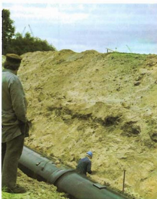
Bild 6: Verbindungsisolierung mit Schrumpfband DN 1200
