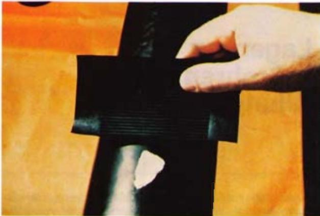
Bild 12: Ausbessern einer Beschädigung der Polyethylen-Umhüllung mittels Schrumpfband
