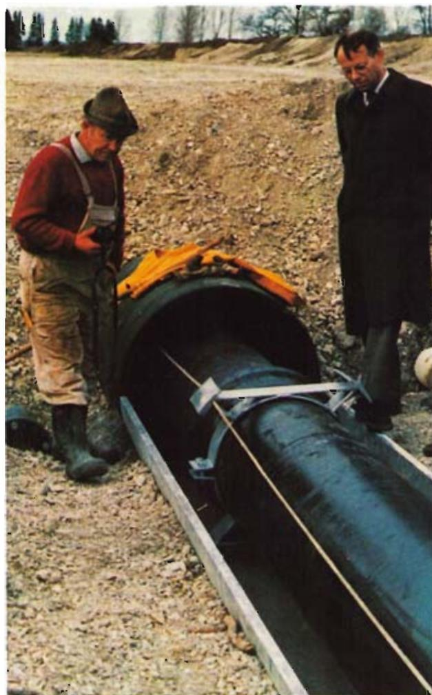
Bild 7: Einziehen der Transportleitung in Schutzrohrstrecke
