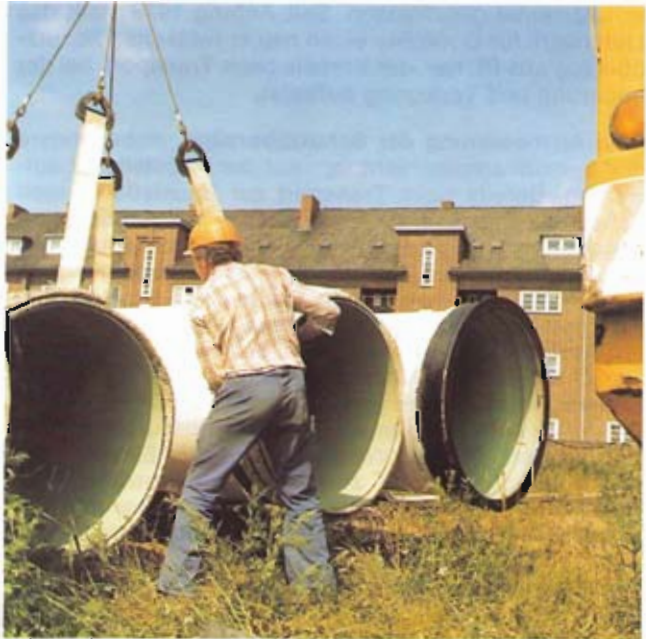
Bild 7: Abladen korrosionsgeschützter Rohre aus duktilem Gußeisen
