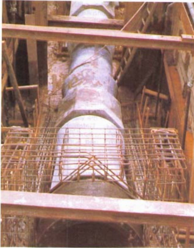
Bild 4: Übergang Spannbeton-/duktile Gußrohre mit einem EU-Stück
