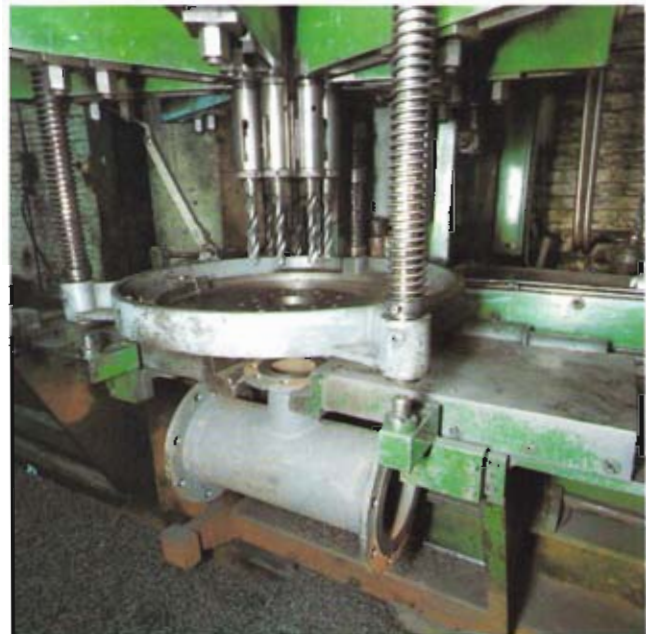
Bild 13: Einbringen der Schraubenlöcher unter Verwendung einer Bohrschablone
