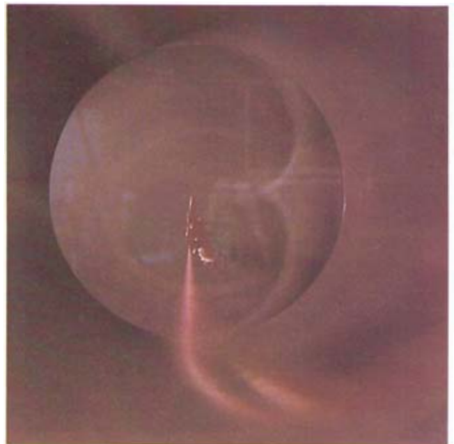
Bild 5: Spritzen der Beschichtung in das sich drehende Rohr
