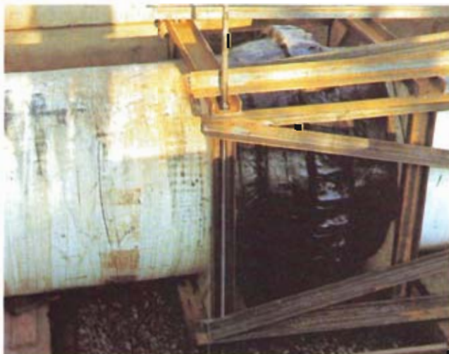
Bild 6: Isolierung einer zugfesten Rohrverbindung des Dükers DN1000 mit einer mehrschichtigen Kunststoffbinde
