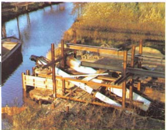
Bild 8: Aufbau der Schleusengraben-Düker DN 500 und DN 1000 in einem Montagegerüst
