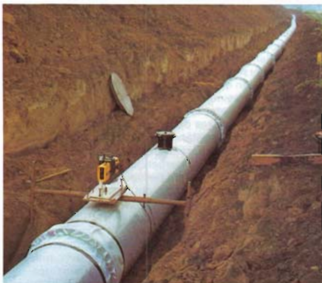
Bild 4: Verlegung der duktilen Gußrohre mit Laser-Gerät
