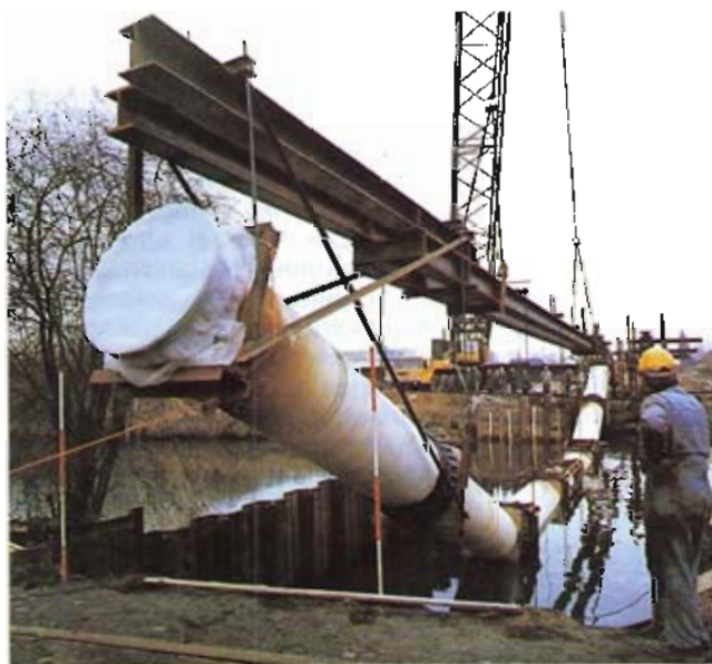
Bild 9: Absenken des Dükers DN 1000 in eine Baggergrube
