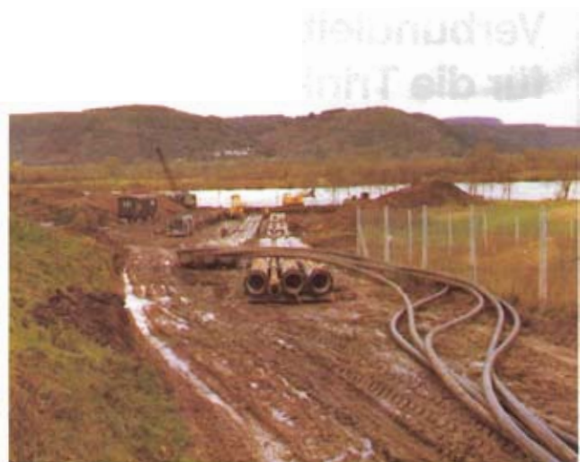
Bild 5: Der Strang links wird zuerst eingezogen, der Strang rechts später angeflanscht und mitgezogen
