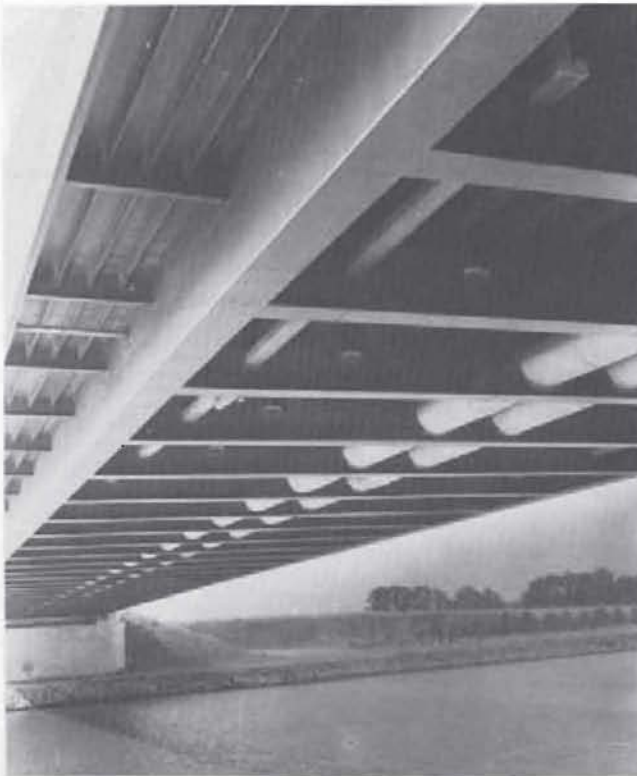
Bild 3 Die Fernleitung wird über den Mittellandkanal geführt
