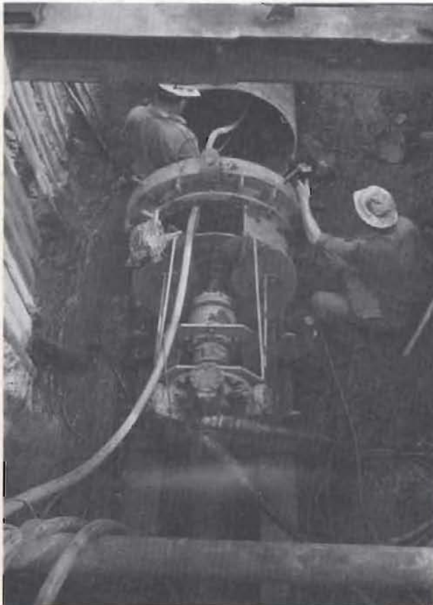
Bild 5 Durchpressung unter der Bundesbahnstrecke Münster-Bremen
