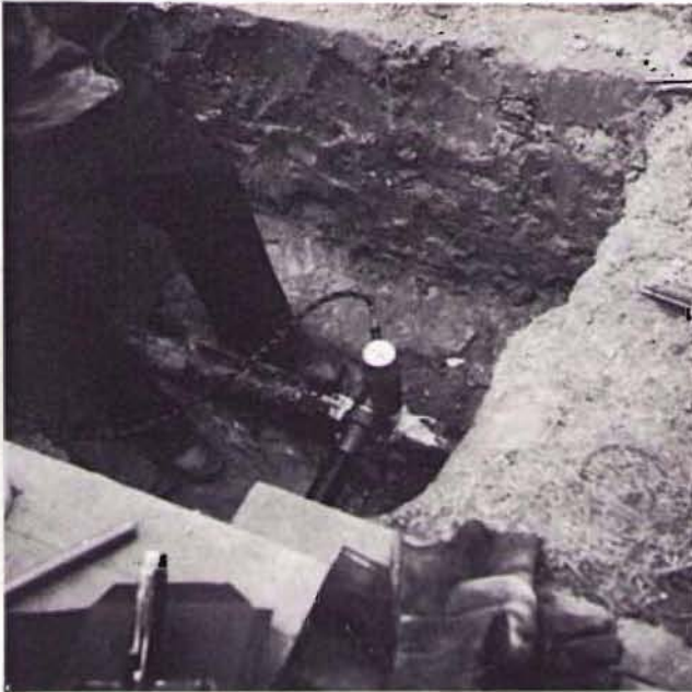
Bild 8: Durchführung der Dichtheitsprüfung vor dem Anbohren (nach Verlegung der Hausanschlußleitung)
