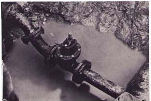
Bild 8: In Bild 7 gezeigter angeschweißter Abgang nach der Montage des Schiebers
