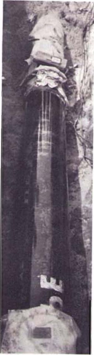
Bild 2: In Philadelphia, Pennsylvania, wurde 1959 in einem Mülldeponiegelände eine mit PE-Schlauch geschützte 12"-Gußrohrleitung (NW 300) verlegt. Die Überprüfung einer beträchtlichen Länge dieser Rohrleitung im Jahre 1969 ließ keine nennenswerten Korrosionsangriffe erkennen.
