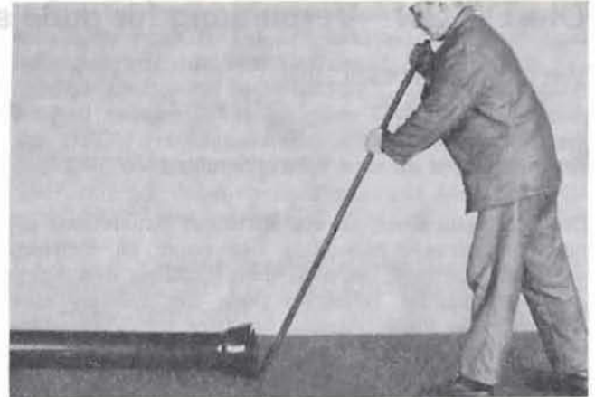
Bild 3: Einführen des Rohres in die Muffe a) mittels eines Hebels für Nennweiten bis 125
