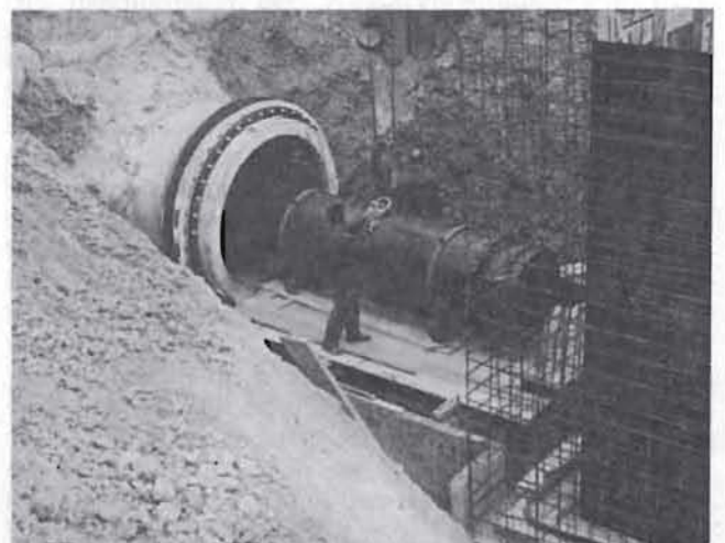
Rohre NW 800 in Durchpressungsstrecke
