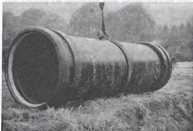
Bild 10: Muffenloses Rohr aus duktilem Gußeisen mit TYTON-Kupplungen
