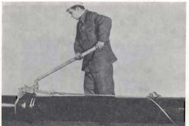
c) mit einer Zugratsche für Nennweiten 350 bis 600
