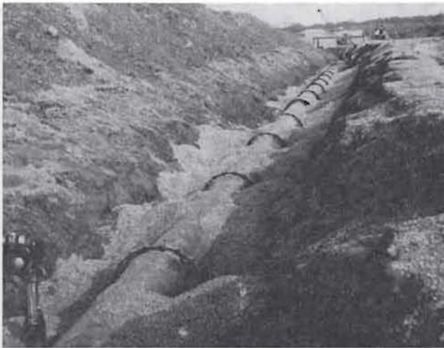
Idealstrecke, Rohre bereits angedeckt
