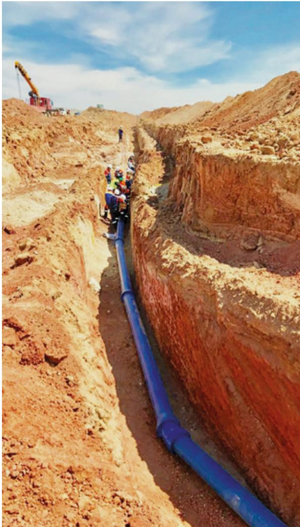
Die bis zu  $-40\text{ }^{\circ}\text{C}$ , die im mongolischen Winter herrschen und den Boden bis in 3,5 m Tiefe gefrieren lassen, machen es notwendig, die Rohre 4 m tief zu verlegen.
