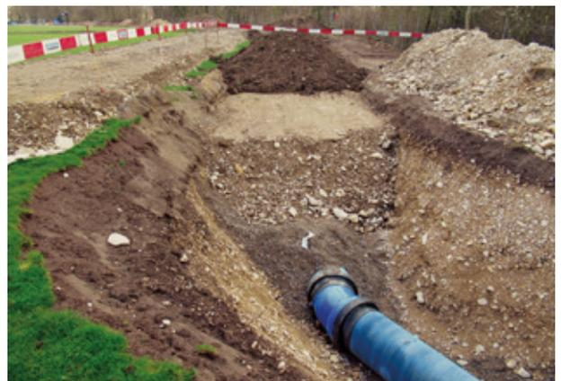
Gut ersichtlich sind die verschiedenen Erdmaterialien, doch das duktile Gussrohr mit der Zementmörtel-Umhüllung (ZM-U) ist jeder Situation gewachsen. Unverschmutztes Aushubmaterial kann auch wieder zum Verfüllen des Grabens verwendet werden.
