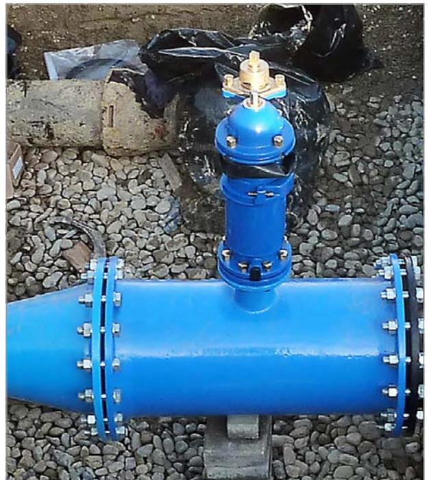
Hochpunkt mit Entlüftung bestehend aus Unterflurhydrant, vonRoll VARIO 2.0 und Flanschstück mit Flanschstutzen
