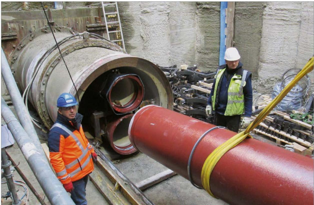
Einbau eines duktilen Gussrohres DN 600 mit einer längskraftschlüssigen BLS® - Steckmuffen-Verbindung
