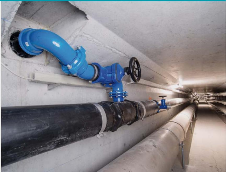
Löschwasserleitung aus wärmegeämmten duktilen Gussrohren DUCPUR mit Steckmuffen-Verbindung HYDROTIGHT und einem seitlichen Abgang zu den Hydranten-Nischen.
