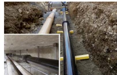
und Umhüllung aus Polyurethan (PUR) sowie ECOFIT-Formstücke mit integraler Epoxidharz-Beschichtung nach GSK/RAL-GZ 662 zum Einsatz, die nach EN 545 als verstärkte Umhüllung klassifiziert sind. Die neue 600 m lange ECOPUR-Trinkwasserleitung DN 200 wurde auf der gesamten Leitungslänge mit dem bewährten HYDRO-TIGHT-Schubsicherungssystem längskraftschlüssig ausgerüstet.
