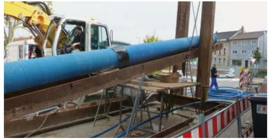
der Neustrukturierung und Ausrichtung der Wasserversorgung weitere 288 m duktile Gussrohre DN 400, C 40, K 9, mit TYTON SIT PLUS® - Steckmuffen-Verbindung eingebaut. Mit der Baumaßnahme war Ende August 2015 begonnen worden, im Dezember 2015 war sie bereits fertiggestellt.
