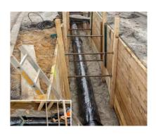
von circa 200 m mit vonRoll ECOPUR-Vollschutzrohren aus duktilem Gusseisen mit verstärkter Umhüllung nach EN 545 zu bauen. Die vonRoll ECOPUR-Steckmuffenrohre sind mit einer porenfreien Innen- und Außenbeschichtung aus Polyurethan (PUR) integral geschützt und können dadurch auch in stark aggressiven Böden eingesetzt werden.
