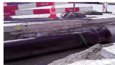
geforderte statische Nachweis für die Tragsicherheit und die Gebrauchstauglichkeit nach der Schweizer Norm SIA 190 erbracht werden. Die hydraulisch glatte und für alle pH-Bereiche 1–14 geeignete Polyurethan (PUR)-Auskleidung nach EN 15655 stellt auch bei geringstem Gefälle eine ausreichende Schleppkraft sicher.
