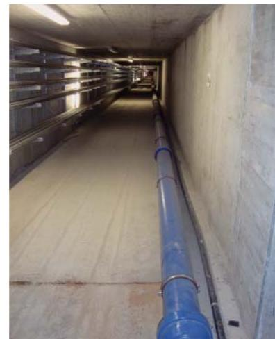
2.200 m duktile Gussrohre DN 200 mit PUR-Beschichtung in einem Leitungsgang unterhalb der Fahrbahn, der auch alle anderen Infrastrukturen aufnimmt. Die Arbeiten sind in vollem Gang; ein Großteil der Löschwasserleitung ist unter Federführung der Firma Atzwanger AG aus Bozen bereits fertiggestellt.
