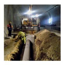
fallende Regenwasser wird vor dem Tunnelbauwerk in einem Regenklärbecken gesammelt und vorgereinigt. Das so gereinigte Wasser wird anschließend von einer Pumpstation über eine 540 m lange Druckleitung aus duktilen Abwasserdruckrohren DN 200 mit längskraftschlüssiger BLS® -Steckmuffen-Verbindung in den Vorfluter Rems eingeleitet. Alle eingebauten duktilen Gussrohre sind außen mit Zink/Epoxidharz beschichtet und mit Zementmörtel ausgekleidet.
