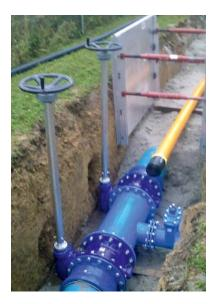
schweige denn unterbrochen werden. Deswegen wird nach Einbau eines Rohres der Graben sofort wieder mit steinfreiem Boden verfüllt. Alle Arbeiten werden nach abgestimmten Plänen ausgeführt, wobei die Sicherheitsbestimmungen der Firma Braun oberste Priorität besitzen.
